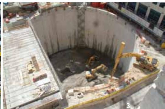
de l'autre par l'intermédiaire de corbeaux scellés dans les panneaux de la paroi moulée. Après ferrailage, le béton est coulé à la pompe sur un bac acier laqué blanc, servant de coffrage perdu, et permettant d'épouser la surface gauche générée par la pente de la rampe et son dévers extérieur.
