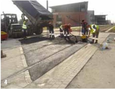
4- Mise en œuvre manuelle des enrobés entre rails.
