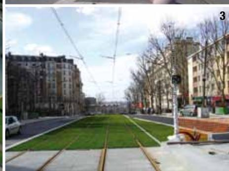
1- Vue d'une plate-forme de tramway avant mise en place des revêtements.
