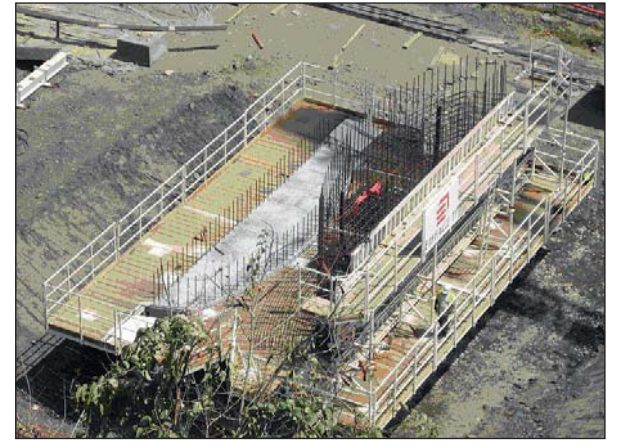
Photo 9 Coffrage et chevêtre Formwork and pier cap
