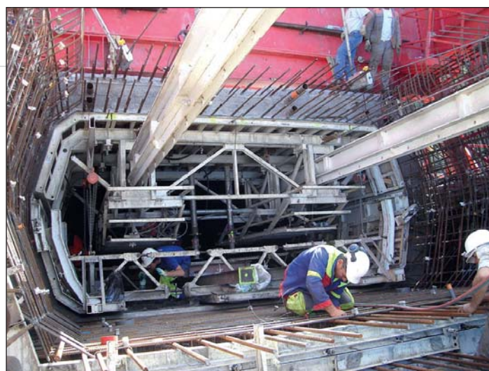
Photo 14 Ferrailage du voussoir d'about Reinforcement of end segment
