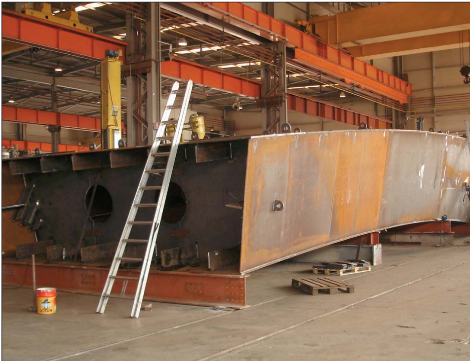
Photo 8 Réalisation d'un tronçon en atelier Construction of a section in workshop
