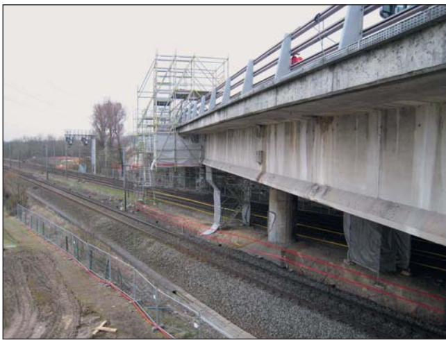
Photo 16 Viaduc de la Mauldre La Mauldre viaduct
