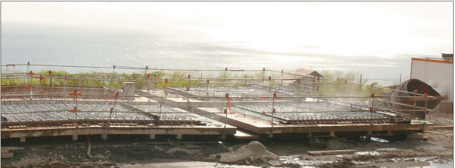
Photo 15 Aire de préfabrication des prédalles Precast slab prefabrication area
