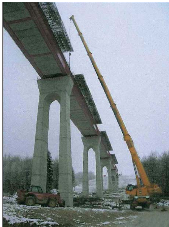
Photo 8 Hourdis inférieur préfabriqué (Epenottes) Prefabricated lower slab (Epenottes)
