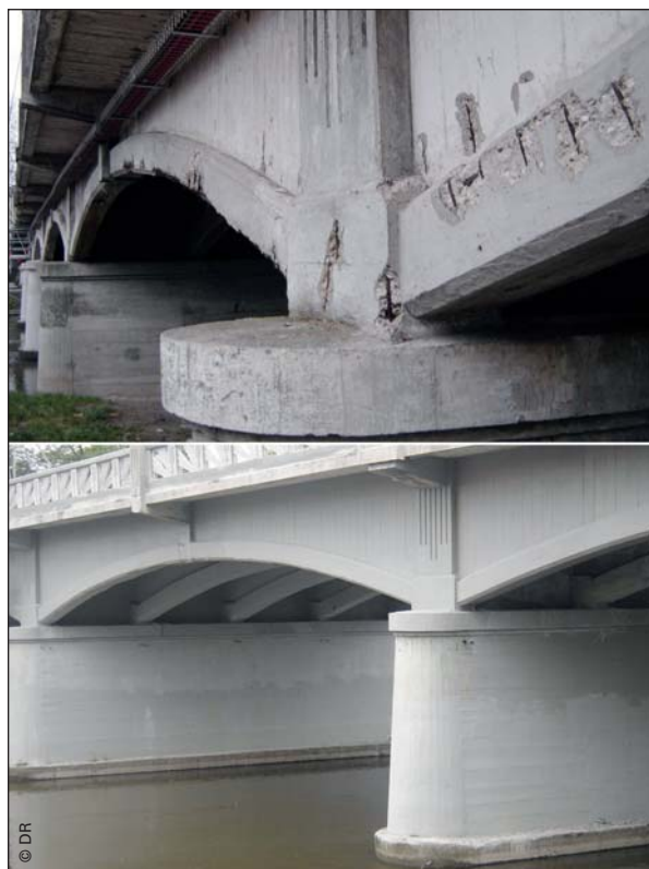
Photo 7 Ouvrage avant et après travaux Structure before and after works
