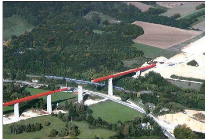
Photo 7 Poussage du viaduc de la Lizaine Pushing the Lizaine viaduct
