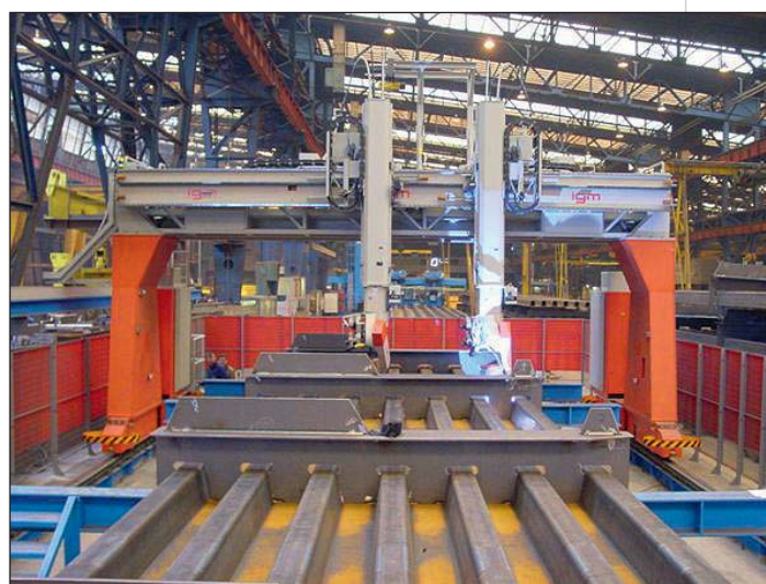
Photo 15 Soudage des entretoises en usine Welding of cross ties in factory
