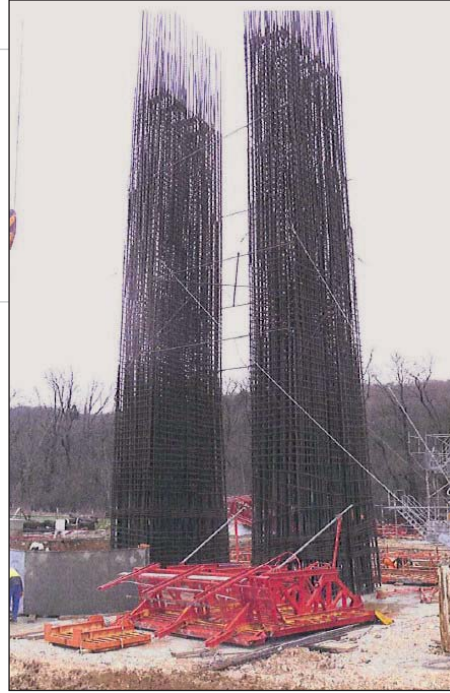
Photo 6 Pose du second fût pile P6 (Lizaine) Placing the second shaft of pier P6 (Lizaine)
