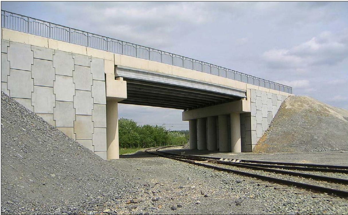
Photo 11 Poutres en BFUP - Pont à Saint-Pierre-la-Cour UHPFRC beams - Bridge at Saint-Pierre-La-Cour
