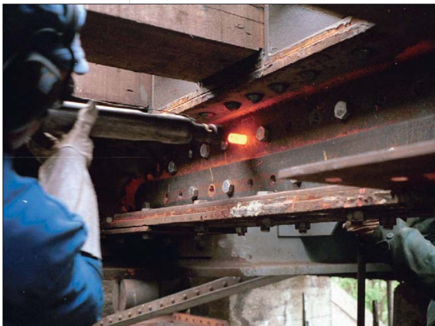
Pose de rivet à chaud Hot riveting
