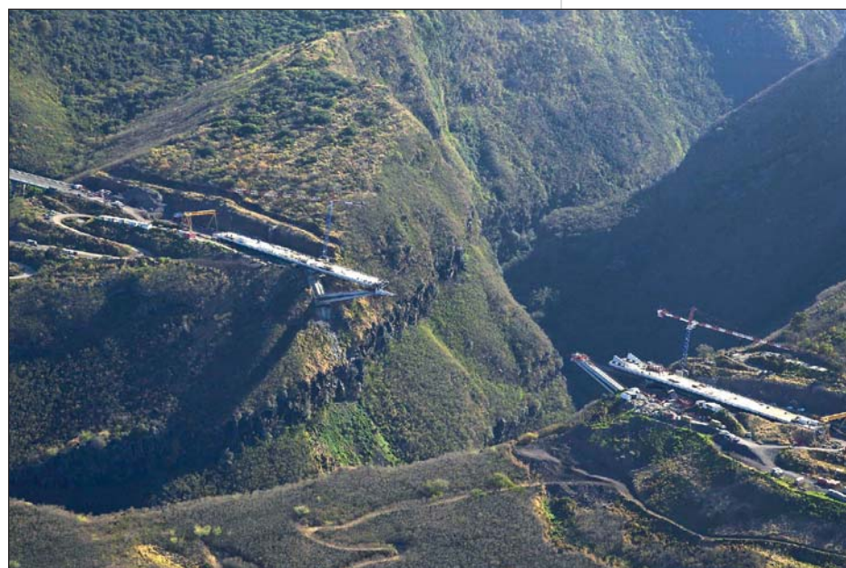
Photo 21 Ouvrage après lançage L3 en rive droite Structure after launching L3 on the right bank
