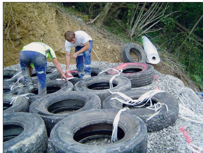
Photo 3 Opération de ligature des pneus Tyre tying operation
