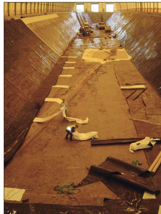
Photo 2 Aménagement d'une alvéole Development of a compartment
