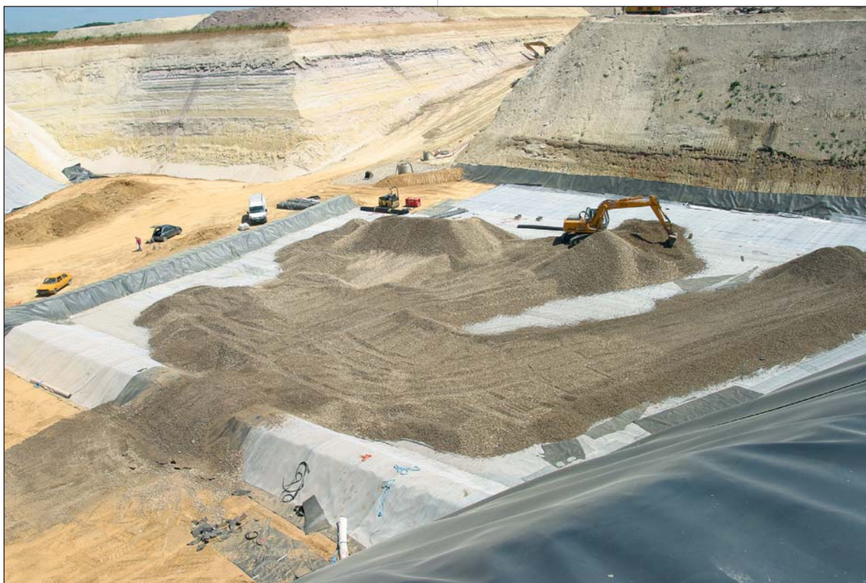
Photo 1 ISDND d'Attainville, vue du dispositif d'étanchéité- drainage en fond Attainville non-hazardous waste storage facility, view of the sealing-drainage system in the background
