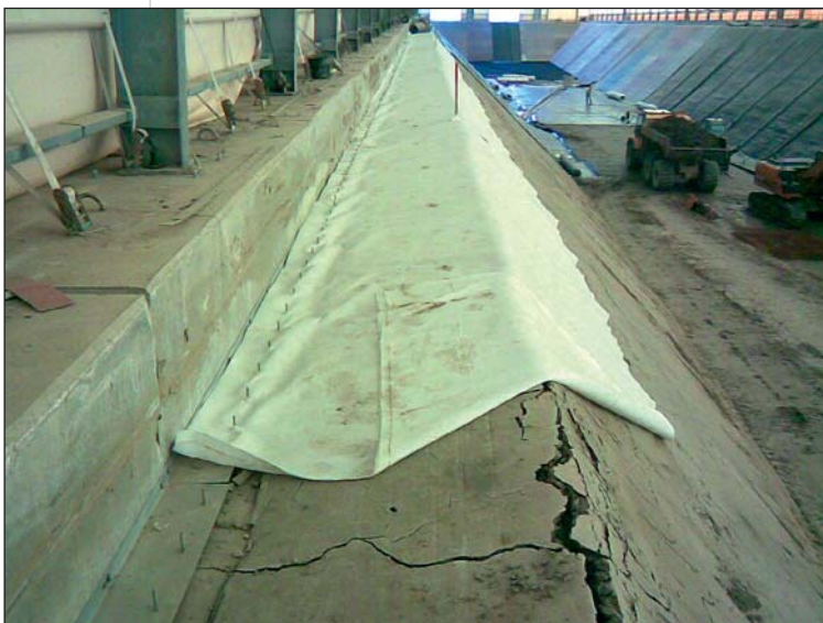
Photo 1 Ancrage des géosynthétiques Geosynthetic clay liner anchorage
