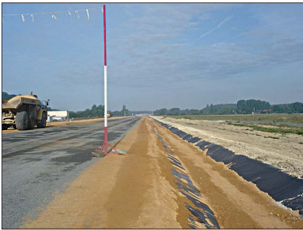
Photo 3 A28 - Mise en oeuvre de la terre A28 - Placing earth
