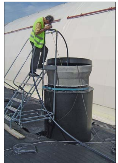
Photo 11 Coulisseau du puits de drainage Drainage shaft slide
