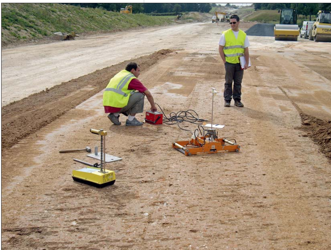
Photo 5 Contrôles de compacité Compaction tests
