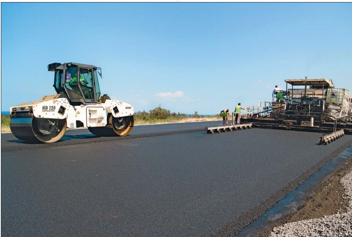
Photo 9 Répandage et compactage de la couche de liaison Spreading and compacting the base course
