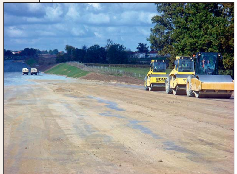
Photo 1 Vue générale de la déviation General view of the bypass
