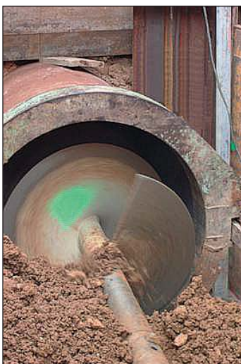
Photo 6 Forage à la tarière Auger drilling
