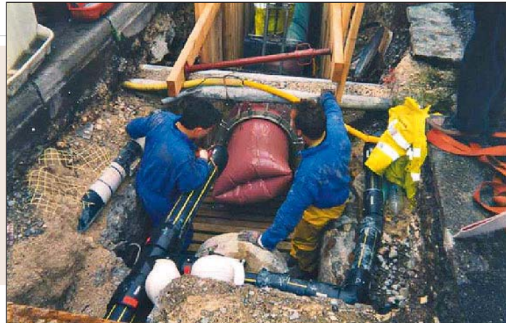
Photos 7 et 8 Rénovation : chemisage polymérisé en place Renovation : in situ polymerised lining
