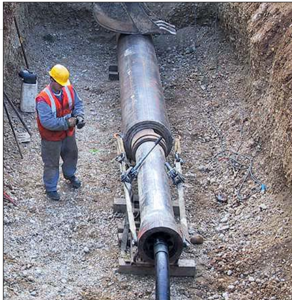
Photo 5 Pousse tube Pipe jack
