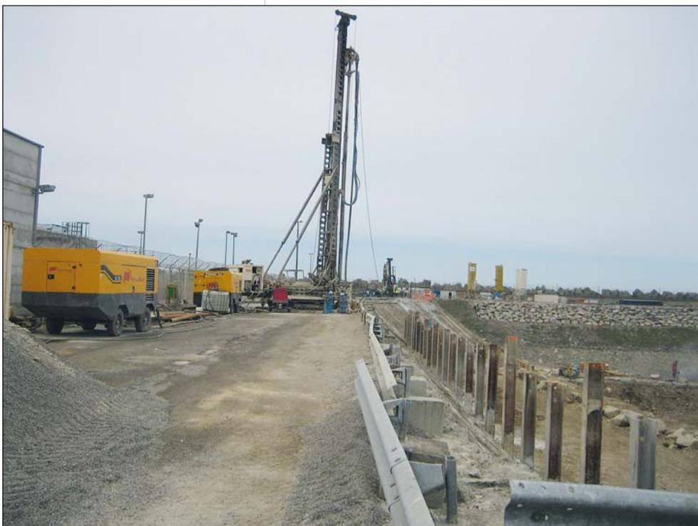
Voile d'étanchéité par injections
