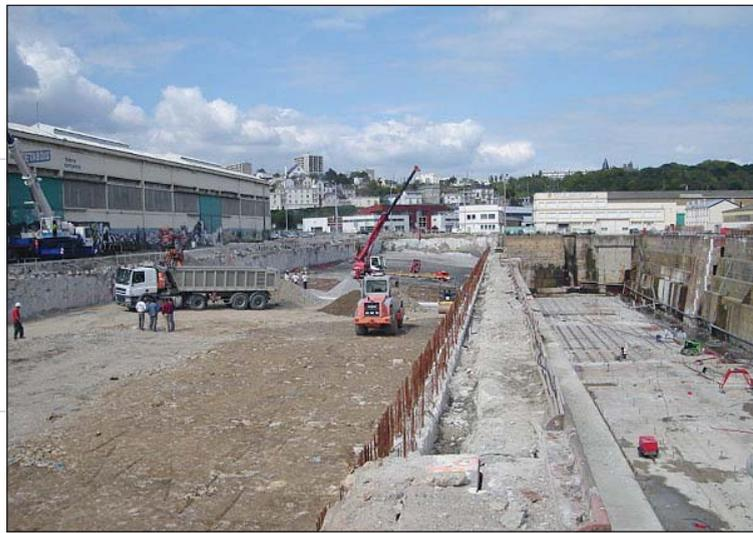
La solution de base prévoyait deux lits de butons entre la paroi et le bajoyer, dont un lit à plusieurs mètres de hauteur, sur une largeur d'une trentaine de mètres en travers de la forme.
