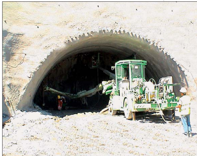
Photo 3 Deuxième voûte parapluie au front sud Second umbrella arch on the South face
