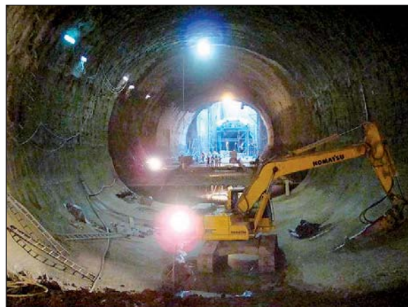
Photo 6 Section achevée (revêtement primaire) Completed section (primary lining)
