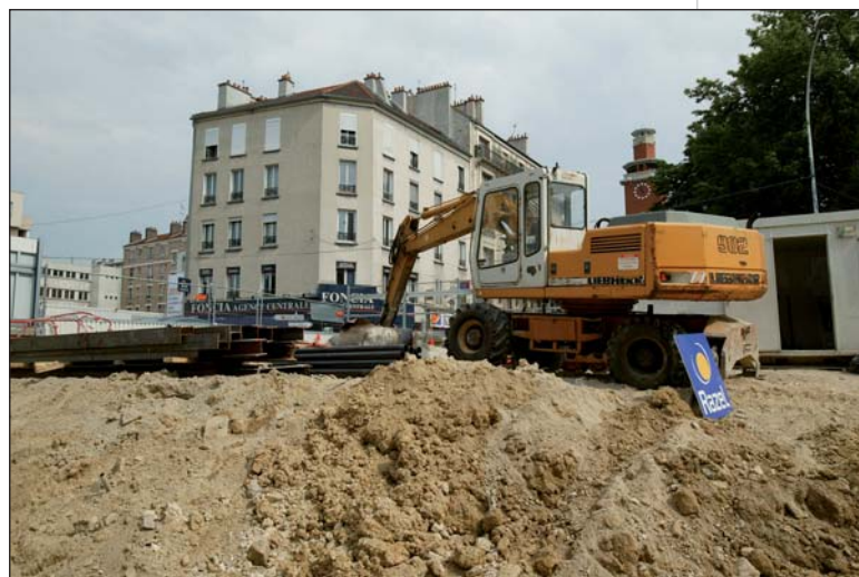
Photo 1 Le chantier, qui s'inscrit dans un milieu urbain particulièrement dense, comportera jusqu'à six zones de travaux en simultanée The project, which is carried out in an extremely dense urban environment, will entail up to six simultaneous work areas
