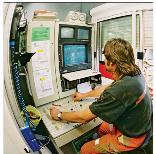
Photo 4 Container de pilotage du microtunnelier Microtunneller control container
