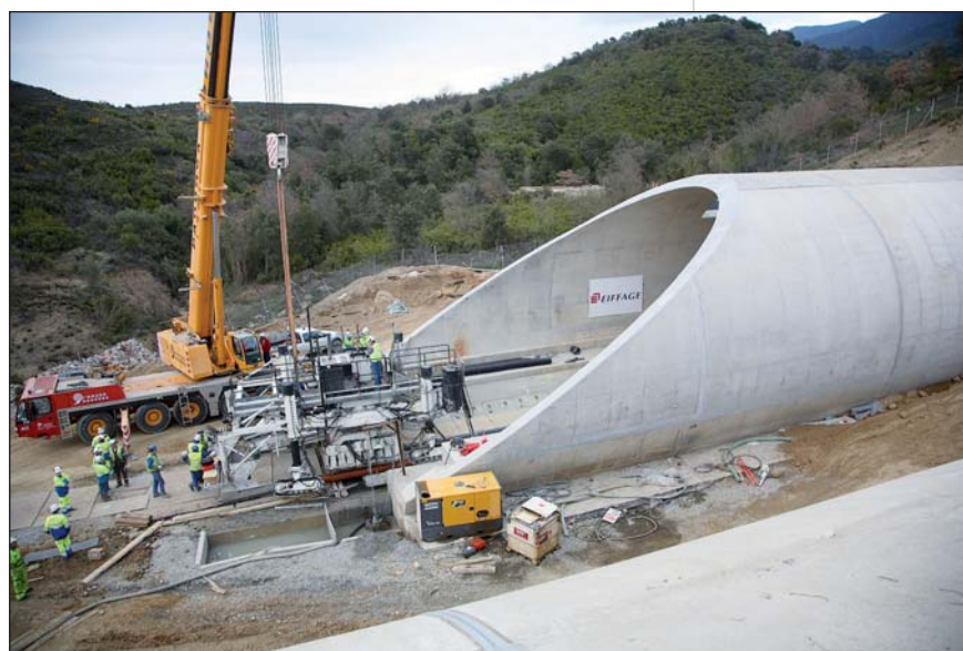
Photo 1 Mise en place de la machine pour radier à l'entrée du tube Setting up the invert pouring machine at the tube entrance
