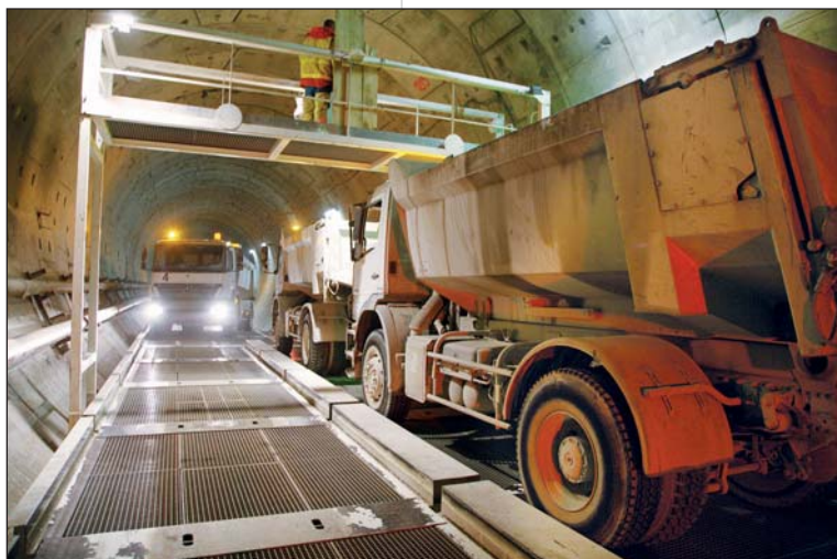
Photo 2 Plate-forme de croisement Cross-passage platform
