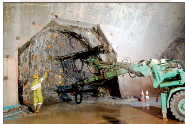
Photo 1 Creusement et bétonnage des seize abris et des cinq sous-stations électriques Excavation and concreting of the 16 shelters and 5 electric sub-stations
