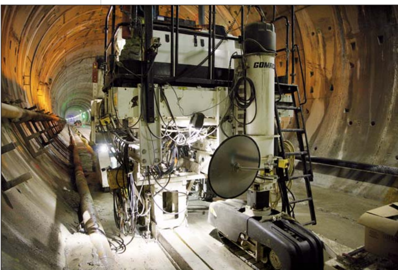
Photo 8 Coulage caniveau à fente Slotted gutter casting
