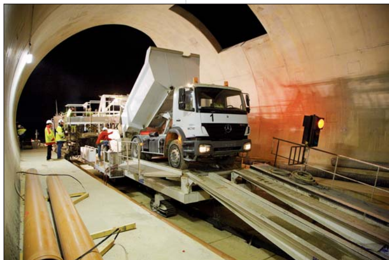
Photo 3 Alimentateur frontal intégrant une plate-forme de retournement Front-end feeder including an overturning platform
