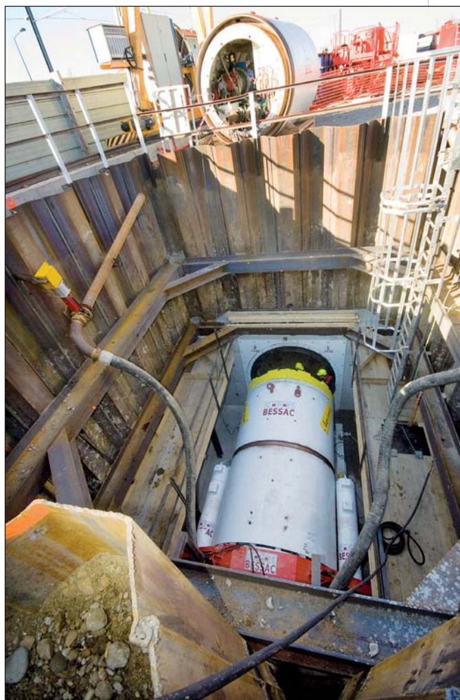
Photo 1 Puits d'attaque du tunnelier Tunneller entry shaft
