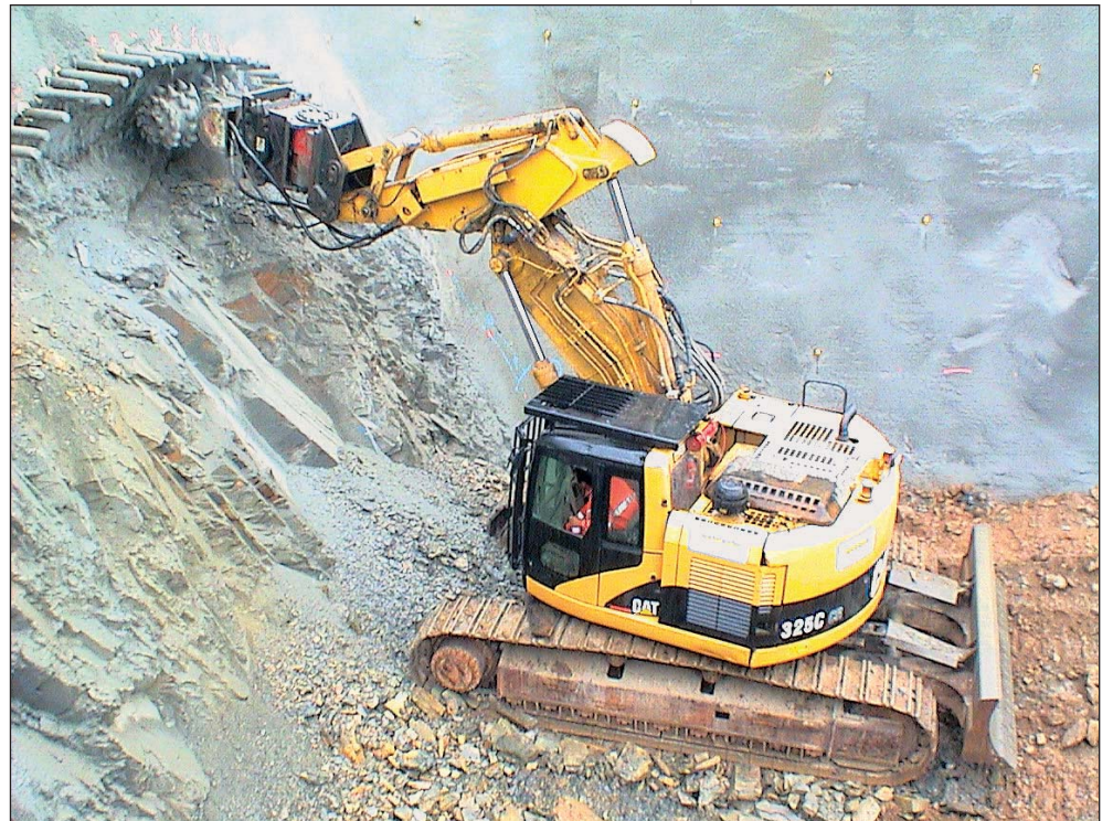
Photo 1 Attaque d'excavation du front nord North face excavation drilling
