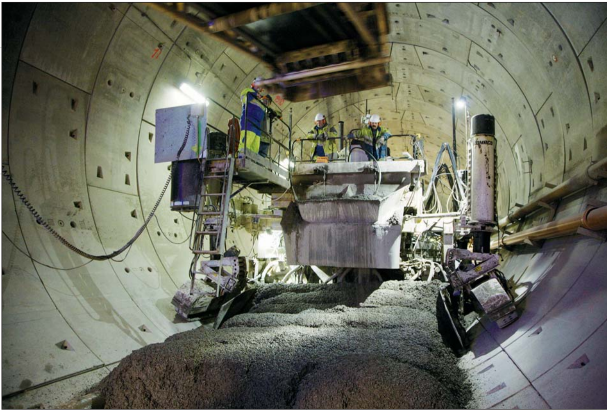
Photo 4 Mise en œuvre du radier Placing the invert
