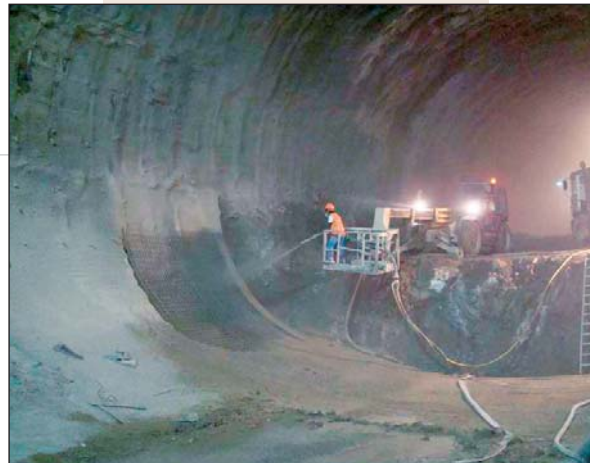
Photos 4 et 5 Section en phase de rabaissement Section during lowering phase
