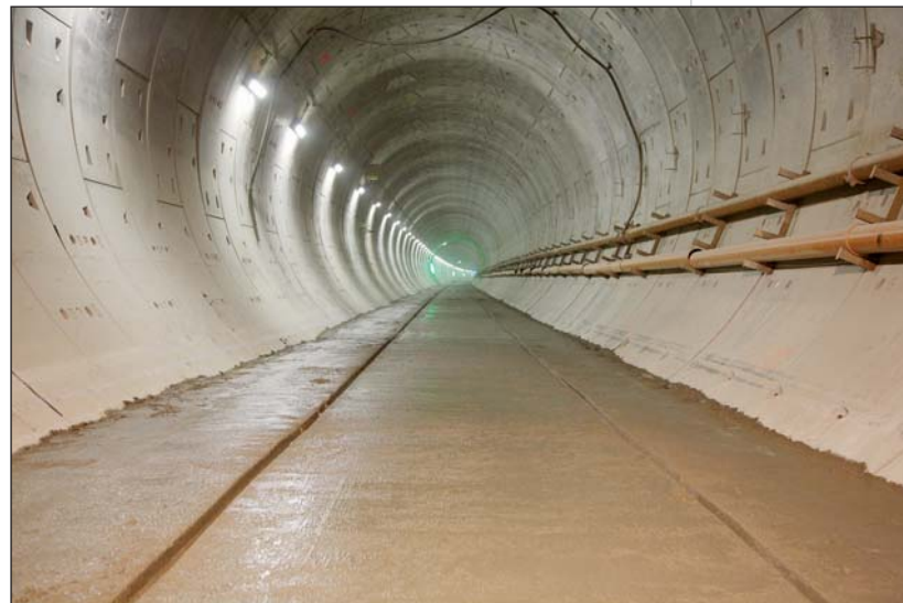
Photo 5 Vue générale du radier General view of the invert
