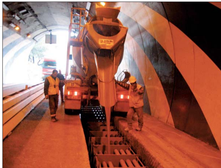
Photo 2 Coulage du béton d'une multitubulaire (chantier de rénovation des tunnels du contournement de Nice sur A8) Pouring concrete for a multitube system (project for renovation of Nice bypass tunnels on A8 motorway)
