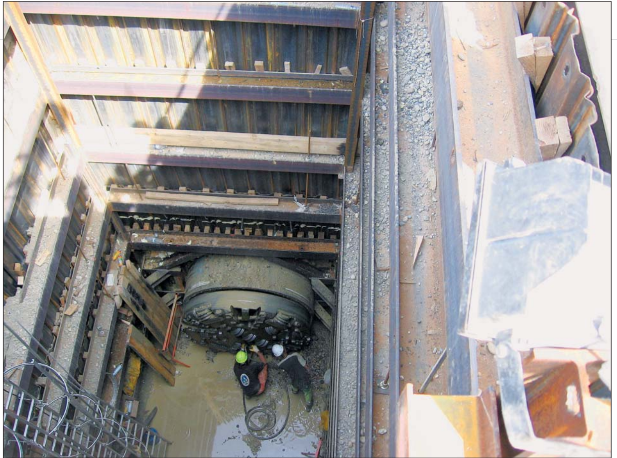
Photo 2 Puits de sortie Exit shaft
