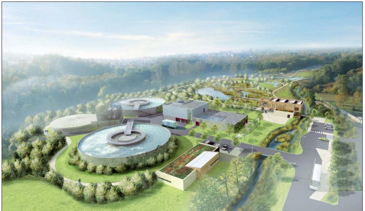
**La station d'épuration du Moulin Neuf, qui offrira une capacité de 60 000 équivalents-habitants, sera la plus grande installation hexagonale de ce type à bénéficier du procédé de traitement membranaire Ultrafor®. L'utilisation de la technique de préchargement a également permis la construction sur fondation superficielle en supprimant la nécessité de réaliser des fondations profondes.**
