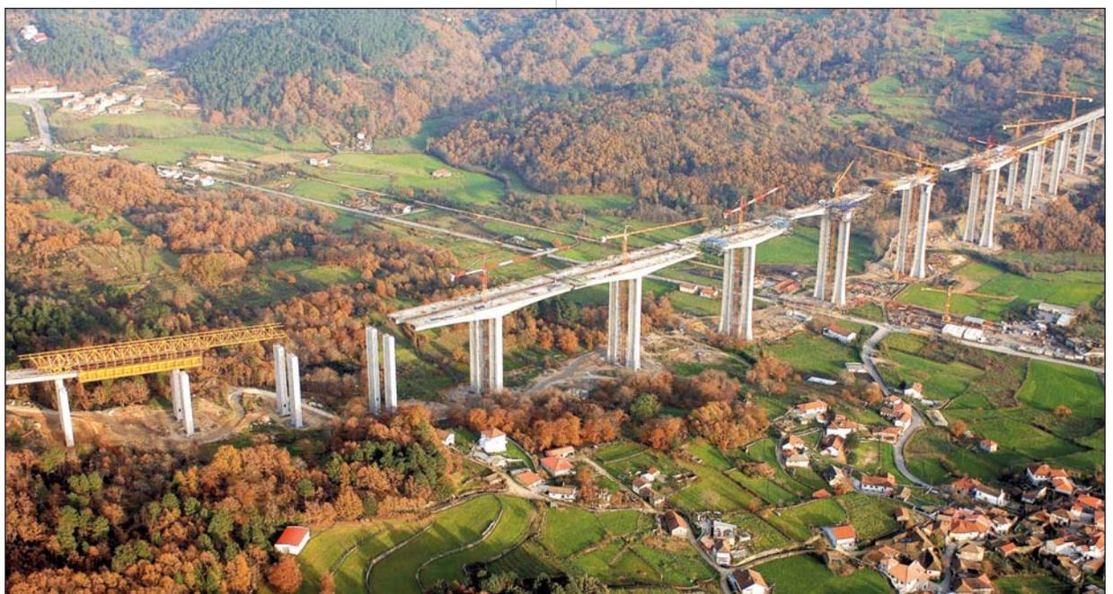
caisson ainsi que sur le hourdis inférieur, rigidifiant ainsi notablement la jonction naturellement souple des deux fléaux. De façon classique, les premières mises en tension des câbles éclisses avaient lieu alors que le béton du voussoir de clavage ne présentait encore que des niveaux de résistance assez faibles, et ce afin de limiter les effets des variations de longueur dues aux effets thermiques.
