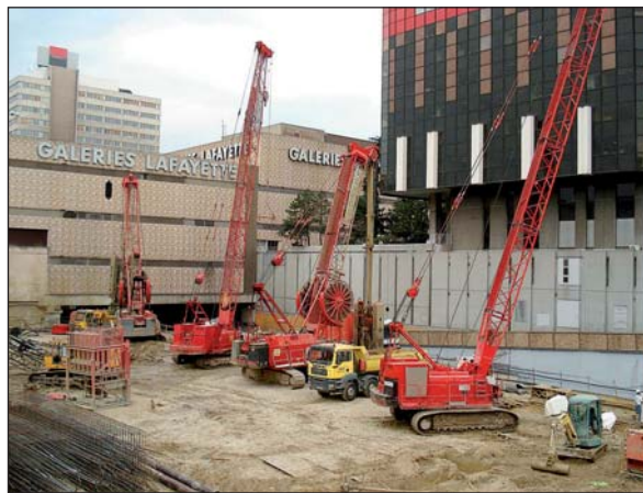
Photo 3 Benne hydraulique KS en cours d'excavation KS hydraulic grab during excavation
