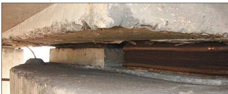
Photo 19 Vue sur un appui avec le calage de construction en charge sur les bossages de vérinage A support with the construction bracing under load on the jacking anchor blocks
