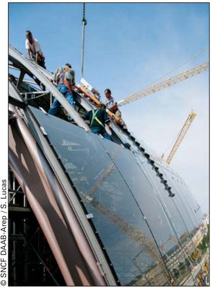
Photo 8 La verrière très bombée est constituée de panneaux cintrés à froid sur gabarit The highly convex glass roof is formed of panels cold bent on a template
