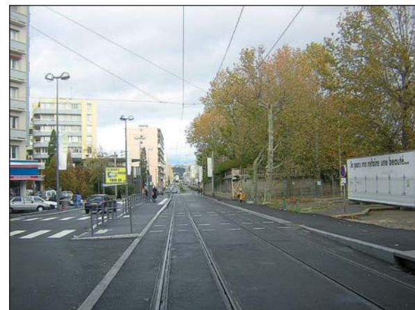
Photo 13 Station de la « Cité du Design » (en attente des aménagements définitifs) "Cité du Design" Station (pending final improvements)
