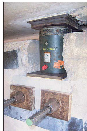
Photo 17 Vue sur un point de vérinage A jacking point
