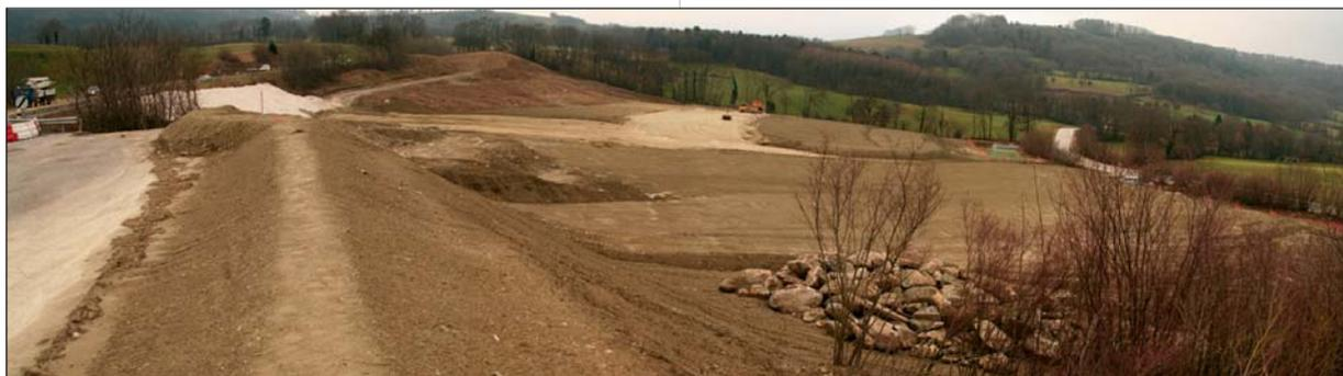
(non prévu dans le mouvement des terres d'ATMB). Le mouvement de ces impropres et excédents a fait l'objet d'importantes décisions. En effet, le morcellement de la section, la concentration de ces matériaux dans certaines buttes et sous-sections, et le planning tendu de l'opération nécessitaient de maîtriser des zones de matériaux excédentaires à proximité des zones d'extraction.
