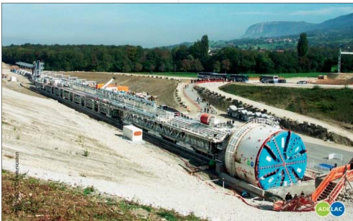
le revêtement déjà posé. L'excavation s'arrête ainsi à la fin de l'allongement des vérins. Le revêtement est alors assemblé à l'abri de la jupe, après rétraction de l'ensemble des vérins de poussée. Une fois l'anneau entièrement assemblé, les vérins sont alors remis en pression, le ramenant ainsi contre le précédent. Le creusement peut alors reprendre pour un nouveau cycle.
