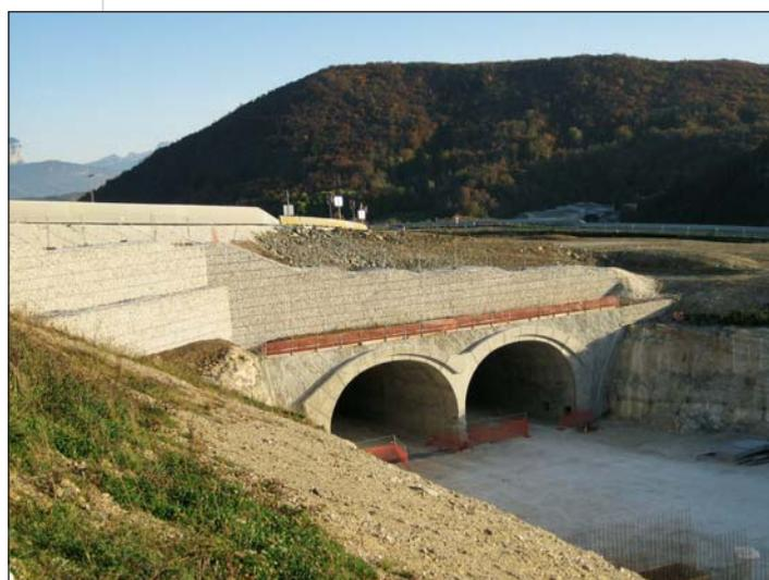
En zone de sismicité Ib, l'ouvrage classé en catégorie C, est dimensionné avec une accélération nominale  $a_N = 2,0 \text{ m/s}^2$ .
