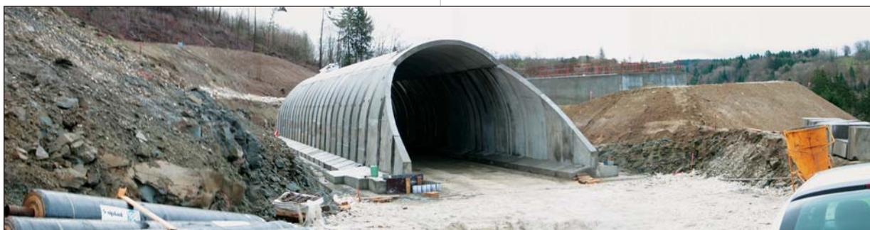
de la présence d'un ouvrage voûte existant pré-contraint en pied. L'opération de raboutage d'une extension se révélant trop délicate pour être envisagée. Les appuis réalisés en sol renforcé évitent de surcharger l'ouvrage existant.
