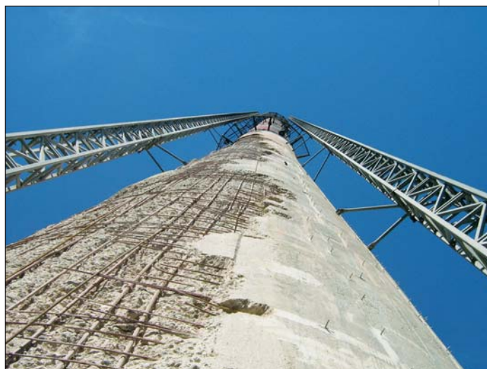
Photo 3 Paroi extérieure de la cheminée une fois les bétons purgés Outer skin of the chimney once the concrete has been bled
