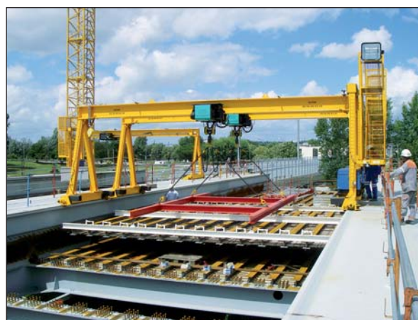
Photo 17 Approvisionnement des paniers préfabriqués de TPE Procurement of prefabricated TPE baskets
