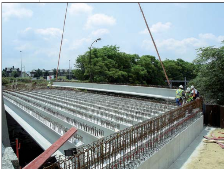
Photo 4 Pose des poutres Placing the beams
