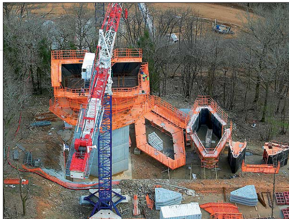
Photo 3 Coffrages des piles Pier formwork
