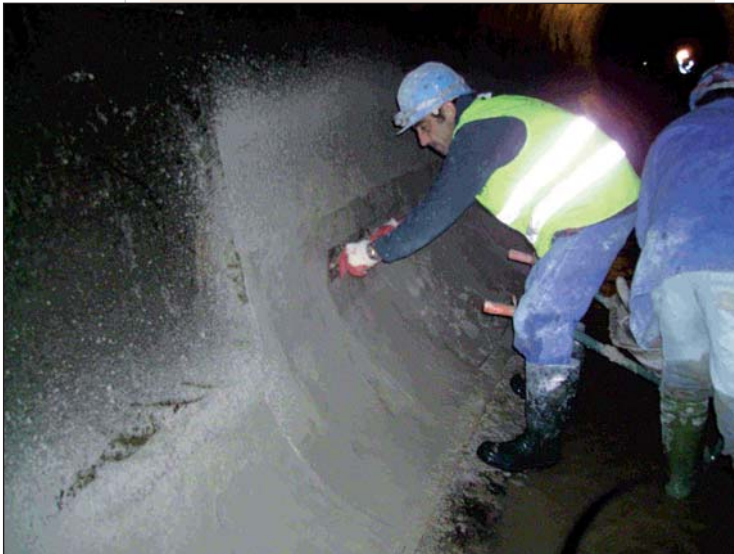
Photos 1 et 2 Enduit sur piédroits Rendering on side walls
