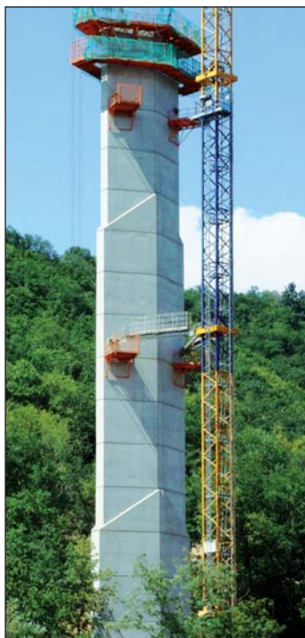
Photo 5 La pile P3 en cours d'exécution Pier P3 in progress
