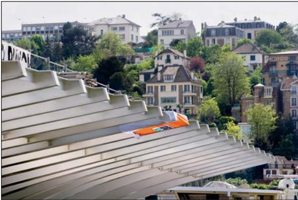
Photo 8 Les encorbellements Cantilevering
