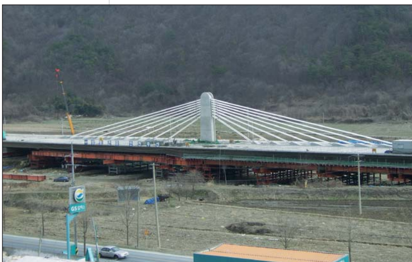
Photo 3 Vue générale du pont extradossé de Shindae en Corée du Sud General view of Shindae curved bridge in South Korea
