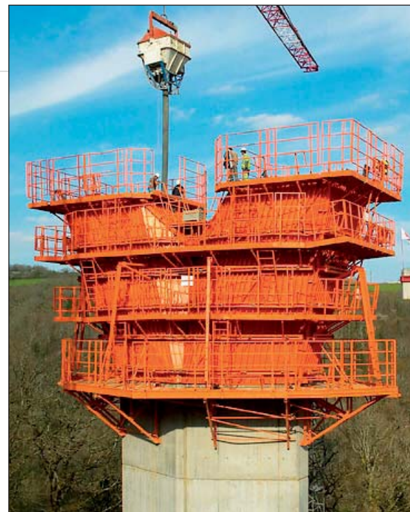
Photo 6 Coffrage d'un chevêtre Formwork for a crosshead beam
