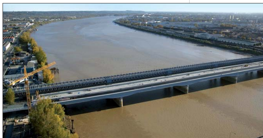
Photo 19 Avancement du chantier (novembre 2007) Site progress (November 2007)
