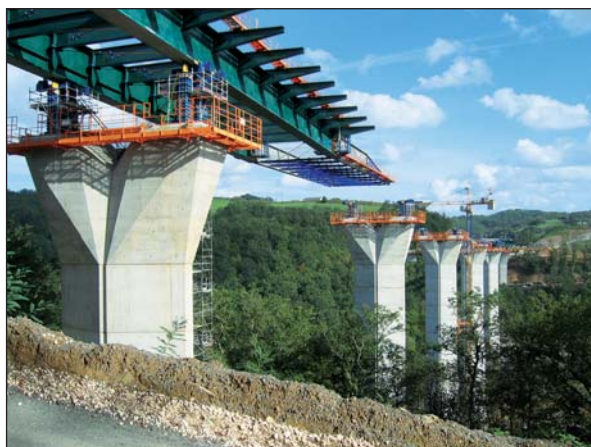
Photo 6 Coffrage d'un chevêtre Formwork for a crosshead beam
