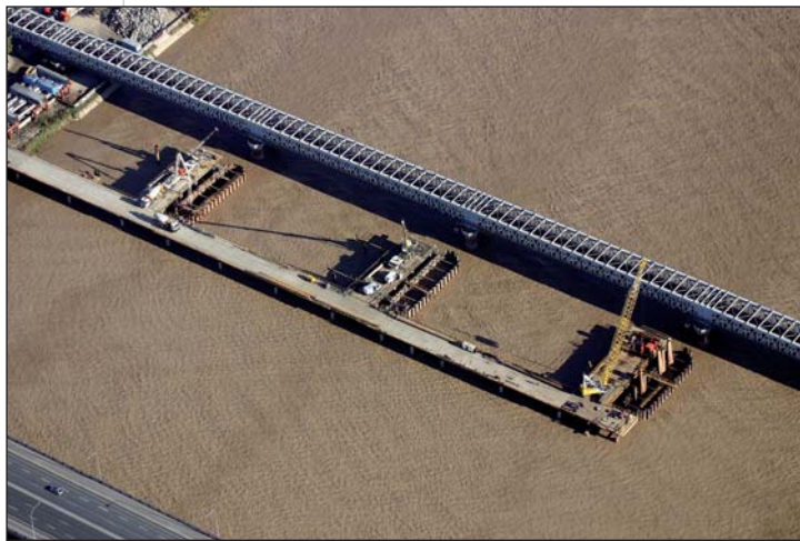
Estacade en rive droite Breakwater on the right bank
