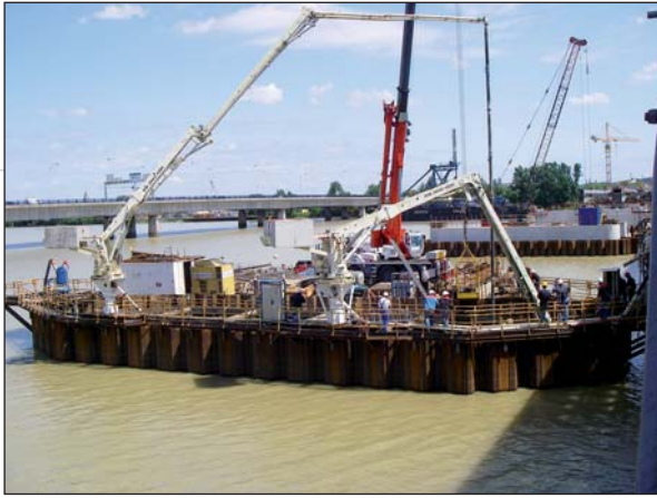
Photo 4 Mâts de bétonnage sur batardeau P6 Concreting masts on cofferdam P6
