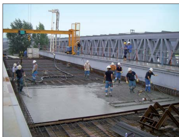
Photo 18 Premier bétonnage de dalle sur le hourdis amont Initial slab concreting on the upstream deck section
