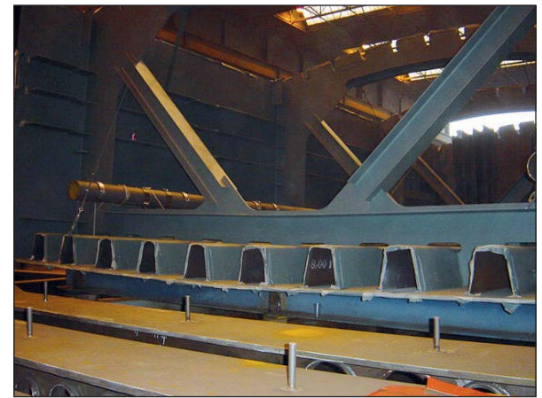
Photo 1 Vue (retournée) du raidissage interne du tablier View (reversed) of deck internal stiffening
