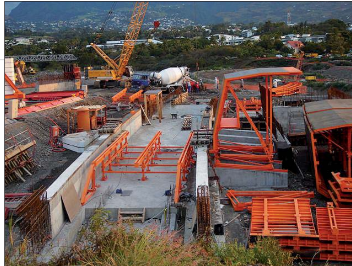
Photo 7 Montage des coffrages du caisson Erection of caisson formwork
