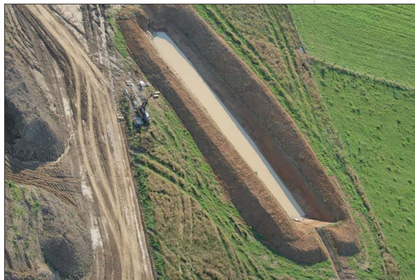
Photo 7 Bassin de décantation Settling pond
