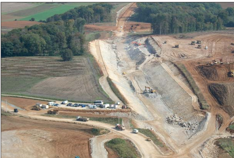
Photo 2 Vue aérienne du D94 Aerial view of D 94
