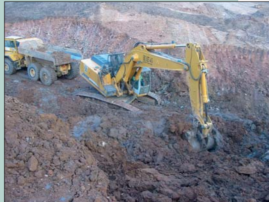
Photo 7 Réalisation d'une purge en assise de remblai Execution of drainage at the base of the embankment
