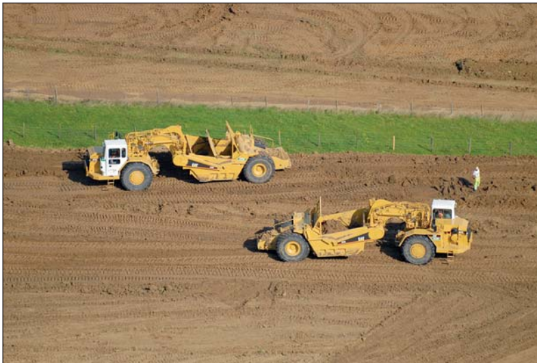
Photo 1 Échelon de décapeuses Fleet of scrapers
