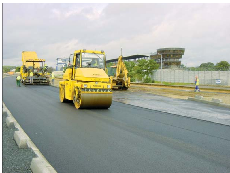
Photo 6 Chantier en enrobés 3E réalisé à proximité du circuit automobile du Mans Low-energy environmentally friendly asphalts project carried out near Le Mans race track
