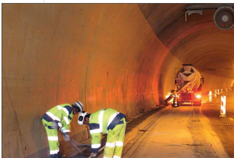
Photo 4 Coulage de béton en tranchée multi-alvéolaire Pouring concrete in multi-cellular trenches
