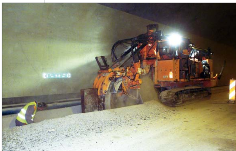
Photo 5 Creusement des caniveaux Excavation of gutters
