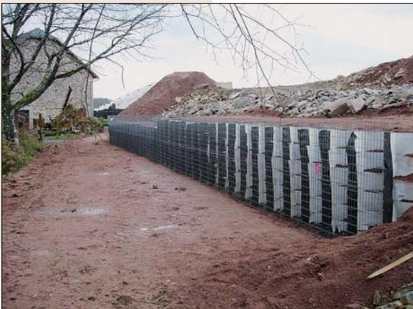
▶ Ainsi, sur ce projet, 1700 m<sup>2</sup> de structure M3S® ont été mis en place sur trois remblais tout en réutilisant les matériaux de déblais avec un suivi rigoureux tant en terme de contrôle des matériaux que de contrôle de compactage. ■
