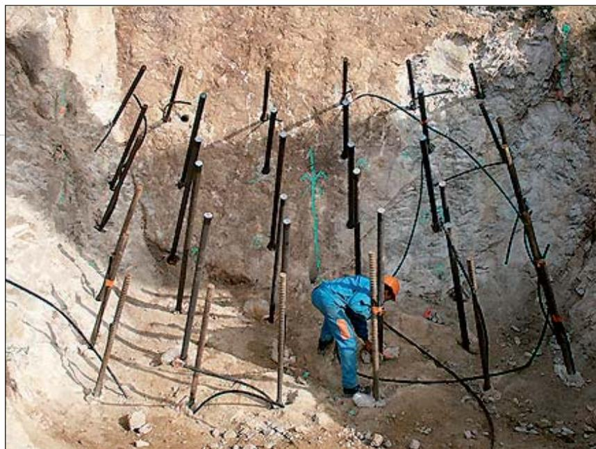
(30 HA 50 côté sud et 40 HA50 côté nord à ce stade) avait été déterminé à partir des résultats d'essais dilatométriques réalisés dans le massif rocheux dans la zone de diffusion des contraintes des fondations des béquilles. Les ancrages passifs ont été implantés dans le massif selon un cône correspondant à la diffusion des efforts apportés par les béquilles.
