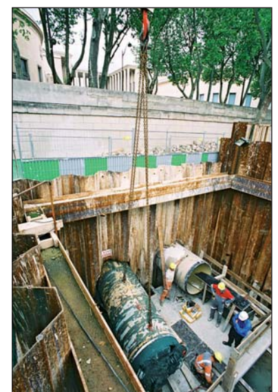
Photo 8 Sortie du tunnelier TBM exit
