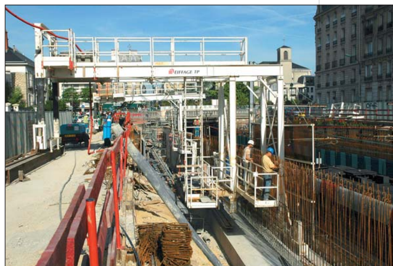
Photo 3 Portiques de ferrillage au premier plan, et de bétonnage de la couverture C Gantry cranes for steel reinforcements in the foreground, and for concreting of covering C
