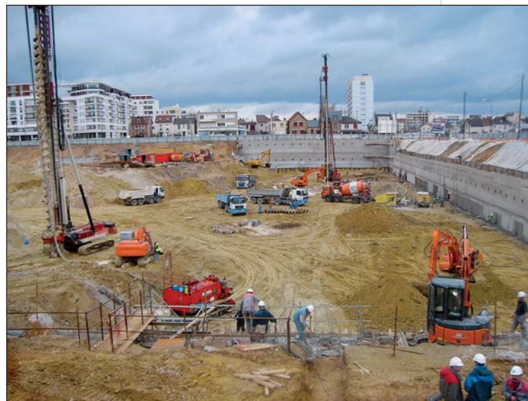
Photo 1 Vue générale montrant le soutènement par béton projeté de la paroi lutécienne en progression et l'exécution des pieux en fond de fouille General view showing the shotcreted supporting structure of the Lutetian type retaining wall in progress and execution of the piles in the bottom of excavation
