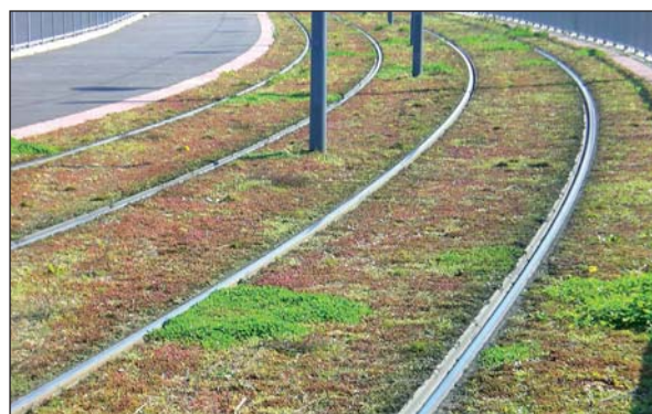
Photo 11 Sédum sur ouvrage d'art Sedum on bridge
