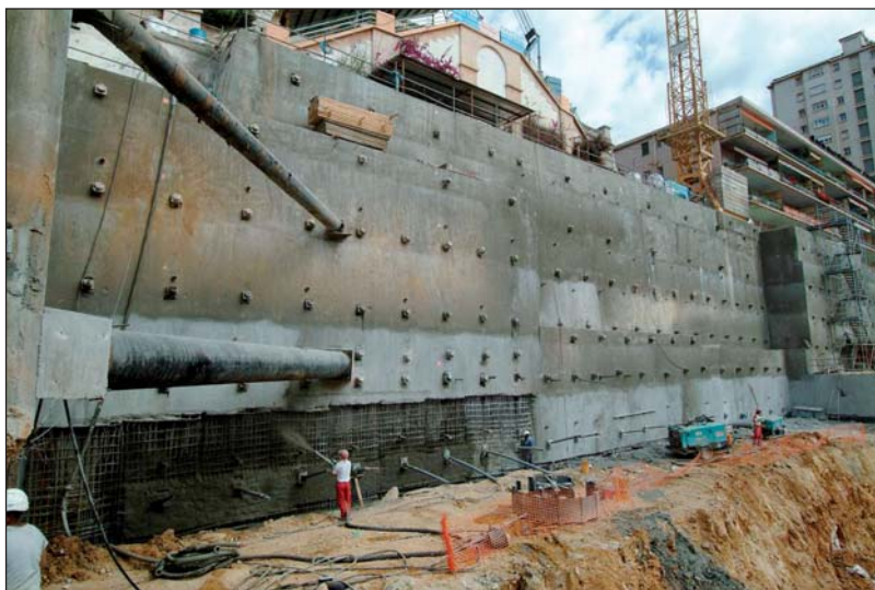
Photo 5 Béton projeté Shotcrete
