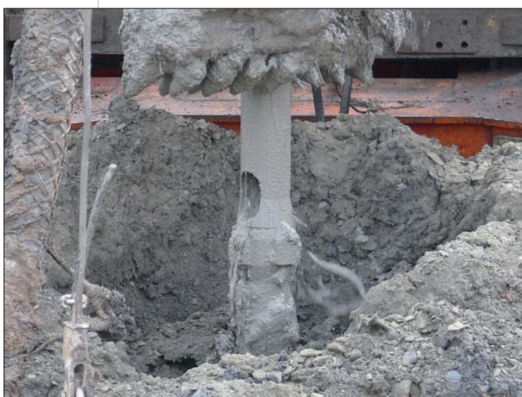
Photo 3 La pointe pilote de la tarière Starsol® Guide tip of Starsol® auger
