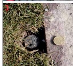
Photo 9 et 10 Circuit d'arrosage et vue d'une tête d'arrosage Sprinkling circuit and view of a sprinkler head
