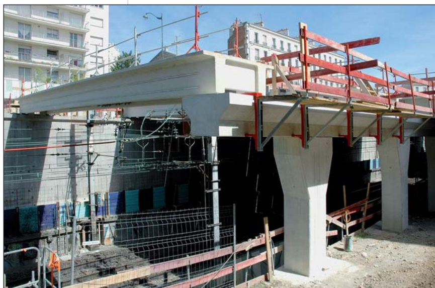
Photo 5 Poutre TT posée en travée centrale avec rail Halfen pour accrochage caténaire TT girder placed in centre span with Halfen rail for catenary system attachment
