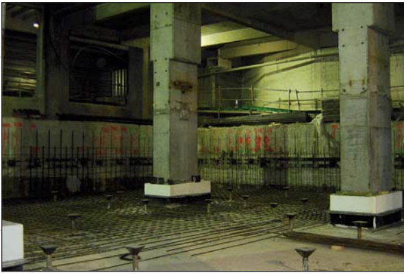
Photo 5 Micropieux d'ancrage du radier Micropiles for foundation raft anchoring
