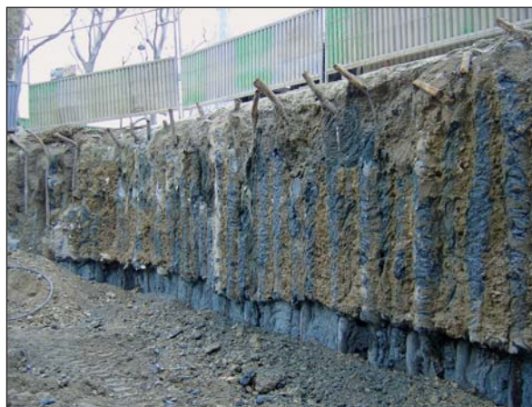
Photo 1 Microberlinoise périphérique Peripheral micropile Berlin wall
