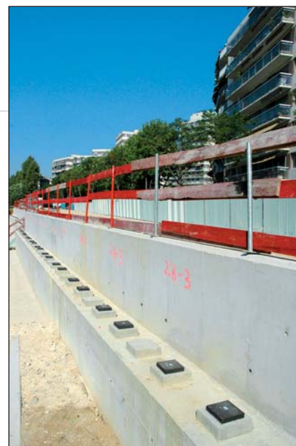
Photo 4 Appuis Néoprène en attente de pose des poutres TT Neoprene supports pending placing of TT girders
