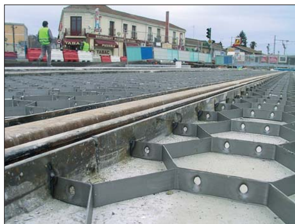
Photo 4 Métalflex Tram soudé au fer plat Métalflex Tram welded to the flat bar
