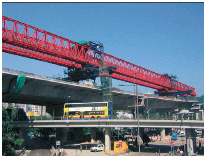
Photo 2 Cintre autolanceur capable de lever des voussoirs de 100 t Self-launching centre capable of lifting 100-tonne segments
