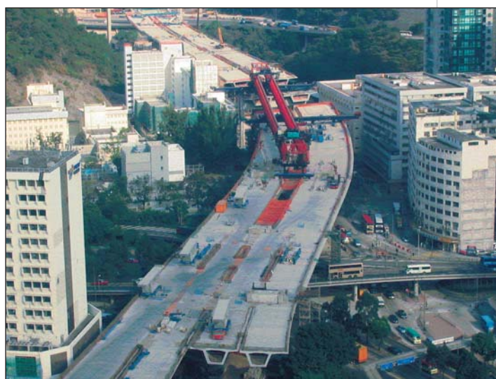
Photo 1 1766 voussoirs préfabriqués et précontraints 1,766 prefabricated, prestressed segments
