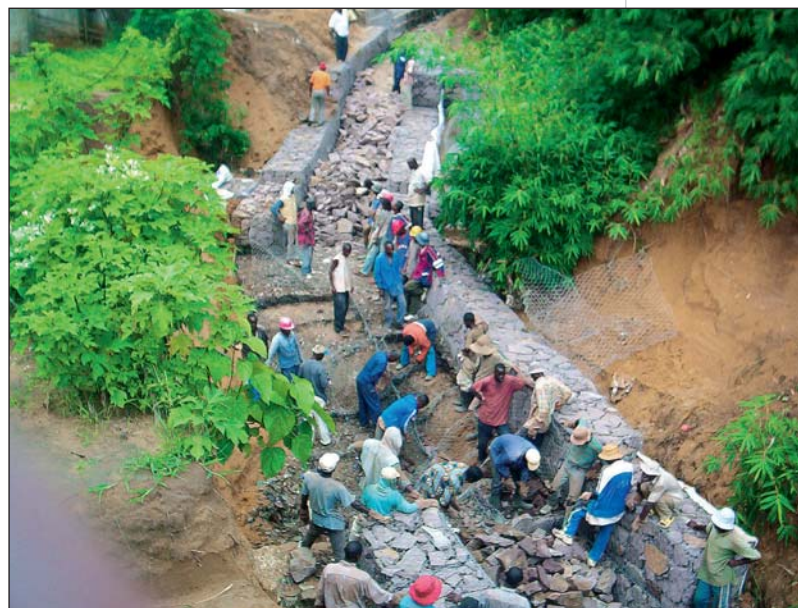
Photo 6 Mise en œuvre des gabions par la population locale Gabions being installed by the local population
