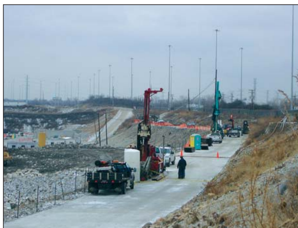
Figure 9 Machines de carottage sonore sur la plate-forme de travail Sonic Drills on Work Platform
