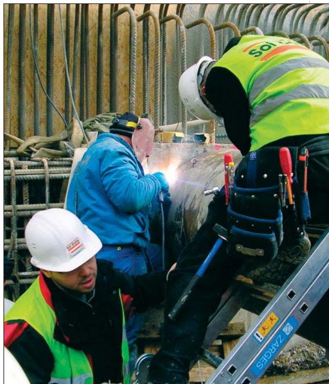
Photo 9 Installation de jauges de contraintes sur un buton pour l'entrepreneur de la station Morisz. La méthode observationnelle permet de limiter le butonnage au strict nécessaire Installation of strain gauges on a stay for the Morisz Station contractor. The observational method allows staying to be limited to strictly what is necessary
