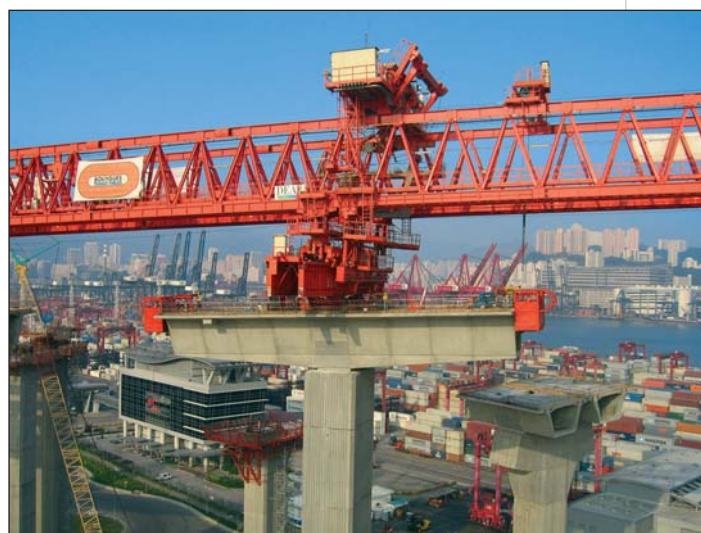
Photo 11 Pose en encorbellement Cantilever placing
