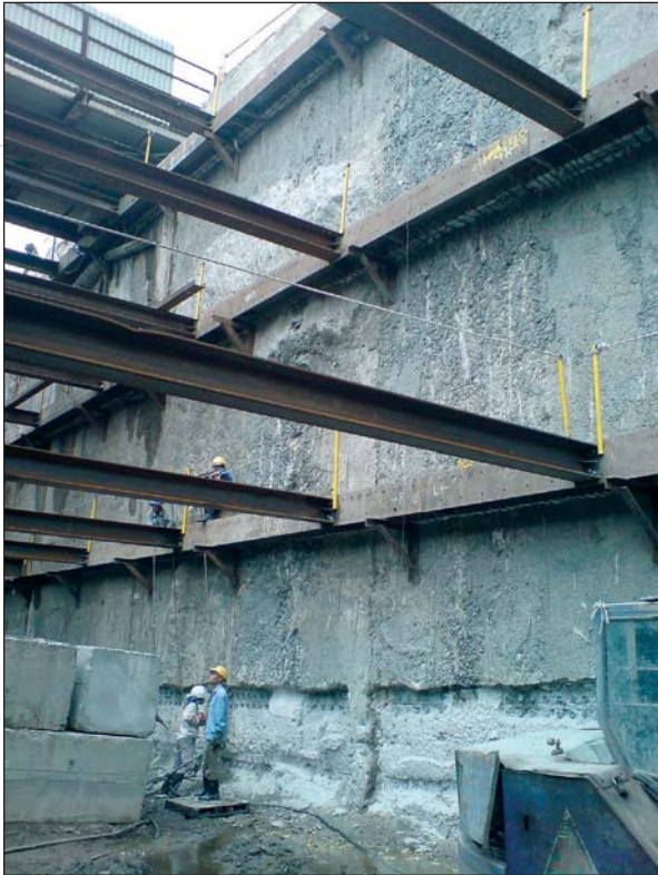
Figure 10 Paroi moulée butonnée, côté Thu Thiem Stayed diaphragm wall, Thu Thiem side
