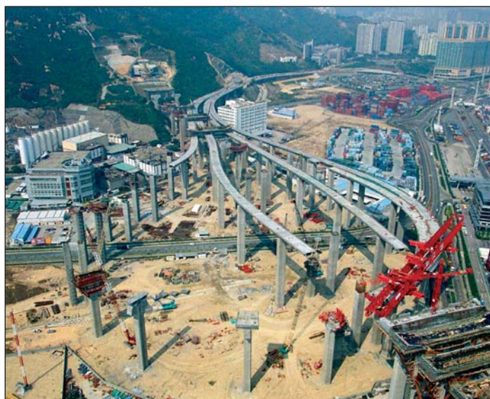
Photo 7 Vue aérienne Aerial view
