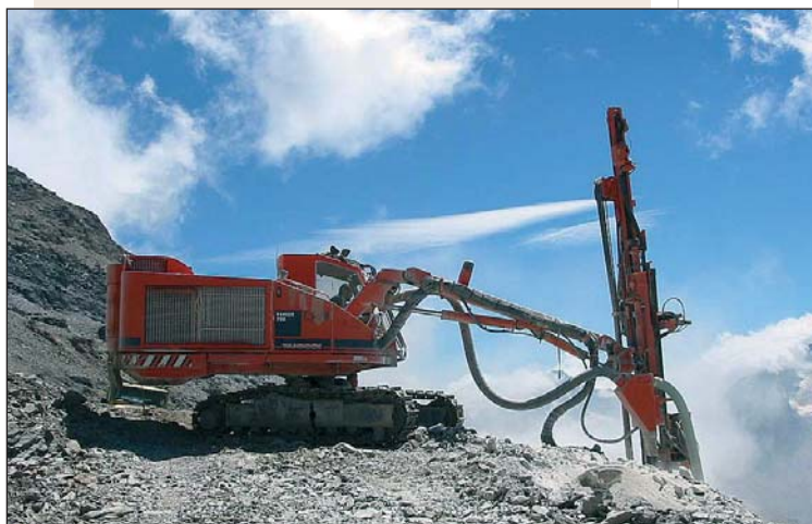
Photos 1 et 2 Chantier en cours aux Deux-Alpes Works in progress at Deux-Alpes
