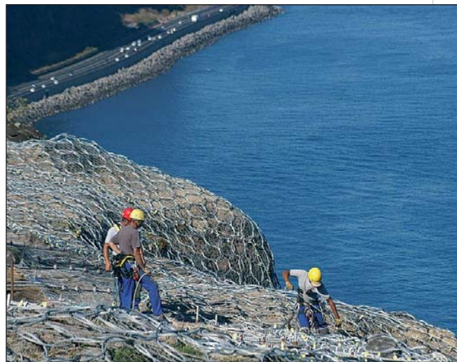
Photo 3 Un ouvrage en filets pendus A hanging net structure
