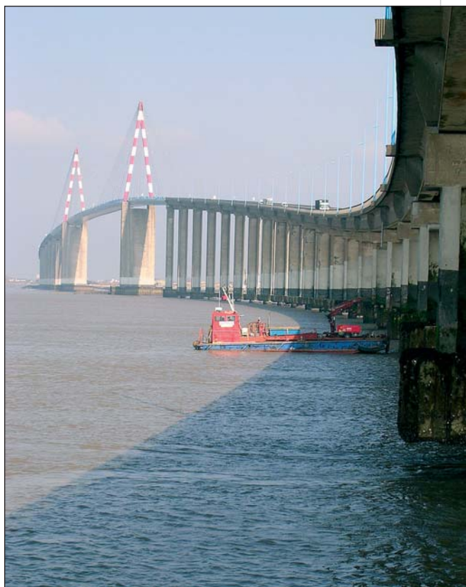
Photo 8 Pont de Saint-Nazaire Saint-Nazaire bridge
