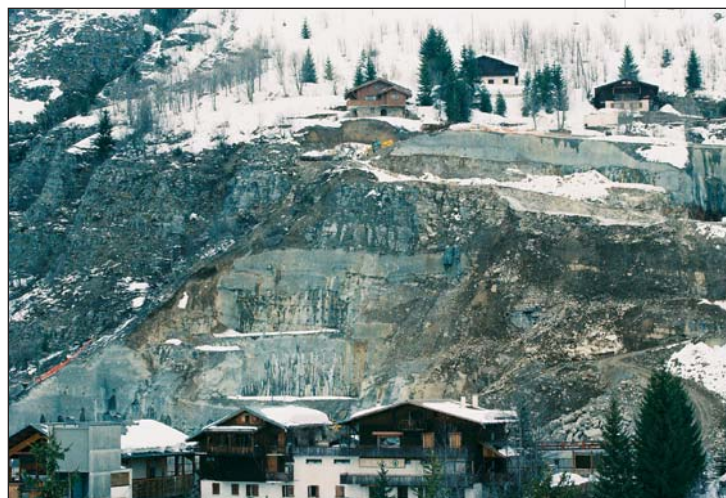
Photo 1 Vue du chantier View of the site
