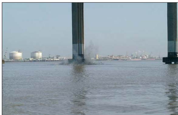
Photo 11 Exécution du tir Performing blasting
