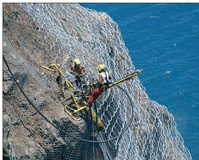
Photo 4 Un ouvrage en filets plaqués A clinging net structure
