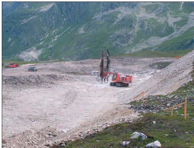
Photo 3 Chantier en cours à La Plagne Works in progress at La Plagne
