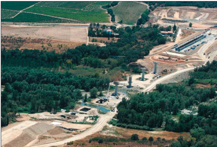
Photo 13 VIA 15.65 – Charpente en cours d'assemblage sur la plate-forme VIA 15.65 – Structure undergoing assembly on subgrade
