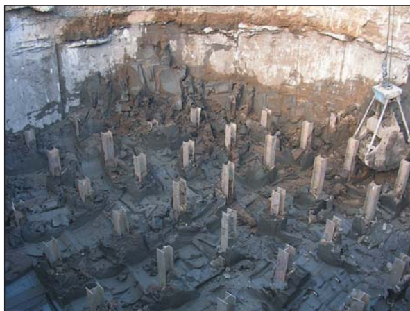
Photo 8 Renforcement des argiles par inclusion d'HEA 300 Clay reinforcement with HEA 300 steel
