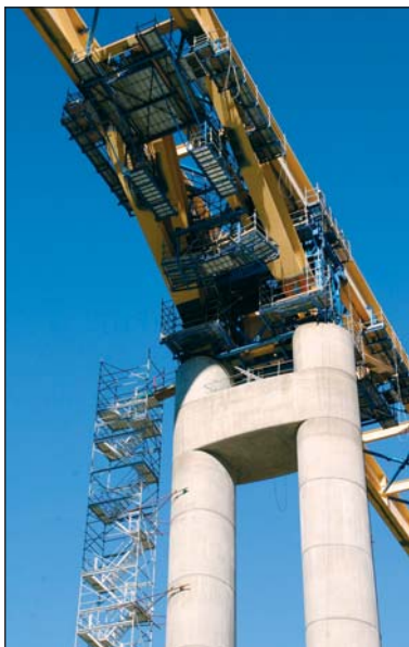
Photo 23 La complexité de la réalisation des bracons in situ The complexity of in-situ stay execution
