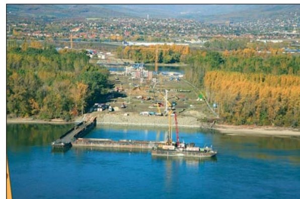
Photo 4 Forage de pieux à terre et en rivière à Budapest Pile drilling on land and in the river in Budapest
