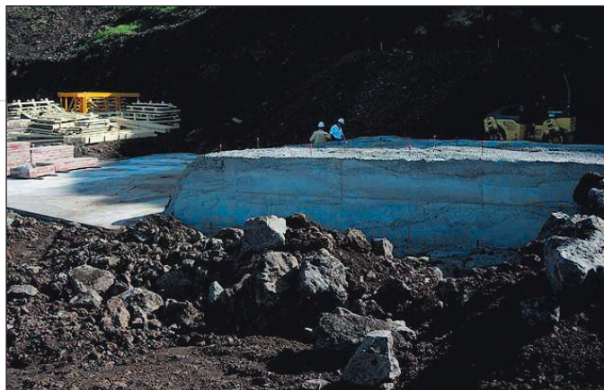
Photo 4 Béton de substitution sur C4 Concrete substitute on C4
