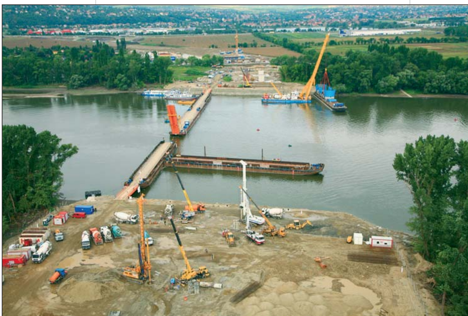
Photo 5 Passerelle du pont de bateaux en position ouverte à Budapest Foot bridge on the boat bridge in open position in Budapest
