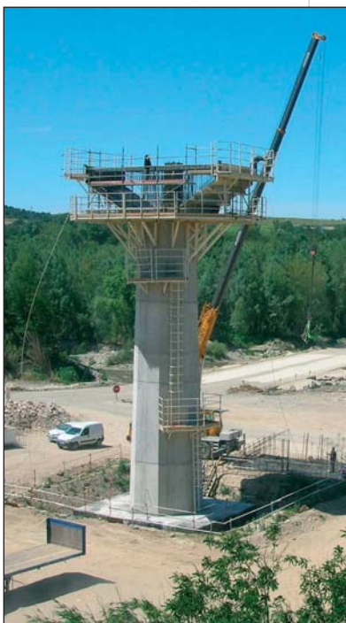
Photos 7 et 8 VIA 15.65 – Coffrage des piles (fût - chevêtre) VIA 15.65 – Pier formwork (shaft - header)
