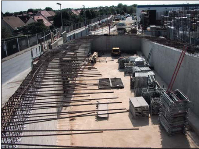
Photo 16 Réalisation de la rampe voie des Laitières Construction of the "voie des Laitières" ramp
