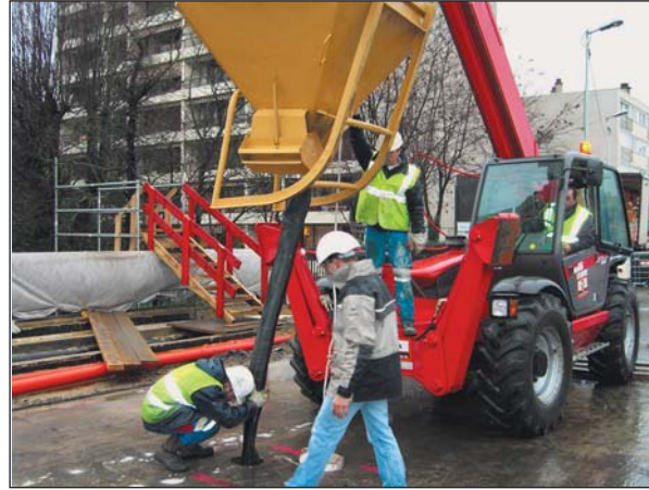
Photo 5 Coulage par cheminée Pouring via channel
