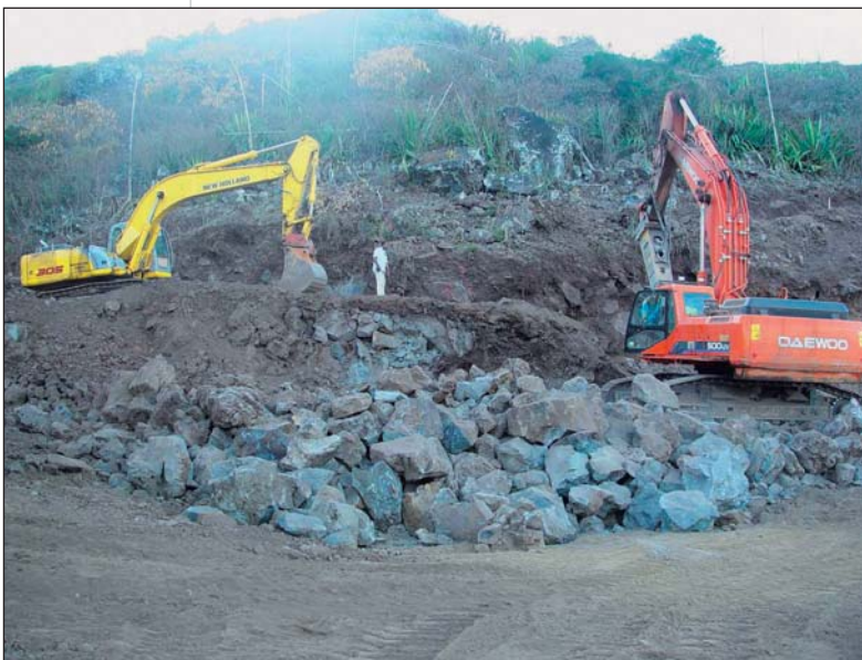
Photo 2 Terrassements des plates-formes et fouilles Foundation earthworks and excavations
