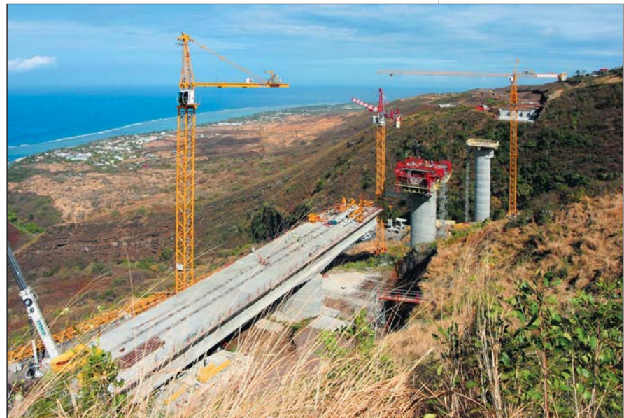
Photo 1 Avancement en décembre 2006 Progress in December 2006
