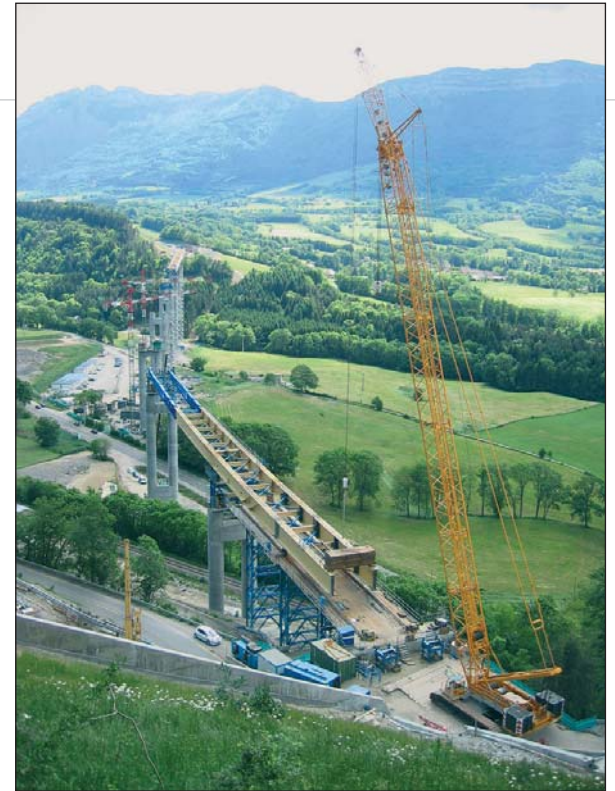
Photo 22 Lançage des tronçons de poutre métallique depuis les deux culées Launching steel girder sections from the two abutments
