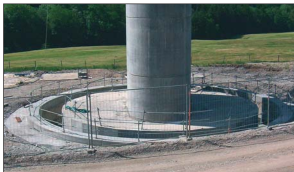
Photo 14 Fondation de la pile P5 une fois terminée Foundation of pier P5 after completion
