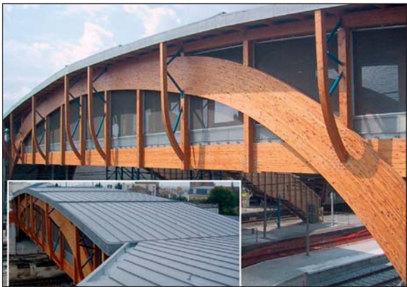
Passerelle de Vaires Vaires foot bridge
