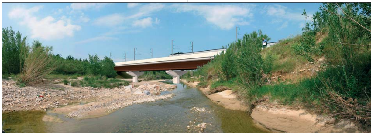
Photo 1 Viaduc sur le Réart Viaduct over the Réart
