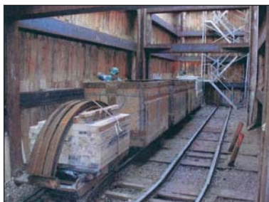
Photo 2 Le fond de puits et le train de marinage The shaft bottom and the mucking train
