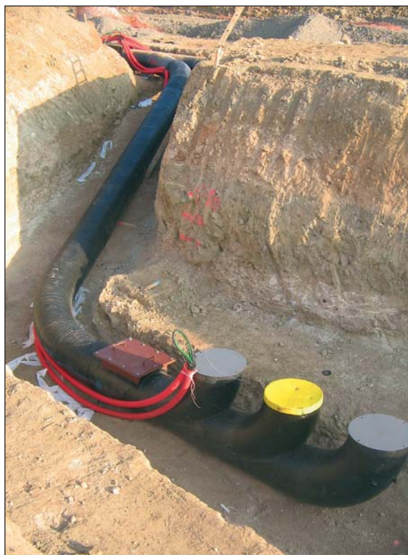
Photo 5 Réseau enterré de collecte Underground collection network
