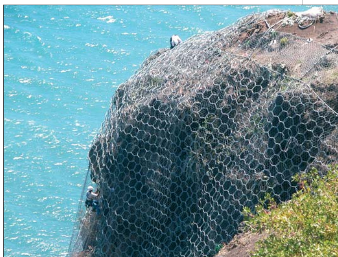
Photo 6 Assemblage de filets Net assembly
