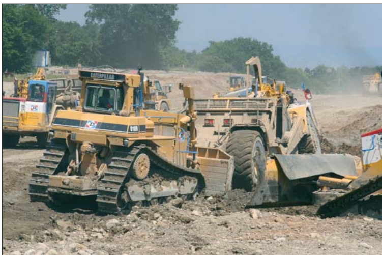
Photo 4 Terrassement grande masse plateau des Morillons Mass earthworks on the Morillons plateau
