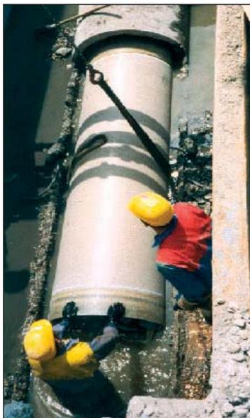
La mise en pression est ensuite réalisée à l'air, en même temps que la polymérisation à chaud de la résine ou dans d'autres cas, en préliminaire à un rayonnement d'ultraviolets.
