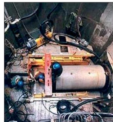
d'une centrale hydraulique de 1,80 ml par 1,00 ml, d'un compresseur de 50 CV et dans le cas d'utilisation de tubes en PE, d'une aire de préparation.
