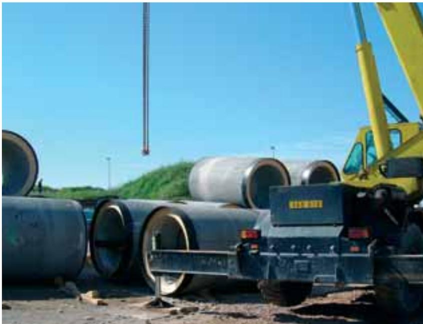
► béton armé de 3 m de long (photo 5). Ces tuyaux ont été conçus en fonction des particularités du chantier : tracé en courbe et longueur foncée très importante. Les éléments sont emboîtés de manière étanche par bagues métalliques et joints en élastomère.
