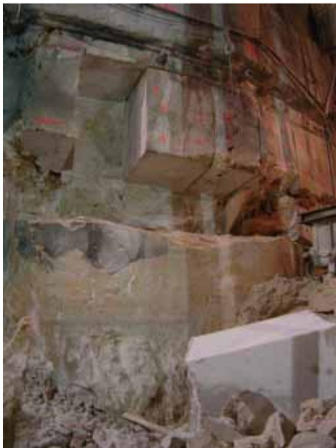
▶ jeunes réalisés en superstructure. Une procédure préventive de minage, très contraignante, a été mise au point avec le concours d'experts. Son efficacité a été validée par des contrôles complémentaires et croisés : enregistrement et analyse des vibrations au moyen d'une base d'acquisition Sol Data, diverses analyses sur prélèvements et notamment observation de la microstructure du béton au microscope électronique, contrôle sonique.
