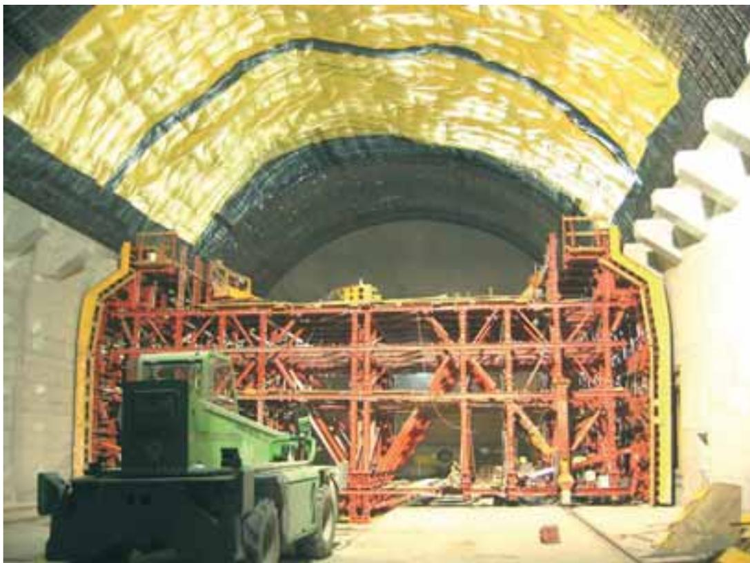
se couche de matériaux drainants injectés entre le terrain et la membrane d'étanchéité ;
