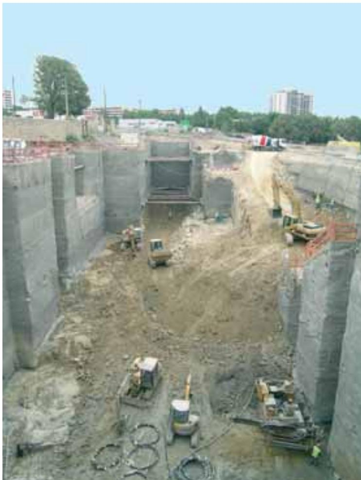
dimensionnement des tirants d'ancrage à revoir à la hausse et volume des terrains durs supérieur aux prévisions (20 000 m<sup>3</sup> contre 11 000 m<sup>3</sup> prévus).
