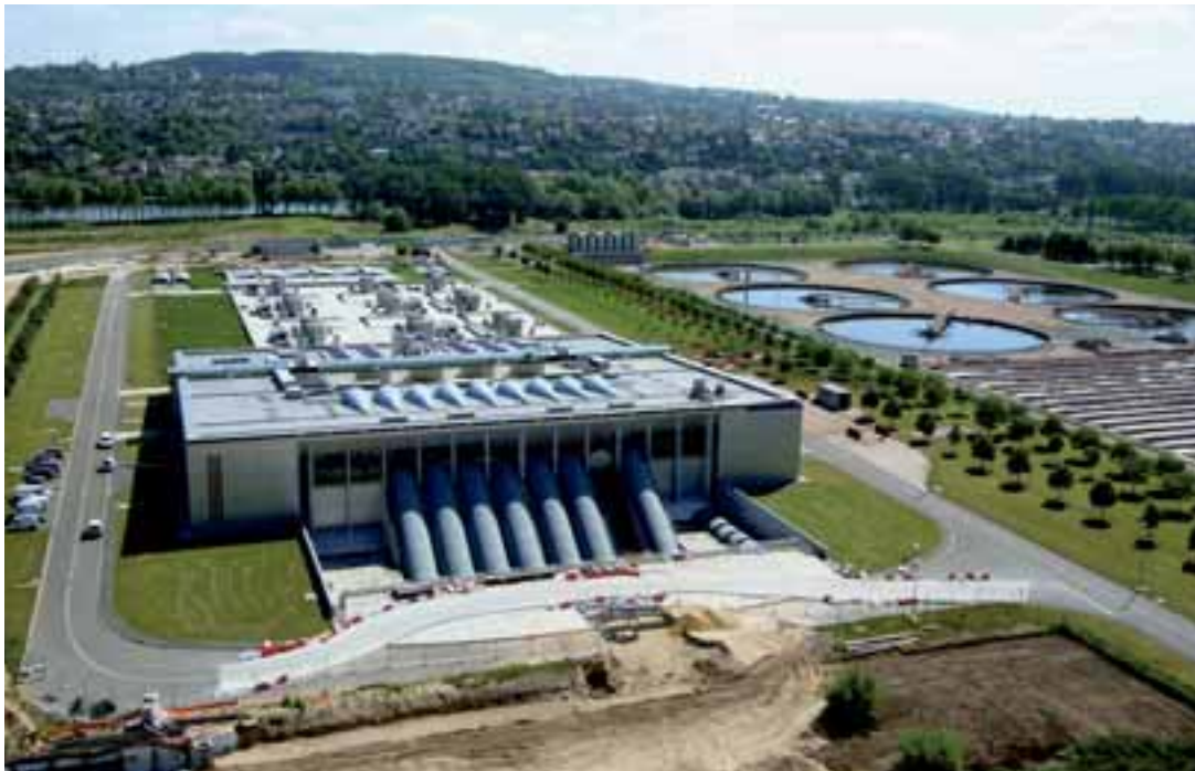
Vue partielle de l'usine Seine Aval (unité de clariflocculation et bassins)
