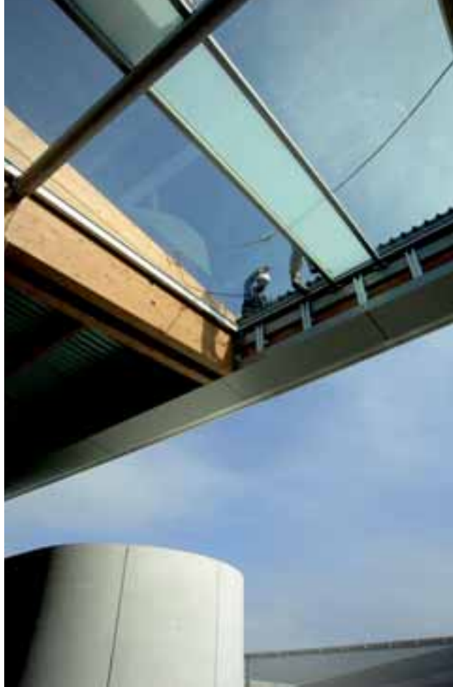
Verrière sur l'auvent de la rue centrale
