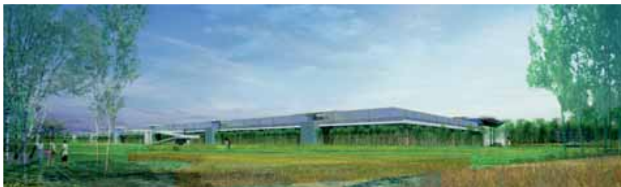
Façade nord du bâtiment de nitrification. Process Biostyr® (simulation)
