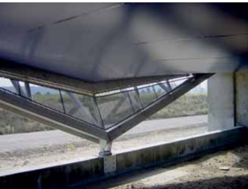
Photo 8 Détail d'un tympan : de vastes ouvertures triangulaires dont la fonctionnalité est la libre circulation de l'air
