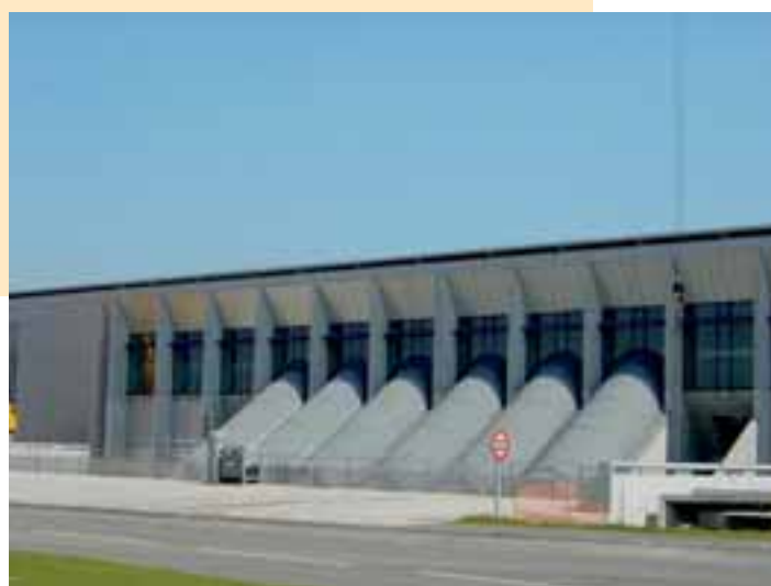
Unité de clariflocculation pour le traitement des eaux pluviales Clariflocculation unit for rainwater treatment
