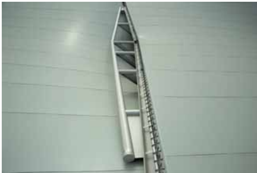
Détail de la couverture en membrane composite au droit des tympans
