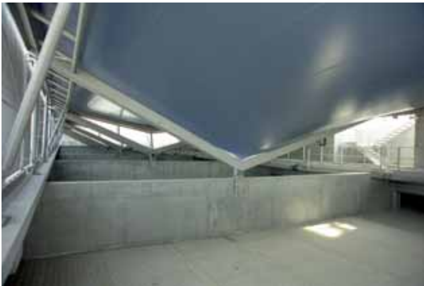
Vue de la charpente métallique support des couvertures des bassins nitrifiants
