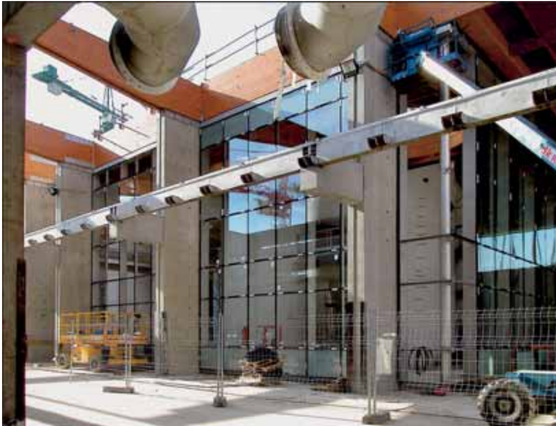
Vue extérieure du mur rideau du local tours de désodorisation
