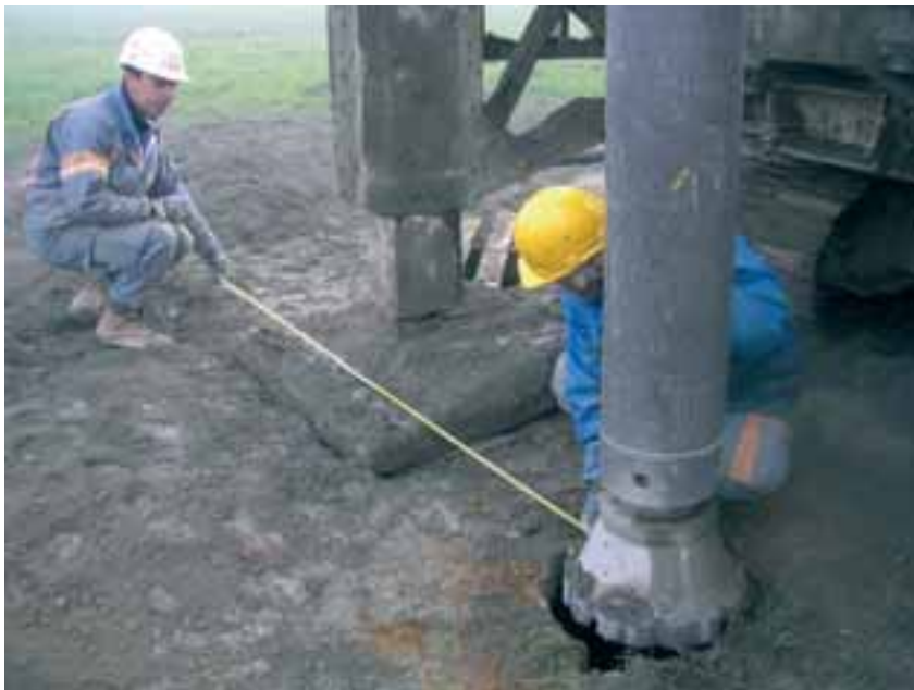
Photos 3 et 4 Forage de pieu Pile drilling
