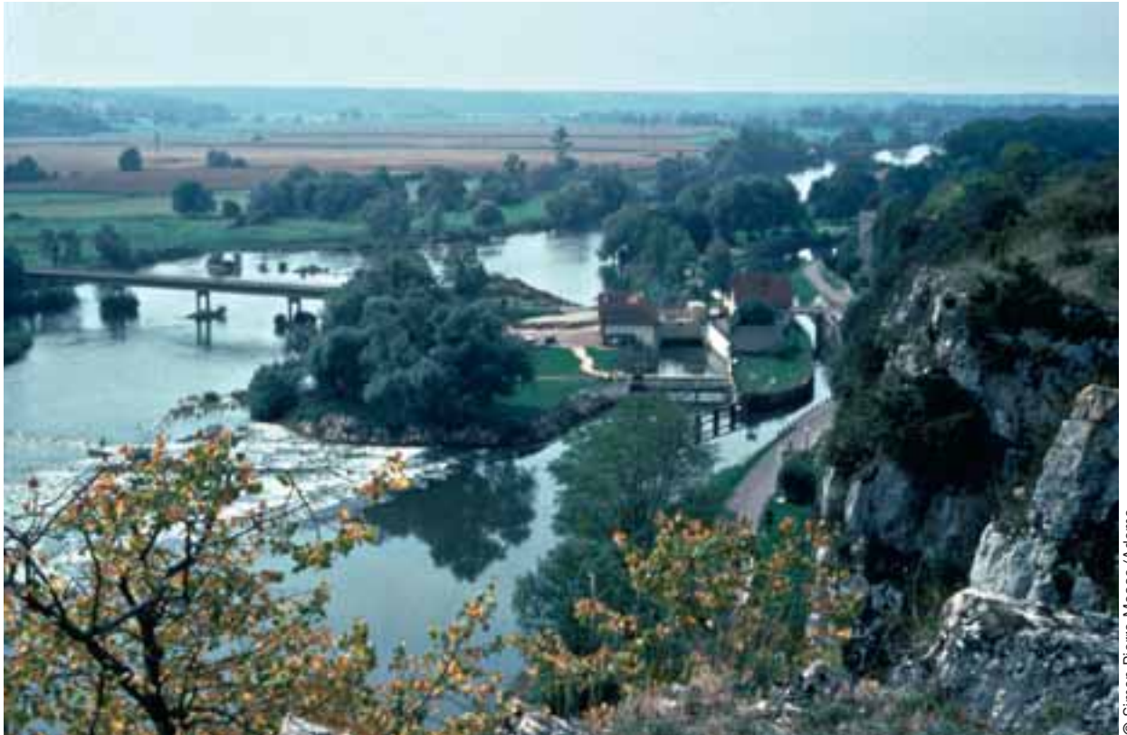
Photo 4 Microcentrale hydraulique de Rochefort-sur-Nénon dans le Jura Micro hydraulic power plant of Rochefort-sur-Nénon in the Jura
