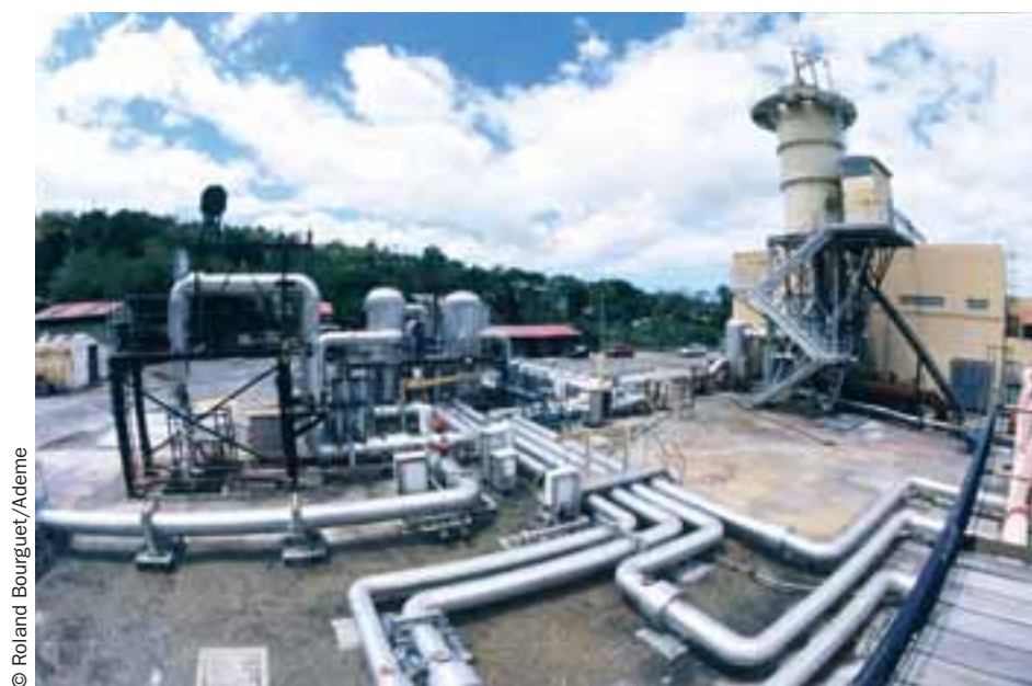
Photo 6 Unité de captage géothermique composée de cuves et tuyauteries inoxydables implantées en pleine végétation tropicale. Région Guadeloupe Martinique Geothermal power unit consisting of stainless steel tanks and pipes located in the midst of tropical vegetation. Guadeloupe Martinique region
