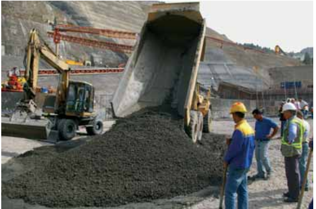
Les premiers mètres cubes de BCR
