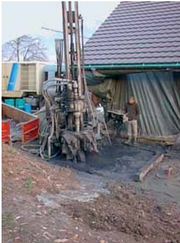
Installation par forage France Géothermie France Géothermie borehole installation
