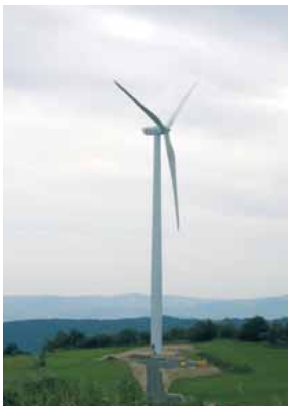
Vue de l'éolienne E1 avant démantèlement de la plate-forme de levage
