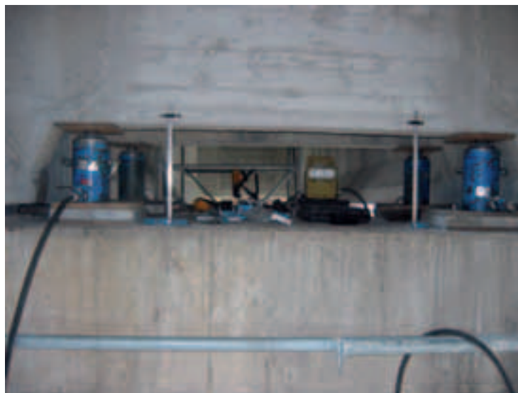
Photos 8 et 9 Vérinage et vue des appuis remplacés Jacking and view of replaced supports
