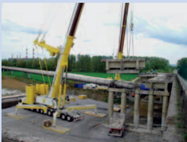
Photo 28 Vue des deux grues en action. Le contre poids est de 160 t. La masse du groupe de trois poutres est de 210 t. La place de la dépose a été bien prévue. La pose sur cale permet de libérer les palonniers View of the two cranes in action. The counterweight is 160 tonnes. The weight of the group of three girders is 210 tonnes. The space for placing down has been carefully provided for. Placing down on a block frees the lifting beams
