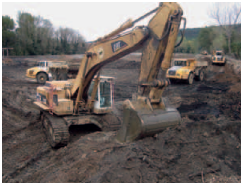
Photo 10 Terrassement des déchets et des sols pollués Grading wastes and polluted soils
