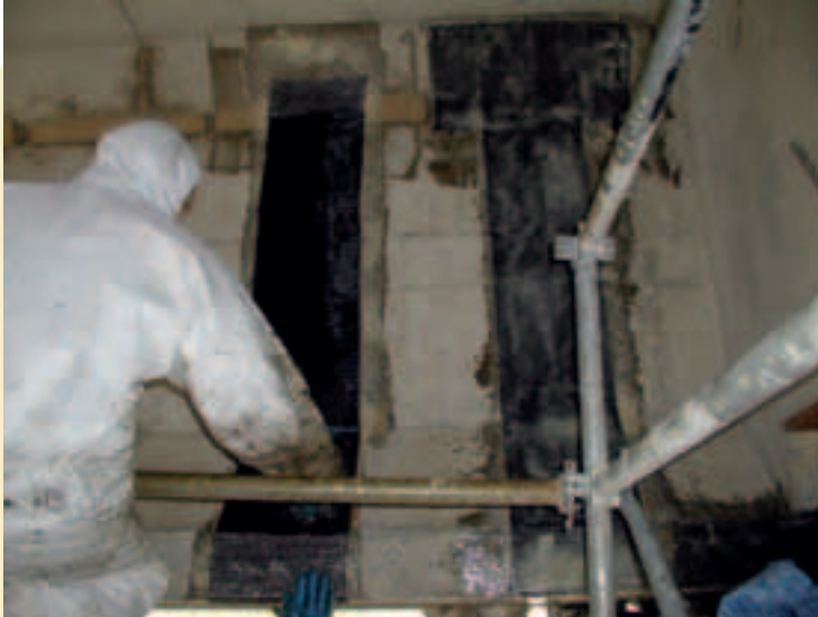
Photos 6 et 7 Pose du TFC® (Tissu de fibres de carbone) en cours et poutre terminée Laying of TFC® (carbon fibre fabric) in progress and completed girder
