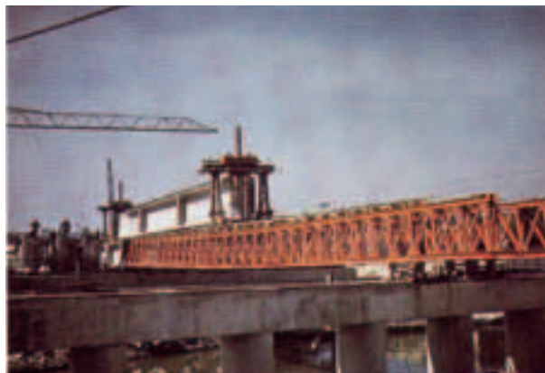
Photo 16 Exemple de cintre lanceur Example of launching centre
