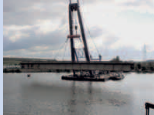
Photos 31 et 32 La bigue vient déposer le tronçon sur une estacade spécialement réalisée. Elle est actionnée par ses moteurs. Le mouvement est sécurisé par quatre élingues à treuil. Chacun des trois tronçons est donc enlevé, puis découpé en petits éléments mis en dépôt provisoire sur place
