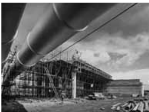
Photo 2 1964 - Lancement de l'ossature du tablier mixte quatre poutres de sens Thionville/Metz 1964 - Launching the structure of the composite four-girder deck in the Thionville/Metz direction
