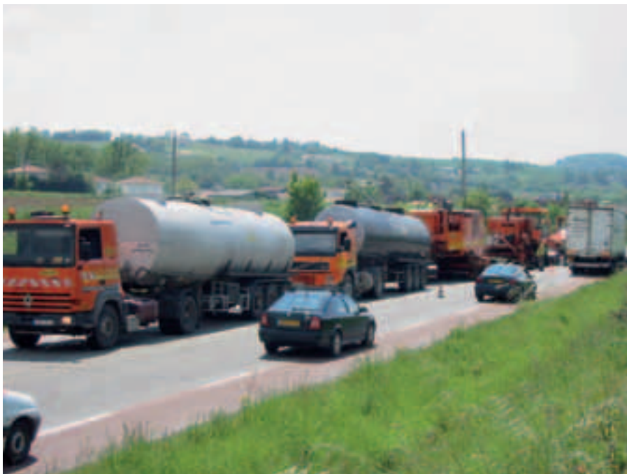
Photo 2 Travaux par demi-chaussée circulation maintenue Work on half-roadway, with traffic maintained
