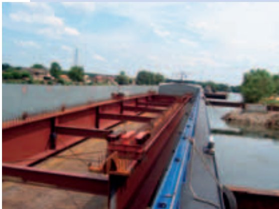
Photo 36 Accostage des péniches apportant les tronçons de l'ossature principale
