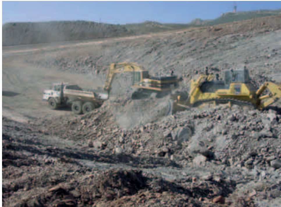
Déblais à l'origine du tronçon
