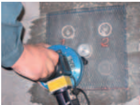
Photo 3 Essai d'arrachement Pull-out test
