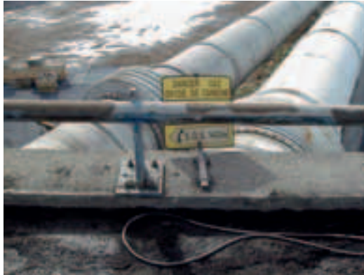
Photo 15 Vue des deux gazoducs depuis le pont d'accès View of the two gas pipelines from the approach bridge
