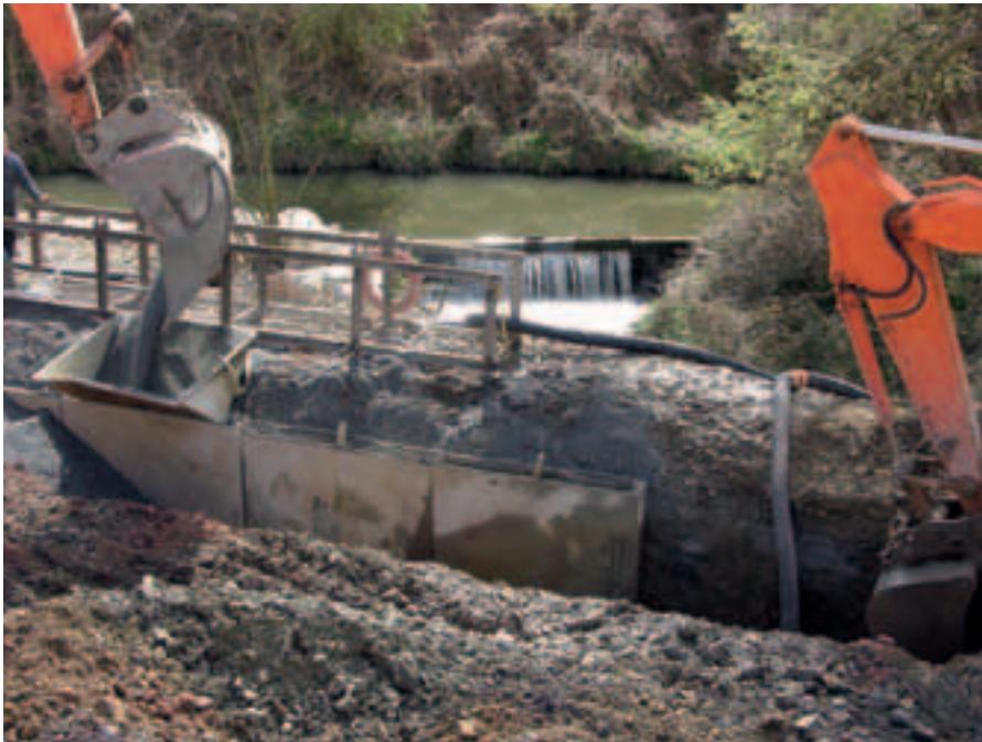
Photo 2 Réalisation de la tranchée drainante
