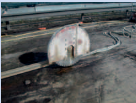
Photo 25 Sciage longitudinal du VIPP pour faire un groupe de deux et trois poutres
