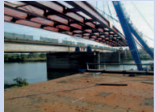
Photo 35 Une fois l'arrière-bec et l'avant-bec assemblés le lancement de l'ossature du pont d'accès vers ses appuis peut commencer
