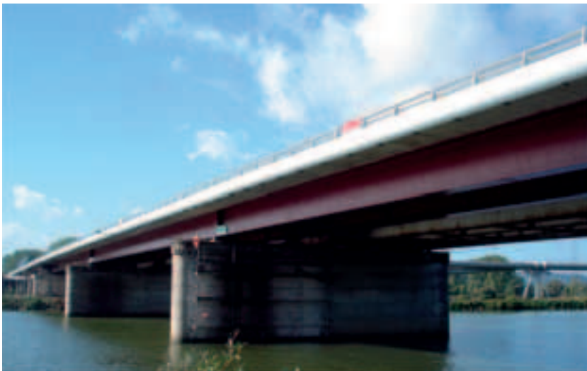
Photo 40 Mission accomplie, l'ouvrage est fini dans le délai de 5 mois de coupure. Réouverture à la circulation le 26 septembre 2005
