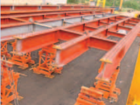
Photo 19 Réalisation complète par Eiffel des charpentes à Lauterbourg (pour chargement ensuite sur le Rhin)
