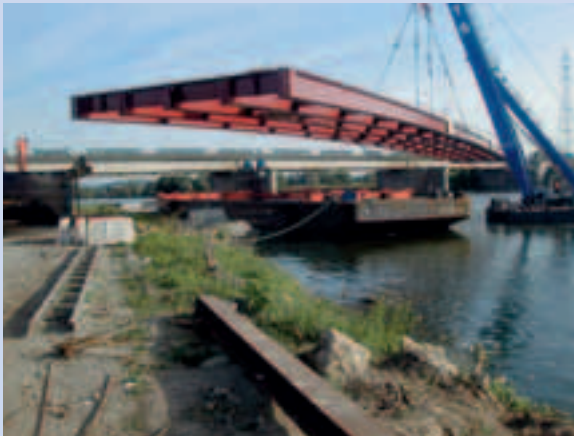
Photo 33 L'infatigable bigue hisse l'ossature du pont d'accès (90 m de long, 295 t). Elle est à son maximum de charge et le ferrailage passif sera mis ensuite, ainsi que l'arrière et l'avant-bec
