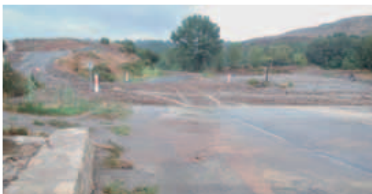
Photo 4 Résultat de l'érosion après une forte pluie : route inondée barrée Result of erosion after heavy rain : blocked flooded road
