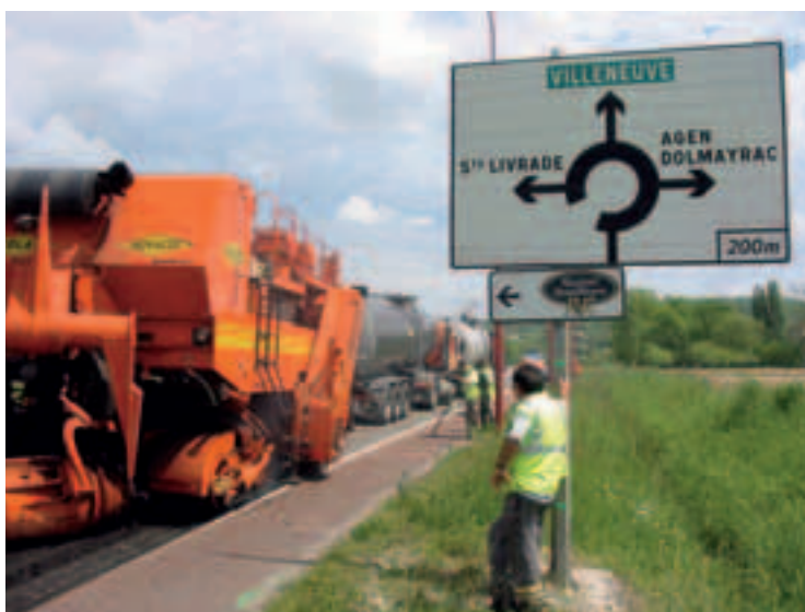
Photo 3 Retraitement de l'ancienne chaussée
