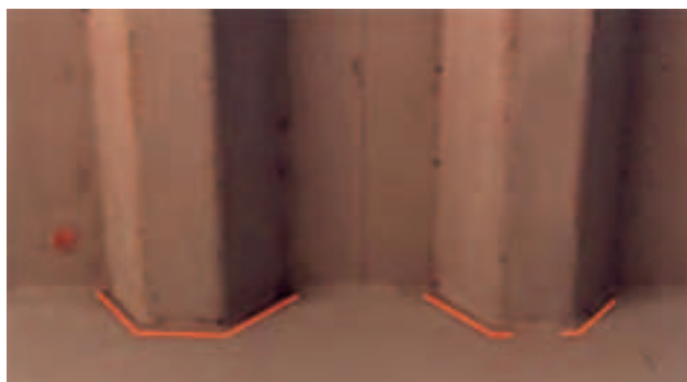
Photo 7 Vue des fissures types à la jonction auget-pièce de pont
