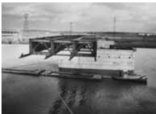
Photo 2 1964 - Lancement de l'ossature du tablier mixte quatre poutres de sens Thionville/Metz 1964 - Launching the structure of the composite four-girder deck in the Thionville/Metz direction
