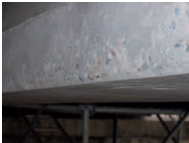
Photos 4 et 5 Préparation (reprofilage et meulage) Preparation (reprofiling and grinding)
