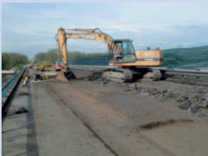
Photo 25 Sciage longitudinal du VIPP pour faire un groupe de deux et trois poutres
