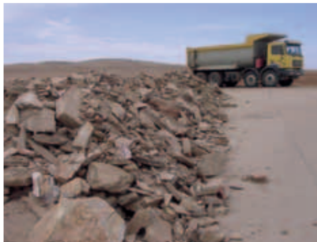
Réalisation des engagements des matériaux fins par des matériaux rocheux
