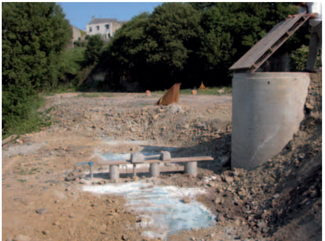
Photo 3 Panneau-drain une fois posé
