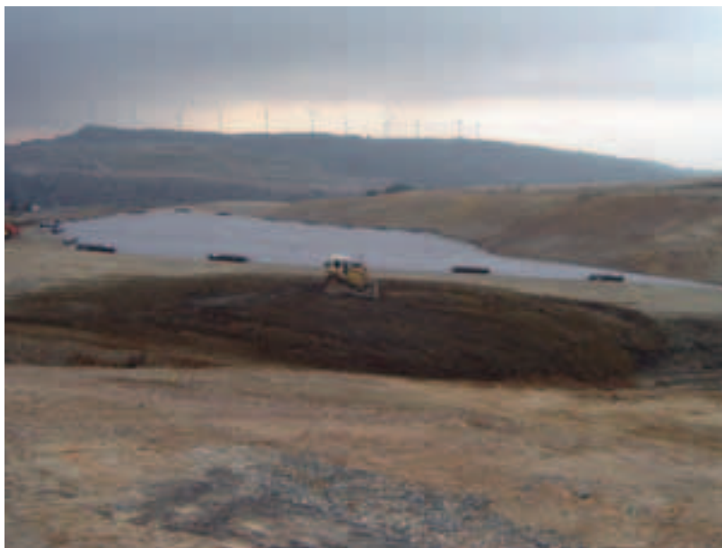
Photo 3 Pose de la géomembrane bitumineuse Laying the bituminous geomembrane barrier
