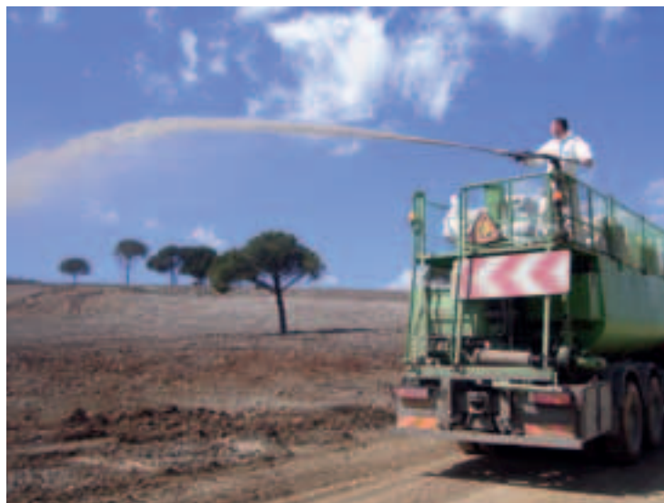
Photo 11 Ensemencement hydraulique des zones phytostabilisées Hydroseeding of phytostabilised areas
