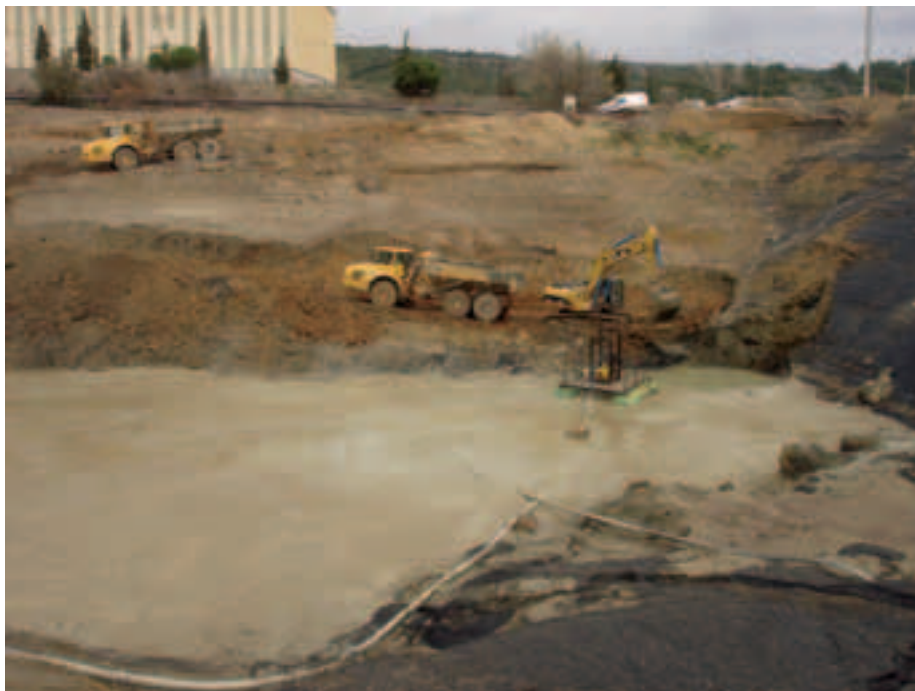
Photo 2 Bassin B1 en cours de consolidation Bassin B1 undergoing consolidation
