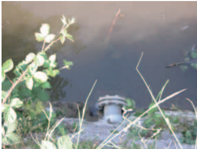
Photo 4 Exhaure des eaux de la tranchée drainante dans la rivière
