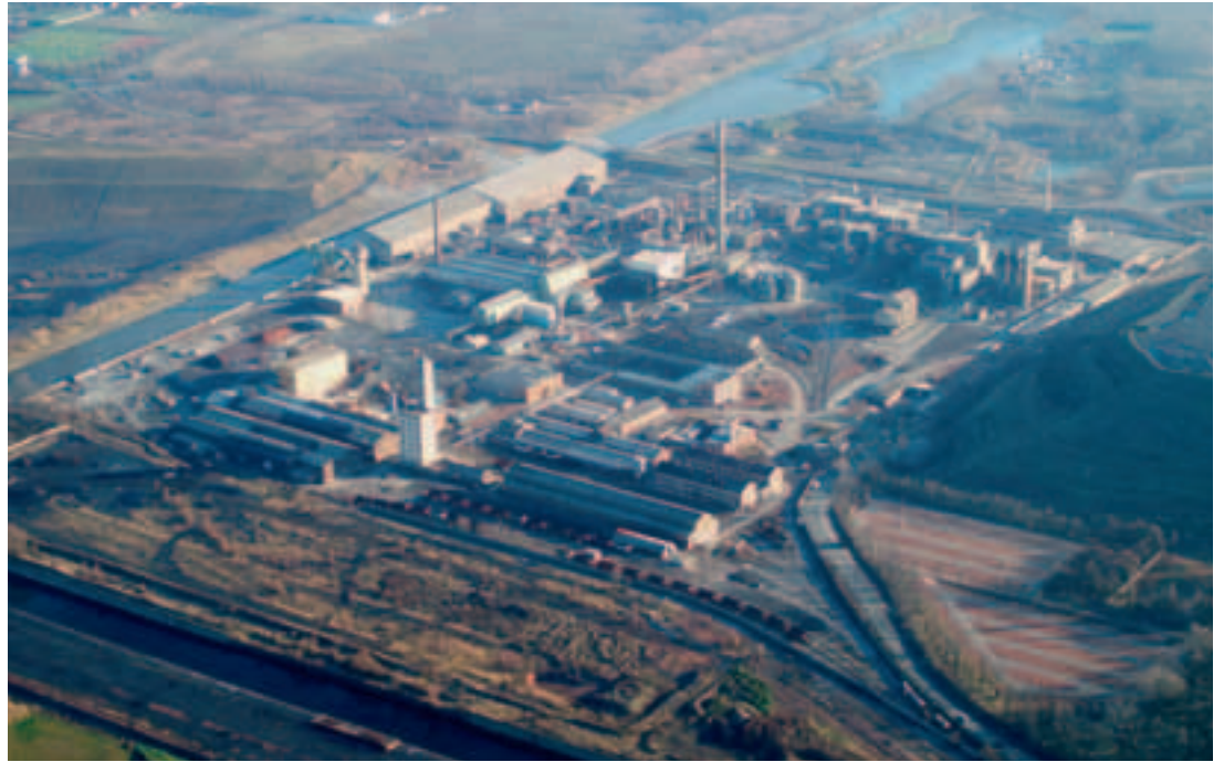
Photo 1 Vue générale du site de Noyelles-Godault General view of the Noyelles-Godault site
