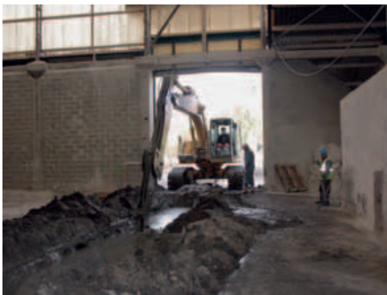
Photo 1 Réalisation de la paroi au coulis dans le bâtiment de stockage
