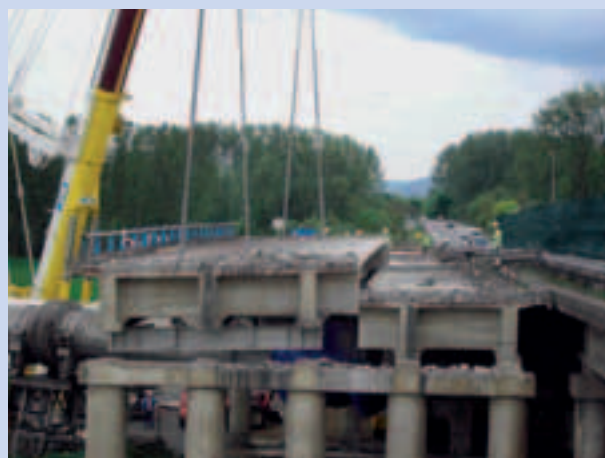
Photo 24 Rabotage et allégement des tabliers principal et d'accès
