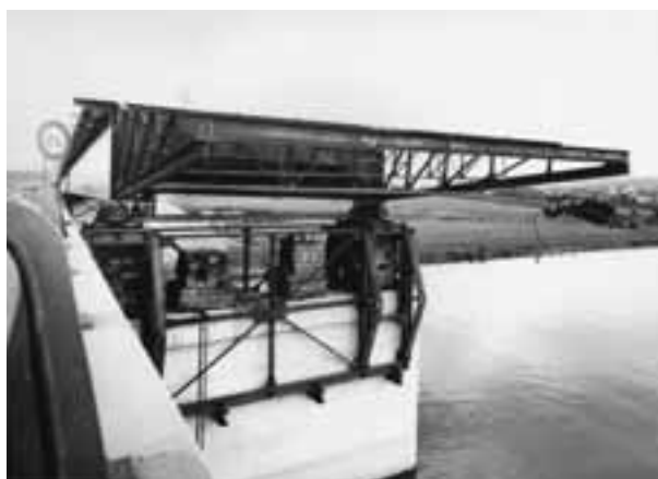
Photo 17 1966 - Bâti métallique pour lancement et dévérinage de la dalle orthotrope 1966 - Steel frame for launching and jacking down the orthotropic slab
