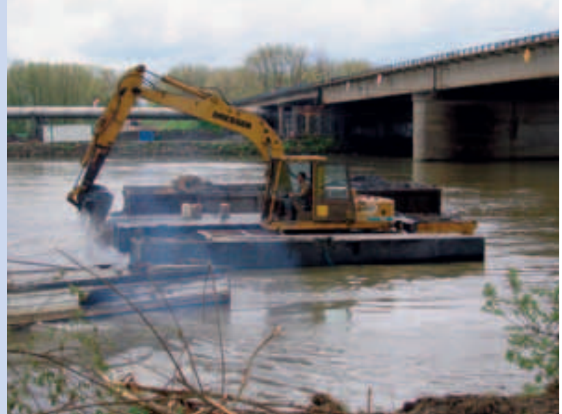
Photo 20 Dragage de la Moselle sous la travée 3 pour assurer le tirant d'eau nécessaire de 2,5 m
