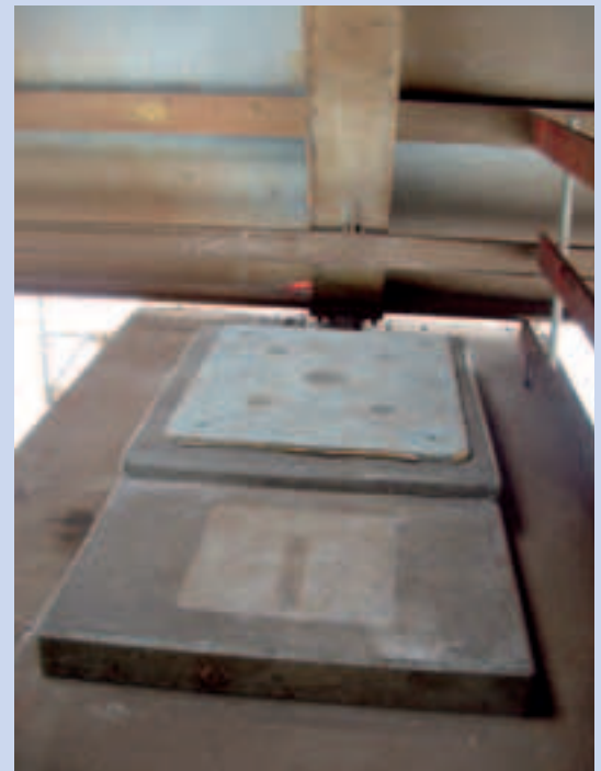
Photo 23 Réalisation des nouveaux dés d'appui pour les piles B et C (entraxe du nouveau pont plus faible)
