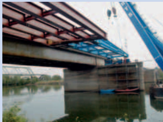
Photo 35 Une fois l'arrière-bec et l'avant-bec assemblés le lancement de l'ossature du pont d'accès vers ses appuis peut commencer
