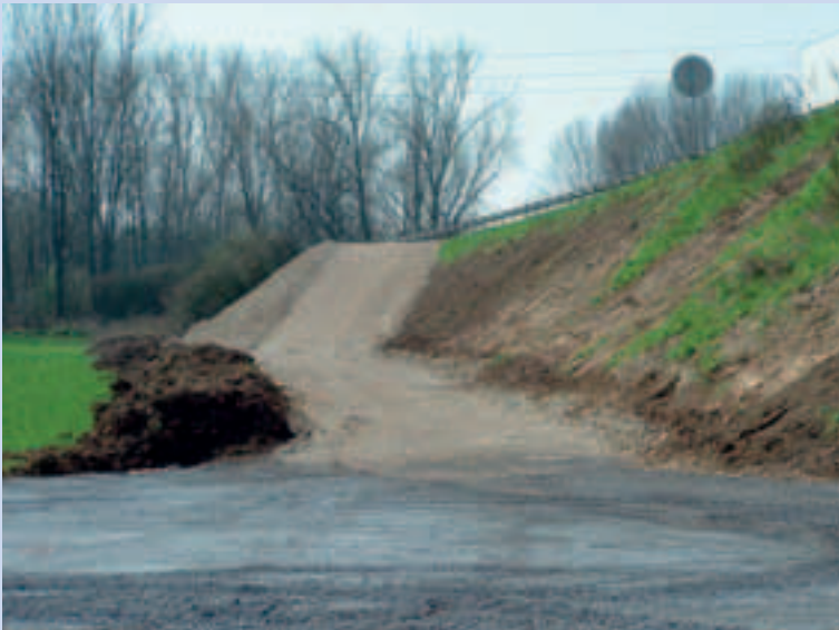
Photo 21 Réalisation des pistes d'accès et zones d'installation Execution of approach tracks and installation areas
