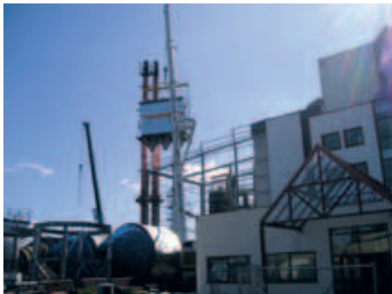
Mise en place des équipements du traitement des fumées de l'usine d'incinération d'Haguenau (Bas-Rhin)
