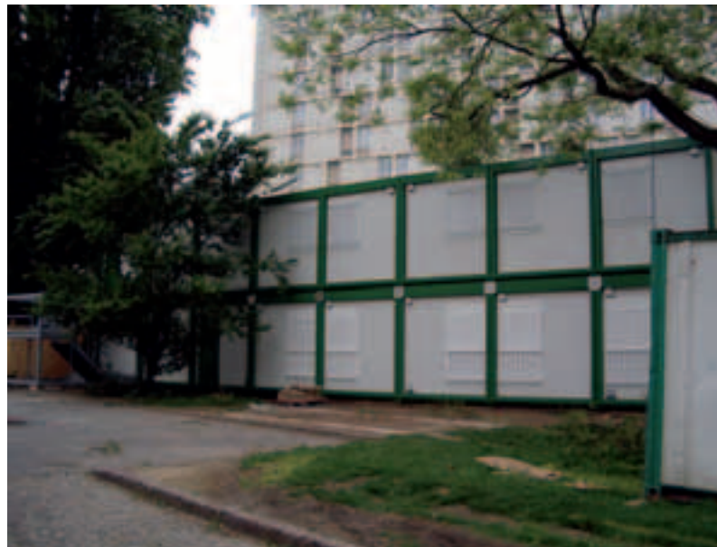
Le site pilote The pilot site
