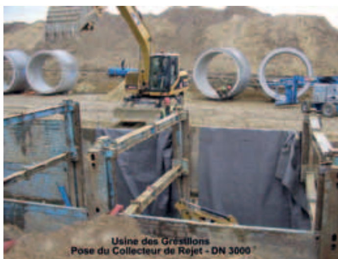
Photo 9 Pose du collecteur de rejet DN 3 000 Laying the main discharge drain of ND 3 000 mm
