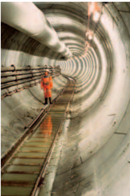
Photo 10 Intérieur du tunnel Inside of the tunnel
