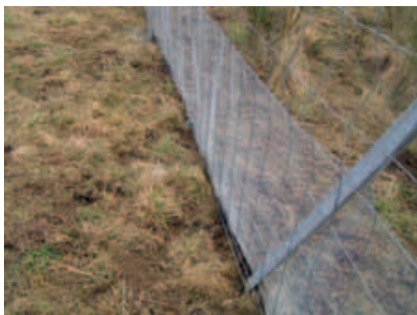
Photo 6 Clôture batraciens en phase définitive Batrachian fence in final stage
