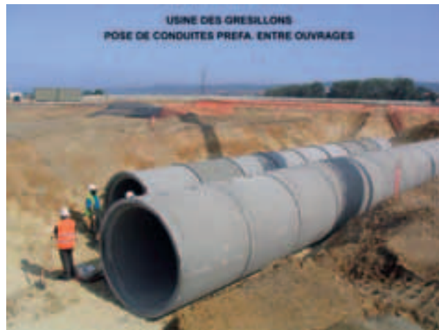
Photo 10 Pose de conduites préfabriquées entre ouvrages
