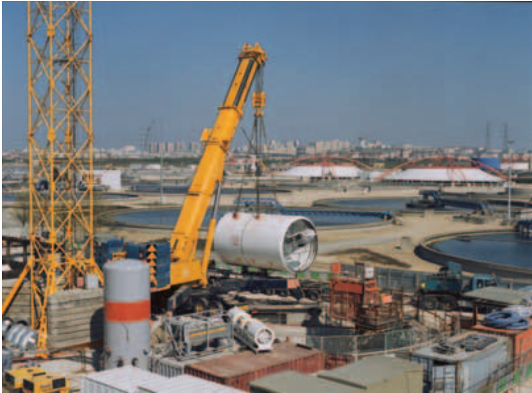
Photo 3 Descente du fût du tunnelier sans sa roue dans le puits de départ
