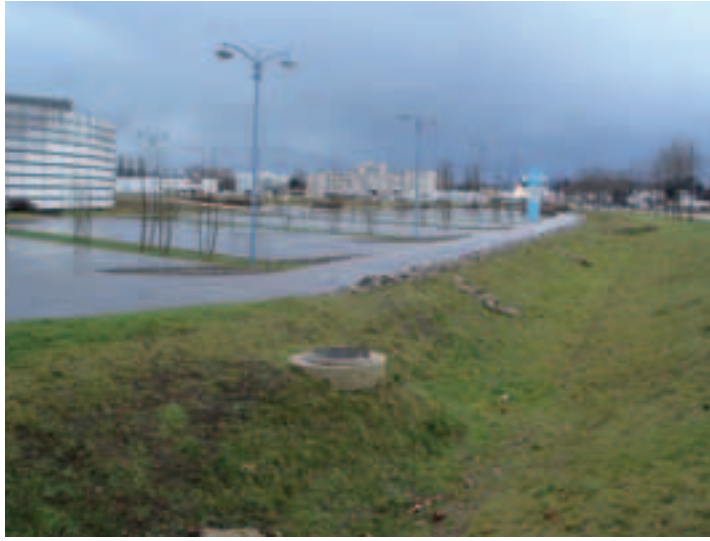
Photo 5 Larges noues drainant le parking de la salle socioculturelle de Pont-à-Mousson
