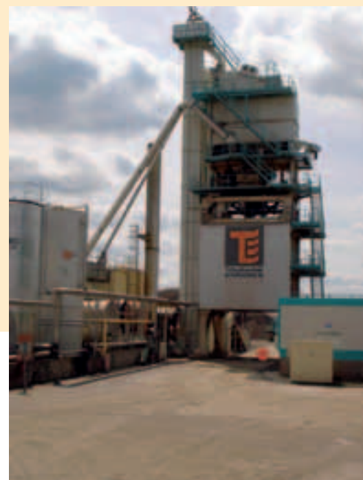
Photos 5, 6 et 7 Les enrobés tièdes peuvent être produits par tous les types de postes
