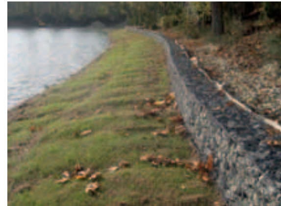
Photo 6 Début de végétalisation des matelas Initial revegetation of the mattresses
