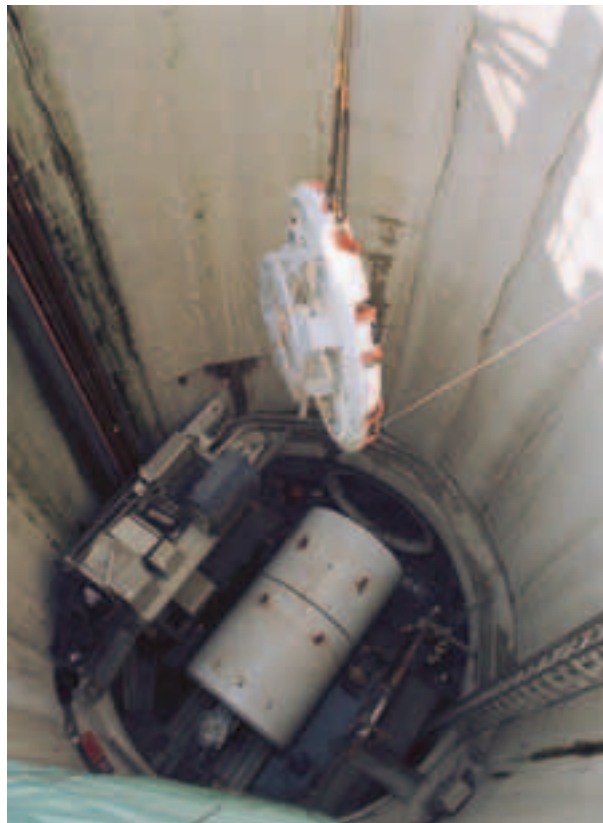
Photo 4 Mise en place de la roue
