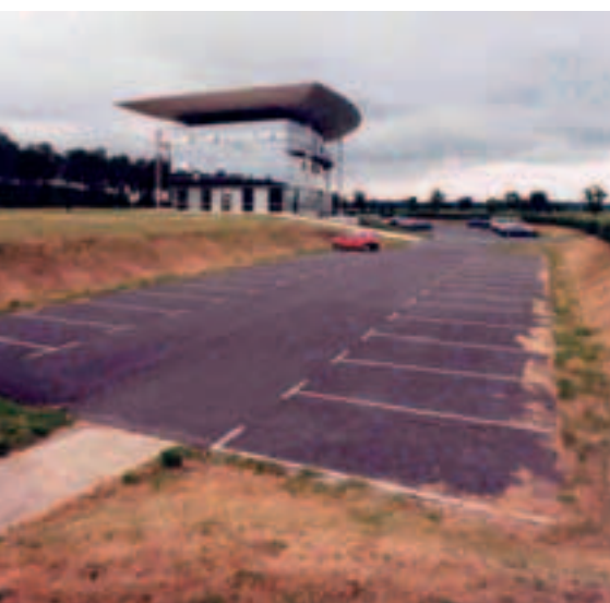
Photo 2 Chaussées à structure réservoir pour la protection décennale Pavements with reservoir structure for ten-year flood protection
