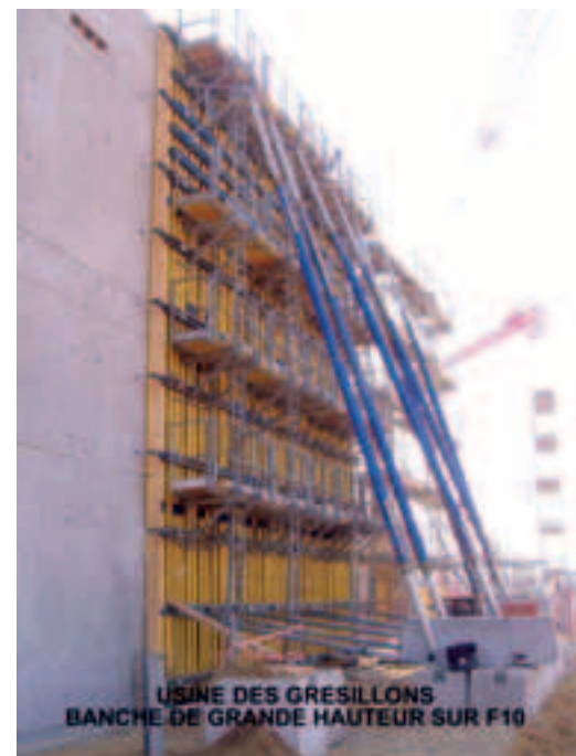
Photo 15 Banche de grande hauteur sur F10 Very high shuttering panel on F10
