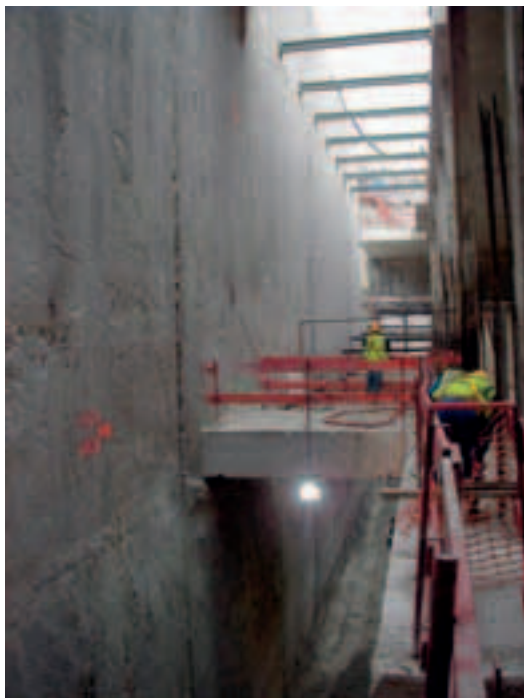
Fond de fouille à 32 m de profondeur sous 27 m de charge d'eau
