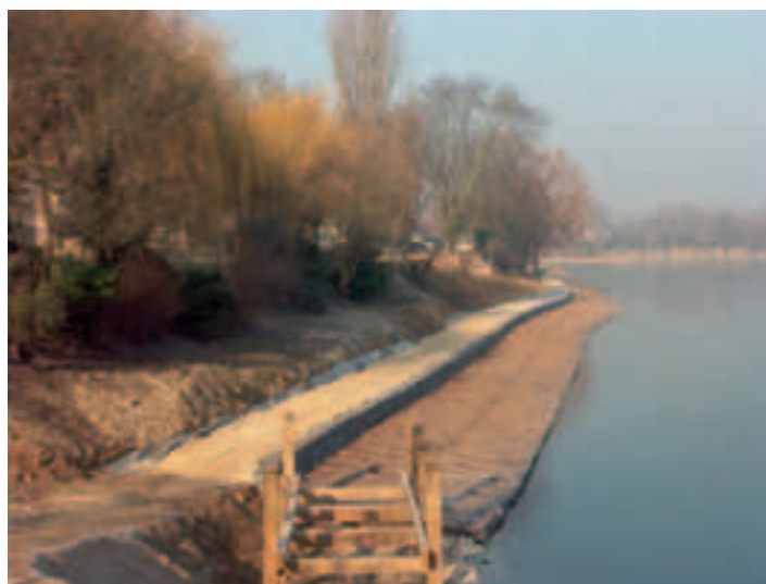
Photo 2 Vue du chantier en fin de travaux
