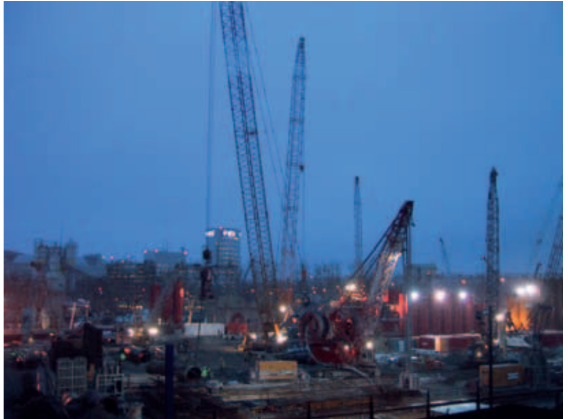
En cours de travaux de fondations During the foundation works
