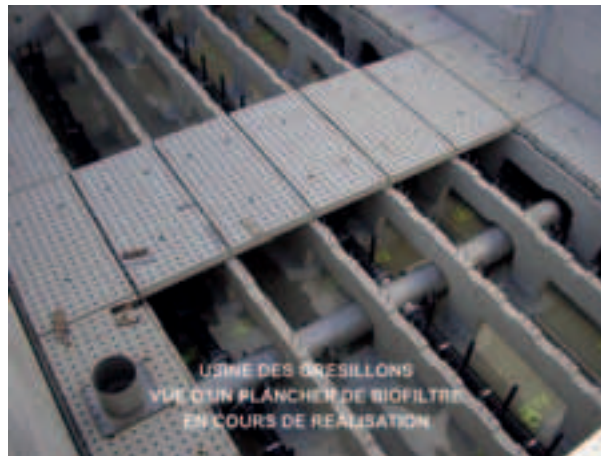
Photo 16 Vue d'un plancher de biofiltre en cours de réalisation View of a biological filter floor undergoing construction
