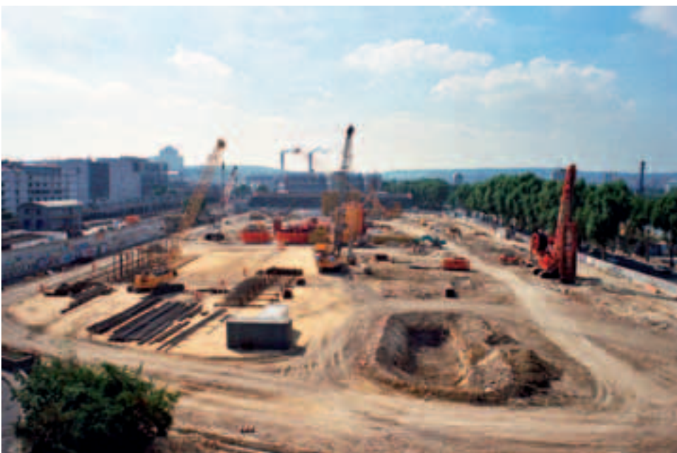
Le site au démarrage du chantier The site at the start of the project
