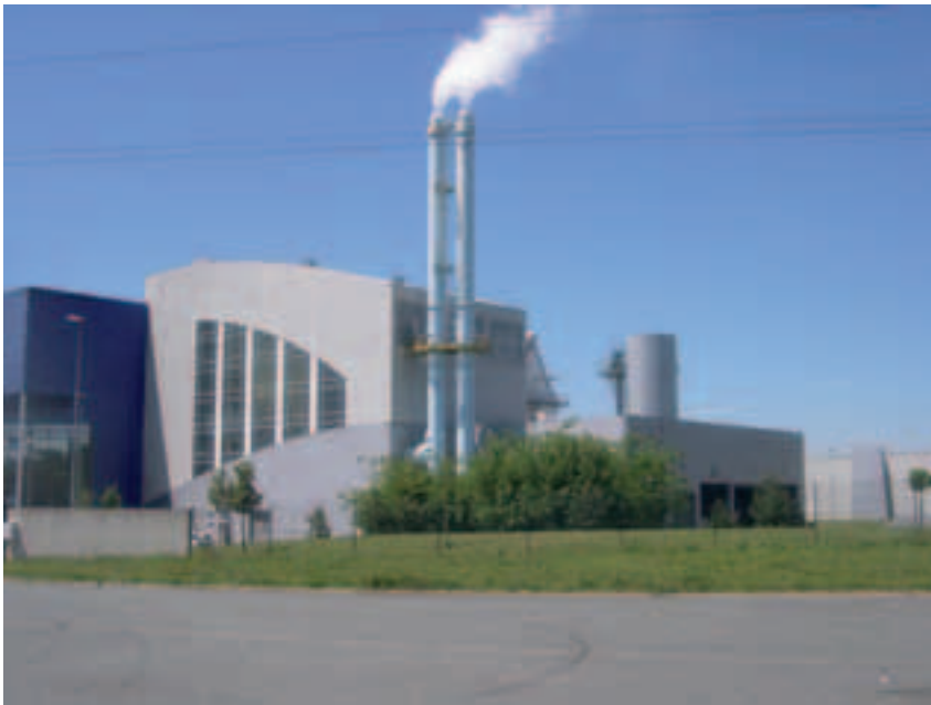
L'unité de valorisation énergétique de Sarran, près d'Orléans (Loiret) The energy recovery unit at Sarran, near Orléans (Loiret region)
