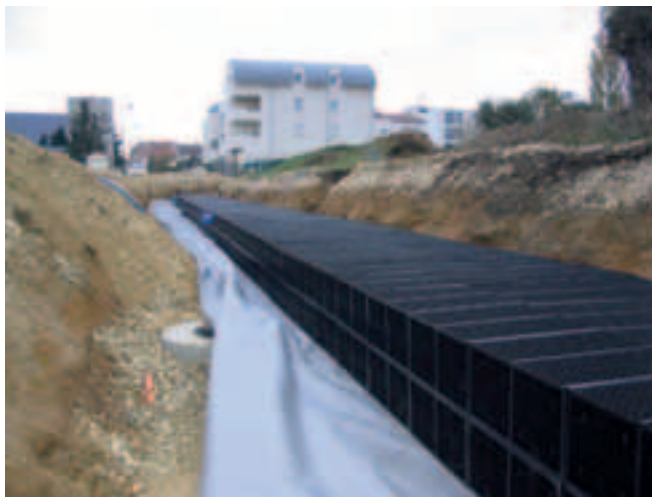
Photo 7 Réalisation d'une rétention de 300 m 3 en structure alvéolaire ultra-légère
