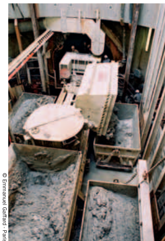
Photo 9 Train de marinage dans le puits
