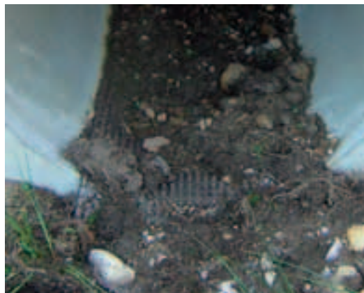
Photo 2 Détail, géotextile gaufré et terre en entrée de buse Detail, corrugated geotextile and earth at culvert entrance
