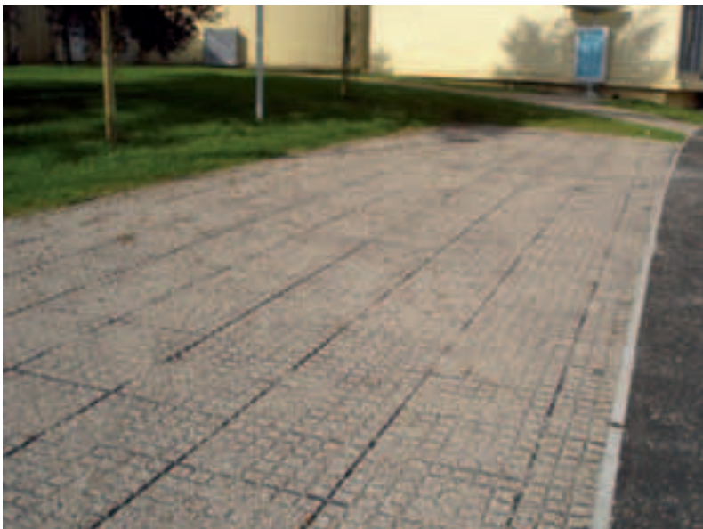
Photo 8 Parking perméable, station d'épuration à Maxeville (maître d'ouvrage : Communauté Urbaine du Grand Nancy) Permeable parking lot, Maxeville treatment plant (Owner : Communauté Urbaine du Grand Nancy)
