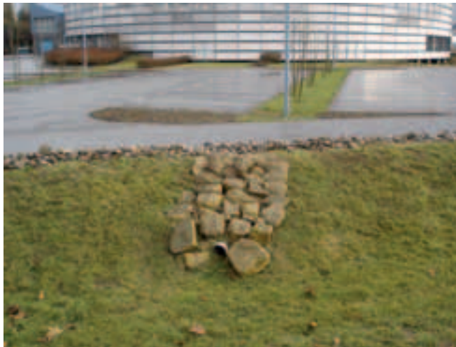
Photo 6 Raccordement à la noue
