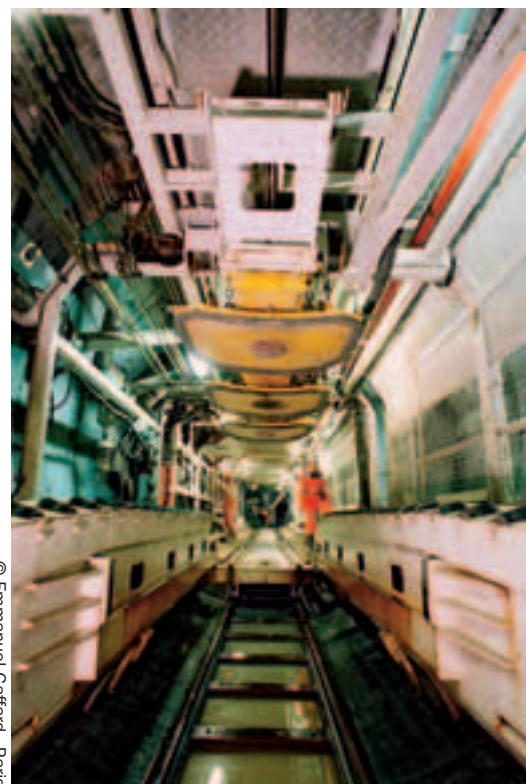
Photo 7 Intérieur du train suiveur, ventouse pour le dépilage des voussoirs
