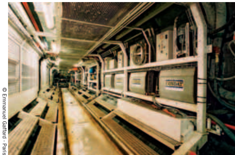
Photo 8 Intérieur du train suiveur sous le tapis de transfert des déblais
