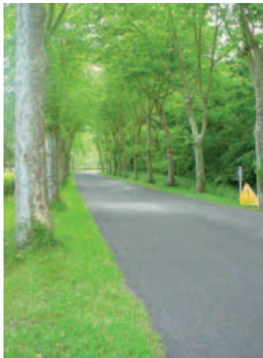
Photo 4 Composé de 100 % d'agrégats d'enrobé, Biochape est un procédé d'enrobé à froid
