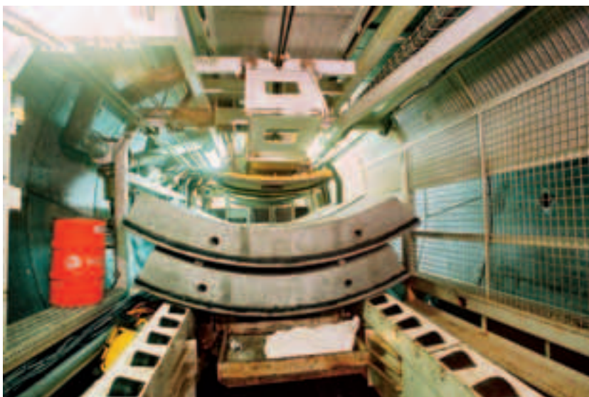
Photo 6 Intérieur du train suiveur, convoyeur pour le transfert des voussoirs
