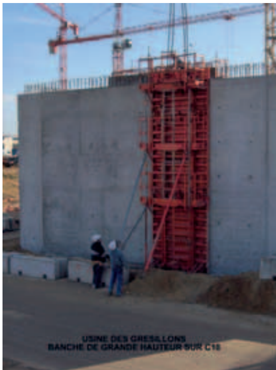
Photo 14 Banche de grande hauteur sur C10 Very high shuttering panel on C10
