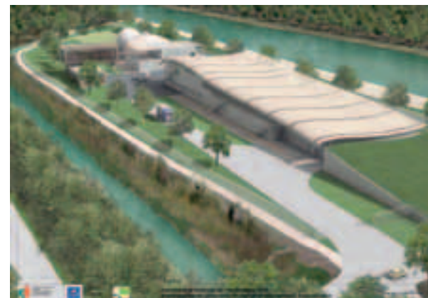
Station d'épuration de la Communauté de Communes des Trois-Frontières - CC3F - 120 000 équivalents-habitants avec procédé R3F
