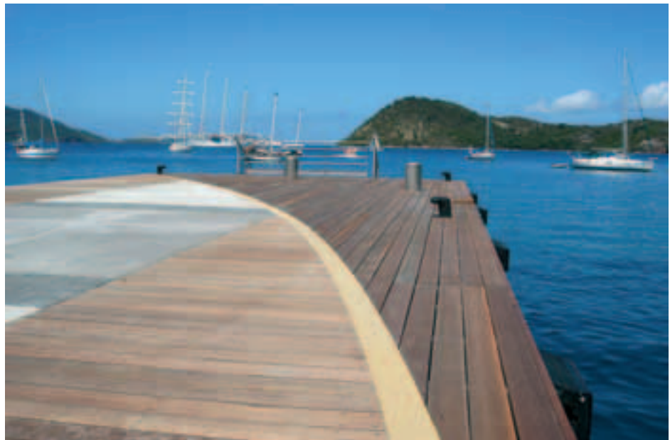
Photo 6 Extrémité de l'appontement, bollards de 20 t et bornes lumineuses spéciales End of the wharf, 20-tonne bollards and special lighting bollards
