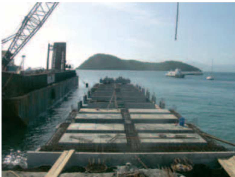
Photo 4 Pose des éléments préfabriqués Placing prefabricated elements
