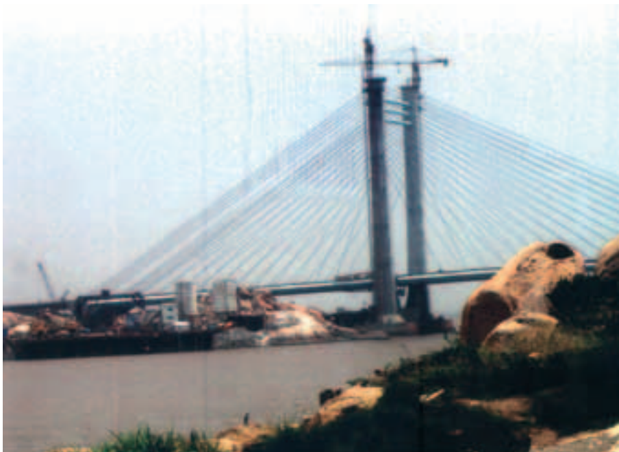
Figure 3 Pont à haubans avec une travée de 332 m de long, en cours d'achèvement (figure fournie par l'ingénieur en chef M. Zhang Jian)
