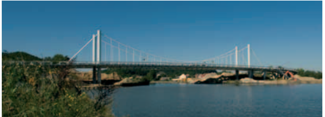
Photo 1 Vue générale du pont de Kanne General view of Kanne Bridge
