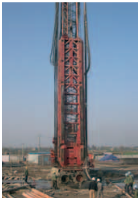
Wuhan - Une des hydrofraises HF 1200 en épaisseur 1,5 m Wuhan - One of the HF 1 200 hydro-cutters in a 1.5 m thickness
