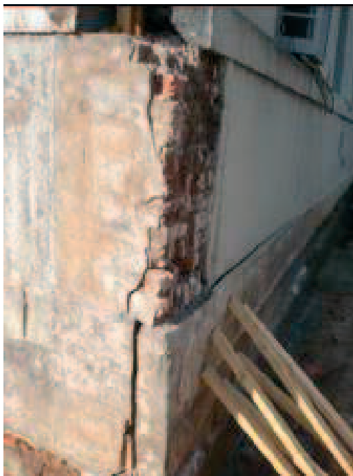
Photo 1 Mise au jour des fondations de briques
