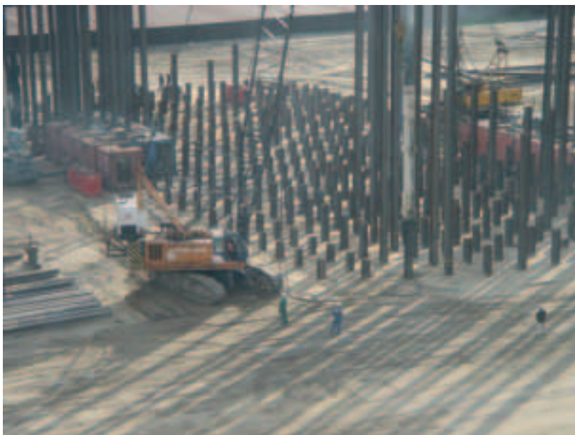
Photo 5 Battage des pieux. Phase production
