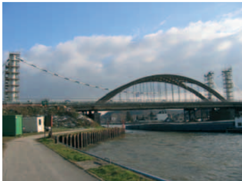
Photo 7 Premier câble en place First cable in place
