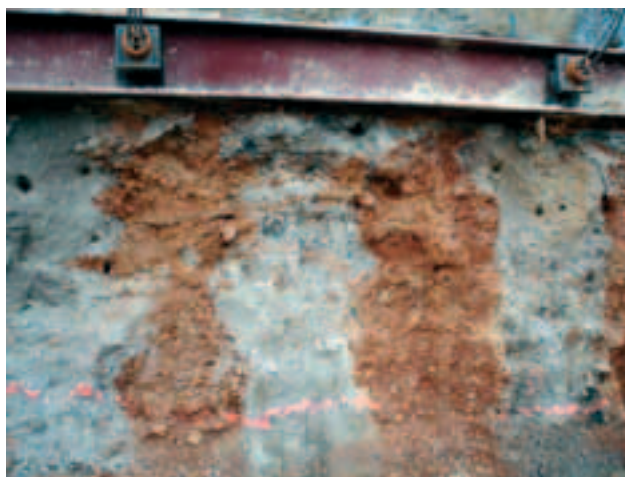
Photo 2 Colonnes de jet grouting découvertes, lierne et tirants Uncovered jet grouting columns, lierne rib and tie rods
