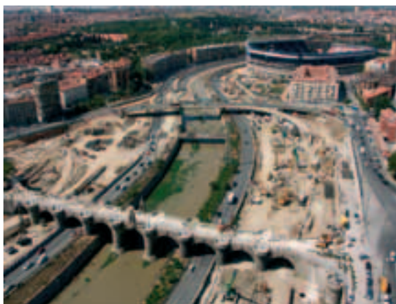
Pont de Tolède. Chantier de parois moulées
