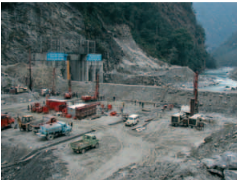
Photo 6 Travaux de jet grouting et d'injection sur le batardeau amont Jet grouting and grout injection work on the upstream cofferdam
