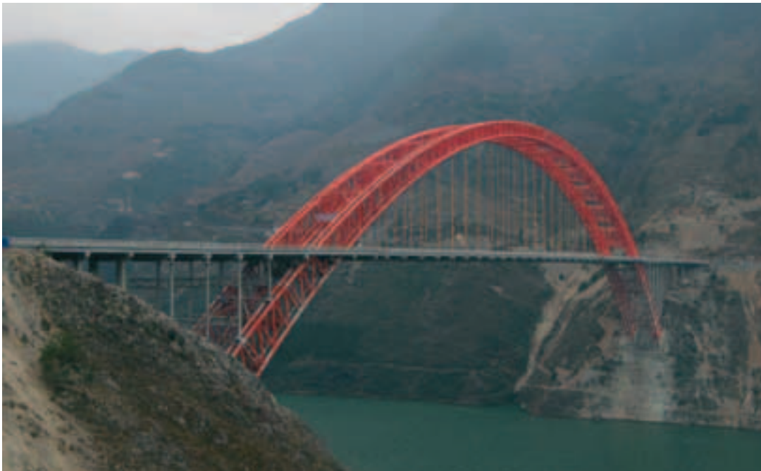
Figure 1 Le pont de Wushan achevé (arc en tubes d'acier remplis de béton)
