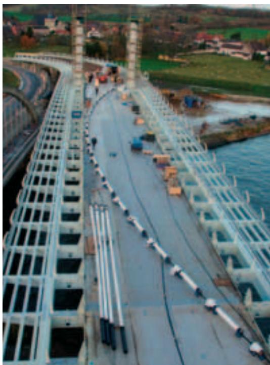
Photo 3 Préfabrication du câble sur le tablier
