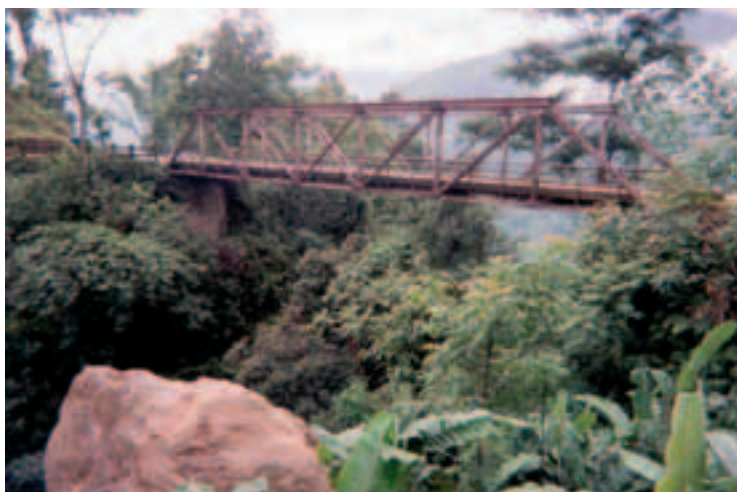
Photo 2 L'accès au chantier comporte des passages délicats
