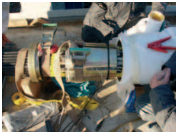
Photo 4 Cales avant le blocage du collier Wedging before blocking the collar
