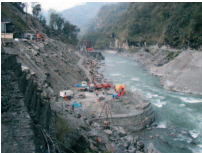
Photo 4 La plate-forme du plot d'essai The platform of the test section
