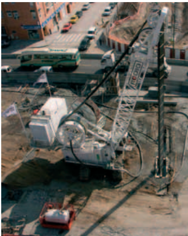
Parois moulées. Hydrofraise Evolution de Rodio (groupe Solétanche Bachy)
