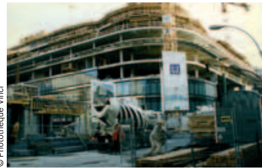
Photo 5 Ensemble Friedrichstadt Passagen en chantier Friedrichstadt Passagen complex undergoing construction
