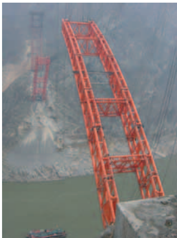
Figure 4 Arc raccordé par grue à câble Arch spliced with cable crane
