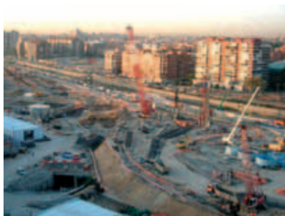
Echangeur sud. Chantier de parois moulées
