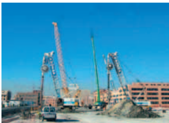
Parois moulées. Atelier benne KS 3000 de Kronsa (groupe Solétanche Bachy)
