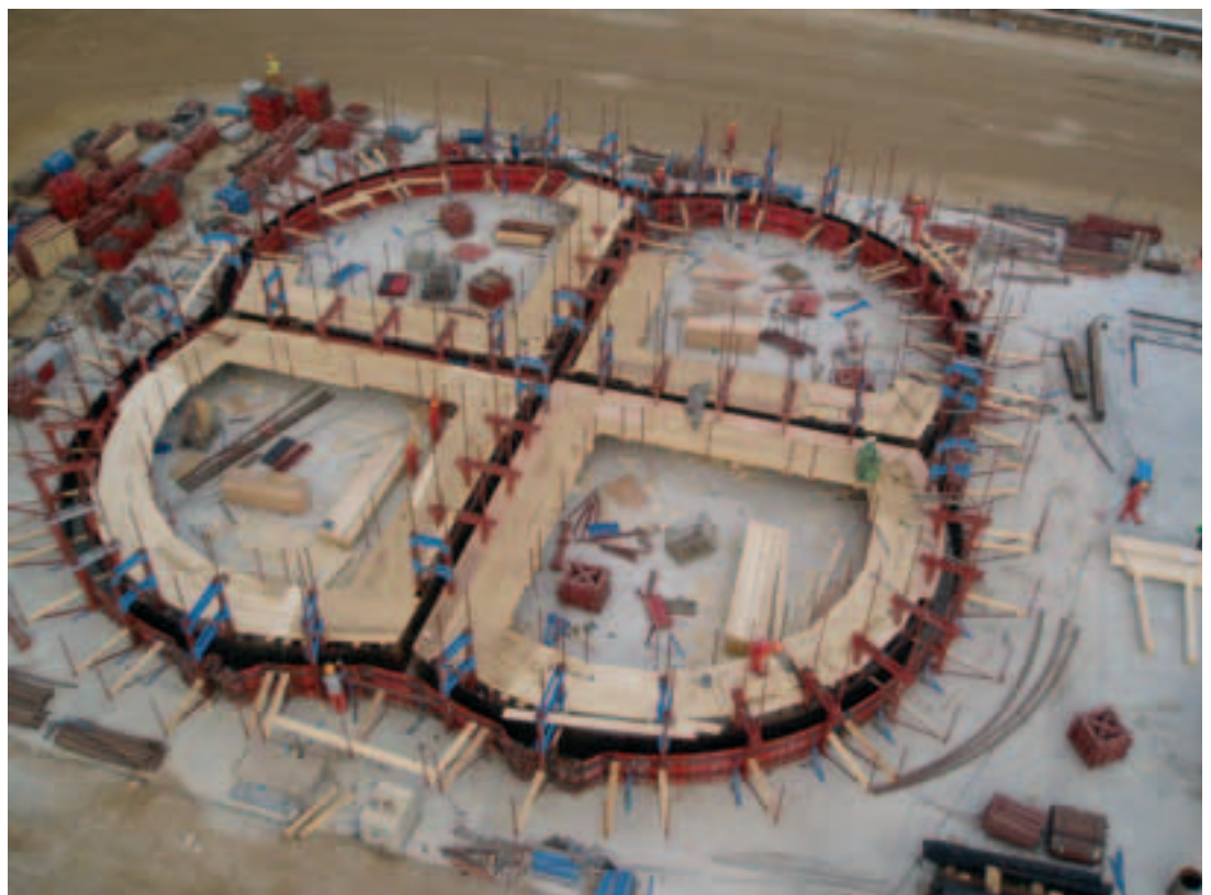
Photo 8 Montage du coffrage glissant Erecting the sliding formwork
