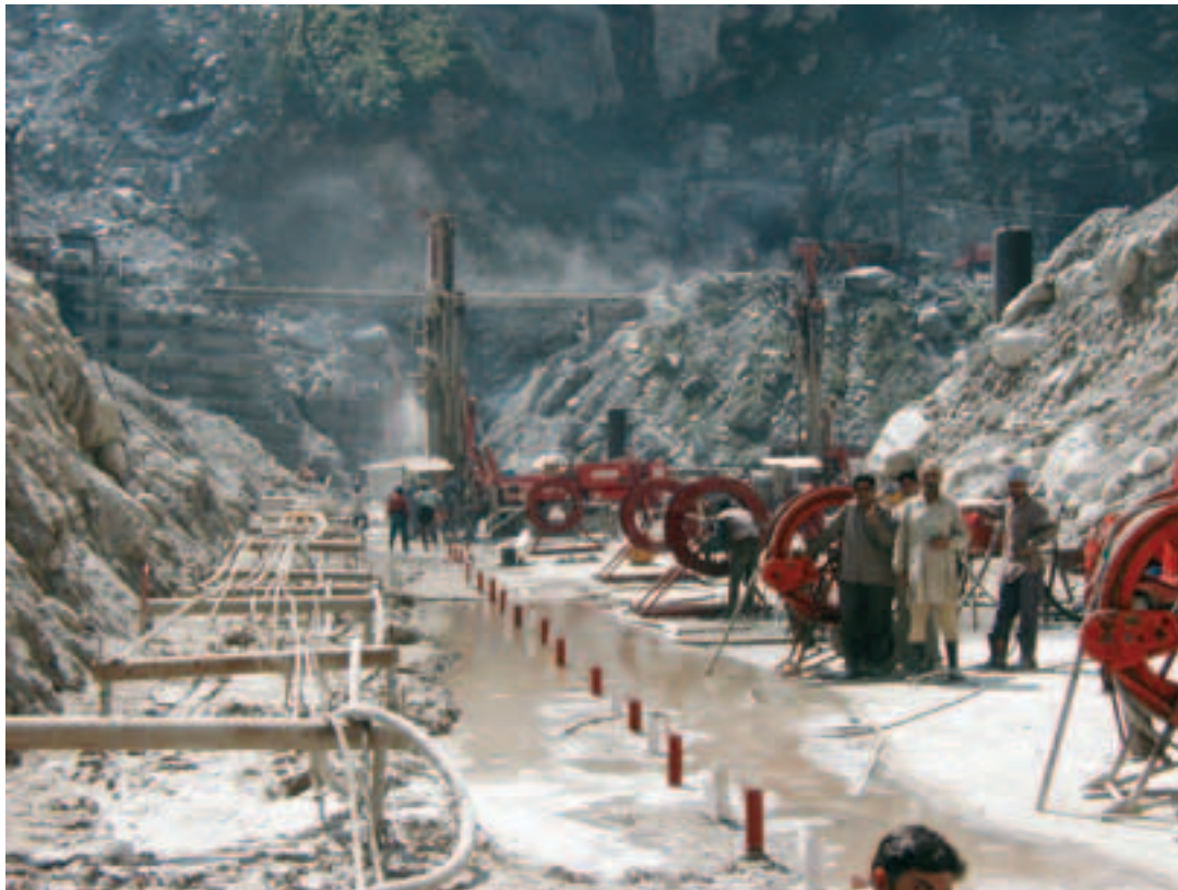
Photo 7 Exécution du voile d'injection Execution of the grout injection shear wall
