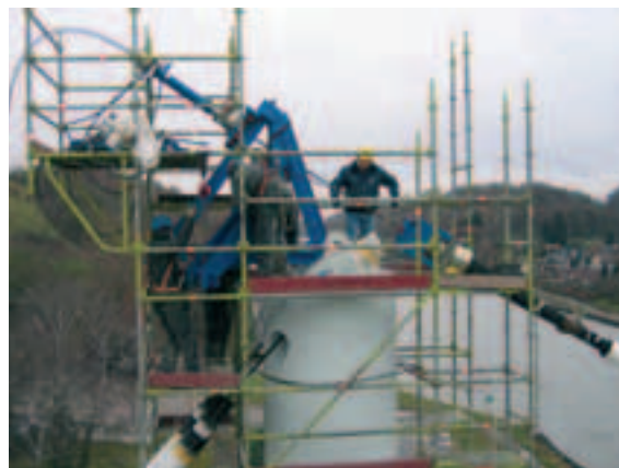
Photo 6 Levage par toron de la seconde extrémité du câble
