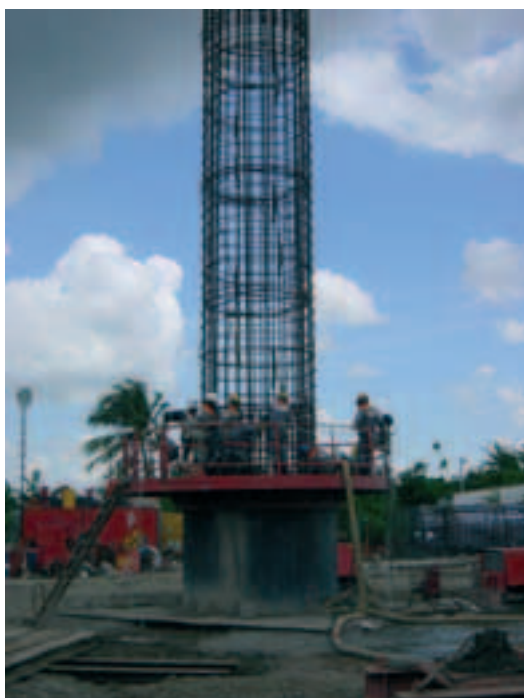
Photo 4 Can Tho - Mise en place d'une cage d'armature de 40 t Can Tho - Placing a 40-tonne reinforcement cage
