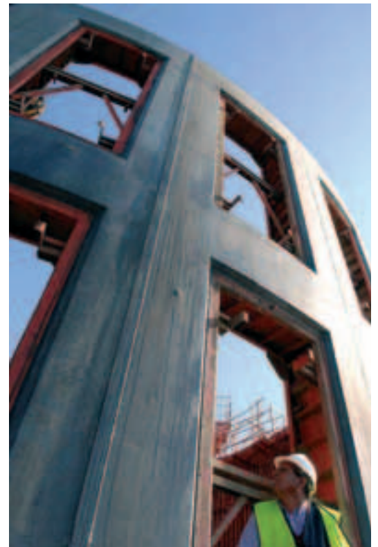
Photo 14 Ouvertures voile avant Front shear wall openings
