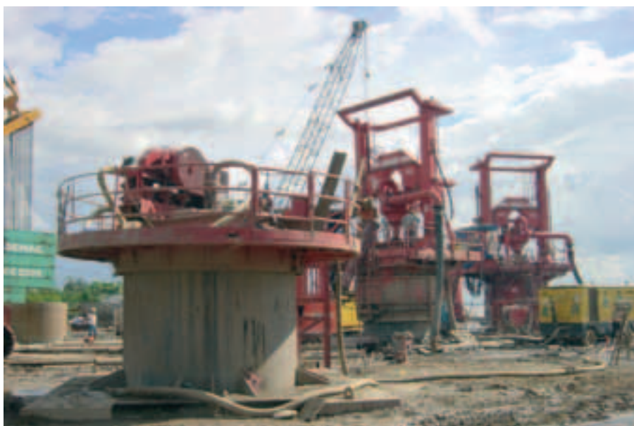
Photo 3 Can Tho - Deux machines de circulation inverse exécutant le forage Ø 2,50 m à 96 m de profondeur. Recyclage de boue au premier plan
