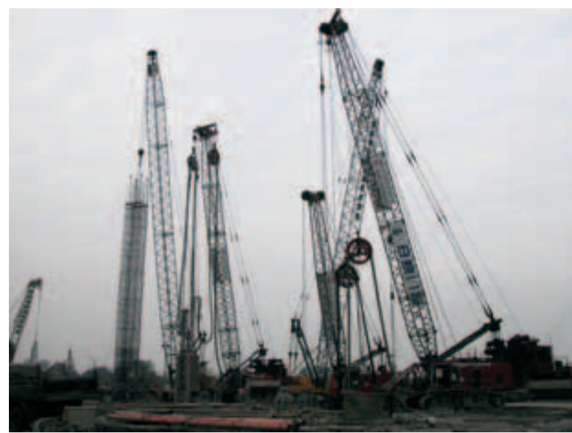
Wuhan - Le spectaculaire ballet des excavatrices et des grues de service
