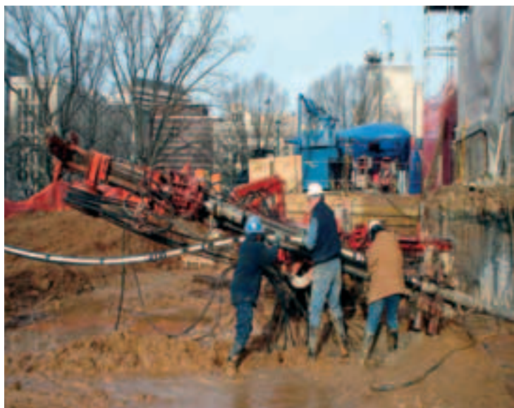
Photo 4 Mise en place d'un tirant dans un forage tubé
