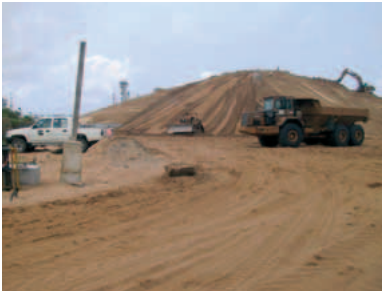
Photo 2 Opération de préchargement du réservoir LNG LNG tank preloading operation
