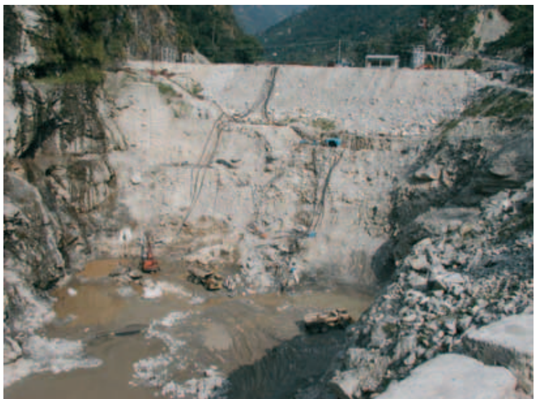
Photo 8 Travaux de terrassement dans la fouille à l'abri des batardeaux et des coupures étanches Earthworks in the excavation sheltered by the cofferdams and cutoffs
