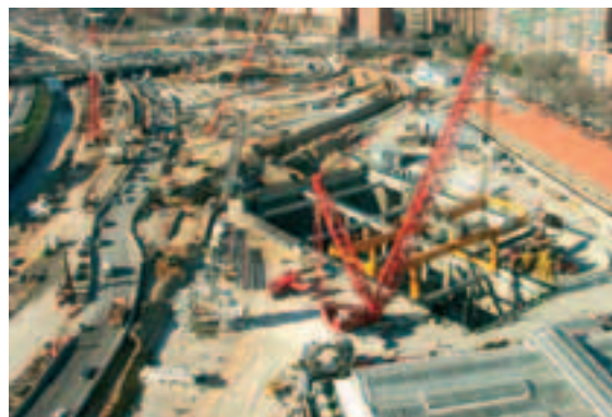
Echangeur sud. Puits d'accès en parois moulées pour le tunnelier
