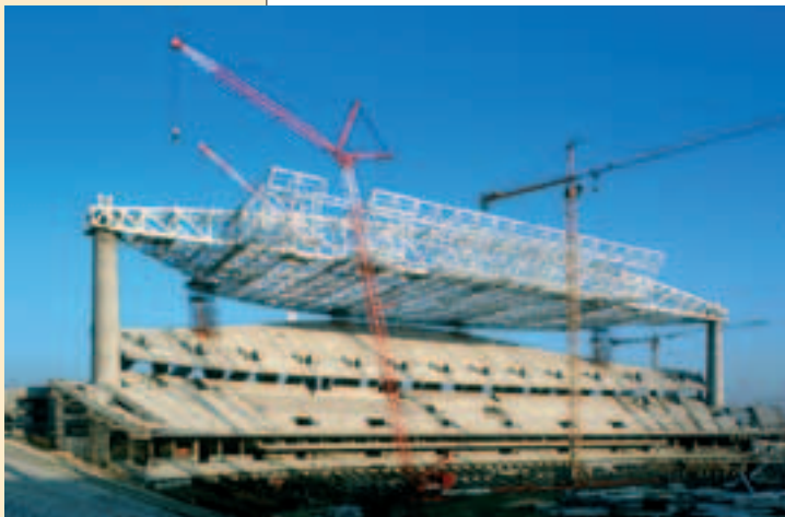
Photo 10 Tribune ouest du stade Atatürk à Istanbul Western grandstand of the Ataturk stadium in Istanbul
