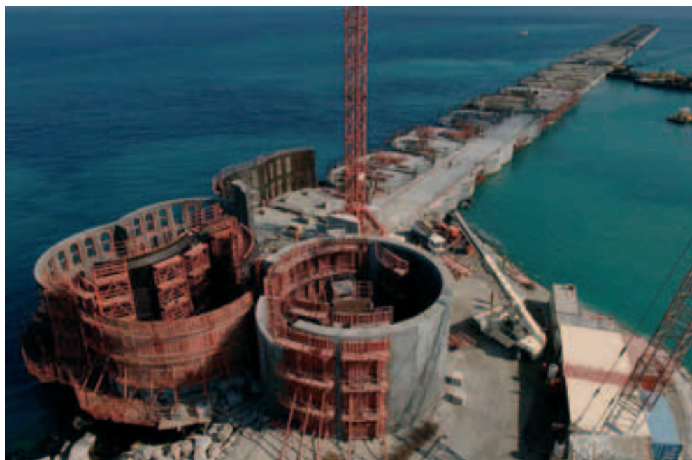
Photo 1 Vue générale des caissons General view of the caissons
