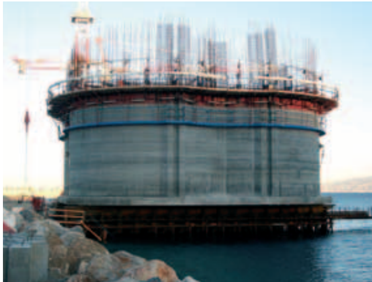
Photo 12 Deuxième phase de bétonnage Second phase of concreting
