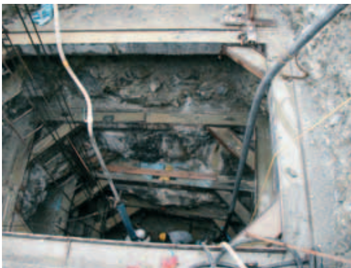
Photo 5 Le puits réalisé au centre du plot d'essai The shaft executed in the centre of the test section
