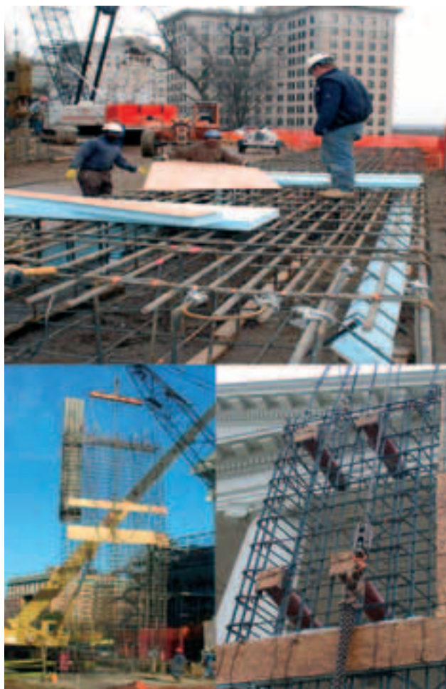
Photo 3 Cages d'armatures et diverses réservations
