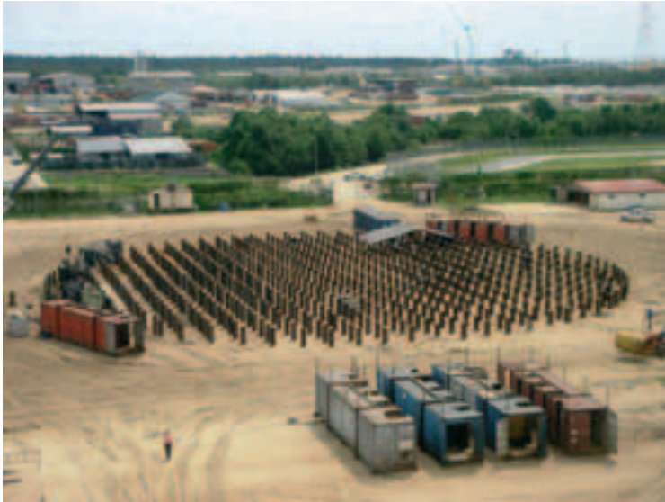
Photo 6 Battage des pieux. Pieux terminés Pile driving. Completed piles
