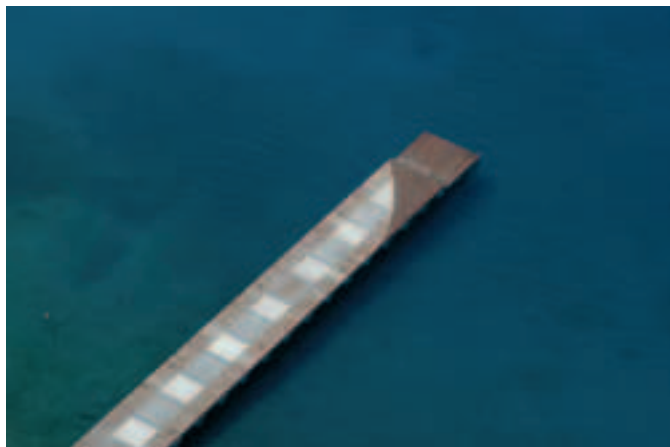
Photo 8 Vue aérienne Aerial view
