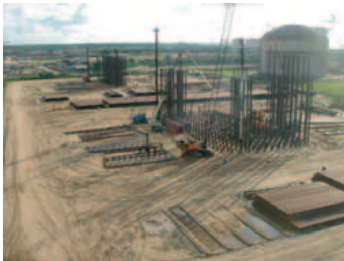
Photo 4 Battage des pieux des réservoirs LPG
