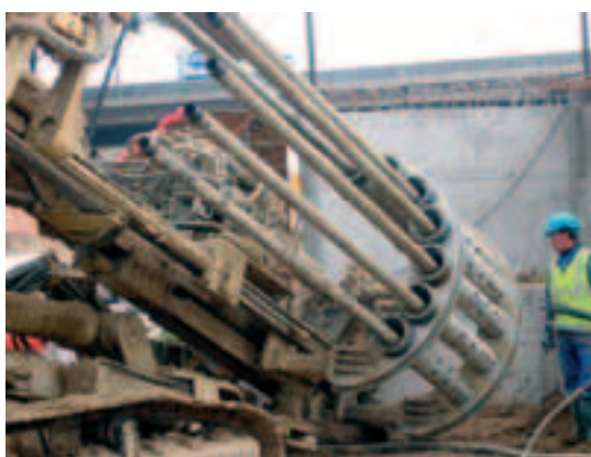
Atelier de tirants d'ancrage
