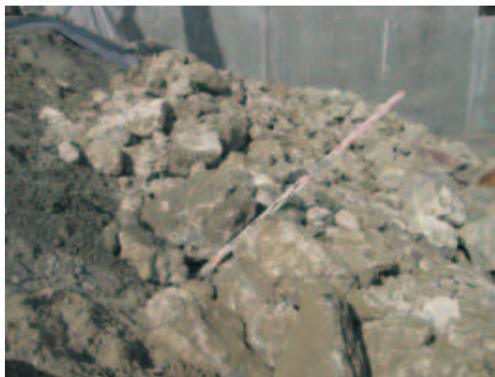
Photo 9 Mise en œuvre d'enrochements silico-calcaires en talus Placing silico-calcareous riprap on embankments
