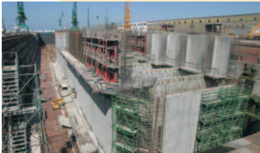
Photos 3 et 4 Réalisation des musoirs en forme 7 Construction of the pier heads in dry dock 7
