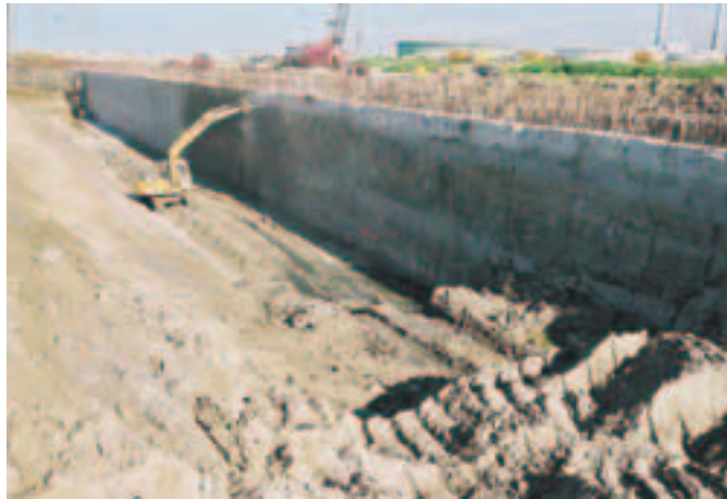
Photo 5 Préparation de la paroi côté aval Preparation of the downstream side wall
