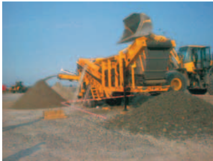
Photo 3 Vue sur site View on site
