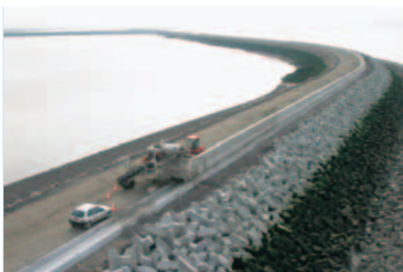
Photo 8 Préfabrication et stockage des Accropode™ sur le site de Port 2000 Prefabrication and storage of Accropode™ blocks on the Port 2000 site
