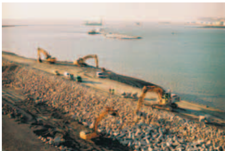
Mise en œuvre des blocs ACCROPODE™ Placing ACCROPODE™ blocks
