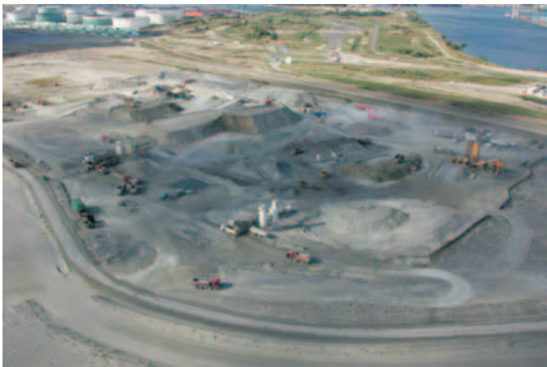
Photo 1 Vue générale des installations de chantier General view of construction plant
