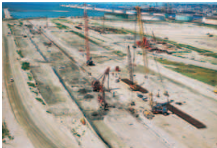
Photo 1 Réalisation de la paroi moulée formant le quai
