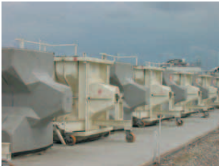
Photo 7 Moulage et décoffrage des ACCROPODE™
