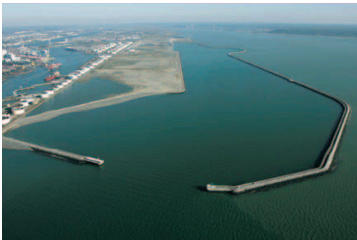
Photo 1 Les musoirs et la digue extérieure de Port 2000 The pier heads and the outer breakwater of Port 2000
