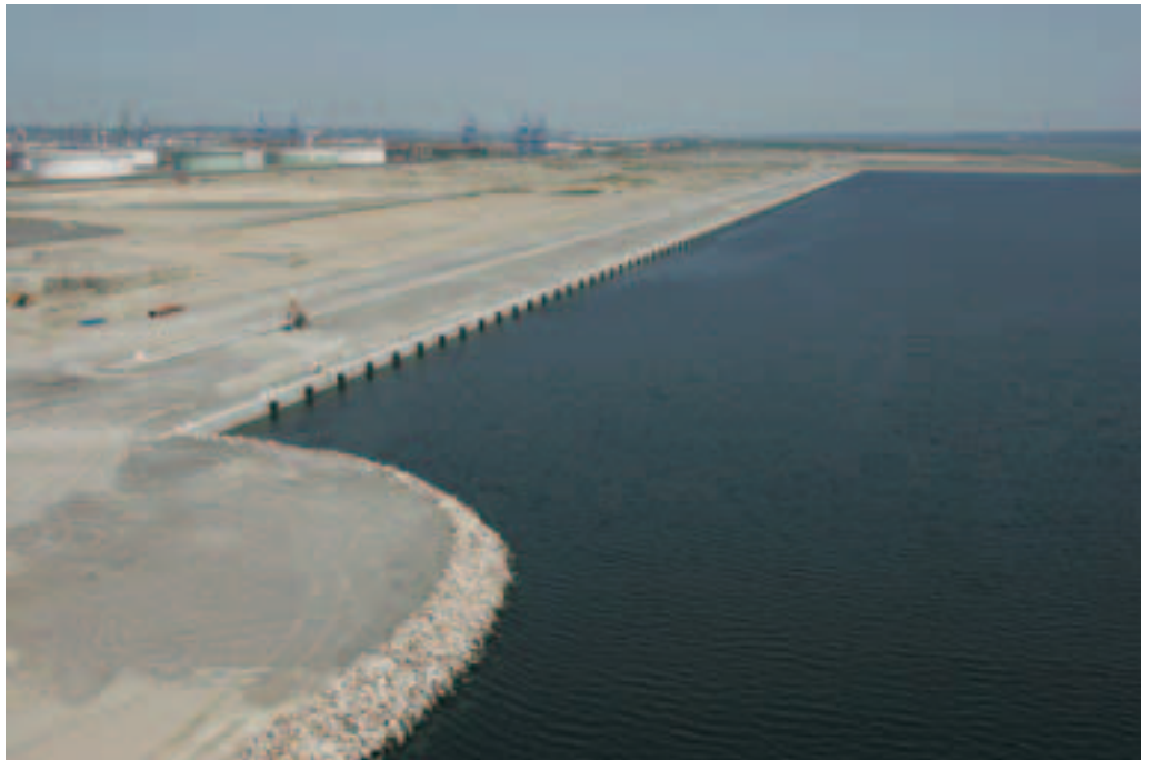
Photo 2 Réalisation de la paroi moulée servant de mur de quai pour les quatre premiers postes
