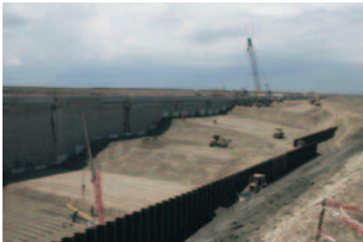
Photo 4 Réalisation de l'ancrage arrière Execution of the rear anchorage
