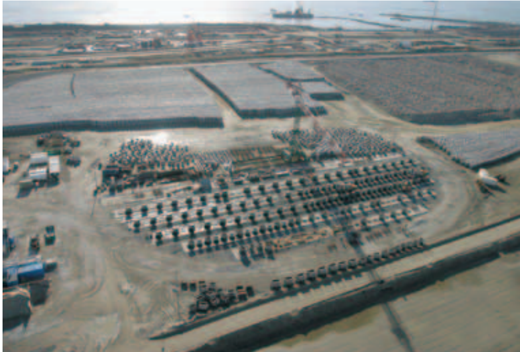
Photo 8 Préfabrication et stockage des Accropode™ sur le site de Port 2000 Prefabrication and storage of Accropode™ blocks on the Port 2000 site
