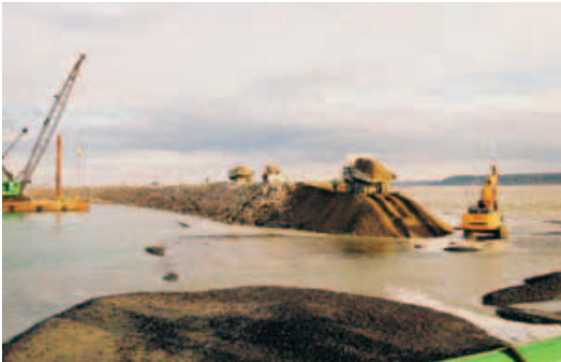
Mise en œuvre d'enrochements sur la digue sud Placing riprap on the southern breakwater
