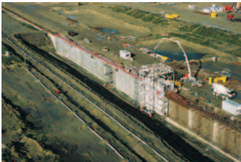
Photo 2 Réalisation du génie civil de la poutre de couronnement Performance of civil engineering for the coping girder
