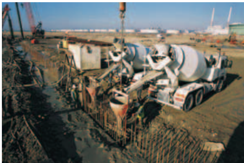
Photo 3 Coulage d'un panneau de paroi
