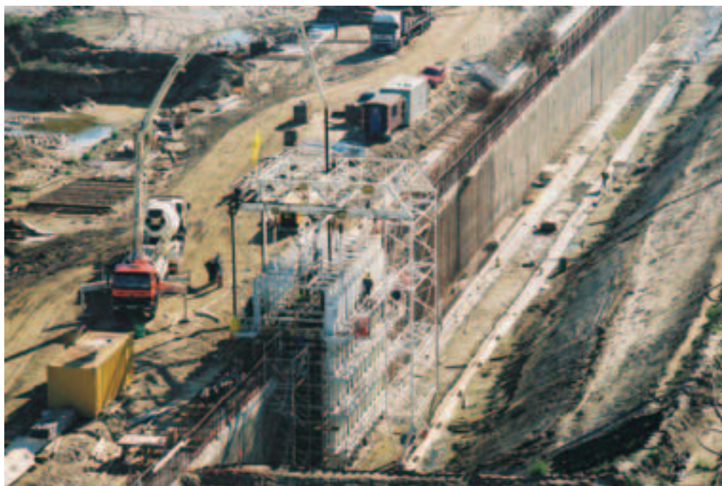
Photo 6 Construction de la poutre de couronnement
