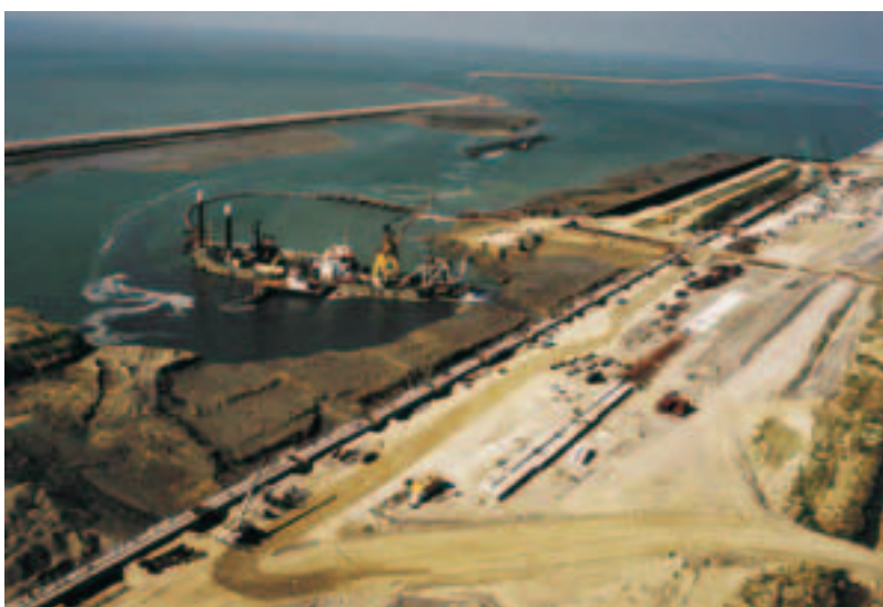
Photo 4 Dragage de la darse en avant du quai
