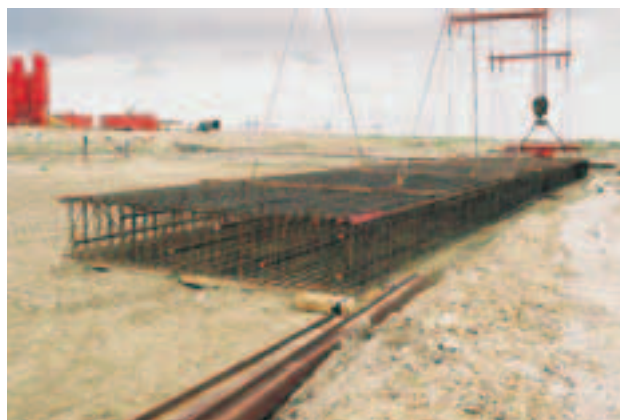
Photo 2 Dispositif de levage des cages Cage lifting device
