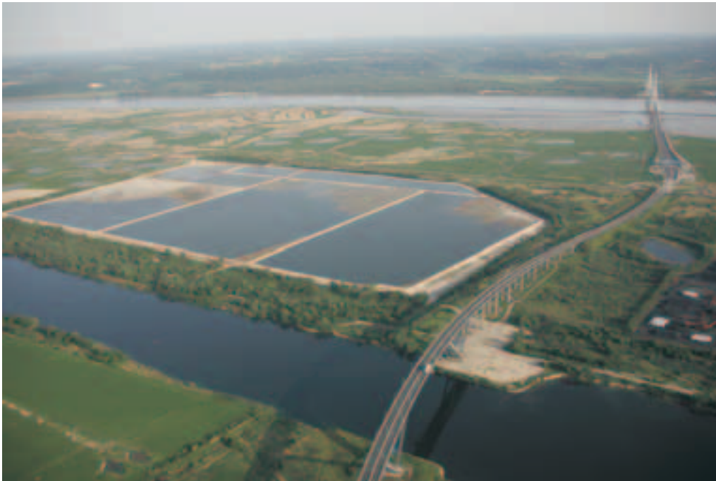
Photo 1 Chambres de dépôt Settling chambers
