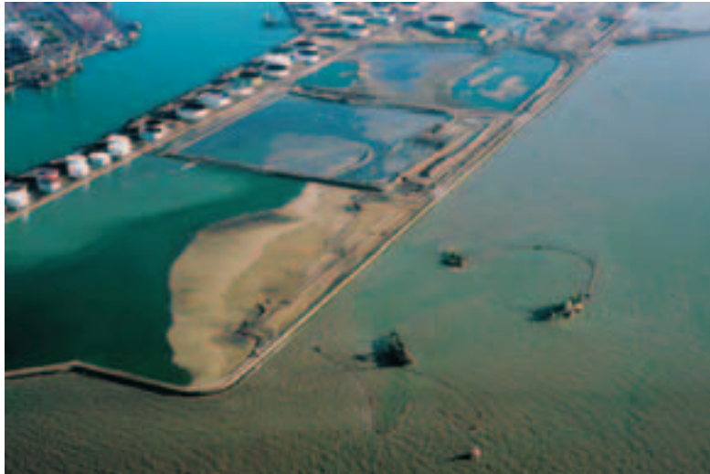
Remplissage des casiers par deux DSD
