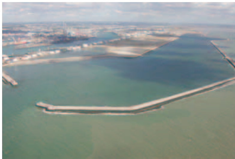
Photo 1 Avancement des travaux à fin septembre 2005 (source: Port Autonome du Havre)
