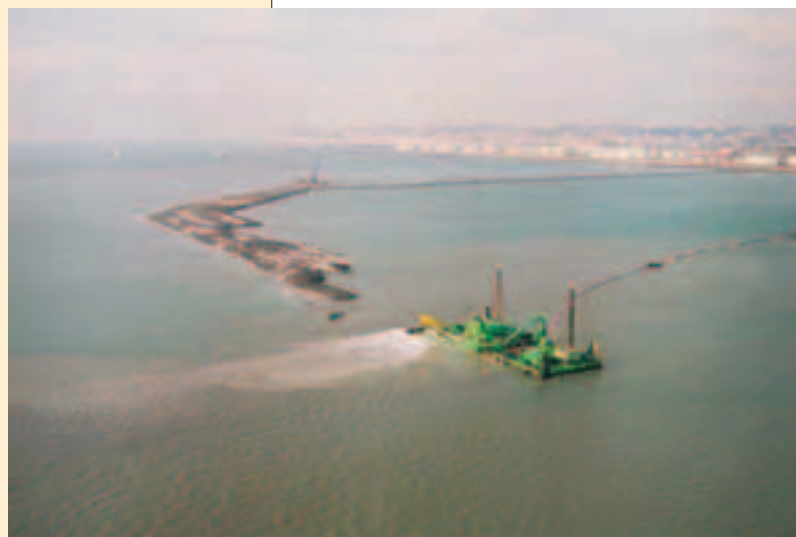
Soubassement de la boucle ouest en cours avec Bayard II
