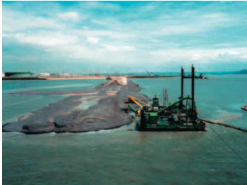
Photo 11 Réalisation du soubassement de la digue
