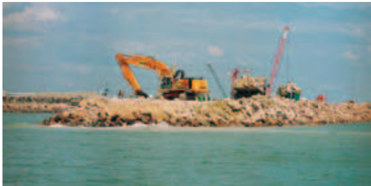
Mise en œuvre d'enrochements sur la digue sud Placing riprap on the southern breakwater
