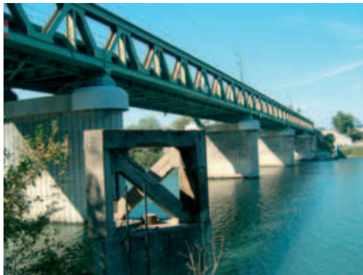
Photo 1 Vue générale du premier pont SNCF avec son tablier reconstruit après 1945
