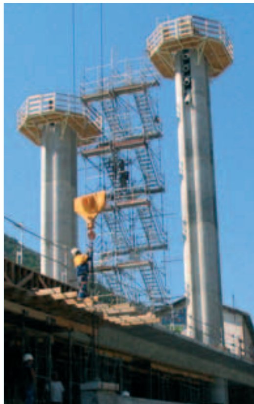
Photo 8 Construction des mâts du pylône. Vue d'ensemble et accès aux plates-formes de travail Construction of tower masts. Overall view and access to the work platforms
