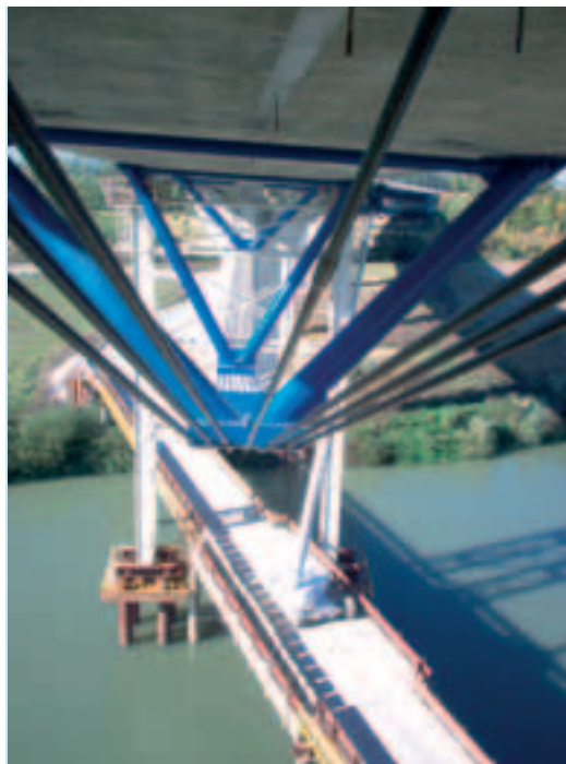
Photo 5 Mise en place des câbles du sous-bandage : vue depuis la sous-face du tablier Laying the sub-binding cables : view from the underside of the deck
