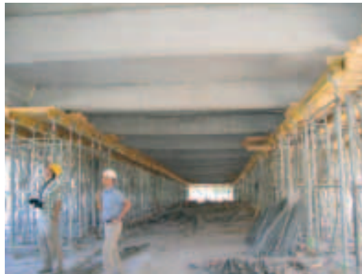
Photo 7 Construction du tablier sur centrage. a) Vue générale du centrage et plaques d'ancrage de la précontrainte. b) Entretoises et prédalles préfabriquées en sous-face du tablier
