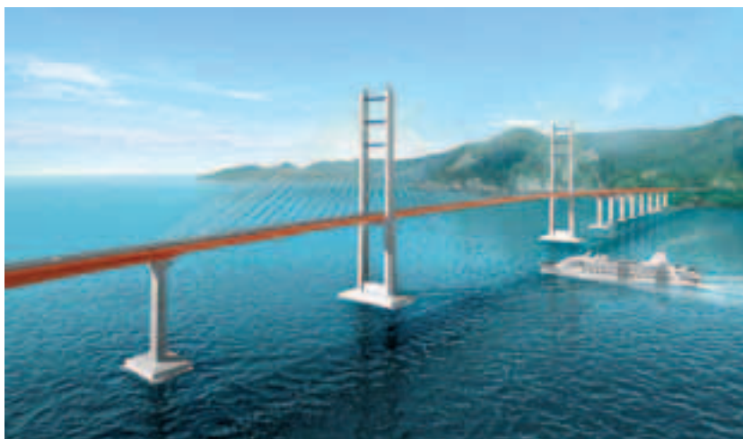
Photo 3 Vue virtuelle de l'ouvrage terminé depuis l'amont Virtual view of the completed structure from upstream
