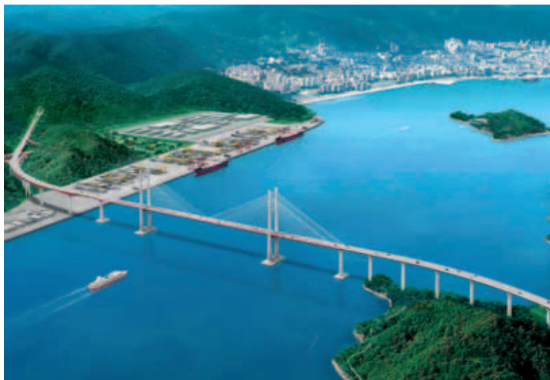
Photo 1 Vue virtuelle de l'ouvrage terminé depuis l'aval
