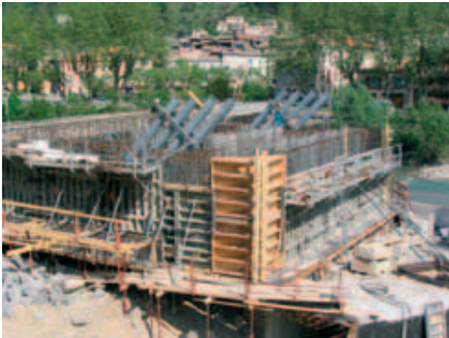
Photo 6 Culé rive droite. Partie supérieure mobile. a) Coffrage et ferrailage (mai 2004). b) Décoffrage septembre 2004
