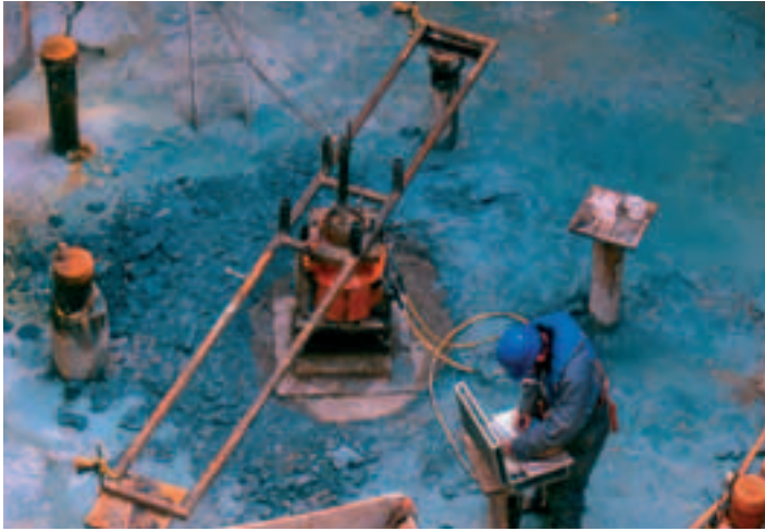
Photo 8 Essai de traction en fond de batardeau sur un micropieu définitif Tensile tests at the cofferdam bottom on a permanent micropile
