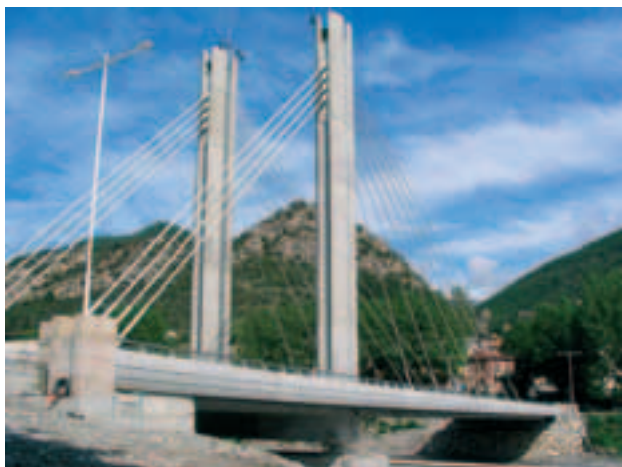
Photo 18 Vue rapprochée de l'ouvrage Close-up view of the structure
