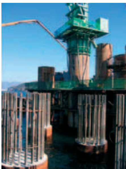
Photo 5 Equipements en tête de pieu diamètre 3 m Pile head equipment of diameter 3 m
