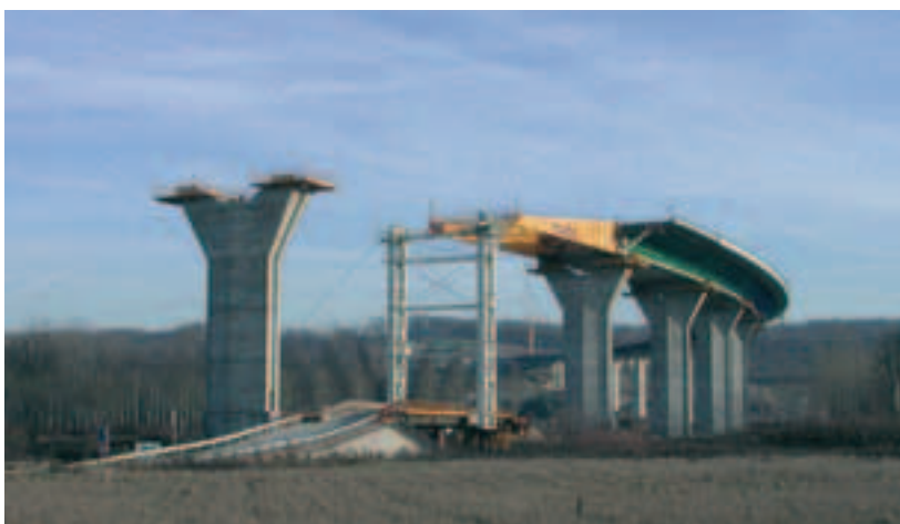
Photo 1 L'avant-bec franchissant la travée sur la Marne
