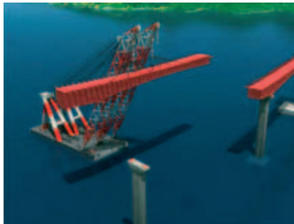
Photo 14 Vue virtuelle de la mise en place d'une travée complète du tablier ouest à l'aide d'une grue flottante Virtual view of placing of a complete span of the western deck using a floating crane
