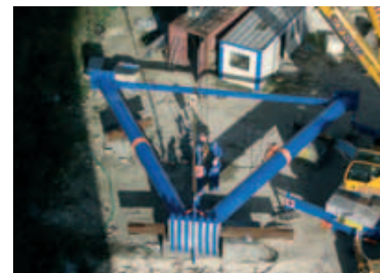
Photo 9 Préparation au sol
