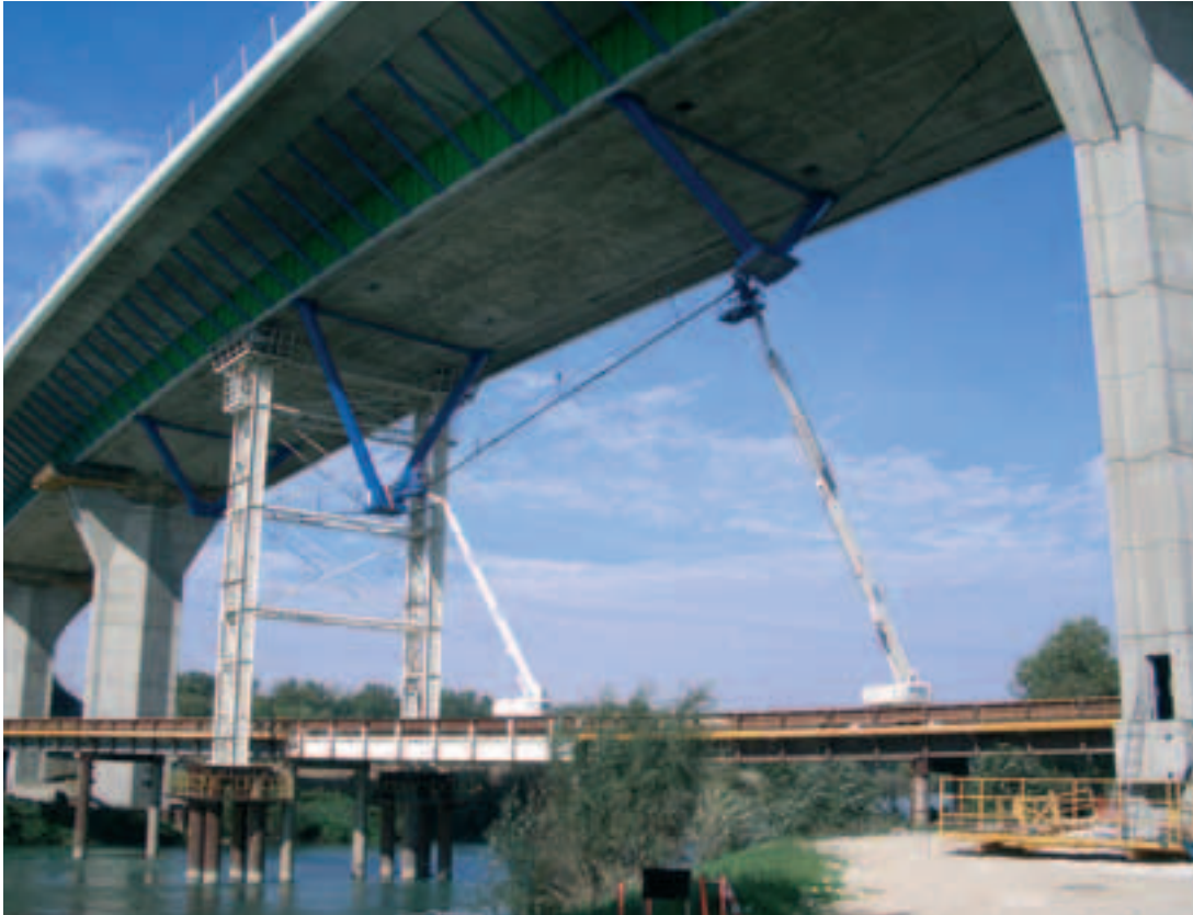
Photo 13 Mise en place des gaines PEHD Placing HD polyethylene ducts
