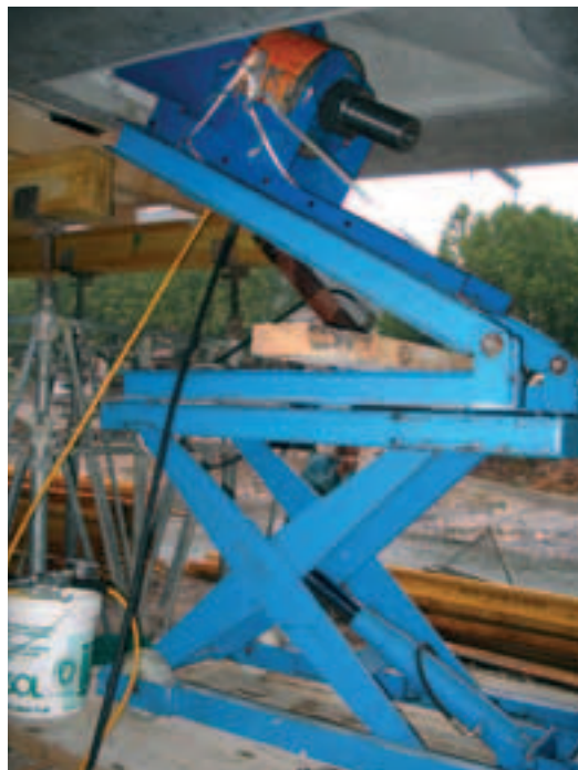
Photo 11 Mise en tension des haubans avant rotation depuis la sous-face du tablier
