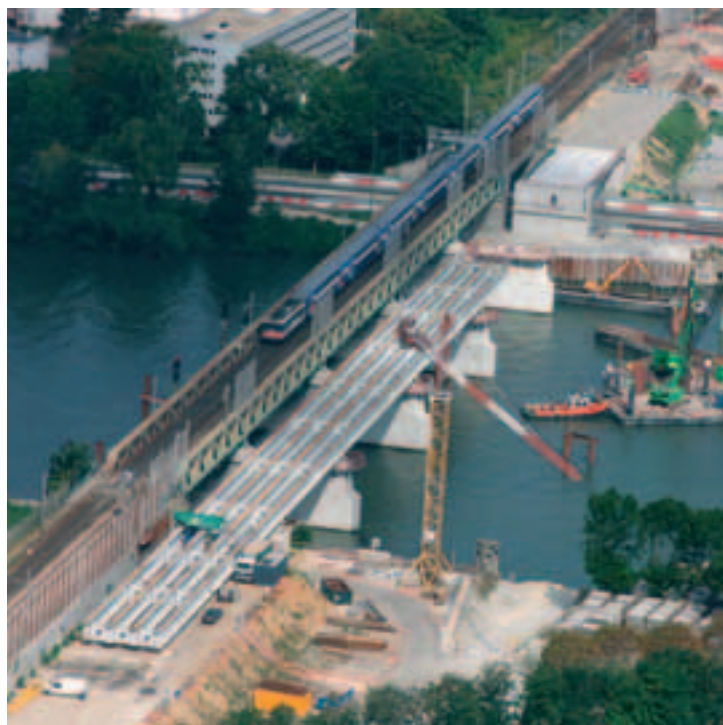
Photo 2 Vue générale de l'ouvrage en cours de construction
