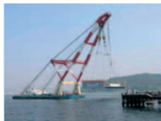
Photo 8 Levage de coque préfabriquée : phase 3, arrivée sur site Lifting a prefabricated shell : phase 3, arrival on site
