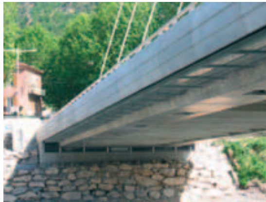
Photo 14 Butée parasismique de blocage latéral en culée rive gauche
