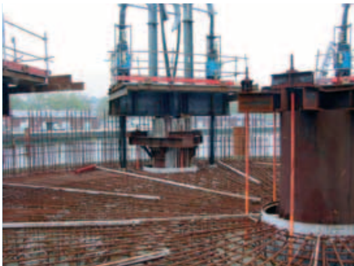
Photo 9 Radier du gabion : déformée pendant le vérinage Gabion foundation raft : deformation during jacking
