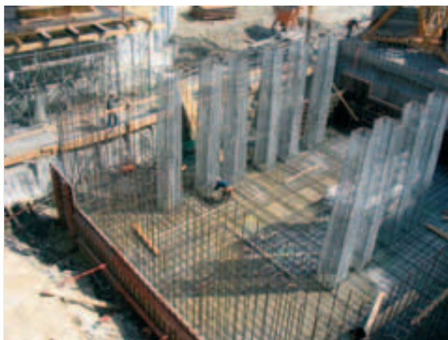
Photo 5 Culée rive droite. Partie inférieure fixe. Ferrailage et réservations pour les cheminées de solidarisation (mai 2004)
