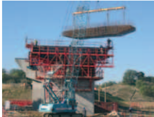
Photo 4 Coffrage et ferrailage d'un chevêtre Formwork and reinforcement for a joist
