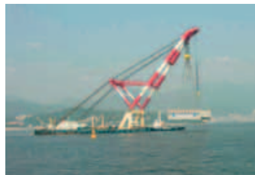
Photo 7 Levage de coque préfabriquée : phase 2, transport sur site Lifting a prefabricated shell : phase 2, transport to site
