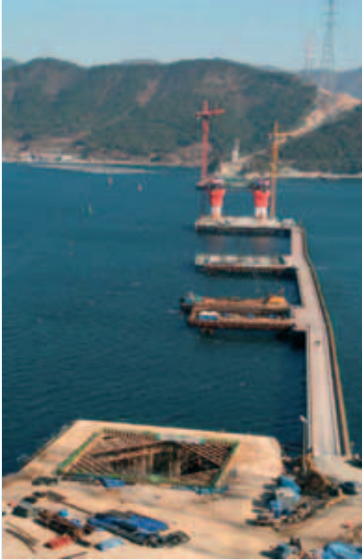
Photo 18 Vue d'ensemble du chantier (décembre 2005) avec le coffrage glissant sur PY1 et les estacades provisoires
