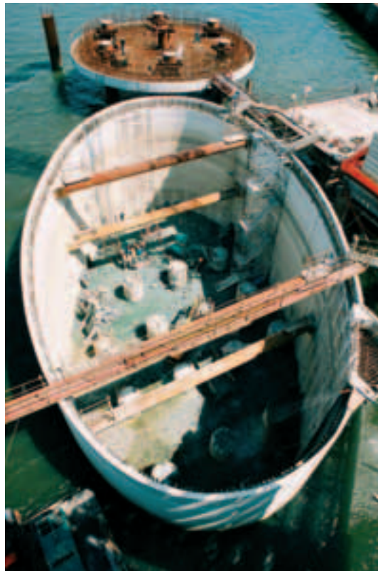
Photo 5 Socle après vidange Base after drainage
