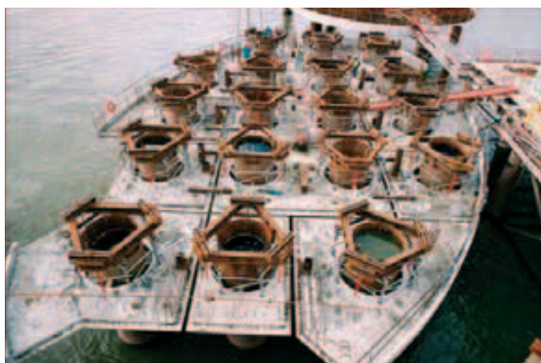
Photo 4 Socle. Assemblage des éléments préfabriqués Base. Assembling prefabricated elements
