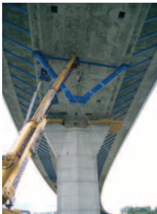
Photo 11 Pose de l'étauçon P8 à la grue Placing the P8 prop by crane
