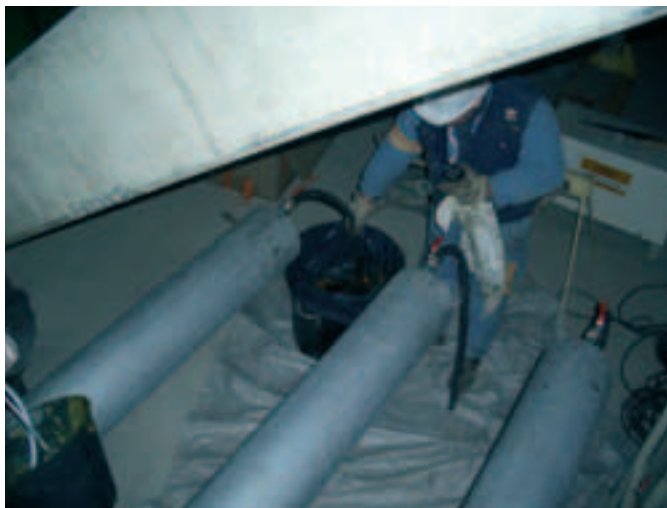
Photo 16 Injection à la cire et tube rallonge de démontage
