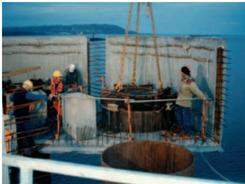
Photo 2 Pont de Normandie - Viaduc nord. Construction des fondations
