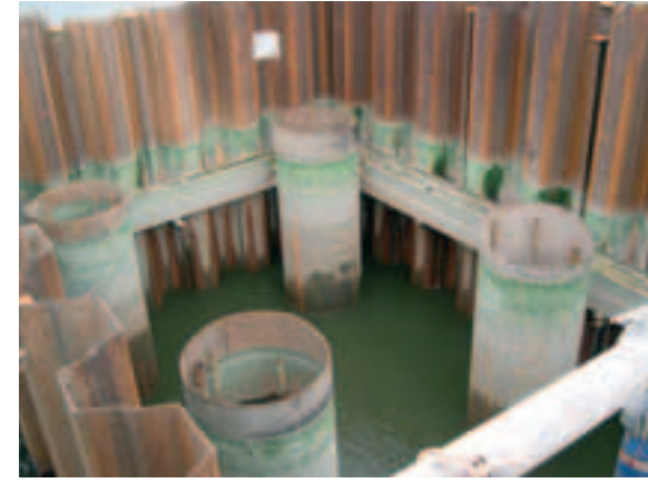
Photo 3 Pieux pile P8 P8 pier piles
