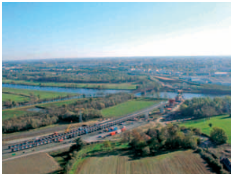
Photo 1 Le bipoutre en cours de réalisation The double girder undergoing construction
