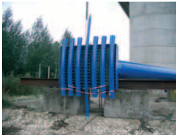
Photo 8 Préparation et assemblage au sol
