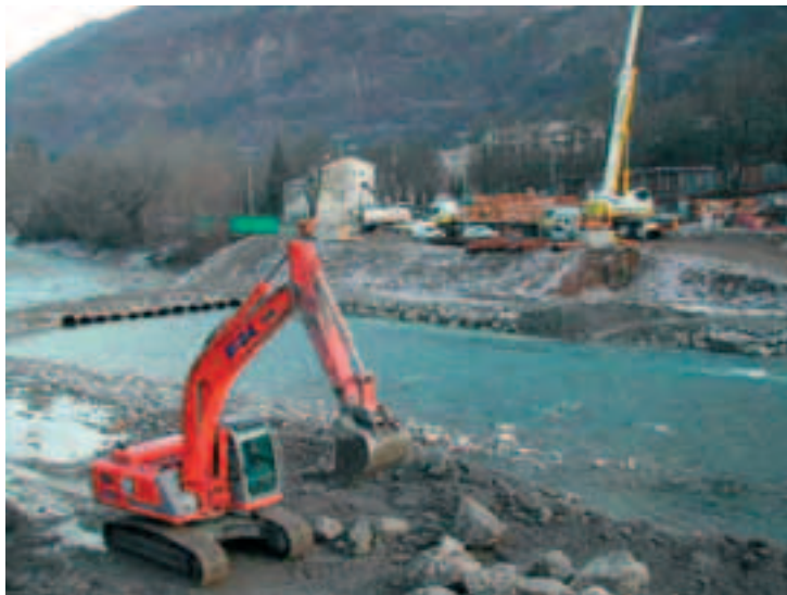
Photo 3 Travaux de terrassement généraux et de battage des palplanches (septembre 2002)
