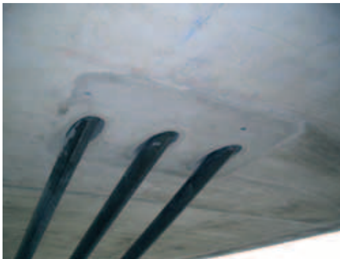
Photo 17 Traitement de la sortie des câbles
