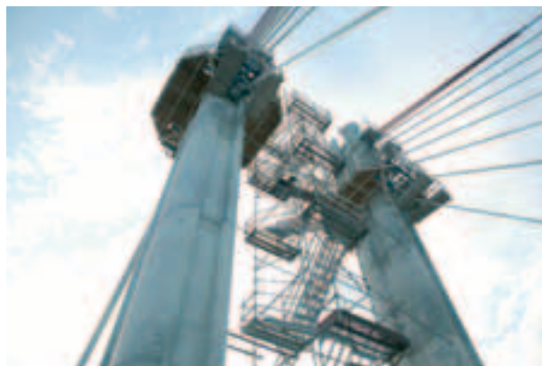
Photo 15 Réglage définitif des haubans depuis les têtes de mâts
