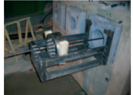
Photo 14 Enfilage des torons depuis l'intérieur du caisson Inserting tendons from the inside of the box girder
