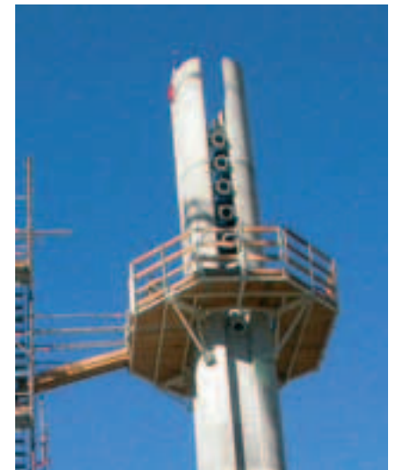
Photo 9 Boîtes d'ancrage métalliques des haubans Steel anchorage boxes for stay cables
