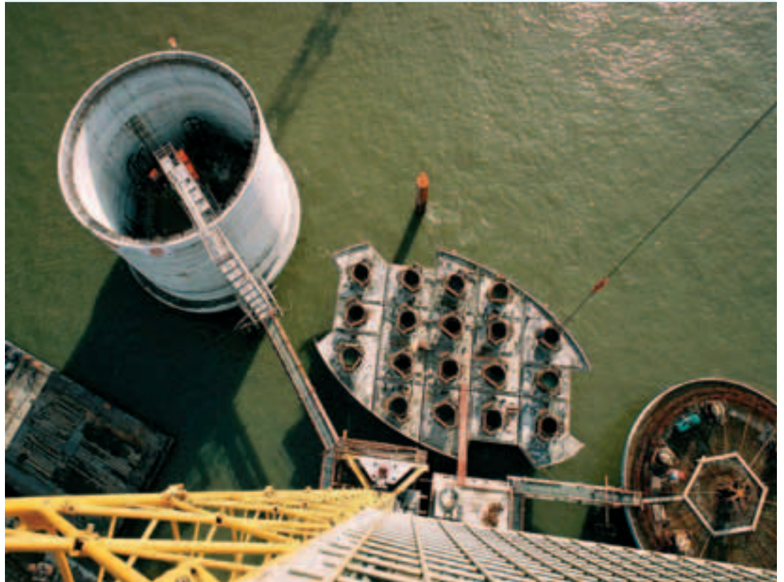
Photo 7 Gabion prêt pour descente Gabion ready for lowering
