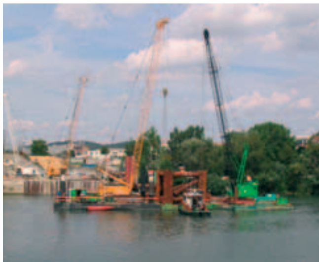
Photo 4 Mise en œuvre des ducs d'Albe Installing dolphins
