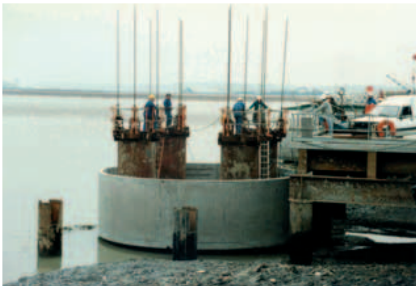
Photo 4 Socle. Assemblage des éléments préfabriqués Base. Assembling prefabricated elements
