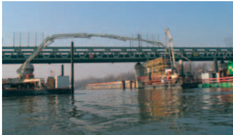
Photo 10 Bétonnage de l'une des piles du nouveau pont Concreting one of the piers of the new bridge
