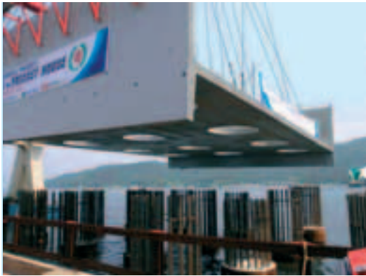
Photo 9 Levage de coque préfabriquée: phase 4, début de pose de la coque Lifting a prefabricated shell: phase 4, start of shell laying
