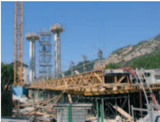
Photo 7 Construction du tablier sur centrage. a) Vue générale du centrage et plaques d'ancrage de la précontrainte. b) Entretoises et prédalles préfabriquées en sous-face du tablier
