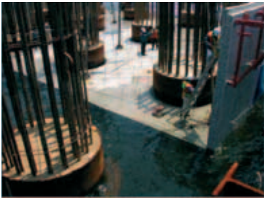
Photo 10 Levage de coque préfabriquée: phase 5, coque en place Lifting a prefabricated shell: phase 5, shell in place
