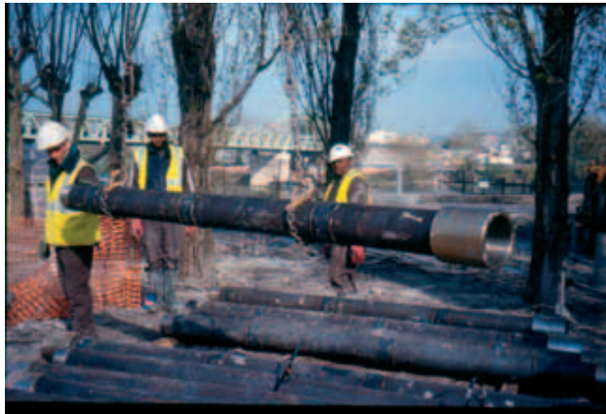
Photo 3 Armature des micropieux; tube acier 180 mm e = 27,5 mm
