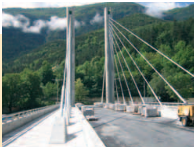
Photo 16 Pose des superstructures et équipements. a) Dallage des trottoirs. b) Réserve pour spot d'éclairage dans les plots d'ancrage des haubans. c) Spots d'éclairage des haubans de retenue
