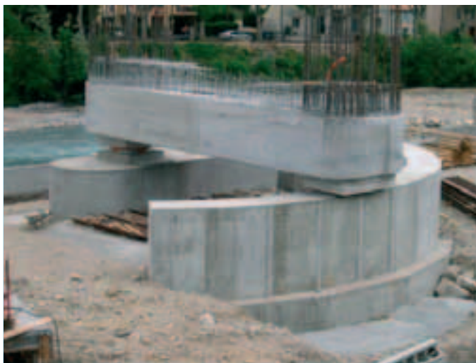
Photo 4 Positionnement de l'entretoise sous pylône sur la longrine circulaire avant la rotation et détail de la couronne de guidage de l'appareil d'appui fixe servant de pivot
