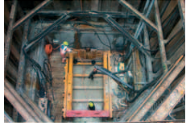
Photo 5 La station principale de poussée dans le puits de départ The main pushing station in the outgoing shaft
