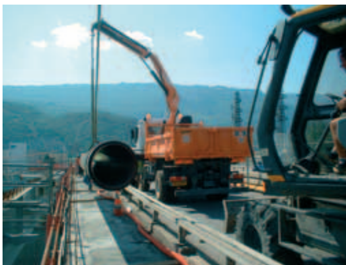
Photo 6 Mulhouse. Pour TPHR, la réalisation des réseaux d'assainissement en diamètre 100 à 6 m de profondeur a représenté une des principales difficultés du lot de déviation de réseaux
