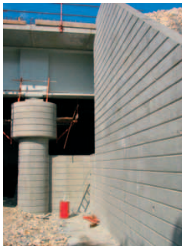
Photo 2 Pile en rive droite Pier on the right bank
