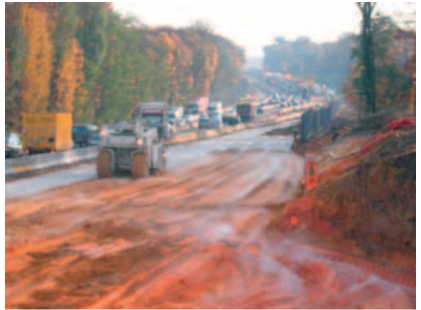
Photo 2 Vue d'ensemble pendant la réalisation du LTCC (limon traité chaux-ciment) Overall view during production of lime/cement treated loams
