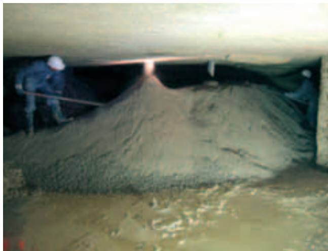
Photo 5 Réalisation d'un barrage dans la carrière de Gravelle avant comblement Construction of a barrier in the Gravelle quarry before filling
