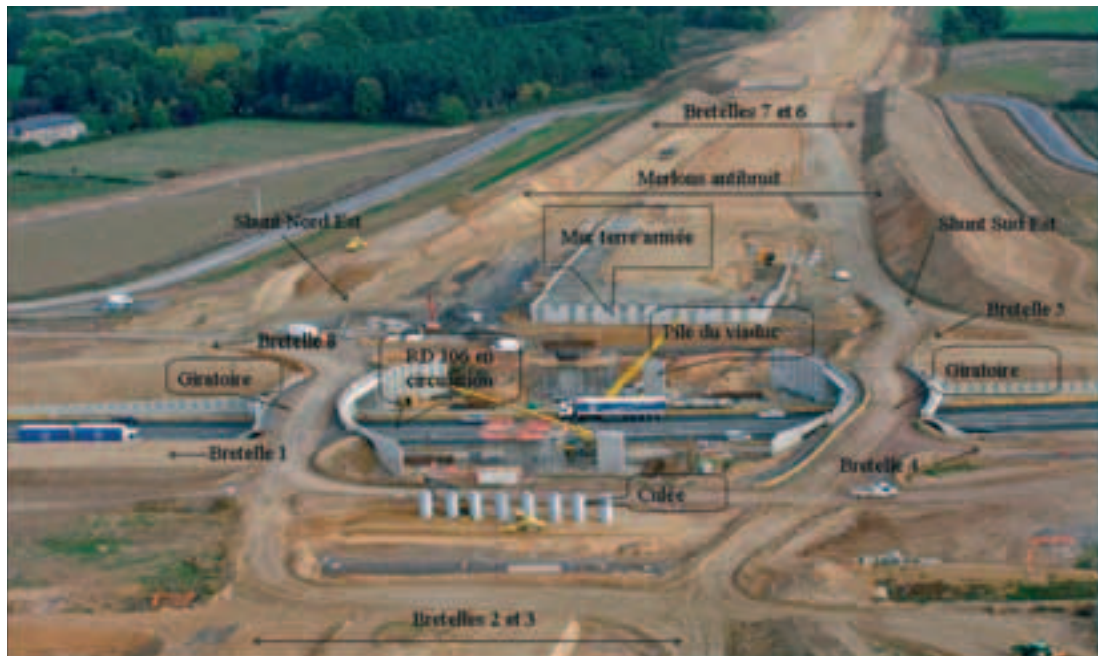
Photo 4 Vue aérienne de l'échangeur de la RD 106 montrant la route départementale 106 à 2 x 2 voies en circulation au premier niveau, les passages supérieurs du giratoire d'échange au deuxième niveau d'où partent les bretelles de raccordement, et la construction du troisième niveau avec les appuis du viaduc ainsi que les remblais d'accès, le mur en terre armée et les merlons antibruit de part et d'autre
