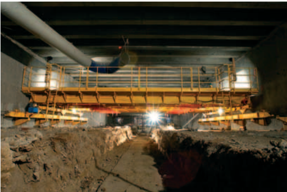
Photo 6 Table coffrante pour les planchers Flying form table for the floors
