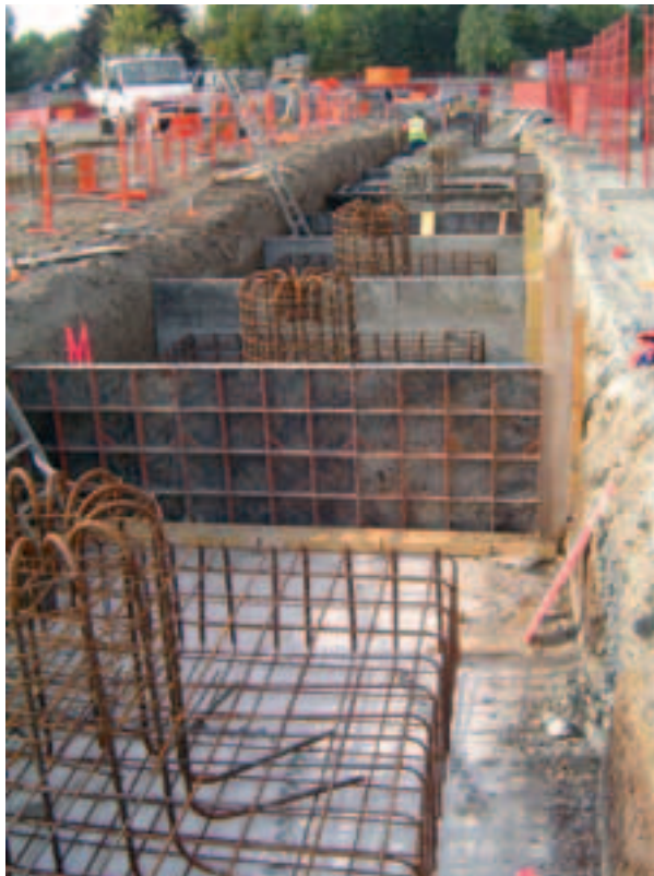
Photo 16 Clermont-Ferrand. Tout le long du tracé, Sobea Auvergne réalise les massifs d'ancrage des mâts des "lignes aériennes de contact" (LAC), qui supporteront notamment les câbles d'alimentation électrique du tramway
