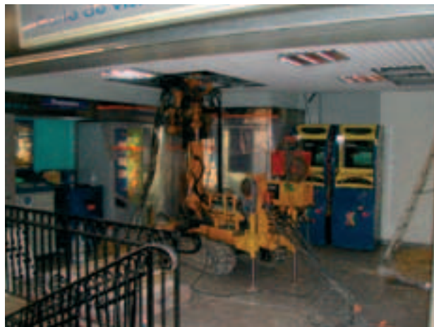
Photo 10 Injections de vides de dissolution gare de l'Est à Paris. Travail de nuit Cement grouting of dissolution interstices in gare de l'Est railway station in Paris. Night work
