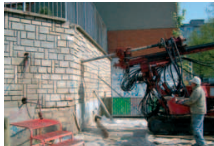
Photo 1 Cloutage du mur de l'église de Saint-Ouen Studding the wall of Saint-Ouen church
