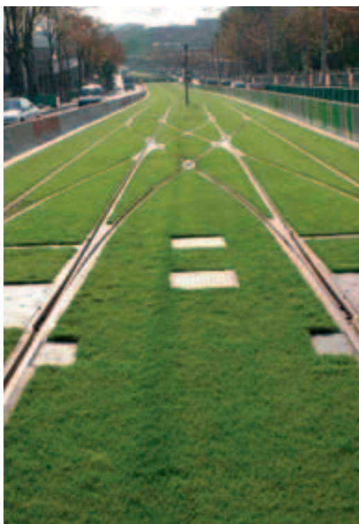
Photo 10 Appareils de voie Points and crossings
