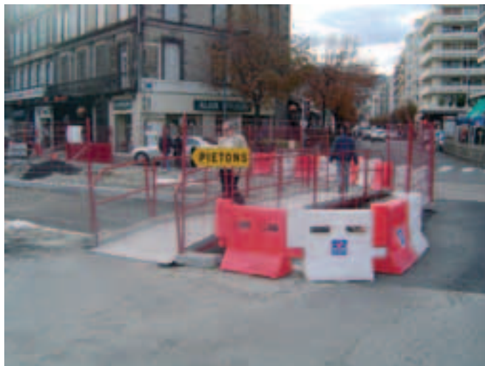
Photo 17 Clermont-Ferrand. L'installation des clôtures de protection de 2 m de haut autour du chantier et l'aménagement des voies de circulation automobiles et piétonnières, particulièrement soignées, sont une clause contractuelle du marché
