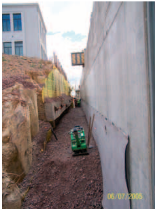
Photo 6 Mise en œuvre de remblais techniques 0/60 entre les piédroits de la tranchée couverte et le soutènement du bâtiment CFA
