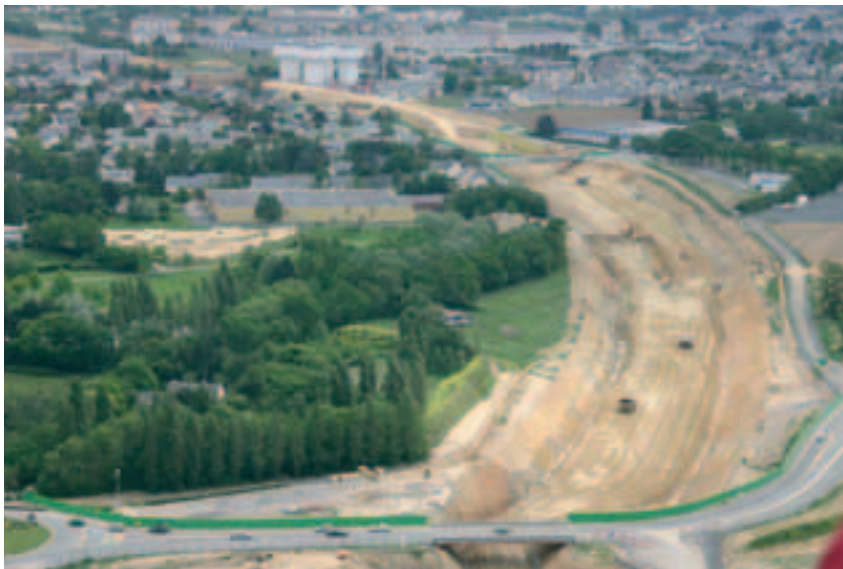
Photo 2 Vue aérienne des terrassements de la tranchée couverte. Les deux ponts provisoires assurent la continuité des terrassements et le maintien de la circulation publique
