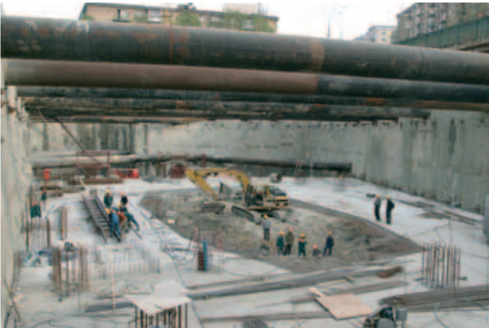
Photo 2 La dalle annulaire sous les butons The annular slab under the stays
