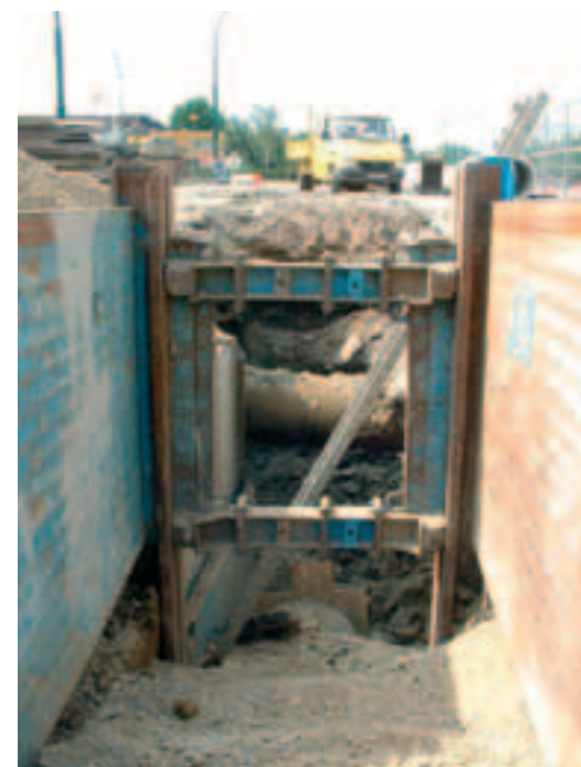
Photo 6 Mulhouse. Pour TPHR, la réalisation des réseaux d'assainissement en diamètre 100 à 6 m de profondeur a représenté une des principales difficultés du lot de déviation de réseaux
