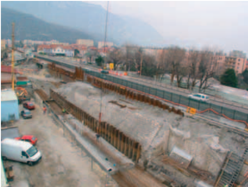
Photo 6 Murs rampe Désaire + blindage Walls of the Désaire ramp + armoring
