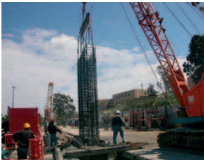
Photo 3 Descente d'une cage d'armature
