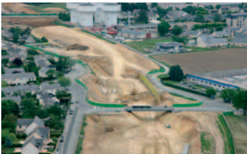
Photo 3 Vue aérienne. Le soutènement provisoire (rideau jaune) s'est avéré nécessaire dans les zones congestionnées. Au pied des châteaux d'eau, atelier de déminage
