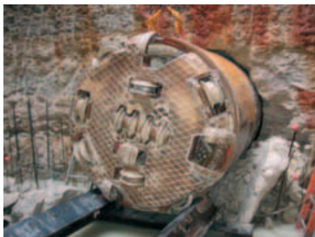
Photo 11 Sortie du microtunnelier dans le puits "Sarrail" Microtunneller exit in the "Sarrail" shaft
