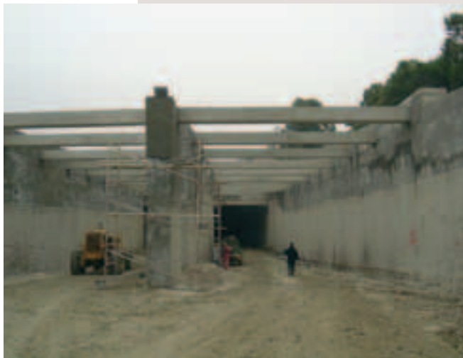
Photo 6 La trémie 1 en voie de finition Finishing work on underpass 1
