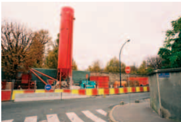
Photo 6 Réhabilitation d'égout rue Diderot à Pantin Rehabilitation of a sewer in Diderot street in Pantin
