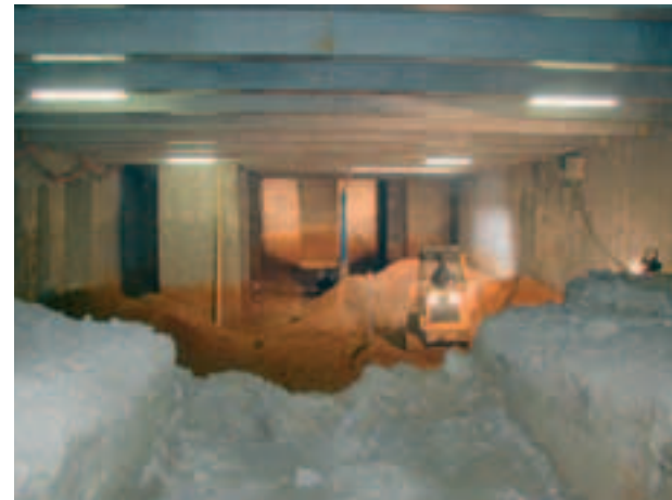
Photo 5 Terrassement en taupe sur une hauteur correspondant à deux niveaux Underground earthworks over a height corresponding to two levels
