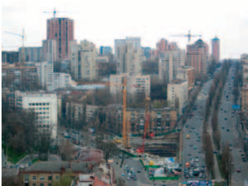
Photo 1 La fouille entre le boulevard Lesi Ukrainky et la rue Mechnykova
