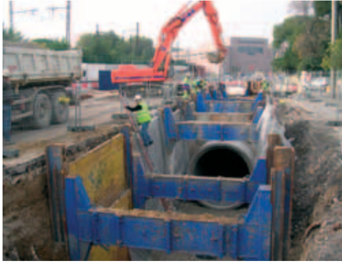
Photo 9 Montpellier. Sa situation en plein centre-ville et dans une zone inondable rend complexe l'exécution du collecteur de Chambéry (diamètre 2800), une conduite sera en permanence en charge complète
