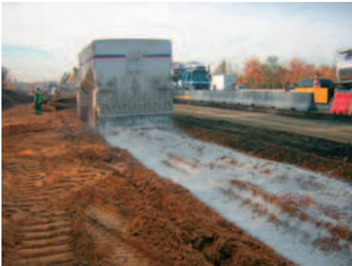
Photo 1 Liant à faible émission de poussière permettant la réalisation du traitement à moins d'un mètre de l'emprise de circulation préservant l'environnement forestier. Avec 3000 t utilisées, le chantier de la RN286 est actuellement celui qui a nécessité le plus important volume de Ligex 16 EPR
