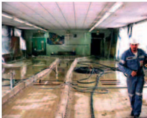
Photo 11 Injections dans l'école Simon Bolivar à Paris Cement grouting in Simon Bolivar school in Paris
