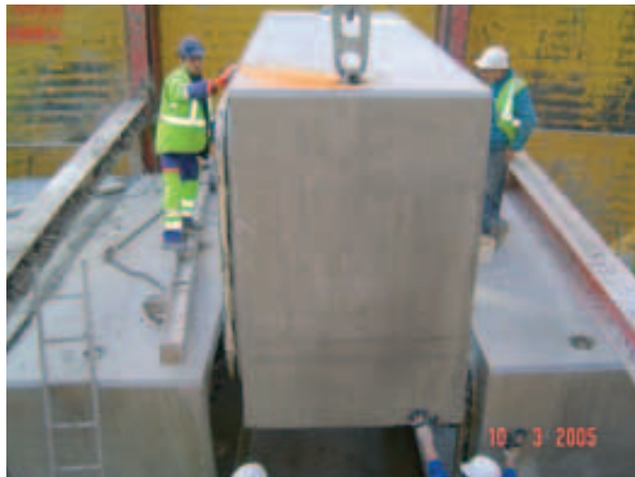
Photo 12 Nice. Mise en place de l'un des 900 éléments du nouveau grand collecteur
