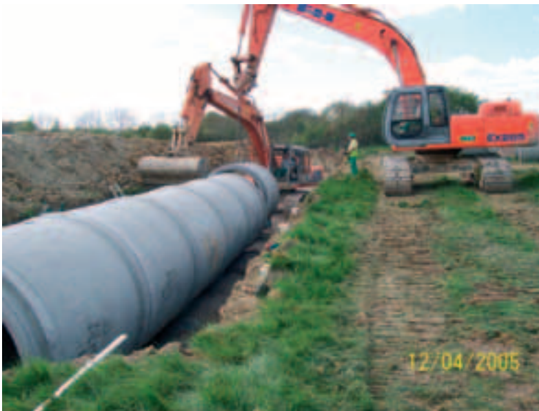
Photo 5 Atelier de pose d'un diamètre 1800 Equipment for laying dia. 1.800 mm pipe
