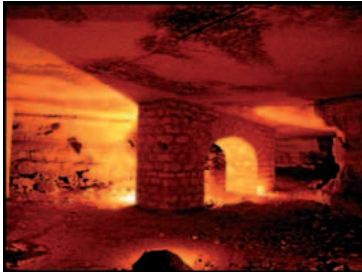
Photo 5 Réalisation d'un barrage dans la carrière de Gravelle avant comblement Construction of a barrier in the Gravelle quarry before filling
