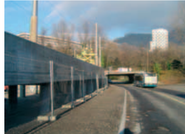
Finitions ouvrage Valmy
