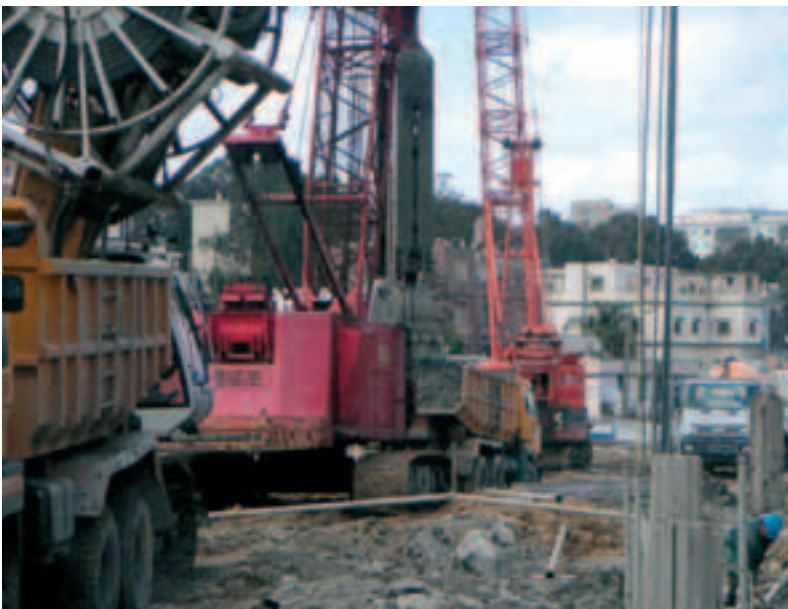
Photo 1 Exécution des parois moulées et barrettes de la trémie 1
