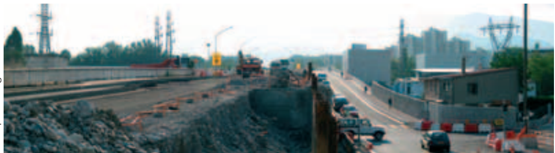
Photo 3 Démolition rampe Désaire Demolition of the Désaire ramp
