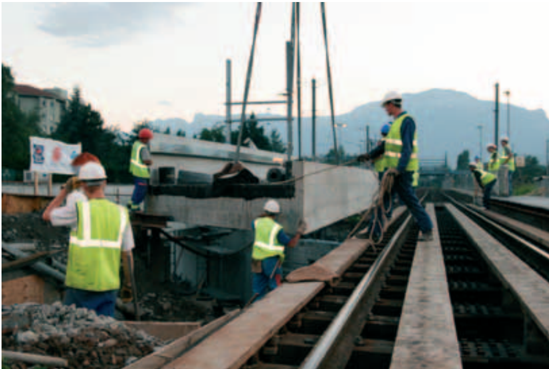
Photo 12 Travaux sur l'ouvrage SNCF de nuit
