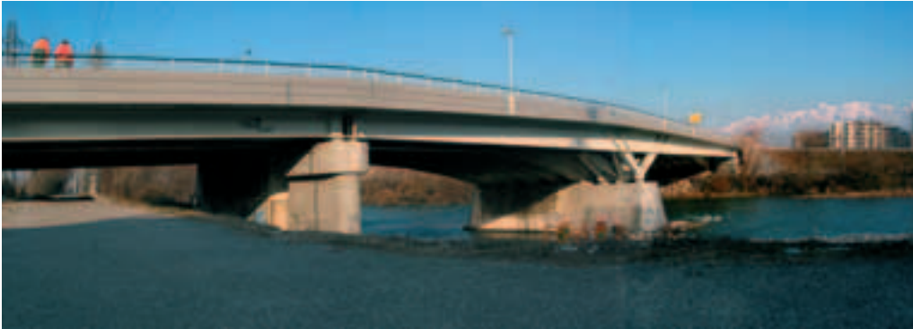
Photo 5 Ouvrage Catane depuis la digue du Drac Catane structure from the Drac embankment
