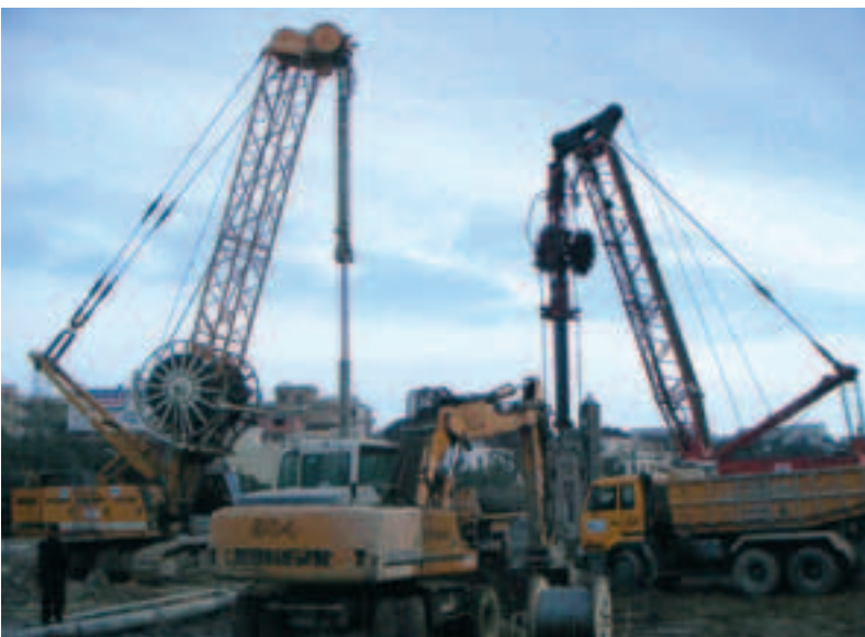
Photo 2 Le nœud du chantier The node of the project
