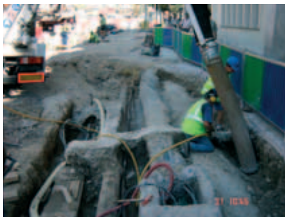
Photo 14 Nice. L'enchevêtrement des réseaux transversaux, leur vétusté et la présence de câbles électriques sous tension dans le sous-sol ont rendu impossibles des terrassements traditionnels et ont contraint à utiliser un camion-aspirateur Nice. The intertwining of cross networks, their obsolescence and the presence of energised electric cables in the subsoil made traditional earthworks impossible and a vacuuming truck had to be used
