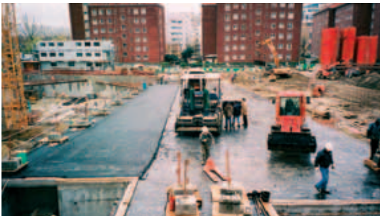
Photo 4 Pose de la chaussée sur la dalle supérieure. A gauche et à droite les chantiers des immeubles mitoyens Laying pavement on the upper slab. To the left and right, the sites of the adjoining buildings
