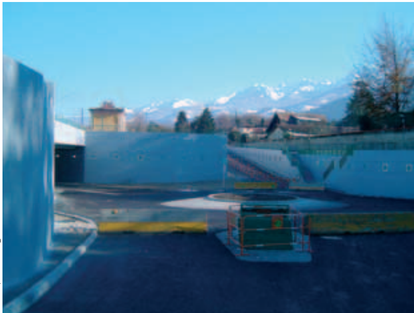
Photo 9 Giratoire de Gières et entrée du passage sous les voies
