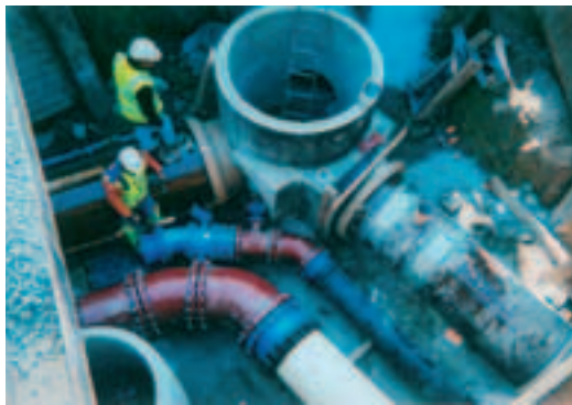
Photo 10 Montpellier. Dans une fouille profonde de 5,80 m, déviations de réseaux d'eau potable (diamètre 600) et d'eaux usées (diamètre 800) du quartier Pedro de Luna
