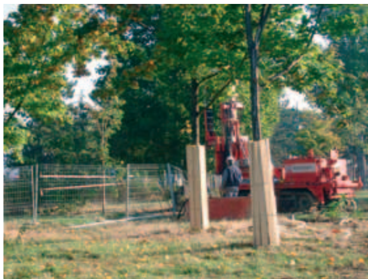
Photo 12 Forages pour comblement de carrières dans le bois de Vincennes Boring for filling quarries in Vincennes woods
