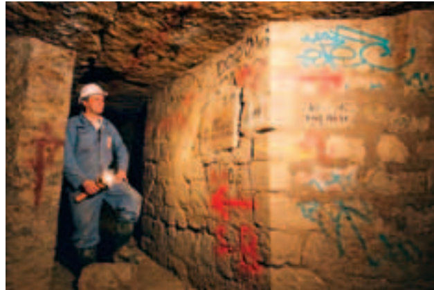
Photo 3 Carrières de Paris. Lire le nom des rues sur les plaques! Paris quarries. Read the street names on the plates!
