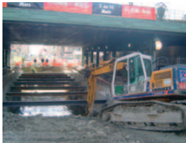
Photo 13 Nice. Aménagement du grand collecteur : passage sous le pont SNCF Thiers, préparé par des opérations de renforcement
