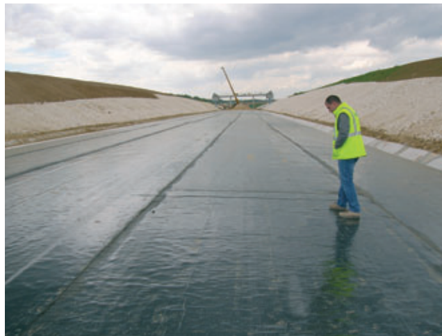
Photo 7 LGV Est. Toutes les arases réalisées dans les marnes gypseuses, soit 5 km sur les 24 du tracé, ont été étanchéifiées à l'aide de géomembranes bitumineuses LGV Est High-Speed Train Line. All the levelling performed in the gypseous marls, namely 5 km out of the 24 km of route, were sealed using bituminous geomembrane barriers
