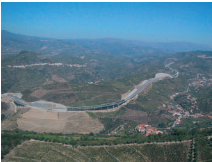
Photo 7 Exemples de confortement réalisés sur le tronçon C (Vila Real - Regua)
