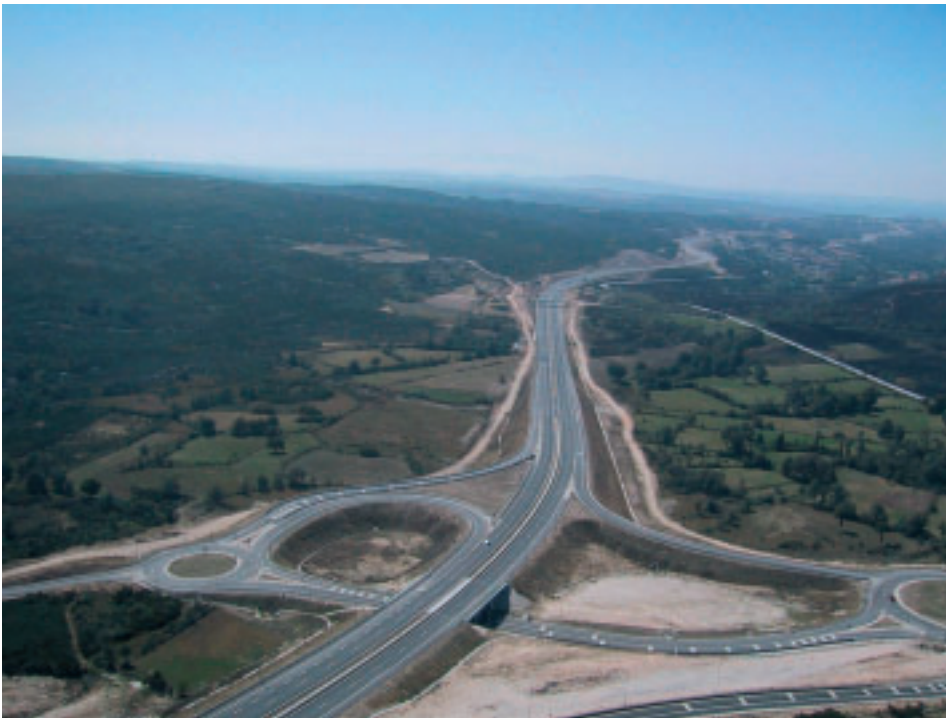
Photo 2 Tronçon B. Echangeur de Bigorne Section B. Bigorne interchange
