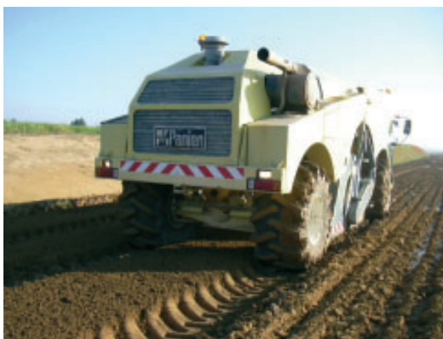
Photo 5 Malaxage après injection de l'eau Mixing after water injection
