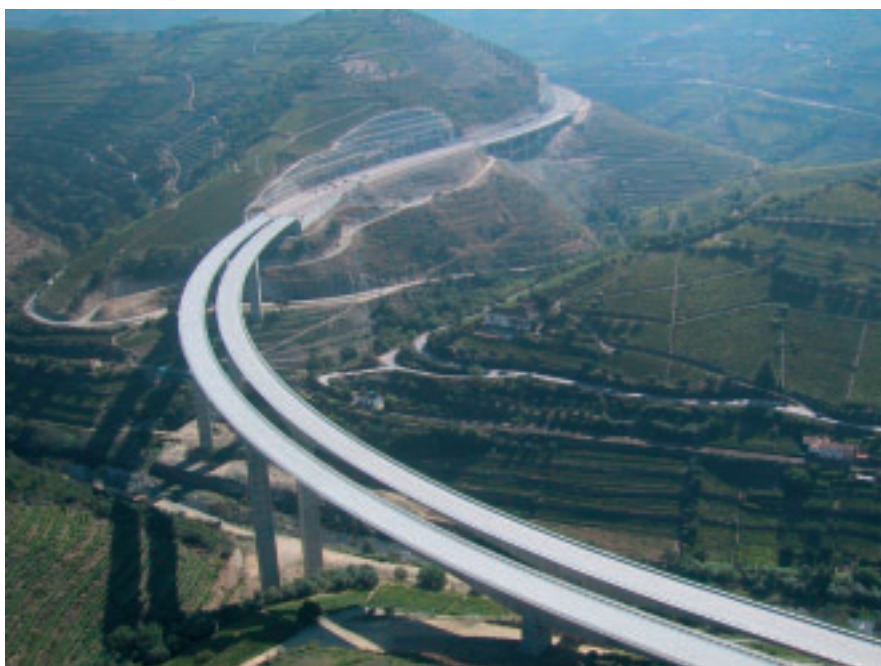
Photo 1 Tronçon C. Viaduc du Corgo Section C. Corgo viaduct
