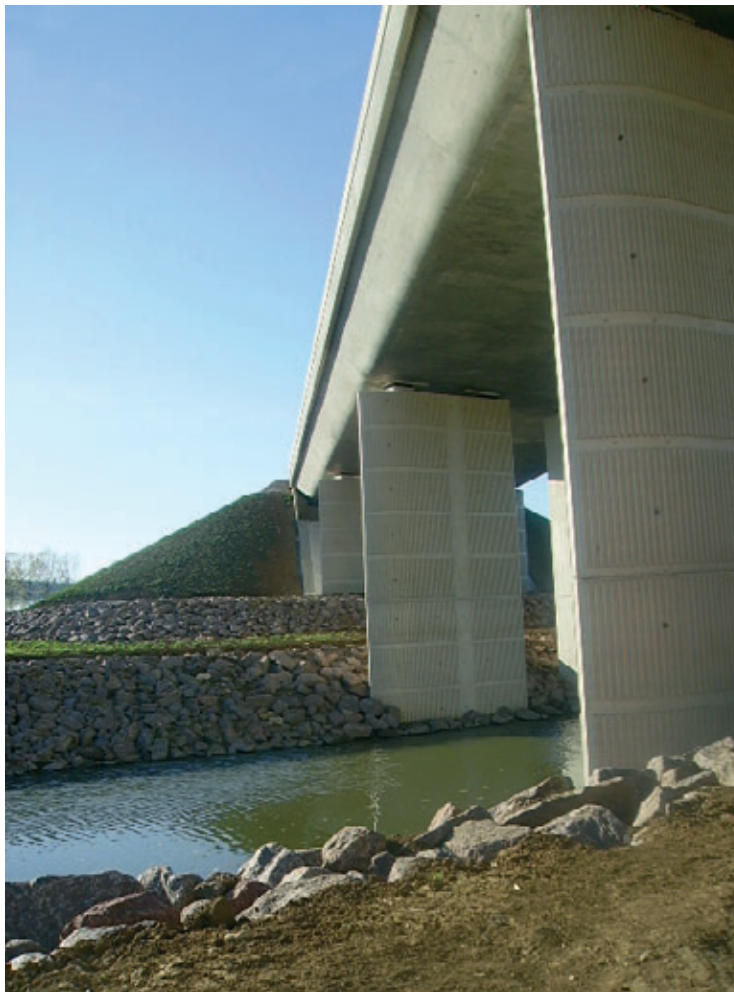
Photo 3 Ouvrage allongé sur la Seille Lengthened bridge over the Seille
