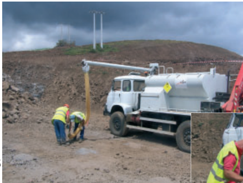
Photo 10 Chargement gravitaire de nitrate-fuel dans les trous de mine avec l'UFME
