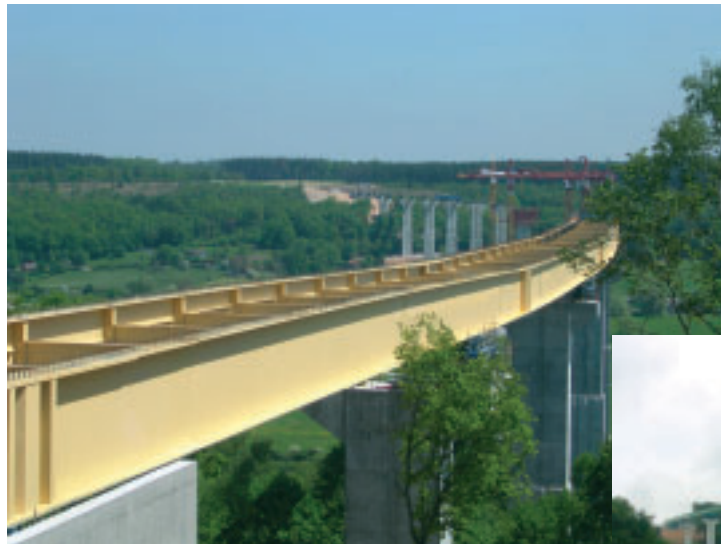
Photo 14 Viaduc de la Risle La Risle viaduct
