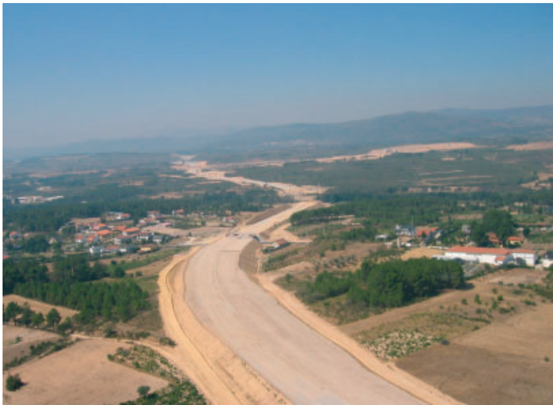
Photo 9 Plate-forme des terrassements après mise en œuvre de la couche de forme
