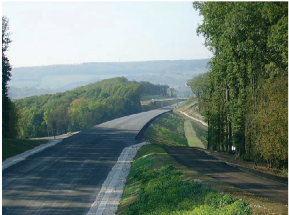
Photo 8 Remblai du vallon du bois du Cerisier Embankment of the dale in "bois du Cerisier" woods
