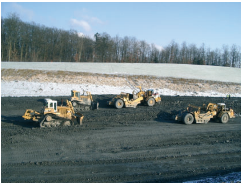
Photo 5 Echelon de motorscrapers
