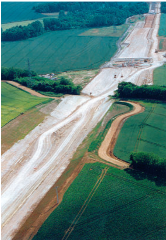
Photo 3 LGV Est. Pour l'essentiel, les 24 km du lot n° 12 traversent les vastes étendues agricoles de la Brie, à l'exception de la vallée de la Théroouanne, que la voie franchit au moyen d'un viaduc de 300 m LGV Est High-Speed Train Line. The 24 km of work section No. 12 mostly pass through the vast agricultural expanses of the Brie region, with the exception of the Théroouanne Valley, which the track crosses by means of a 300-metre viaduct
