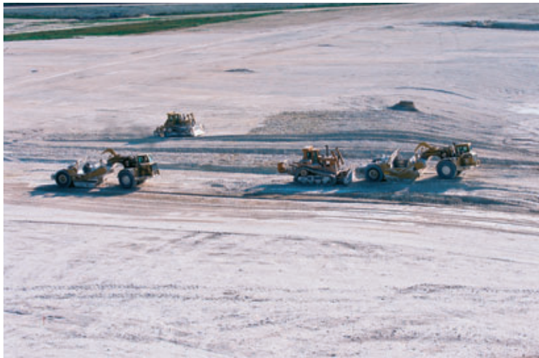
Photo 9 Vatry. Aux prises avec un matériau crayeux, les conducteurs de Deschiron ont aussi dû s'adapter à une géométrie d'emprise inhabituelle
