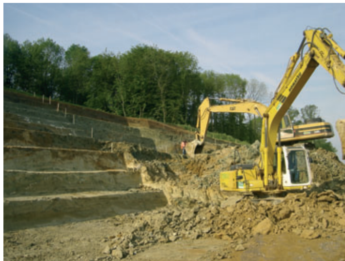
Photo 6 LGV Est. D'importantes purges ont précédé la réalisation des masques de protection des talus, dont le volume global atteint 120 000 m 3 LGV Est High-Speed Train Line. Extensive drainage preceded the laying of facing membranes to protect the earth banks, whose total volume amounts to 120,000 cu.m
