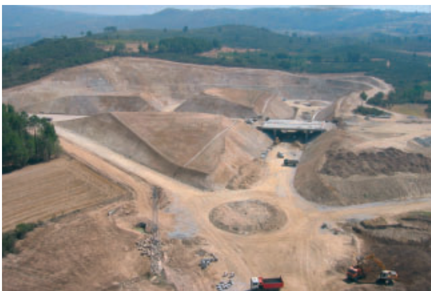
Photo 6 Echangeur de Vila Verde da Raia (lot E3)
