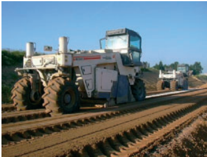
Photo 7 Traitement d'arase Levelling treatment
