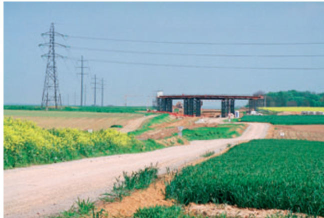
Photo 5 LGV Est. Pour pallier les risques liés à la coactivité des terrassiers et des équipes de génie civil, des passes charretières prototypes ont été aménagées sur tous les sites de construction d'ouvrages LGV Est High-Speed Train Line. To overcome the risks related to concurrent work by earthwork contractors and civil engineering teams, prototype truck passageways were developed on all the engineering structure construction sites
