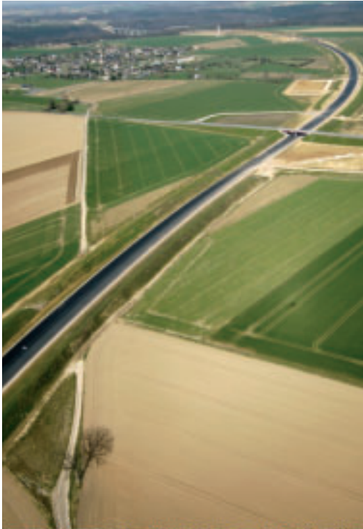
Photo 4 Vue générale du projet General view of the project
