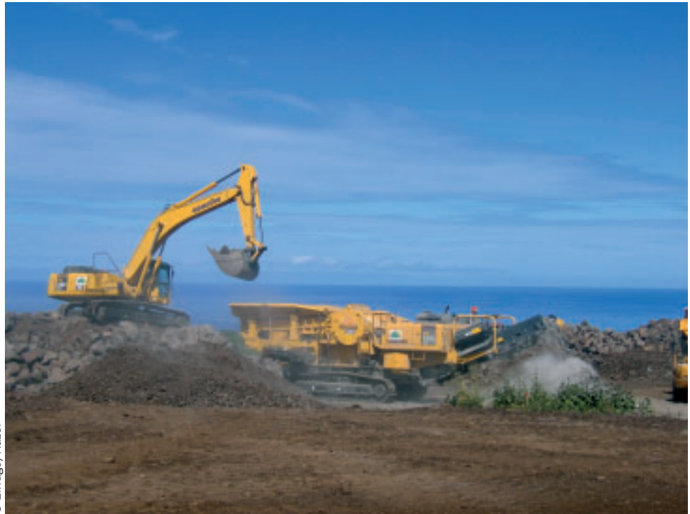
Photo 8 Concasseur mobile et pelle d'approvisionnement
