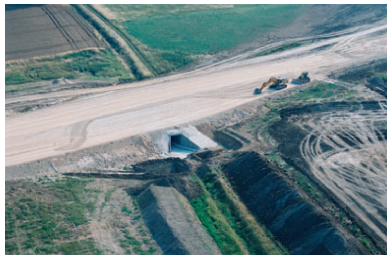
Photo 10 A85. Dans sa partie ouest, où la section traverse une vaste zone de plaine, la plate-forme autoroutière est aménagée sur un remblai "rasant" d'une épaisseur de 1 à 3 m longue de 14 km
