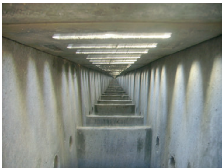
Photo 9 Les fossés préfabriqués à barbacanes Prefabricated ditches with weep holes
