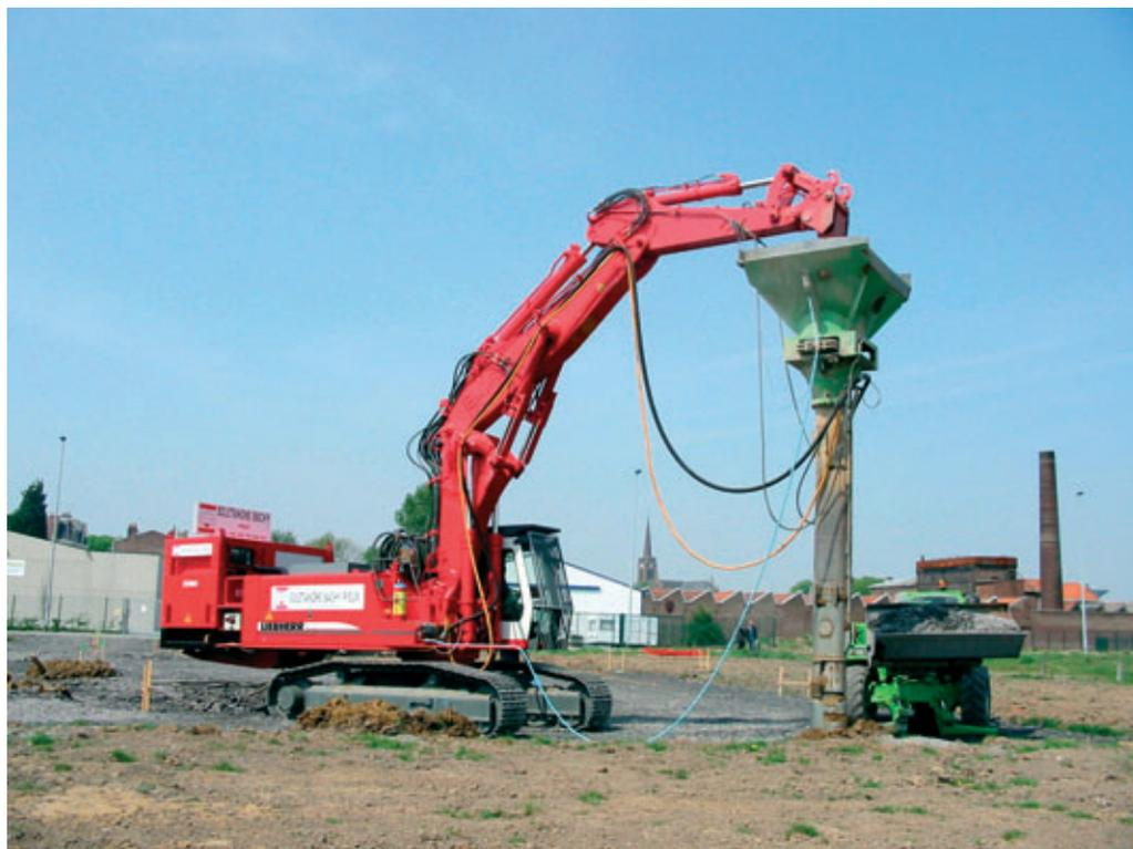
nature du terrain et des objectifs recherchés. On réalise ainsi une densification statique horizontale (photo 4 et figure 1).
