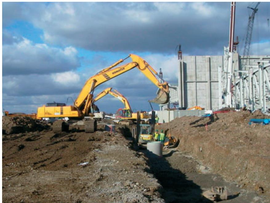
Remblai de tranchée de profondeur 5 m avec restitution de la plate-forme à la performance initiale (800 MPa)
