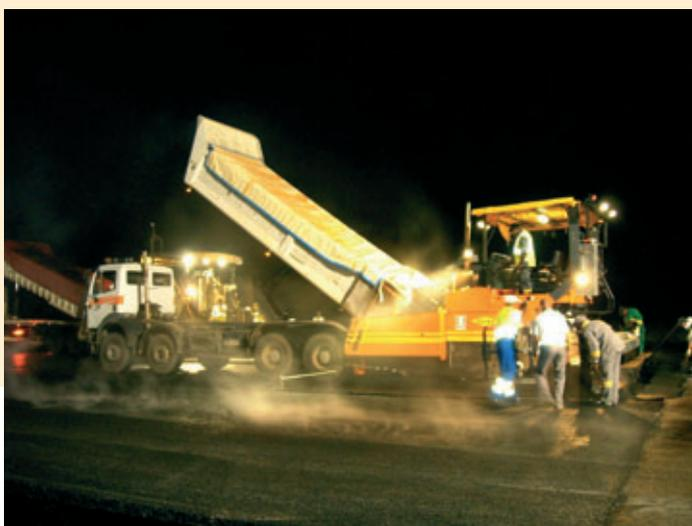
traîne la réalisation d'importants biseaux de raccordement de la couche d'enrobés suivant une pente maximum de 5/1000. Ces chanfreins sont systématiquement rabotés chaque soir sur toute la largeur de la piste.
