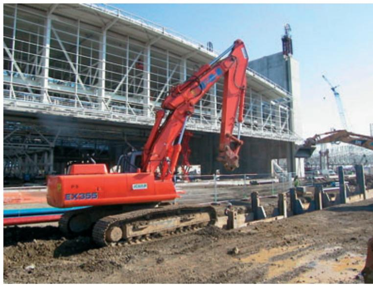
Pose réseau EU-EP-AEP et incendie à une profondeur de 5 m dans un blindage double glissière devant le bâtiment d'assemblage de l'A380
