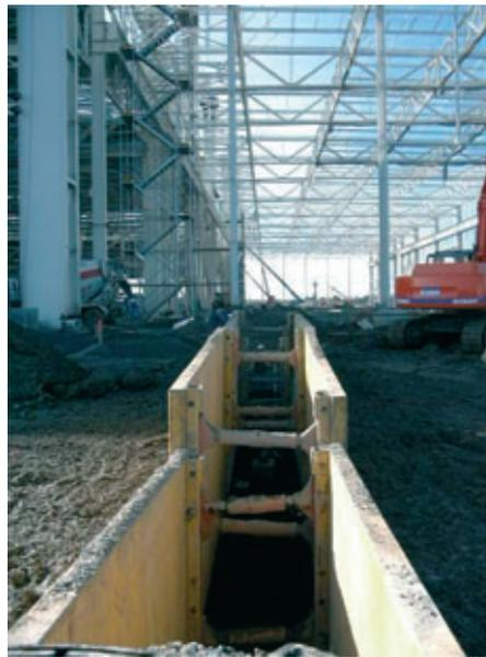
Raccordement du réseau pluvial au pied du "bâtiment Arche"
