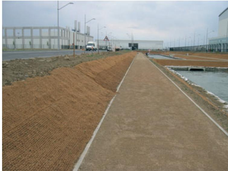
**Le bassin de rétention : mise en œuvre des nattes de coco pour le paillage des végétaux et la tenue des talus**
