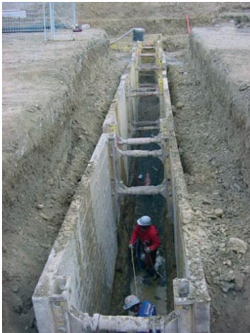
**Pose réseau E.U. dans tranchée blindée avec rabattement de nappe à l'aide de panneaux métalliques type caisson**
