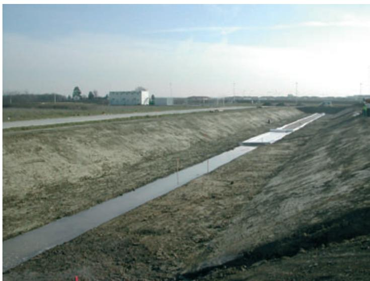
**Terrassement d'un waterway avec sa membrane d'étanchéité antipollution**
