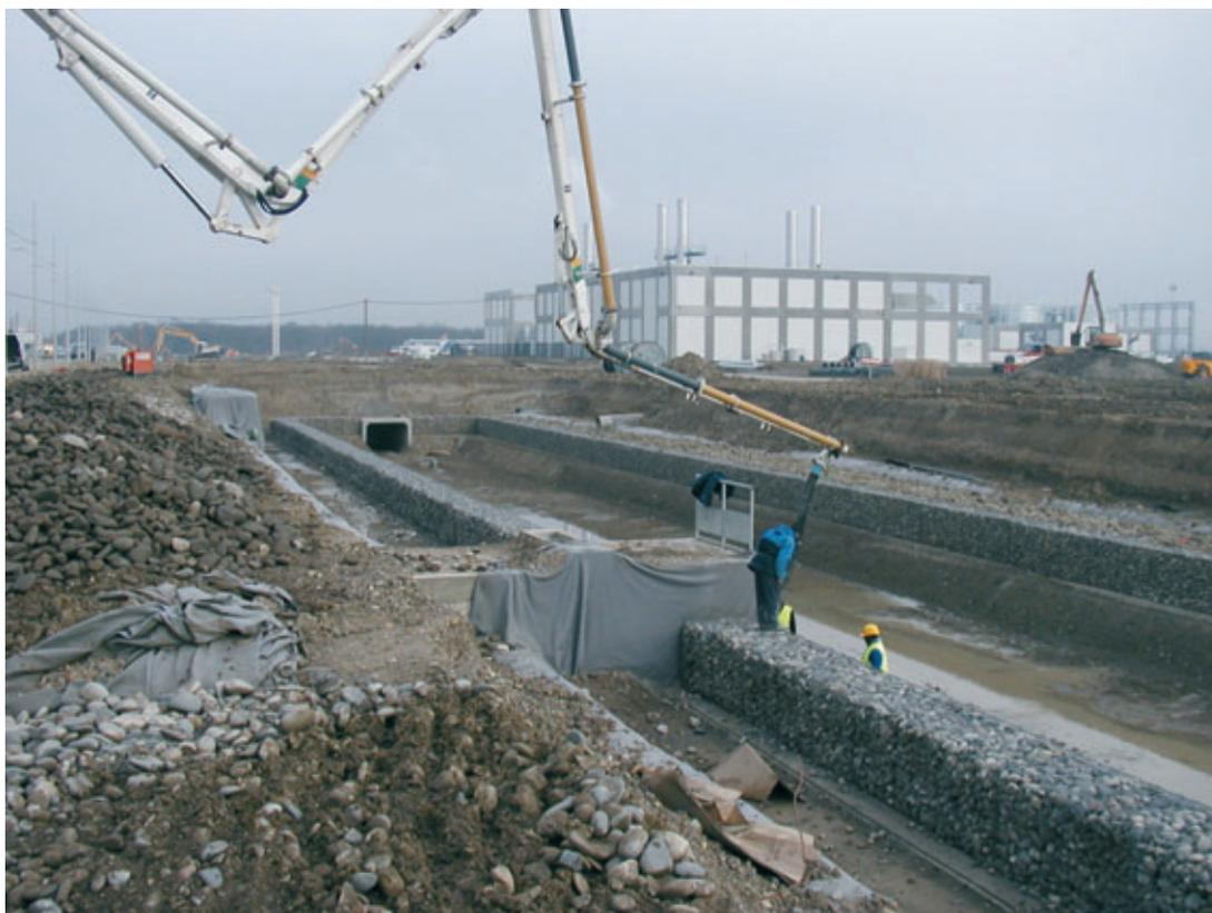
Le réseau long de 7 km est en fonte ductile de diamètre variable jusqu'à  $\varnothing$  1 200 mm. Le choix de la fonte par rapport au béton a permis d'augmenter les cadences de pose en assurant une parfaite étanchéité.
