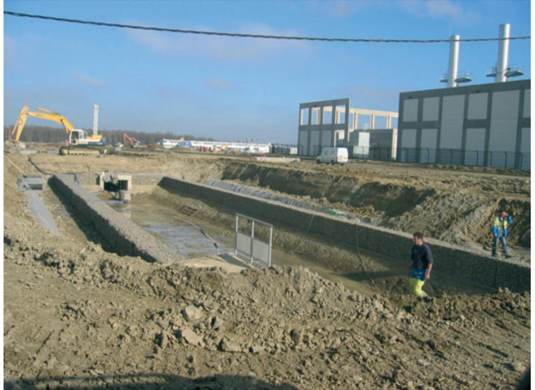
**Mise en place du bassin de rétention des eaux pluviales du site d'Aéroconstellation**
