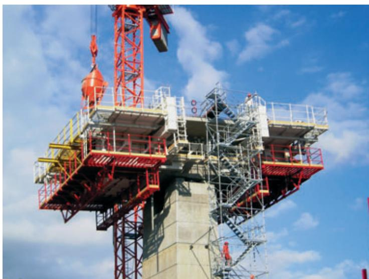
se de construction sur la tête de pile. Les appareils à pot servant à l'appui du tablier en phase d'exploitation sont posés en même temps que les appuis provisoires (photos 4, 5 et 6).
