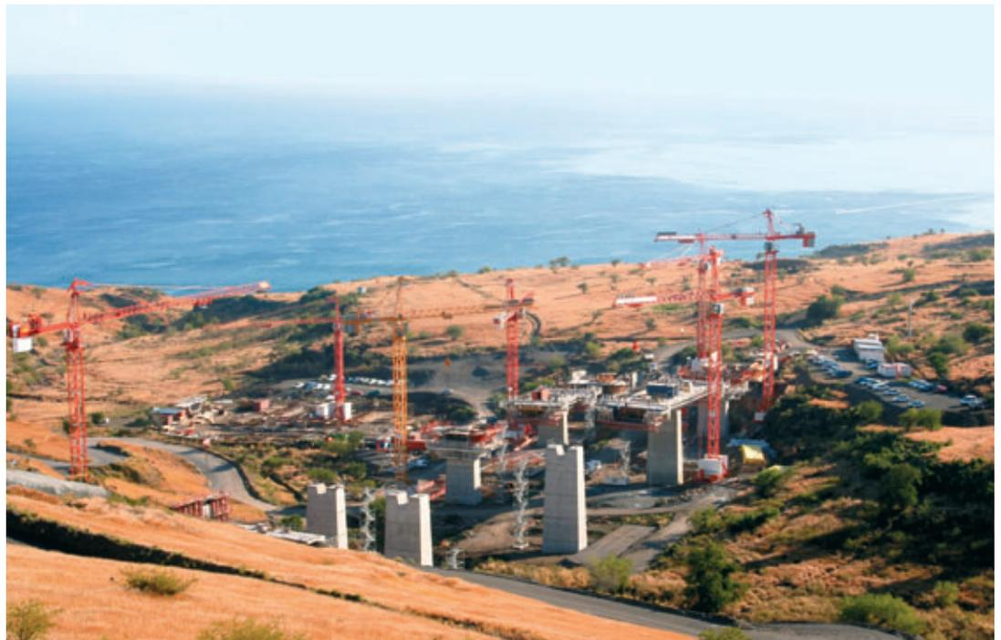
Ils sont évidés longitudinalement dans l'axe de la pile sur une profondeur de 1,50 m avec une largeur en tête de 2,30 m et de 1,60 m dans la partie inférieure.
