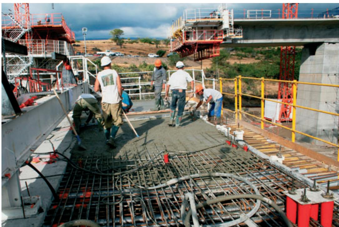
et deux paires d'équipages mobiles (photo 7). Les voussoirs sont bétonnés à la benne (photos 8, 9, 10 et 11).
