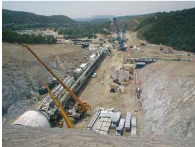
Photo 1 Tunnelier en position de démarrage Tunnel boring machine in starting position
