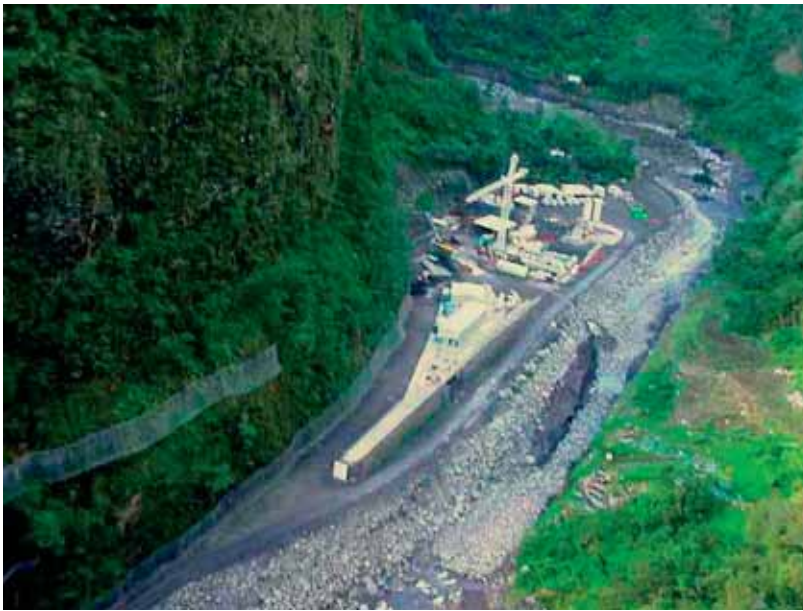
Photo 6 Galerie Salazie amont : plate-forme rivière des Pluies
