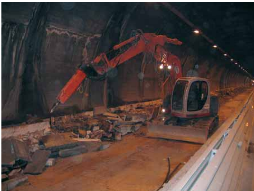
Tube nord : démolition des caniveaux côté voie rapide
