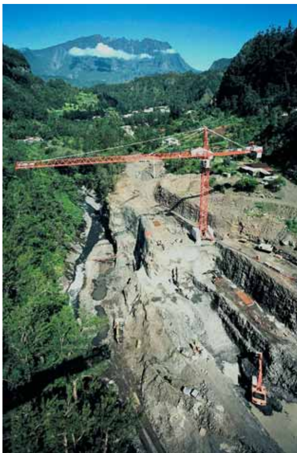
Prise d'eau de la rivière du Mât. Ensemble des terrassements
