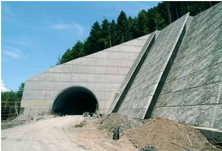
Photo 3 Réalisation de la tête sud. Murs
