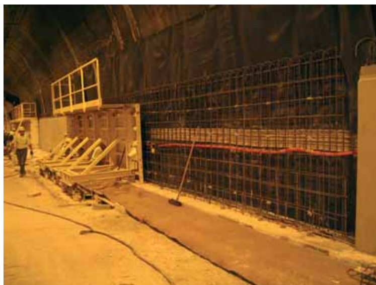
Quelques photos récentes du chantier A few recent photos of the project
