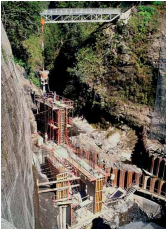
Prise d'eau de la rivière des Fleurs Jaunes. Réalisation de la passe à bichiques Water intake in the Fleurs Jaunes river. Construction of the "bichique" fish ladder
