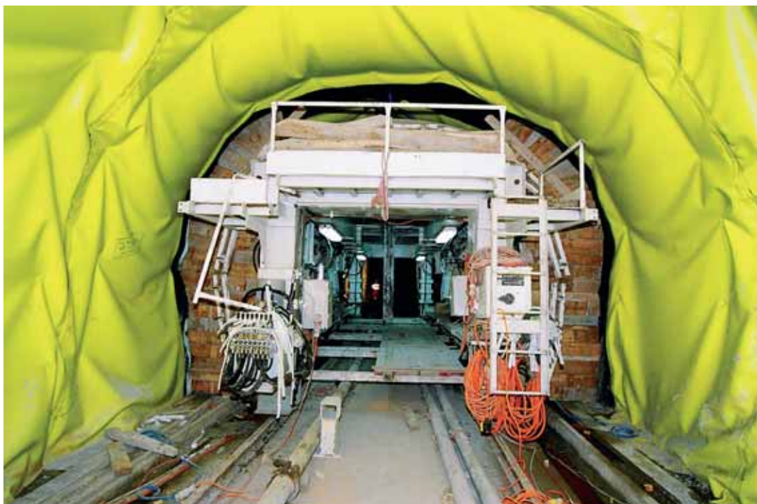
Photo 13 Coffrage et bétonnage de la voûte du tunnel de Kwai Chung
