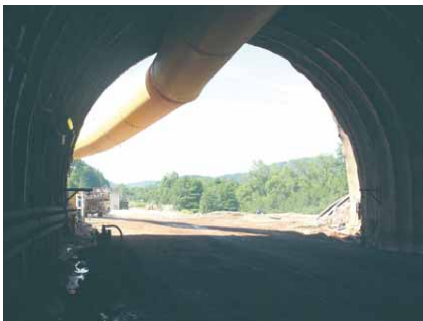
Vue depuis l'intérieur du tunnel en phase excavation View from inside the tunnel during the excavation phase
