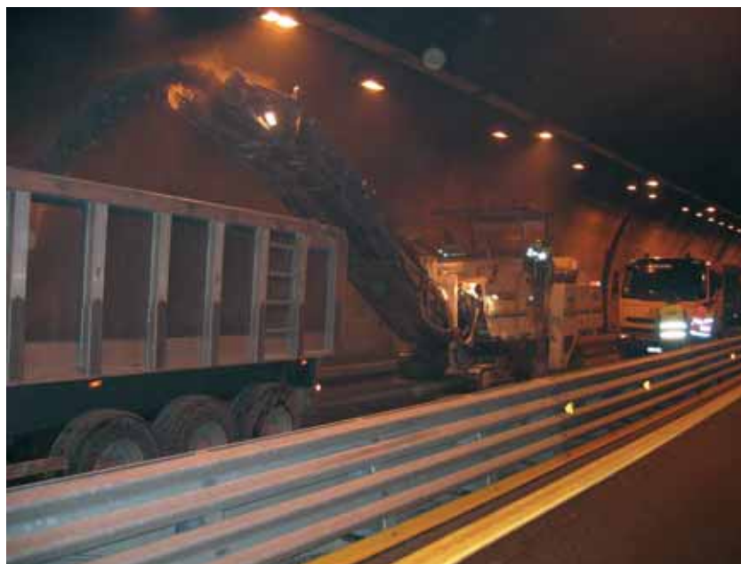
Tube nord : abaissement de la chaussée vole rapide en avril 2005 North tube : lowering of the fast lane pavement in April 2005
