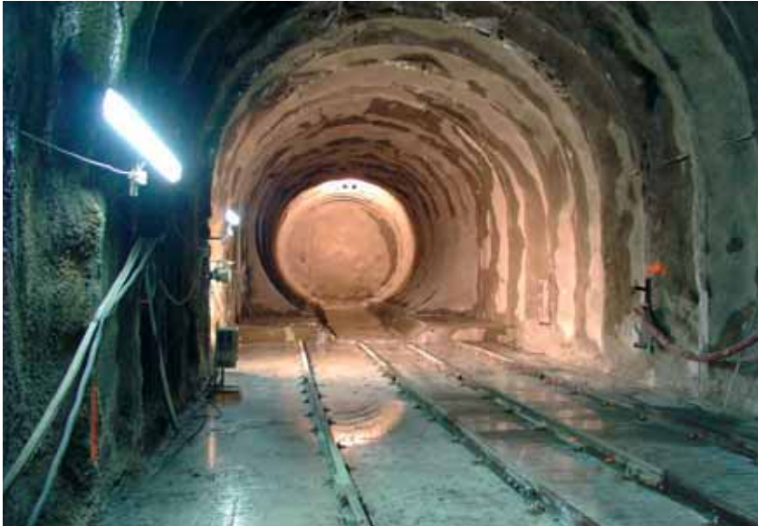
Berceau démarrage tunnelier TBM starting cradle
