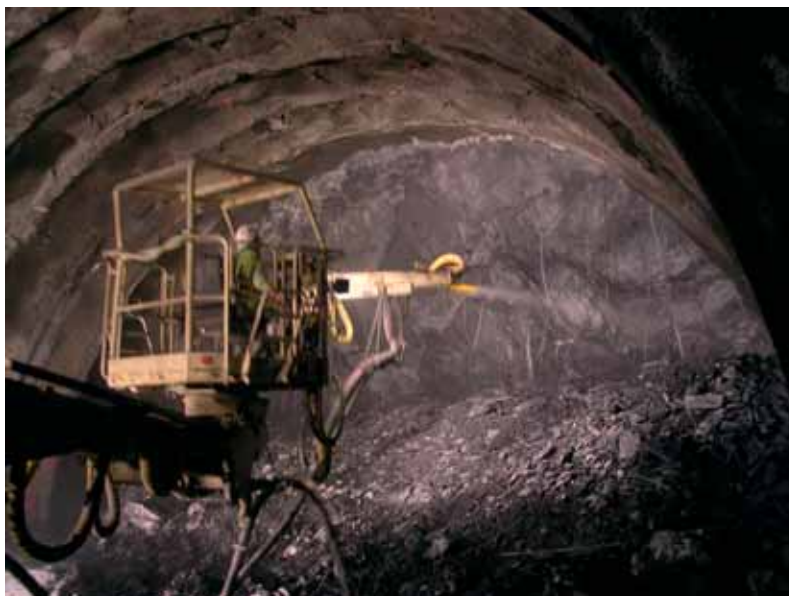
Photo 7 Réalisation du béton projeté à front
