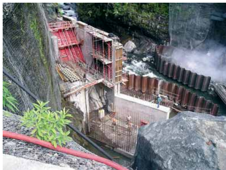
Réalisation de la prise d'eau de la rivière des Fleurs Jaunes
