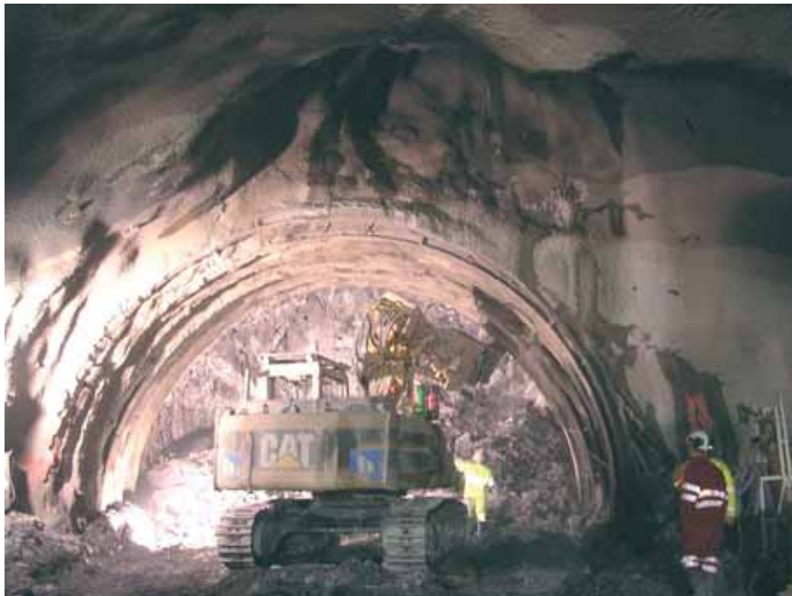
Photo 7 Réalisation du béton projeté à front
