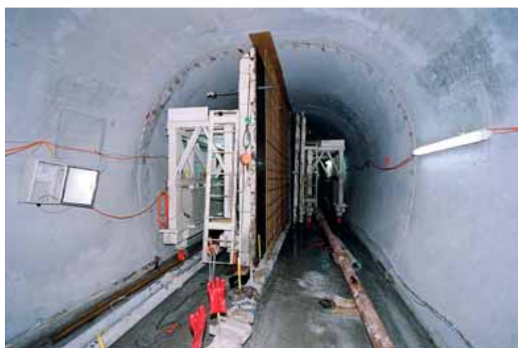
Photo 14 Coffrage du voile central du tunnel de Kwai Chung
