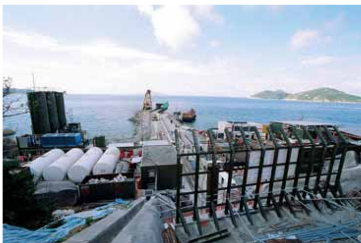
Photo 1 Plate-forme de démarrage du tunnelier de Chi Ma Wan Starting platform for the Chi Ma Wan tunnel boring machine
