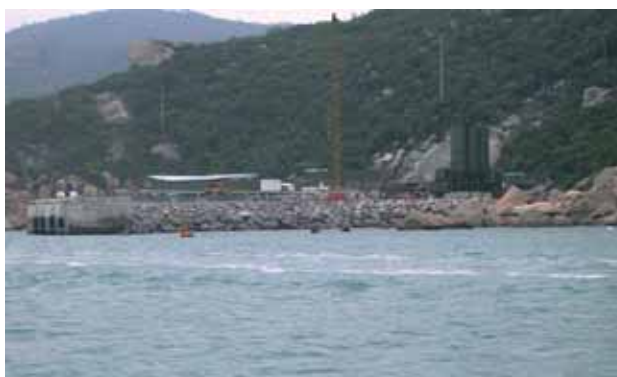
Photo 2 Plate-forme sud du tunnel de Chi Ma Wan vue depuis la mer Southern platform of the Chi Ma Wan tunnel seen from the sea
