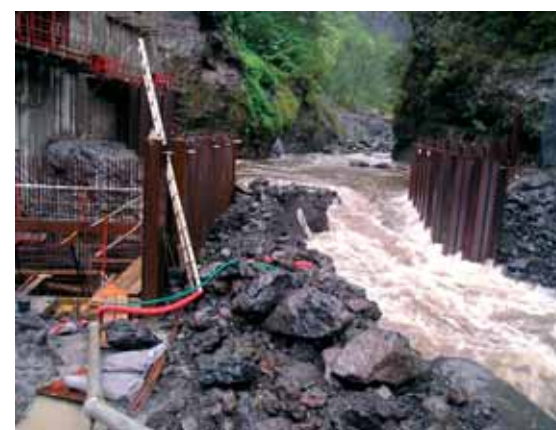
Réalisation du plot de la prise d'eau de la rivière des Fleurs Jaunes Construction of the water intake block in the Fleurs Jaunes river
