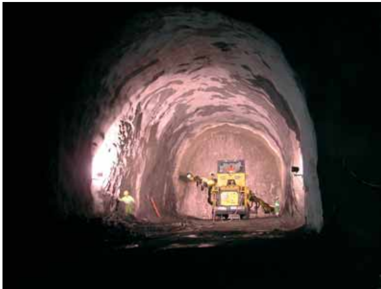
Photo 3 Foration de la volée avec le jumbo automatisé
