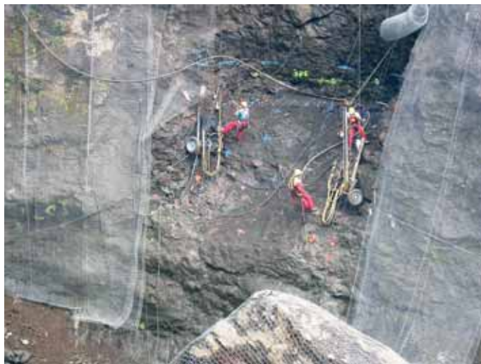
Terrassements acrobatiques Acrobatic earthworks
