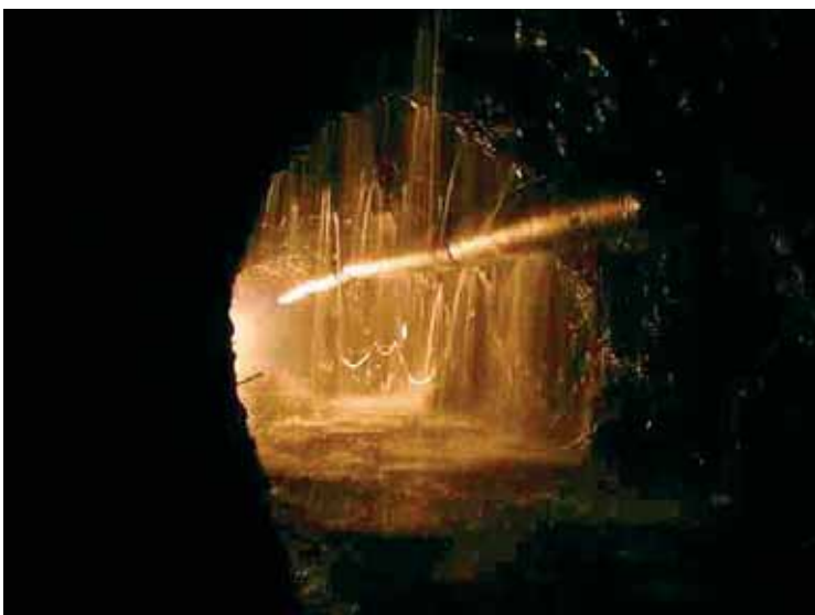
Photo 9 Galerie Salazie amont : fenêtre d'attaque des Pluies
