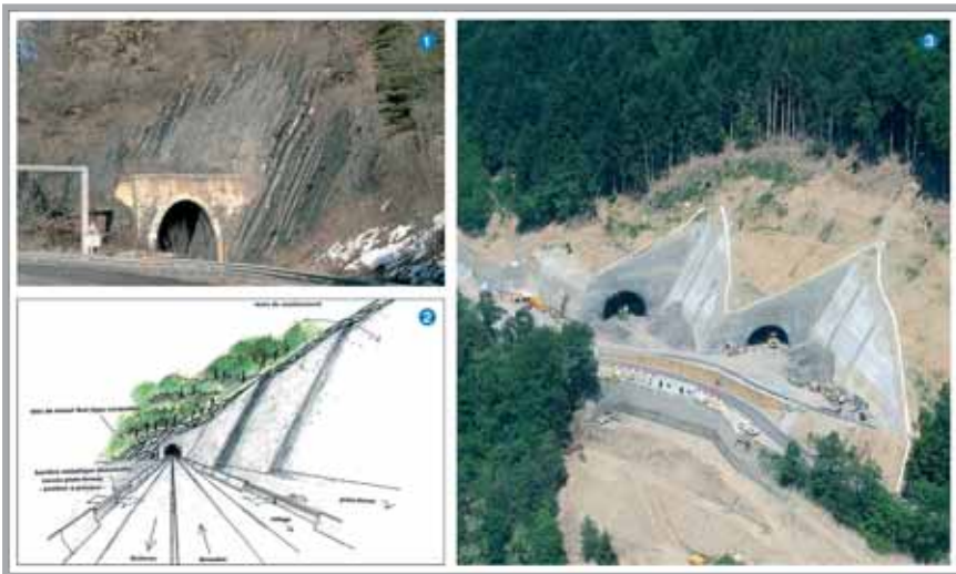
Figure 17 Triptyque architectural de la tête sud. (1) Tunnel de la Motte. (2) Etude archi. (3) Le résultat !
