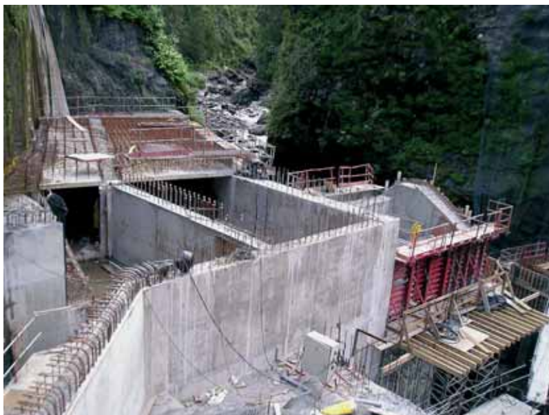
Pose des armatures du plot 1
