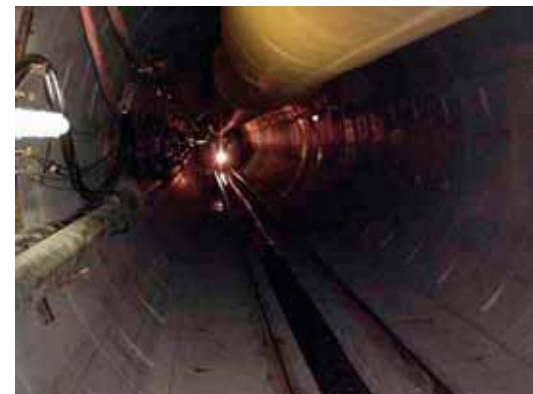
Photo 5 Galerie Salazie aval : galerie revêtue Downstream Salazie gallery : lined gallery
