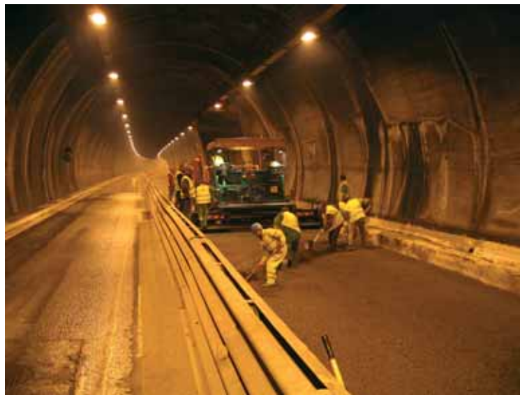
Tube nord : mise en œuvre des drains dans l'épaisseur du béton drainant
