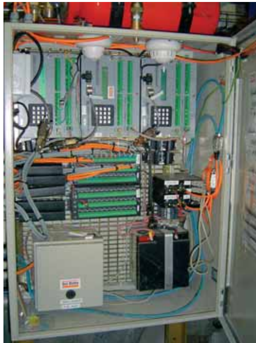
Photo 2 Photo d'un coffret d'acquisition de la galerie expérimentale de Bure à - 445 m
