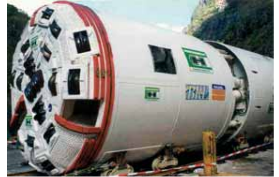
Photo 7 Galerie Salazie amont : tunnelier
