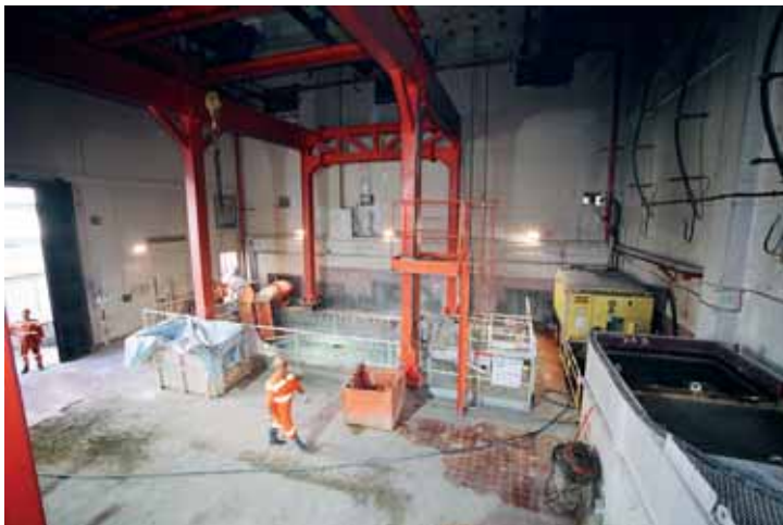
Photo 10 Installation de chantier à la sous-station de Kwai Chung Construction plant at Kwai Chung sub-station
