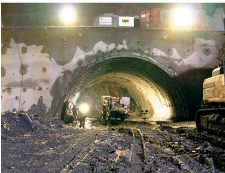
Photo 1 Coupe réelle transversale tube ouest Actual cross section of the western tube
