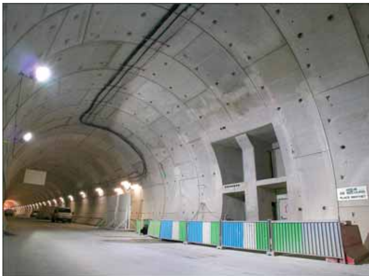
Photo 8 Les ouvertures des niches ont été réalisées après coup. Des travaux supplémentaires ont dû être réalisés pour trois d'entre elles, situées sous la nappe phréatique
