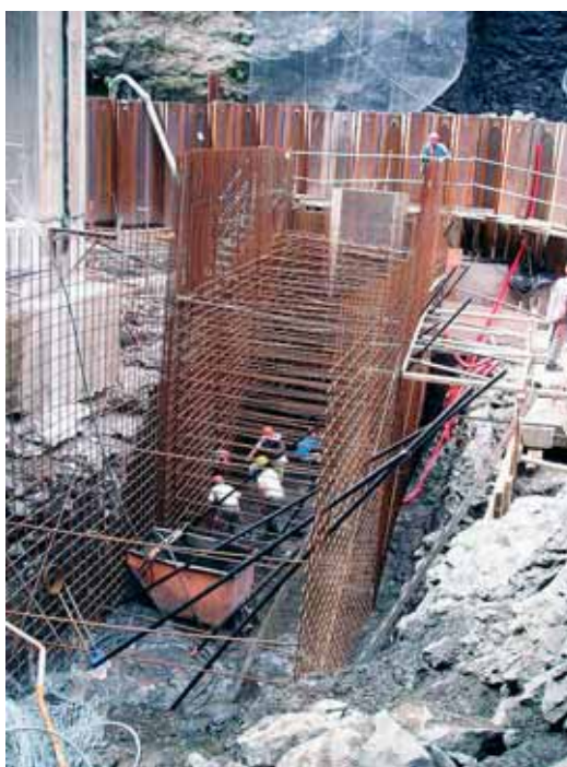
Pose des armatures du plot 1
