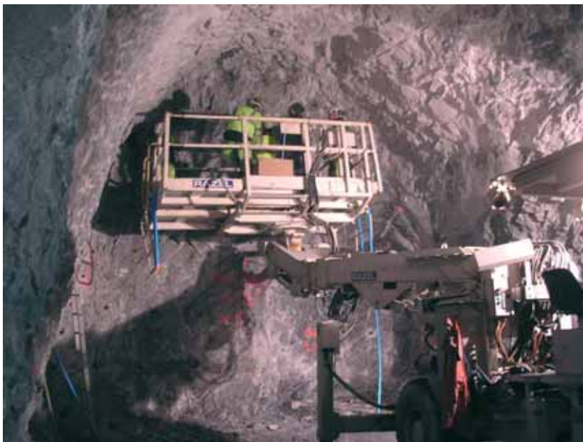
Photo 4 Chargement de la volée dans une niche
