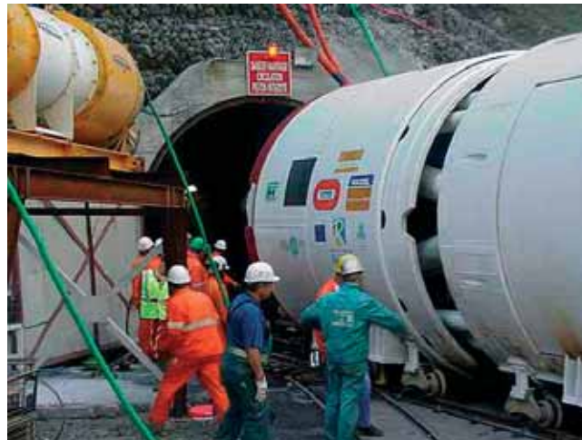
Photo 8 Galerie Salazie amont : entrée du tunnelier
