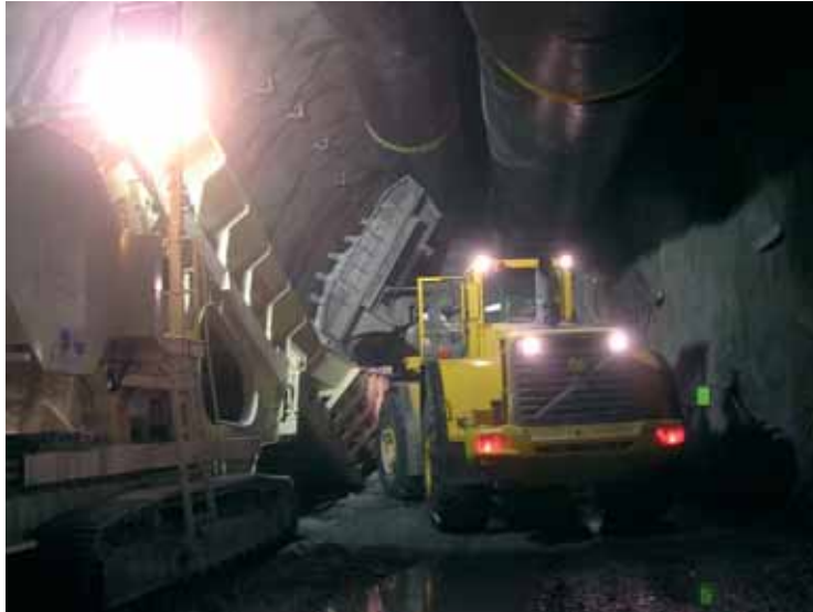
Photo 5 Marinage : déchargement du marin dans le concasseur
