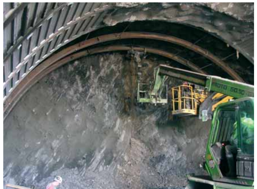
Photo 6 Pose de cintres Placing arches
