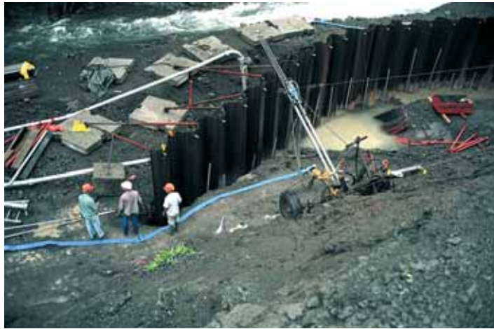
Rideau de palplanches Sheet piling curtain
