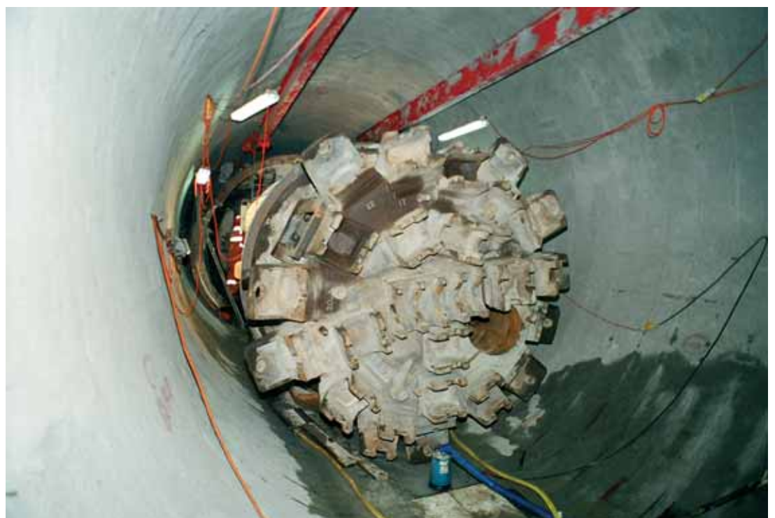
Photo 6 Démontage du tunnelier dans l'amorce nord du tunnel de Chi Ma Wan Dismantling the TBM at the start of the northern face of the Chi Ma Wan tunnel
