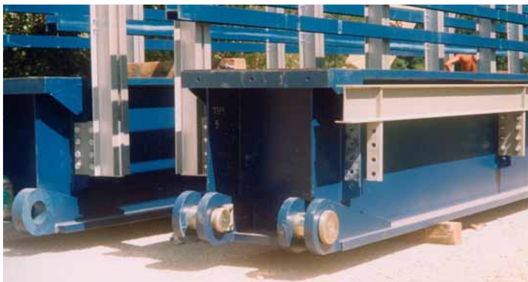
Pont Unibridge : vue des détails d'assemblage
