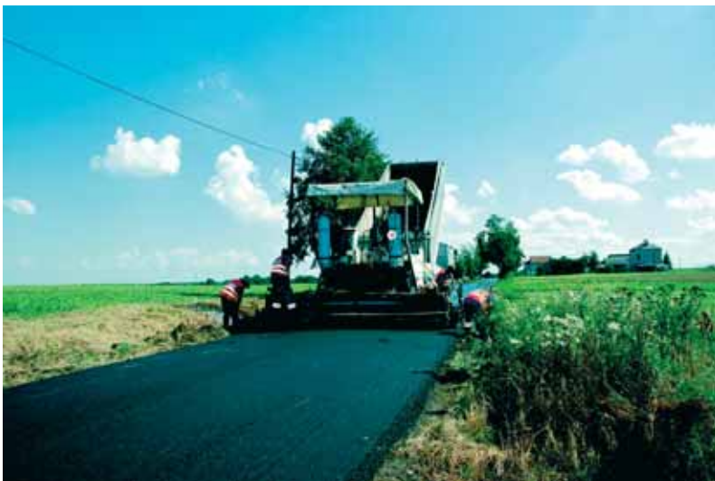
Application de l'enrobé tiède à l'Aspha-Min
