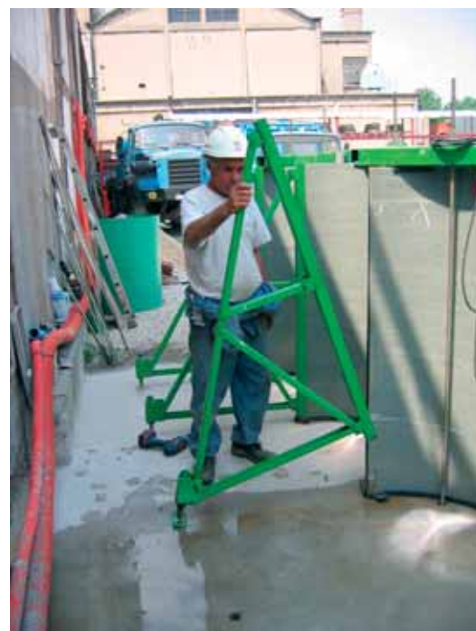
Photo 5 Pose des jambes de force Installing braces
