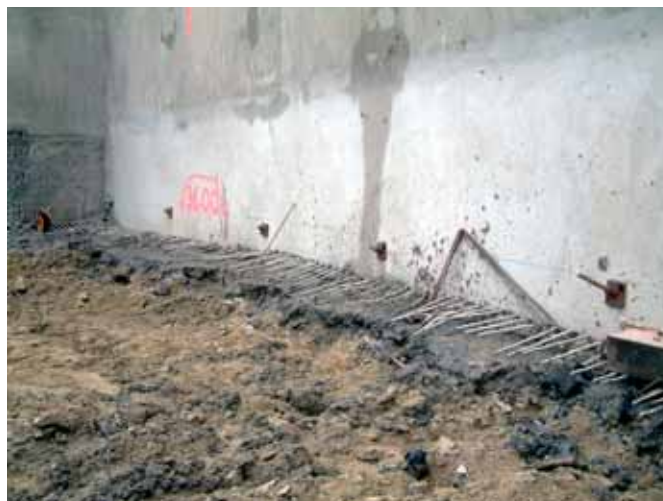
Photo 2 Tirants de paroi moulée testés avec cette méthode
