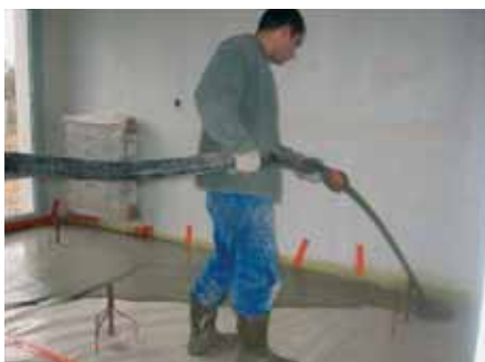
Photo 2 Coulage de fondation (béton autoplaçant fibré) en 2002
