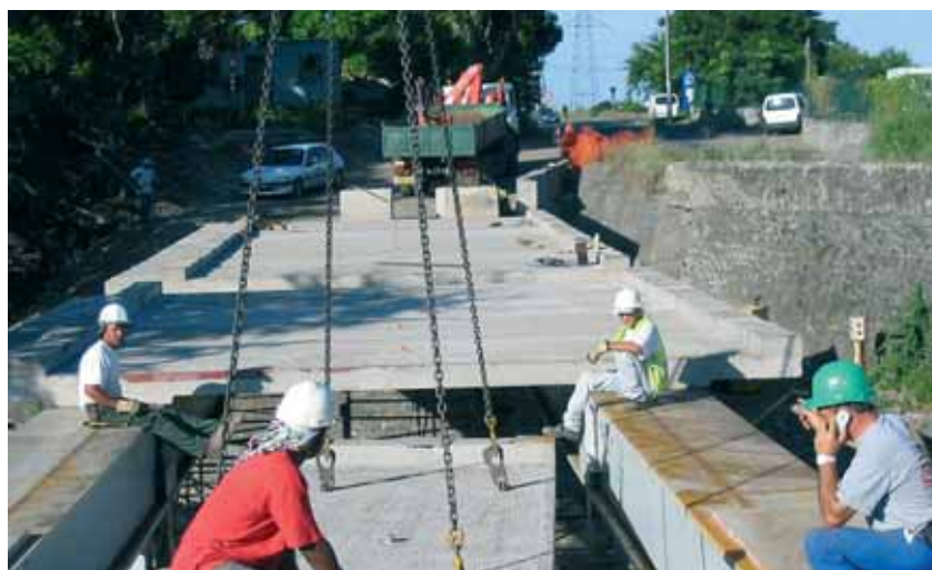
Pose des dalles préfabriquées
