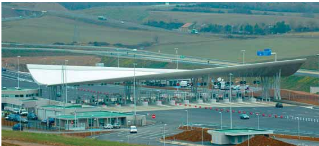
Photo 1 Couverture du péage de Millau - Eiffage TP
