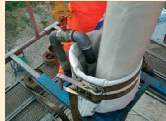
Photos 6 et 7 Procédés de chemisage Everpipe® et Foreverpipe® (Barriquand). Stockée dans un camion réfrigéré, la gaine de chemisage est mise en œuvre depuis une plate-forme surélevée, nécessaire pour former la colonne d'eau qui assure la réversion de la gaine à l'intérieur de la conduite (voir détail). Une fois mise en place, la gaine est polymérisée
