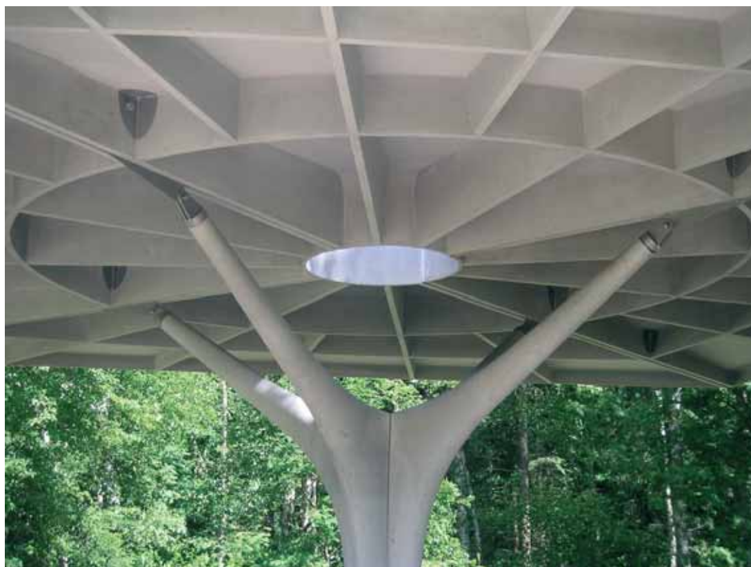
Photo 5 Auvent en BSI nervuré – Folly de Sonnestraal (Pays-Bas) - Hürks Béton. Détail des bracons
