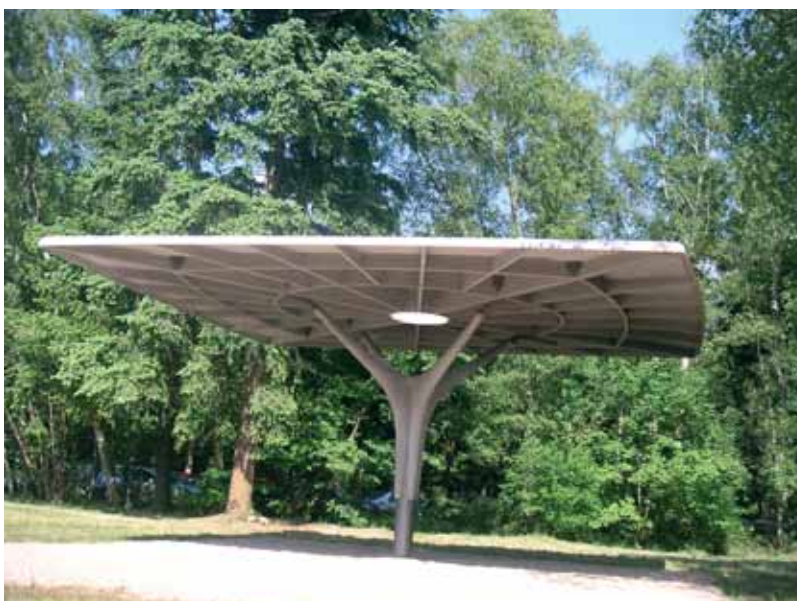
Photo 4 Auvent en BSI nervuré – Folly de Sonnestraal (Pays-Bas) – Hürks Béton. Vue d'ensemble
