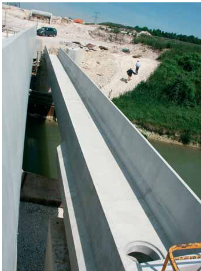
Photo 3 Pont-canal en BSI. LGV Est – Eiffage TP
