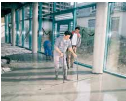
Photo 1 Coulage de la dalle de 950 m 2 de la médiathèque de La Roche-sur-Yon (85) en 2001
