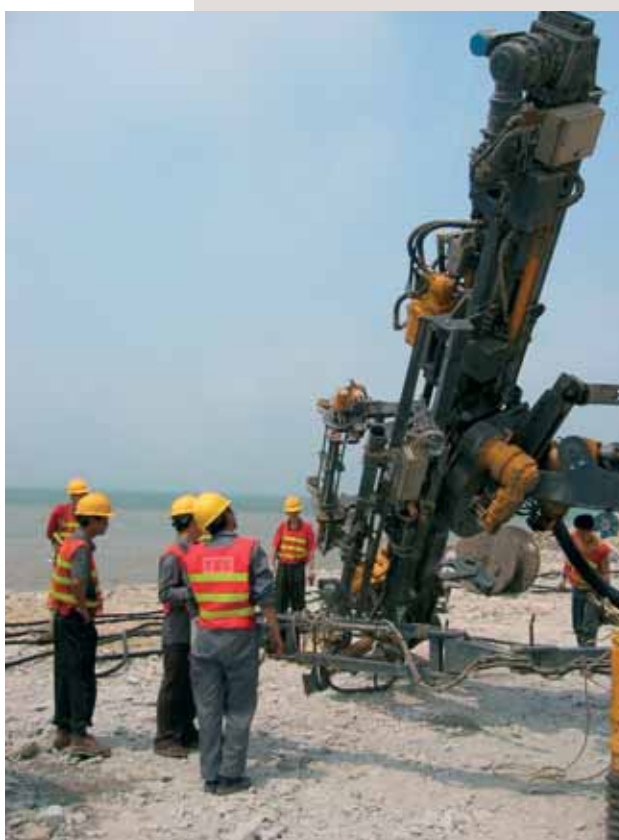
Photo 3 Une foreuse MEDIAN aux mains de son propriétaire A MEDIAN driller in the hands of its owner
