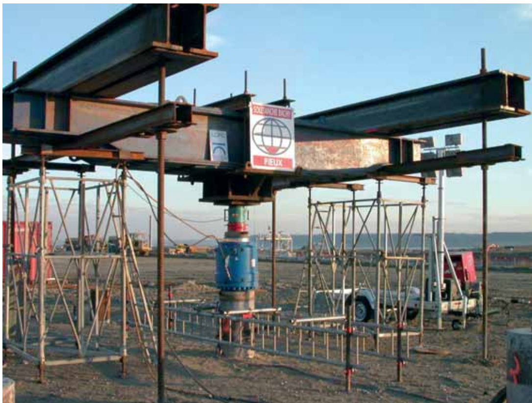
Photo 3 Essai de chargement sur le plot d'essai du Havre Loading test on the Le Havre test pad
