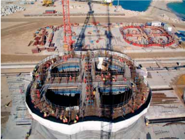
Photo 6 Vue d'un caisson quadrilobé View of a four-lobe caisson
