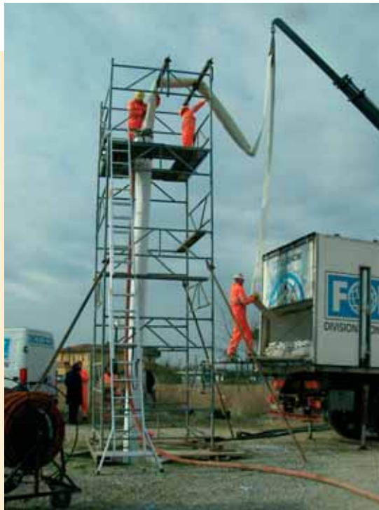
Photos 6 et 7 Procédés de chemisage Everpipe® et Foreverpipe® (Barriquand). Stockée dans un camion réfrigéré, la gaine de chemisage est mise en œuvre depuis une plate-forme surélevée, nécessaire pour former la colonne d'eau qui assure la réversion de la gaine à l'intérieur de la conduite (voir détail). Une fois mise en place, la gaine est polymérisée
