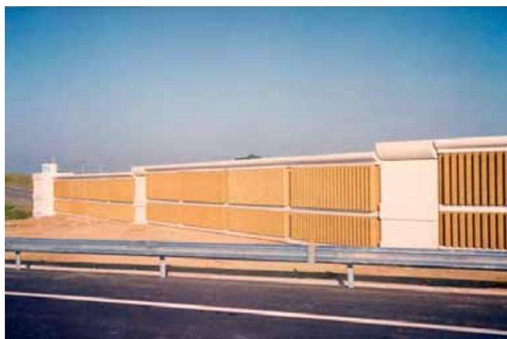
Photos 1 et 2 Exemples de murs antibruit en béton de bois Sysa
