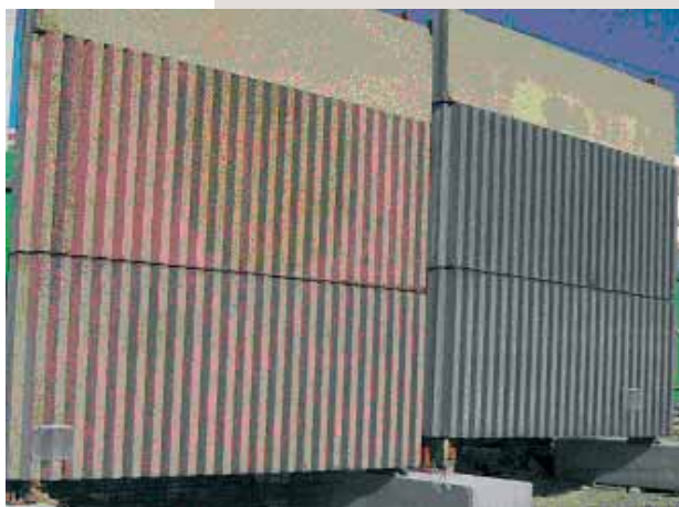
Photo 9 Configuration choisie de mur antibruit dépollueur pour la première phase de recouvrement du périphérique de Paris
