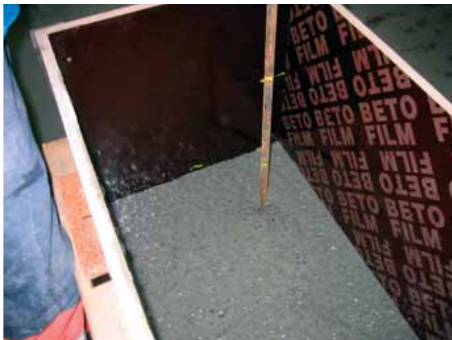
Photo 4 Essai de piquage Rodding test
