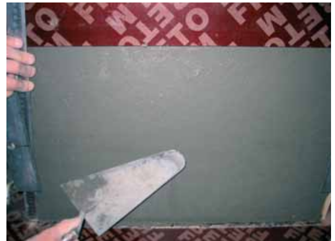
Photo 5 Levée du coffrage glissant et retalochage de surface Raising of sliding formwork and surface refloating
