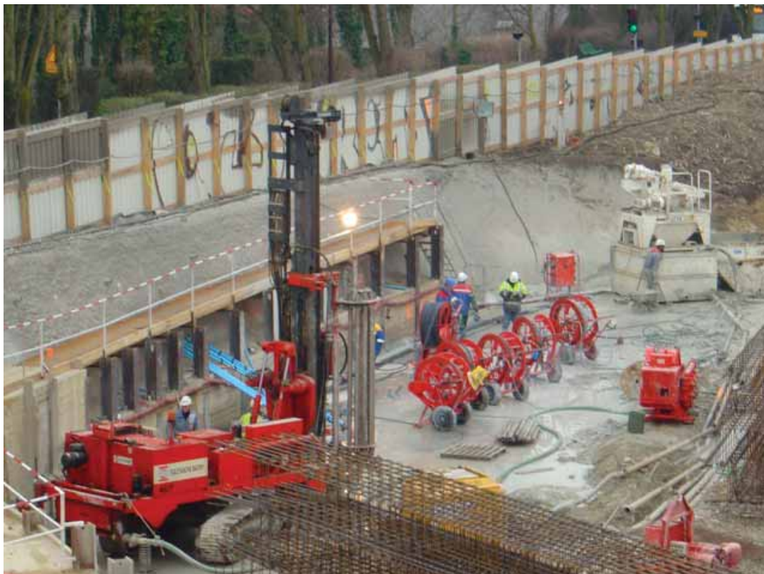
Photo 3 Atelier de forage et d'injection pour la réalisation des bouchons
