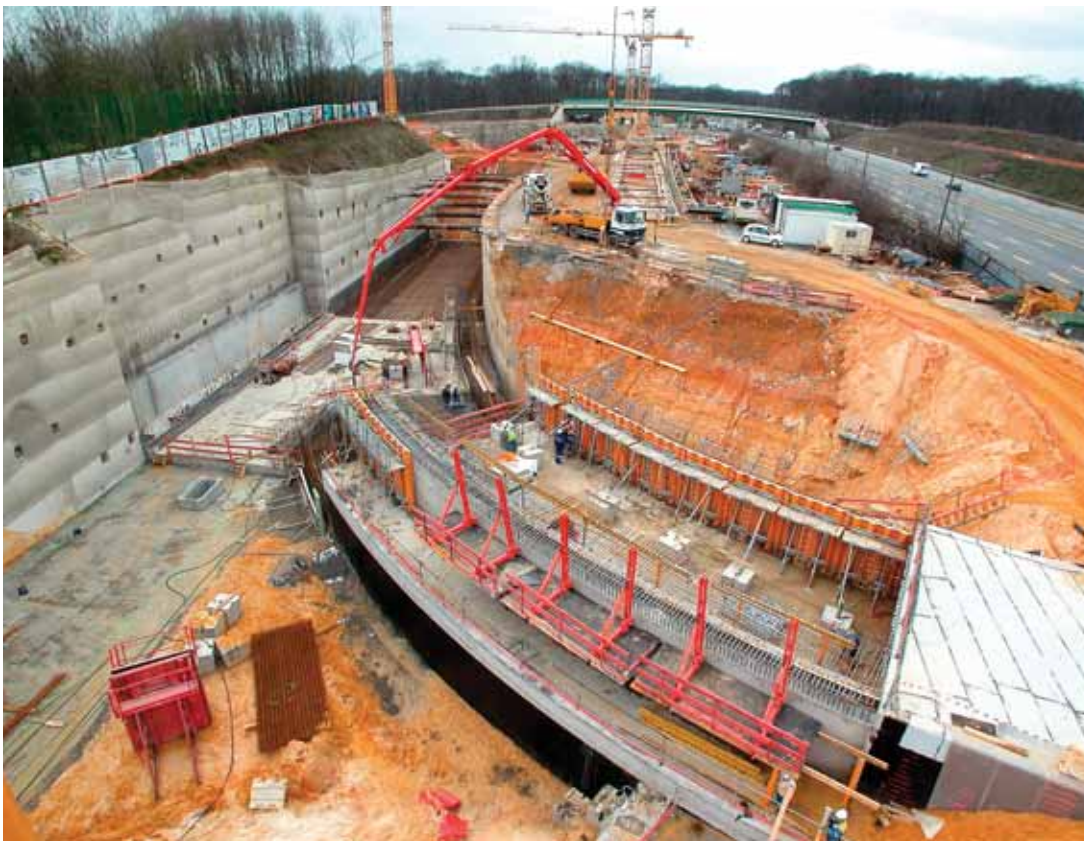
Photo 8 Travaux en cours le long de la RD 182 Work in progress along county road RD 182
