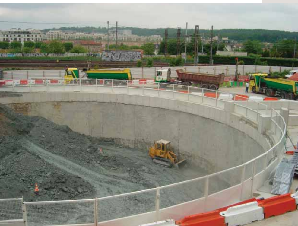
Photo 4 Vue de l'intérieur du puits en cours de terrassement Interior view of the shaft in course of earthworks
