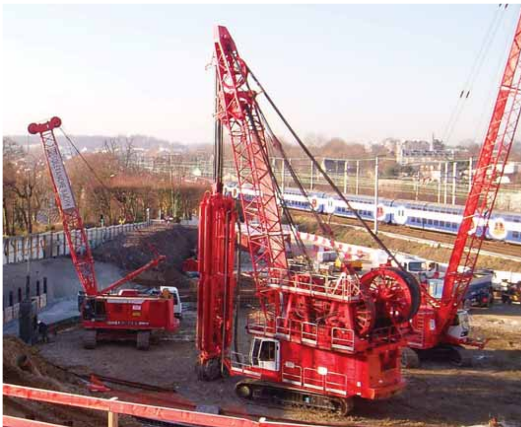
Photo 2 Hydrofraise évolution 2 pour la réalisation de la paroi moulée Évolution 2 hydro-cutter for construction of the diaphragm wall
