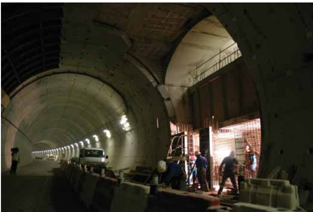
Photo 4 Réalisation de la niche de sécurité
