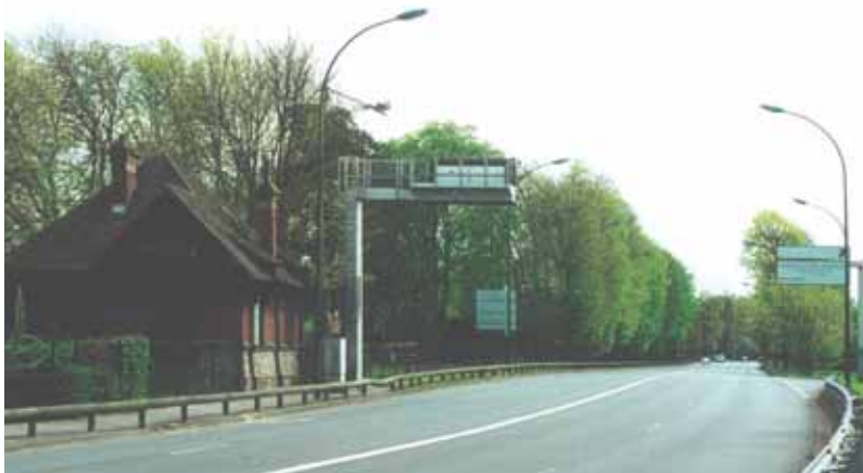
Photo 10 Pavillon aux bœufs avant démolition "Pavillon aux bœufs" prior to demolition
