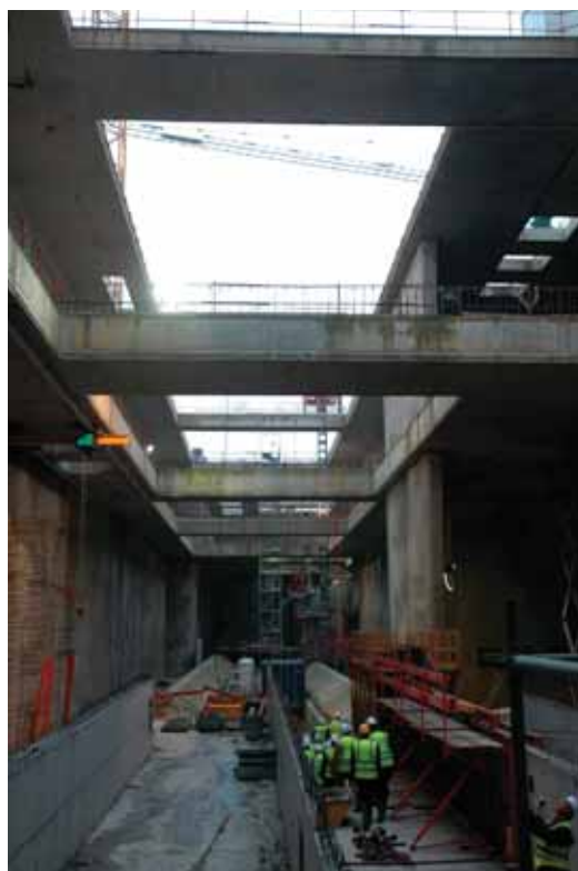
Photo 1 Visite du chantier du futur échangeur A86/A13 avec des partenaires locaux Visit to the site of the future A86/A13 interchange with local partners
