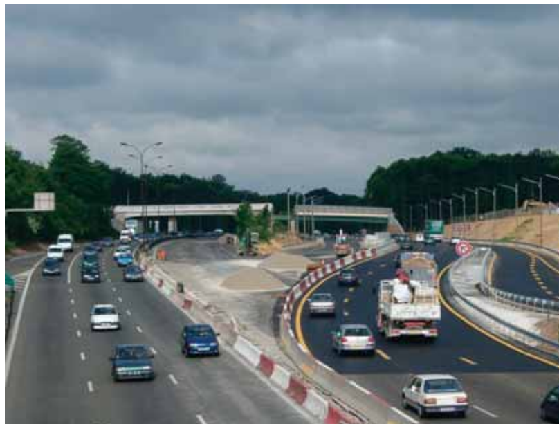
Photo 9 Déviation autoroute A13 A13 motorway diversion
