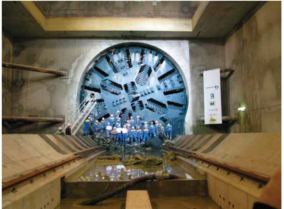
Photo 3 Sortie du tunnelier le 14 octobre 2003 Tunnel boring machine exit on 14 October 2003
