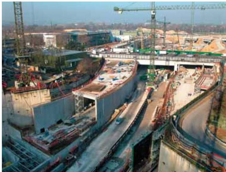
Photo 5 Travaux en cours au niveau du raccordement de Rueil-Malmaison
