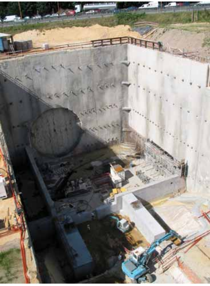
Photo 11 Tête de tunnel réalisée Tunnel portal constructed
