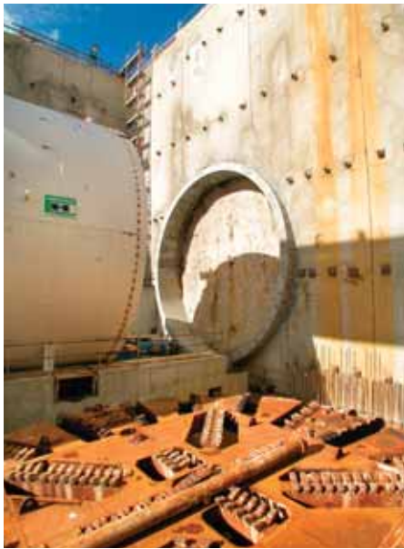
Photo 2 Le tunnelier en phase de montage à Pont Colbert
