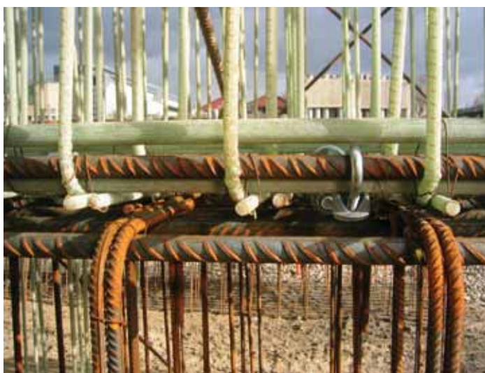
Photo 8 Vue de la zone de recouvrement entre les armatures métalliques et celles en fibres de verre
