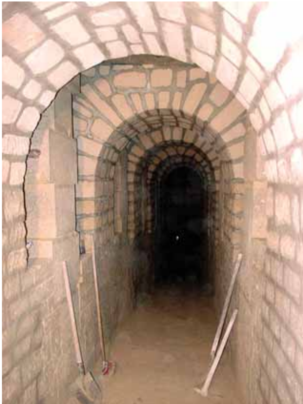
Vue des voûtes maçonneries à partir de l'étage supérieur
