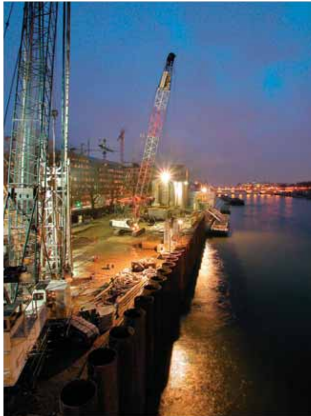
Photo 1 La plate-forme de travail avec en premier plan, le rideau autostable
