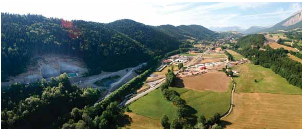
Photo 14 Vue aérienne depuis le nord vers le sud de la vallée du Fanjaret
