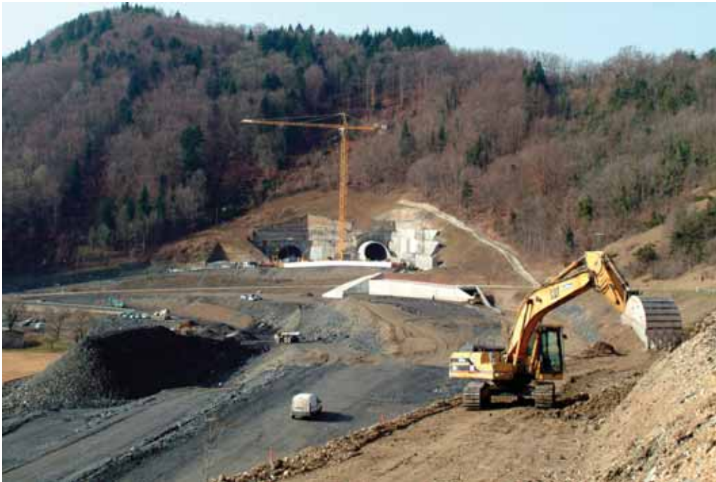
Photo 3 Remblais R8 en cours de réalisation Work in progress on R8 embankment
