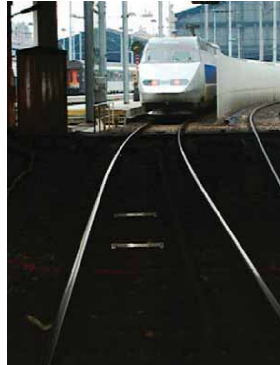
Terminus gare du Nord à Paris : électronivelles sur les voies du TGV
