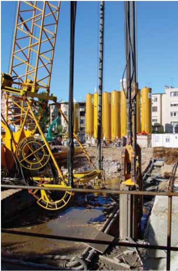
Forage d'un panneau Drilling a panel
