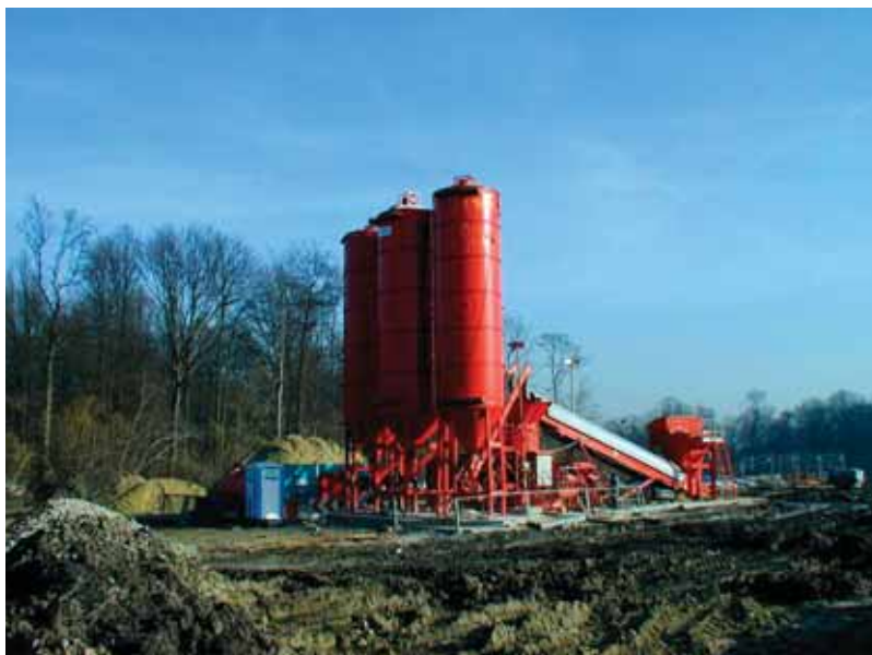
Centrale de fabrication des produits de comblement Plant for production of filler products
