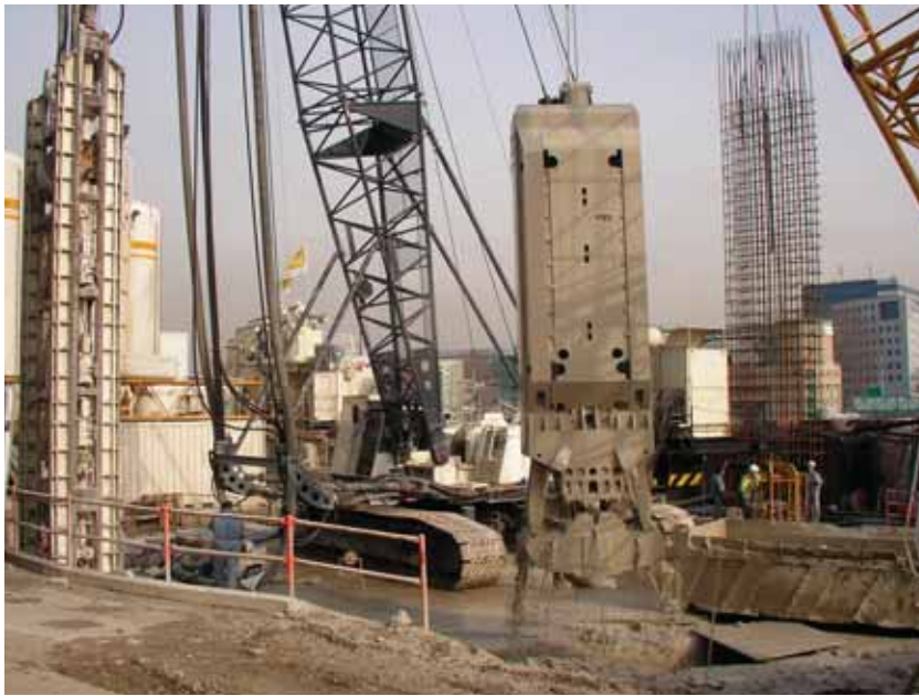
Photo 4 Forage des premiers mètres d'un panneau primaire, à la benne à câbles, dans une emprise déjà bien encombrée
