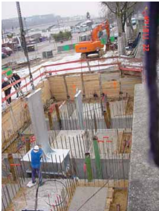
Photo 1 Pose des "marteaux" du massif "catène" en rive gauche
