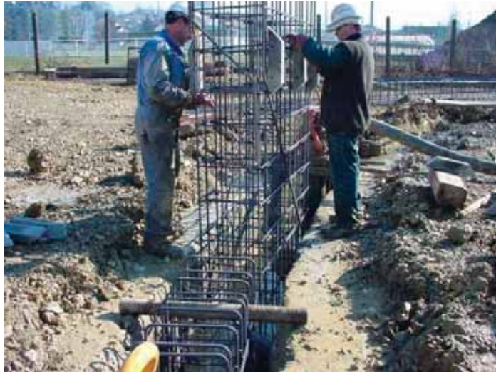
Photo 2 Le ferrailage d'un panneau de paroi moulée Reinforcement of a diaphragm wall panel
