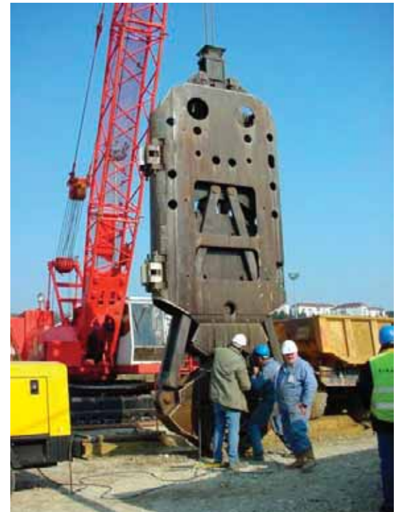
Photo 1 La benne d'excavation de paroi moulée The diaphragm wall excavation bucket
