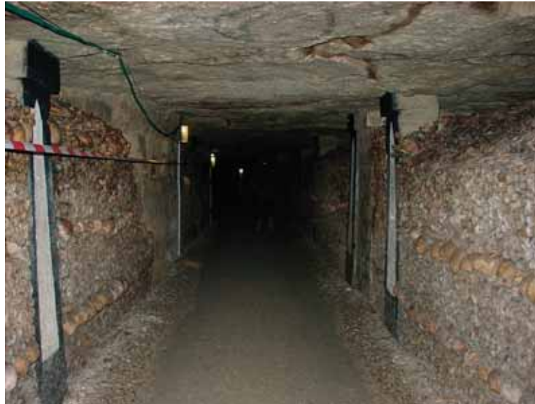
Galerie d'accès aux travaux de confortement Gallery for access to consolidation work
