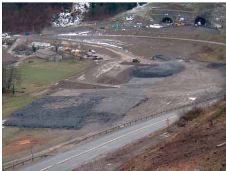
Photo 2 Réutilisation du marinage du tunnel pour le préchargement des banquettes R8 Recycling tunnel mucking as preliminary fill for the R8 berms
