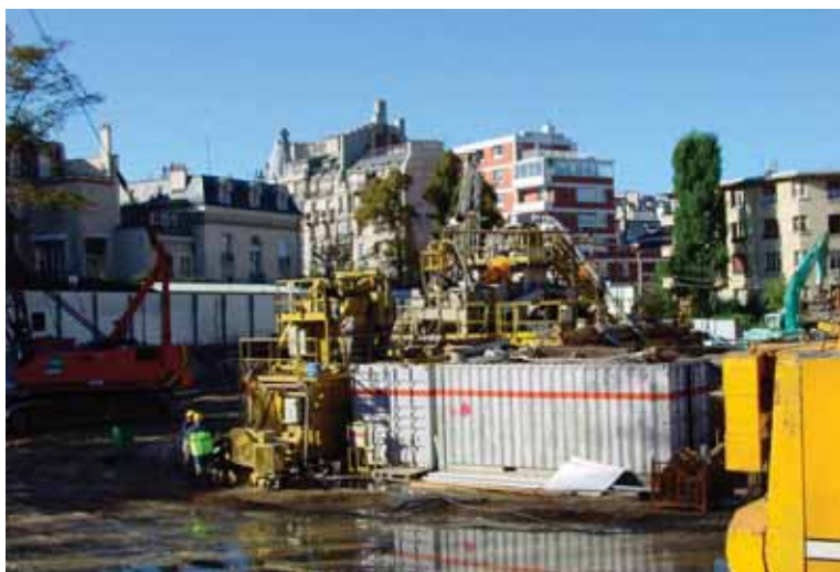
Unité de dessablage Desilting unit
