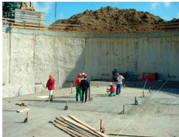
Photo 3 Réglage du fond de fouille avant construction du radier, têtes des micropieux préalablement exécutés depuis la surface
