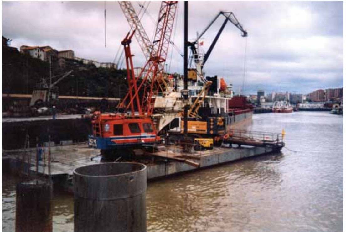
Photo 1 Réalisation des pieux depuis une barge Construction of piles from a barge
