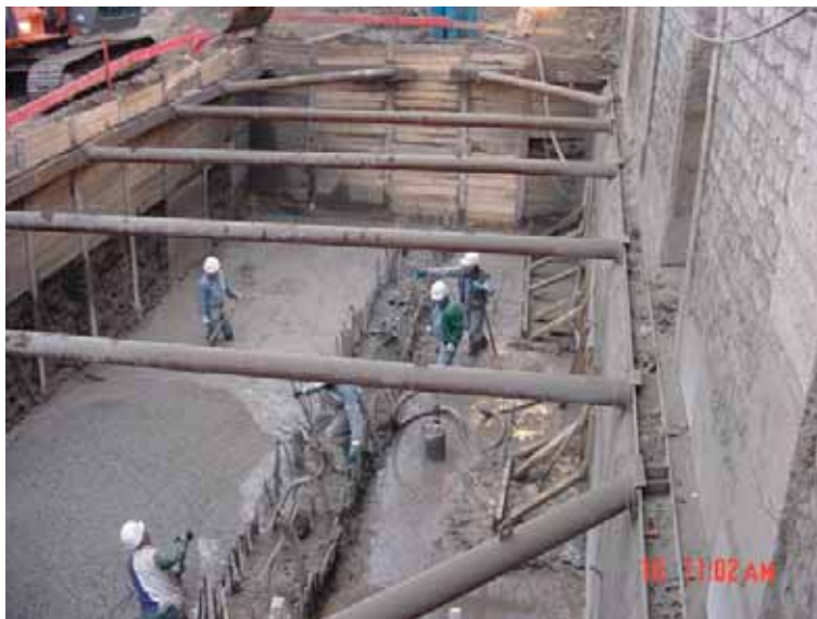
Photo 3 Fouille du massif "catène" en rive gauche, protégée par une paroi berlinoise
