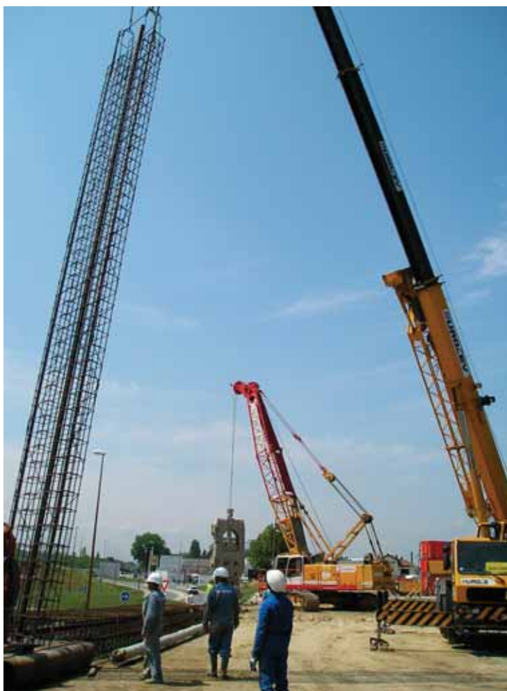
Levage d'une cage d'armature de la paroi moulée Lifting a diaphragm wall concrete reinforcing cage
