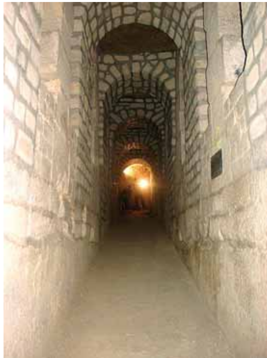
Vue des voûtes maçonneries à partir de l'étage supérieur View of the masonry vaults from the upper level
