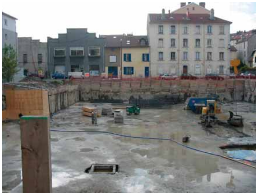
Paroi de soutènement côté rue Clément Supporting wall on Rue Clément street side
