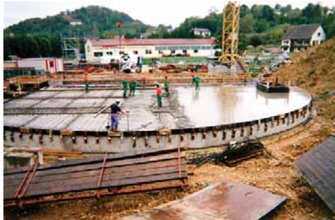
Photo 5 Coulage de la dalle de couverture
