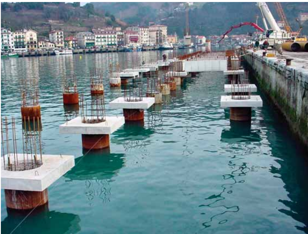
Photo 3 Après la réalisation des pieux, pose des éléments préfabriqués qui porteront le quai After construction of the piles, laying of the prefabricated elements that will carry the dock
