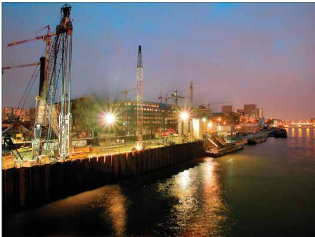
Photo 7 Vue d'ensemble du chantier pendant le poste de nuit, avec les barges à déblais en attente sous la centrale de recyclage
