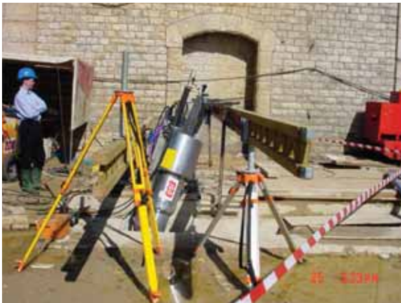
Photo 5 Dispositif pour les essais de tension sur les tirants System for tension tests on the tension members
