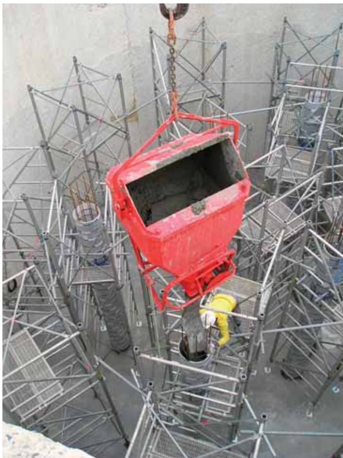
Première phase du bétonnage des poteaux Initial phase of column concretin
