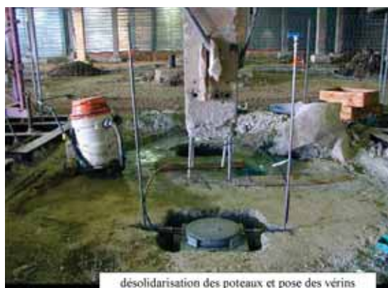
Photo 6 Pose des vérins en tête des micropieux Placing jacks on the heads of the micropiles
