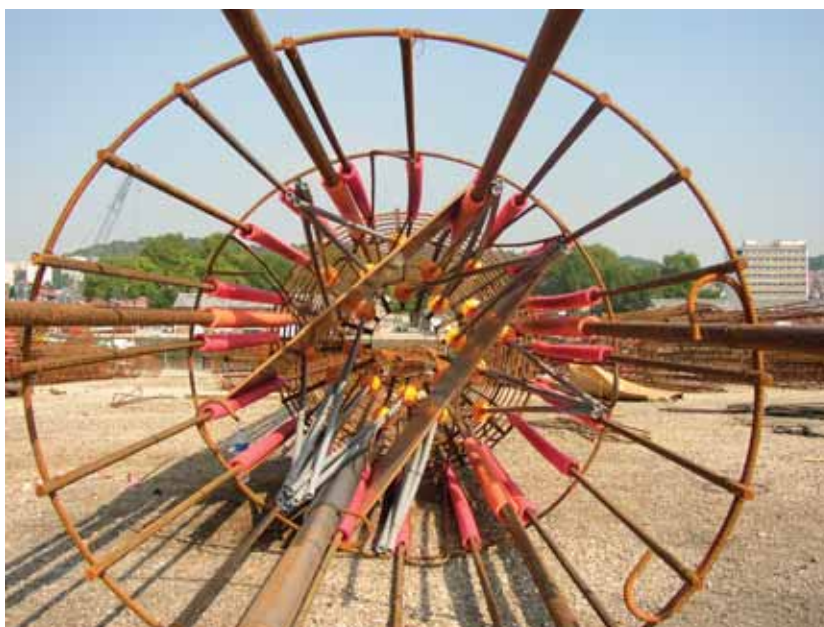
Photo 5 Cadre support préfabriqué des flacons Prefabricated support frame for flasks
