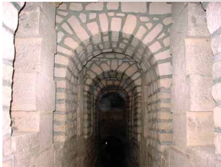
Appui des voûtes sur le banc calcaire Vault support on the limestone bed
