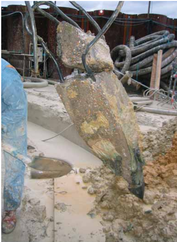
Photo 9 La pointe d'un pieu préfabriqué en béton rencontré lors du forage d'un panneau
