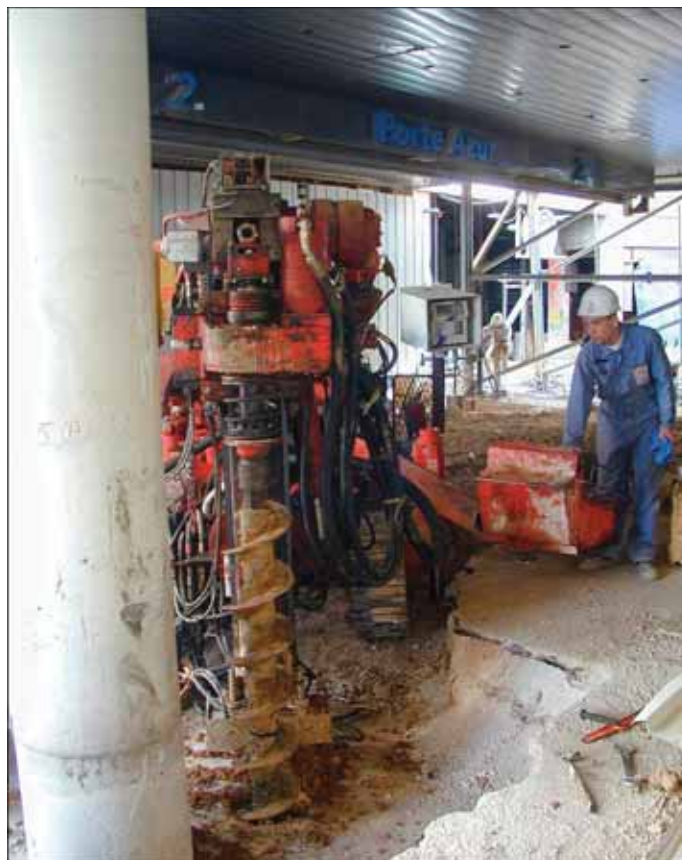
Photo 3 Forage sous hauteur limitée
