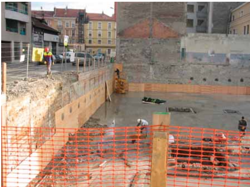
Paroi de reprise en sous-œuvre Underpinning wall
