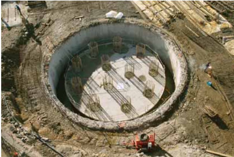
Photo 11 Fondation P5 Foundation P5
