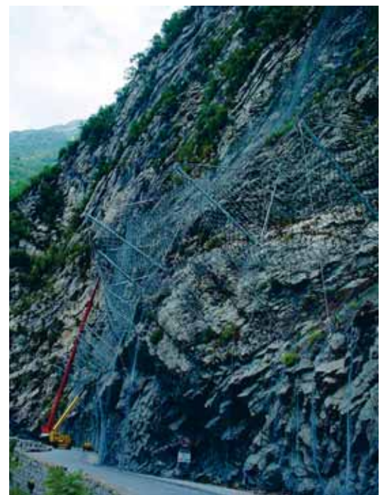
Photo 8 Barrières dynamiques classe 9 Class 9 dynamic barriers
