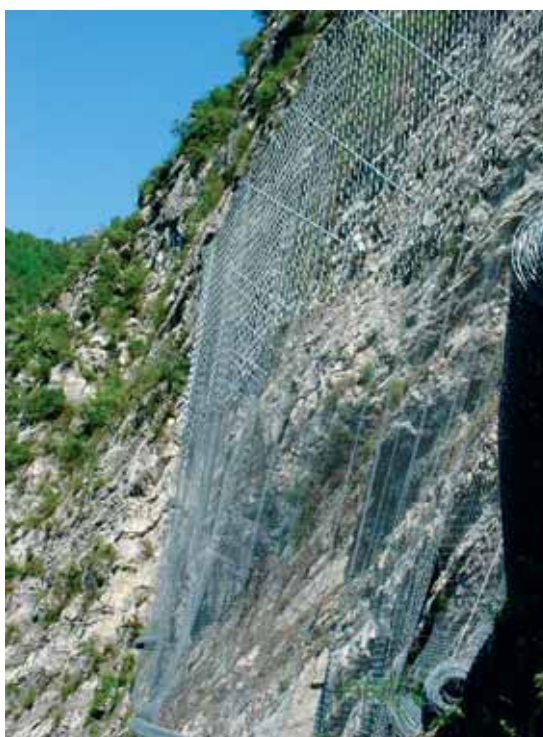
Photo 5 Grillage et renfort ASM
