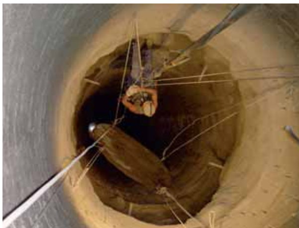
Photo 3 Phase d'équipement dans les puits
