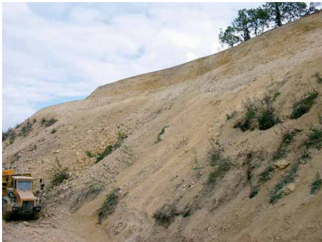
Photo 8 Après travaux After the works
