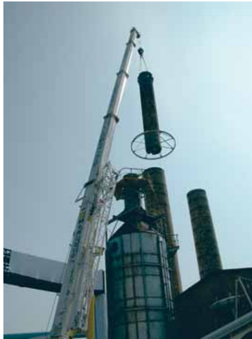
Evacuation des conduits de cheminée par grue
