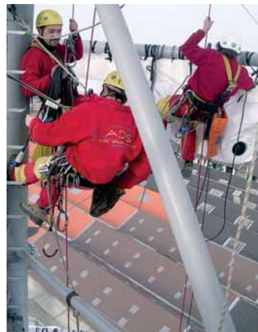
Travaux sur les gonflables blancs Work on the white inflatable rings
