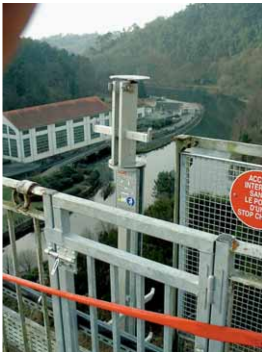
Photo 5 Barrage de Guerledan. Partie haute pivotante permettant à l'opérateur de s'assurer en position de sécurité
