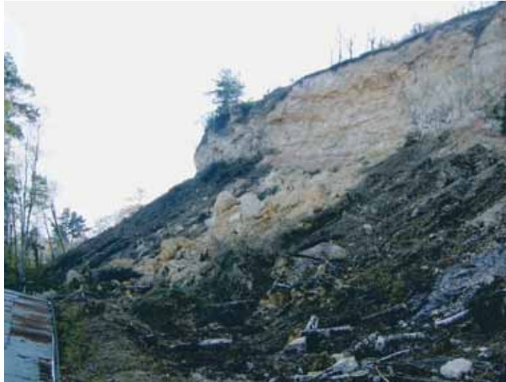
Photo 1 Vue générale du site avant travaux General view of site before the works
