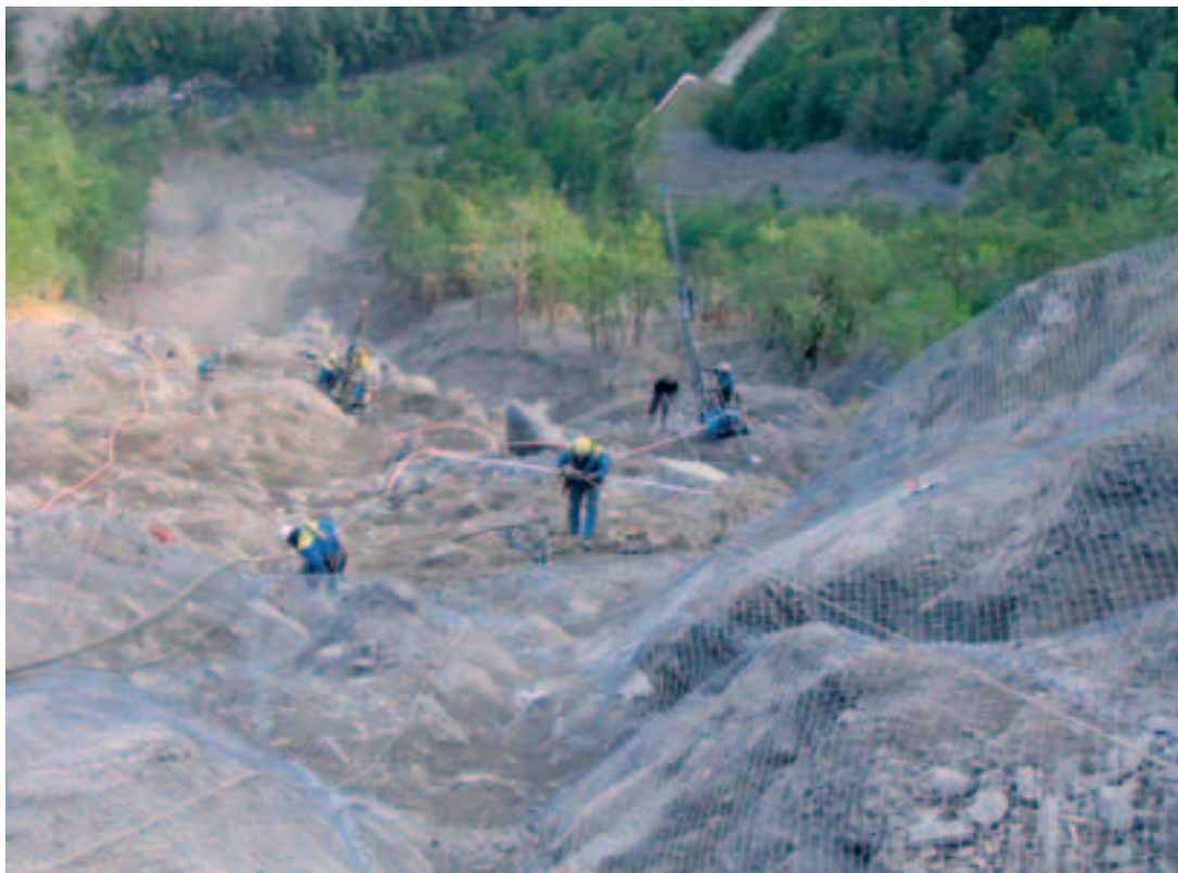
Photo 3 Forage des ancrages de plaquage du grillage Tecco
