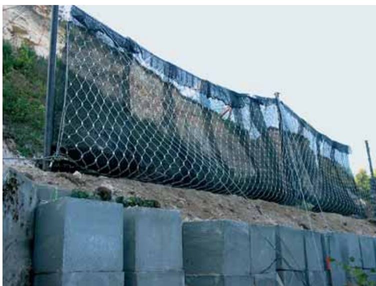
Photo 5 Vue de détail de l'écran de filet classe 6
