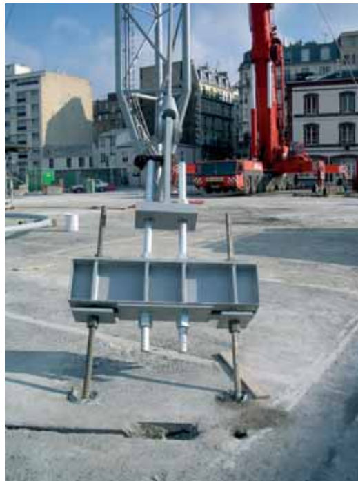
Ancrage de haubans avec tirants enfouis Stay cable anchorage with buried tension members
