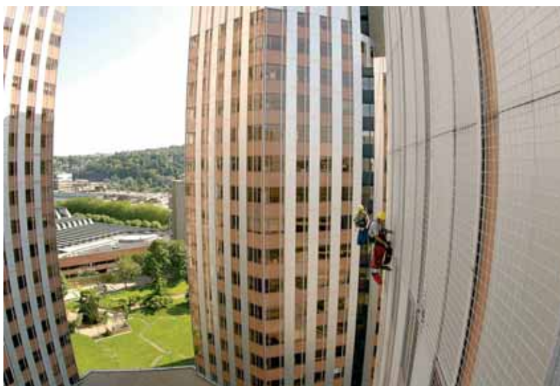
Réglages au niveau des filants d'angle
