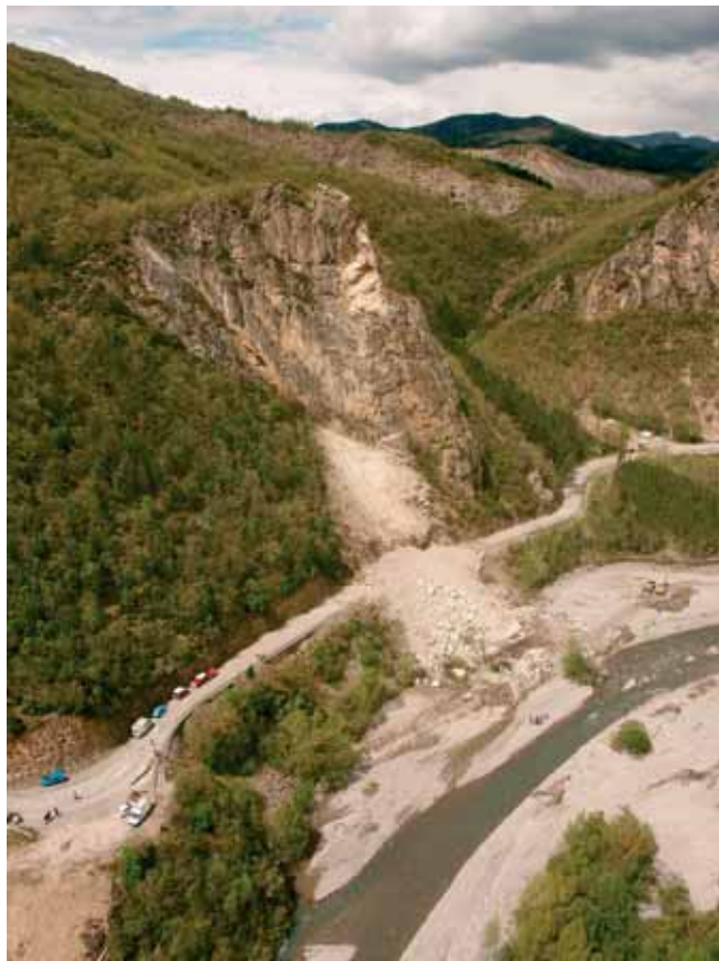
Photo 1 Vue générale de l'éboulement côté Sisteron General view of the rock slide on the Sisteron side
