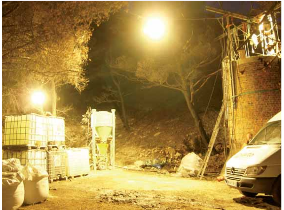
Photo 1 Travaux de nuit Night work
