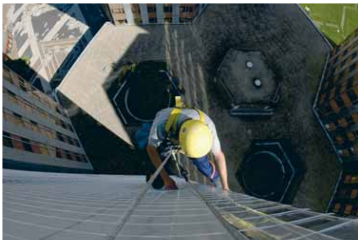
Mise en tension d'un câble intermédiaire
