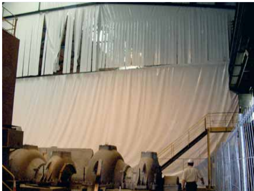
Bâche de confinement à l'intérieur de l'usine Confinement tank inside the plant
