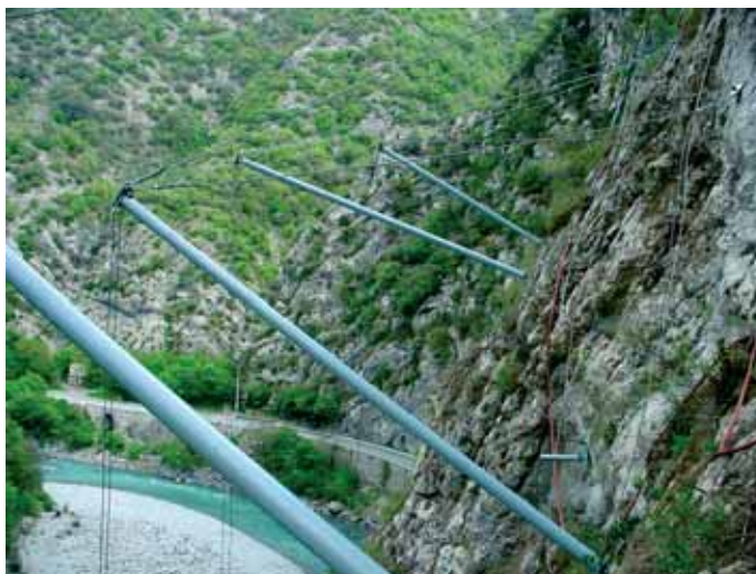
Photo 5 Grillage et renfort ASM
