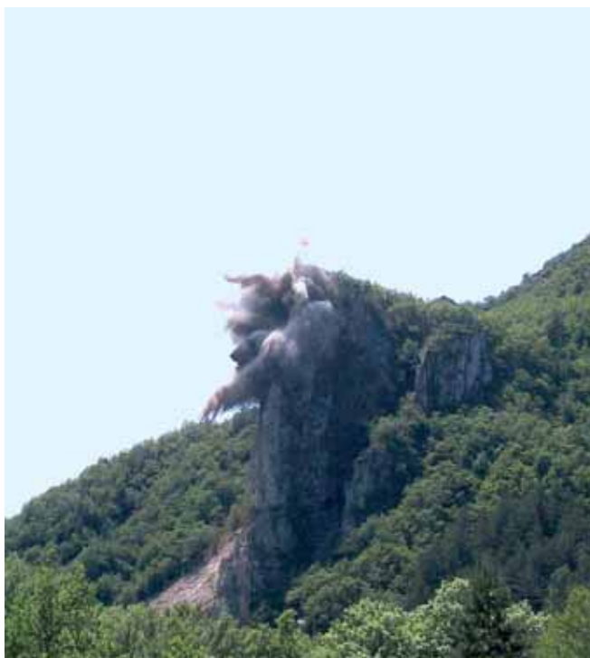
Photo 6 Mise à feu du tir Blast firing
