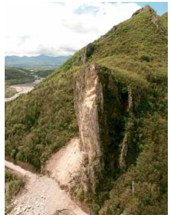
Photo 2 Vue générale de l'éboulement côté la Motte du Caire General view of the rock slide on the "Motte du Caire" side
