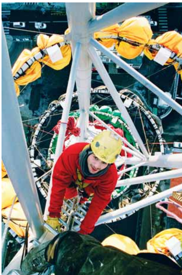
Evolution et travaux dans le mât
