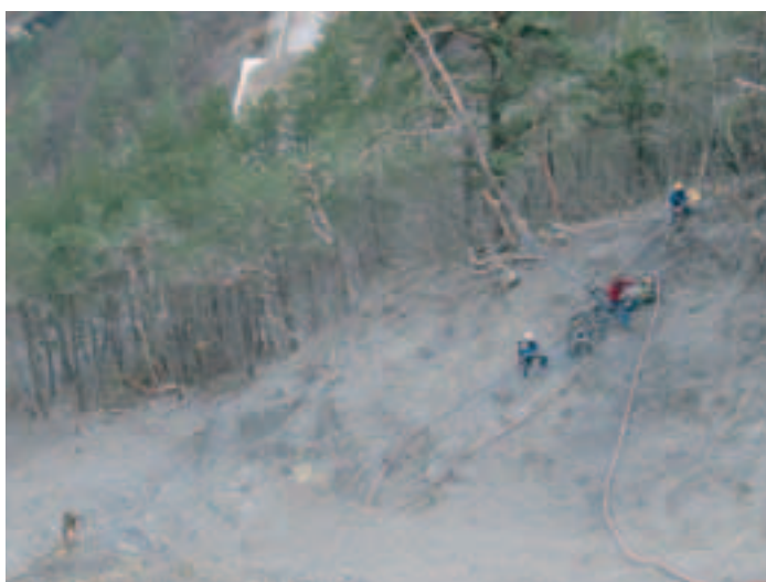
Photo 5 Forage des ancrages de l'écran 3 000 kJ à mi-hauteur du couloir
