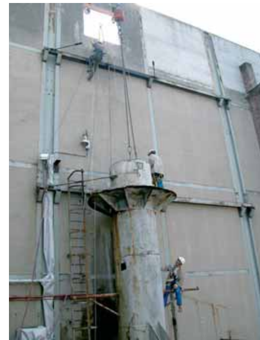
Evacuation de la partie basse de la cheminée
