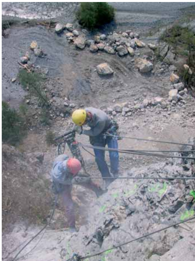
Photo 4 Forage manuel pour le déroctage à l'explosif
