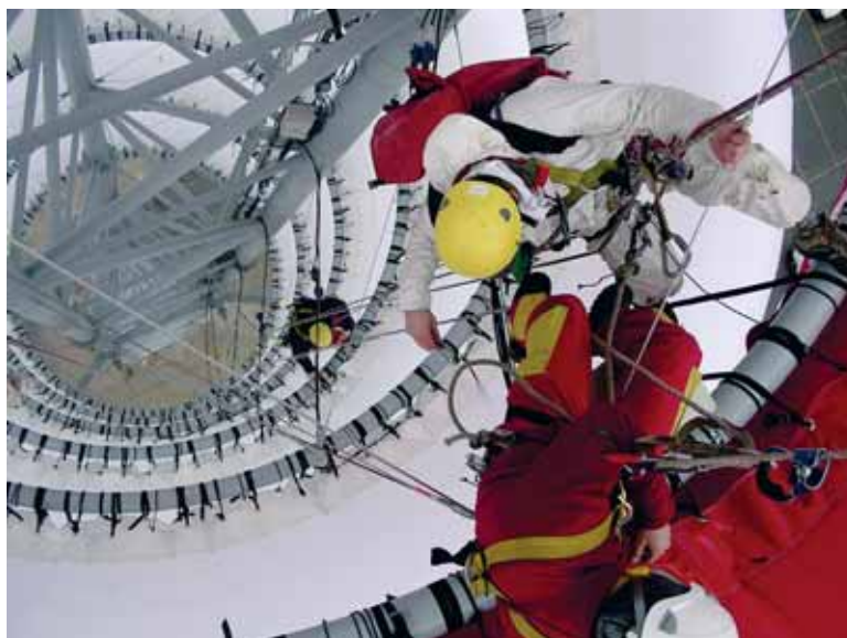
Travaux sur fixation Attachment works
