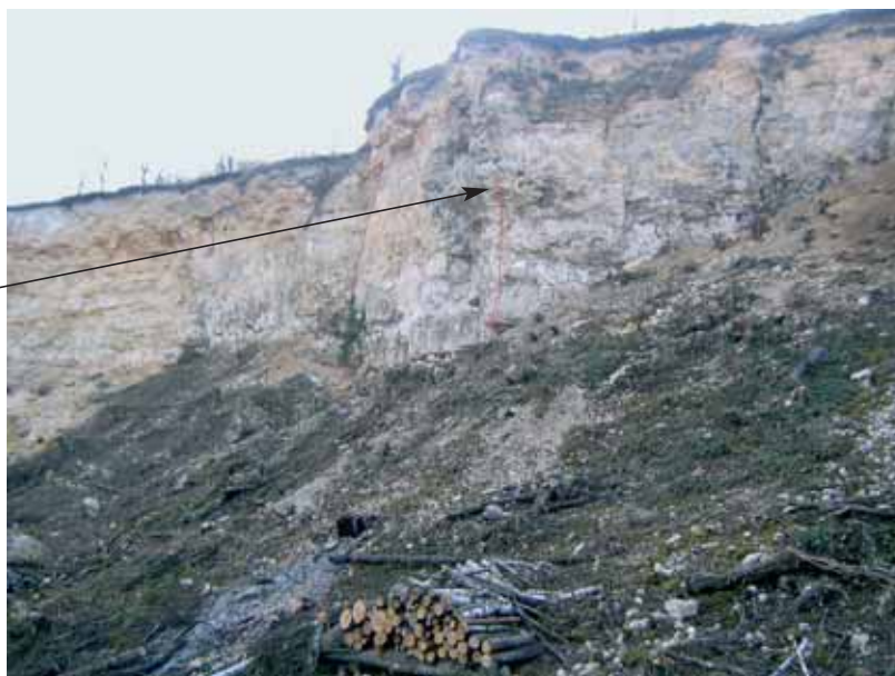
Photo 2 Vue des capteurs en parois View of the sensors on the walls
