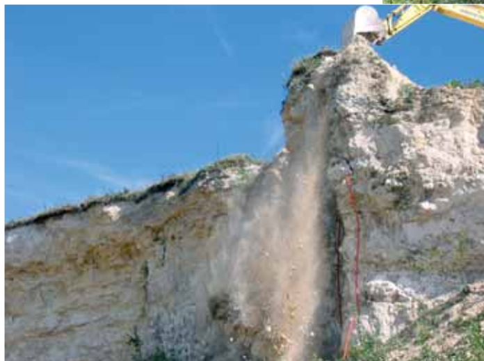
Photos 6 et 7 Travaux de terrassement Earthworks
