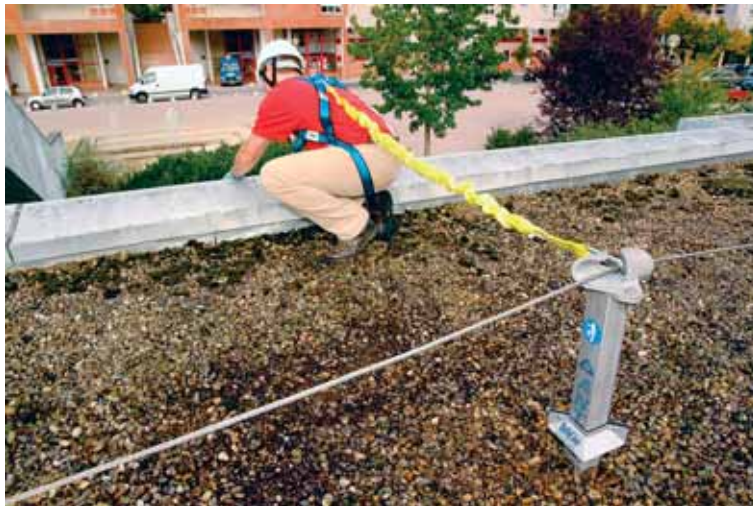
Photo 2 Solution antichute par système de ligne de vie Safeline d'Antec Fall prevention solution through the Antec Safeline lifeline system
