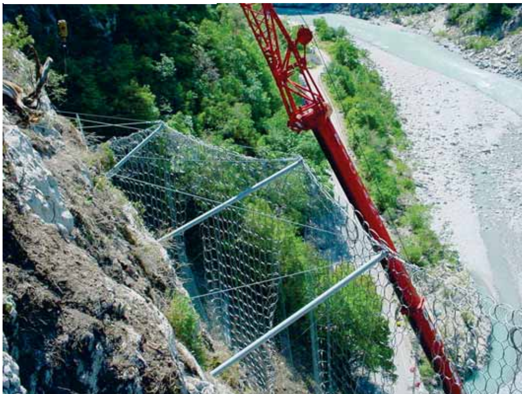
Photo 7 Pose des filets ASM Installing ASM nets
