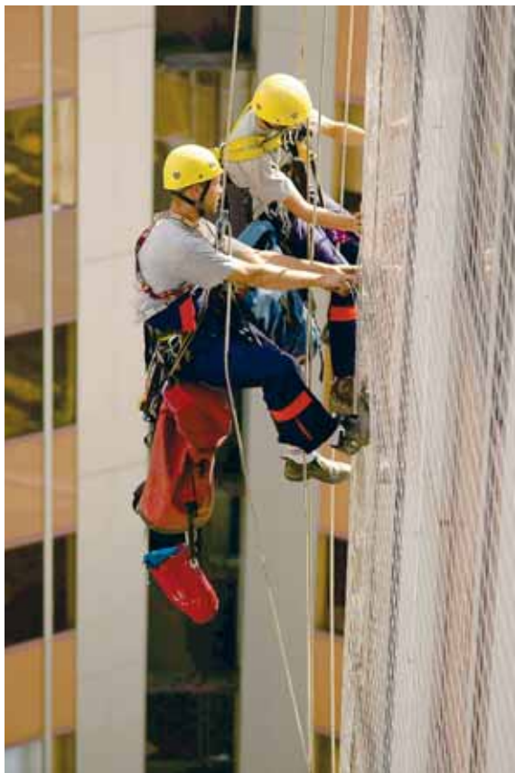
Reprise d'étanchéité d'une bande bitumineuse Bonding of a bituminous strip
