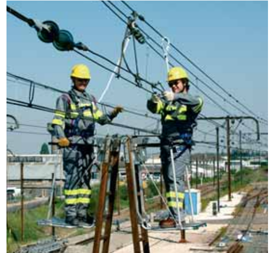
Photo 10 Strapkor de Miller : petite nacelle fixée sur une échelle Lorry offrant une plus grande sécurité que les petits strapontins
