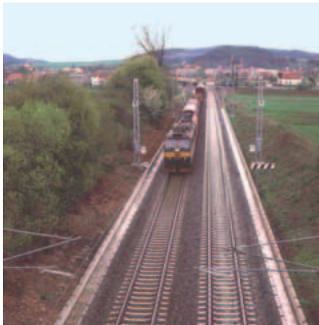
Voie réhabilitée - Moravie (1 er couloir ferroviaire) Renovated track - Moravia (first rail corridor)
