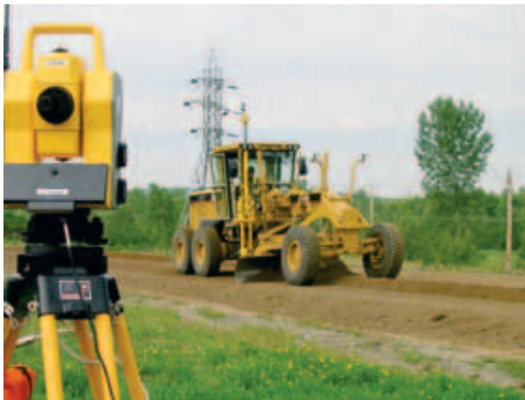
Photo 3 Réglage préliminaire avec niveleuse guidée électroniquement
