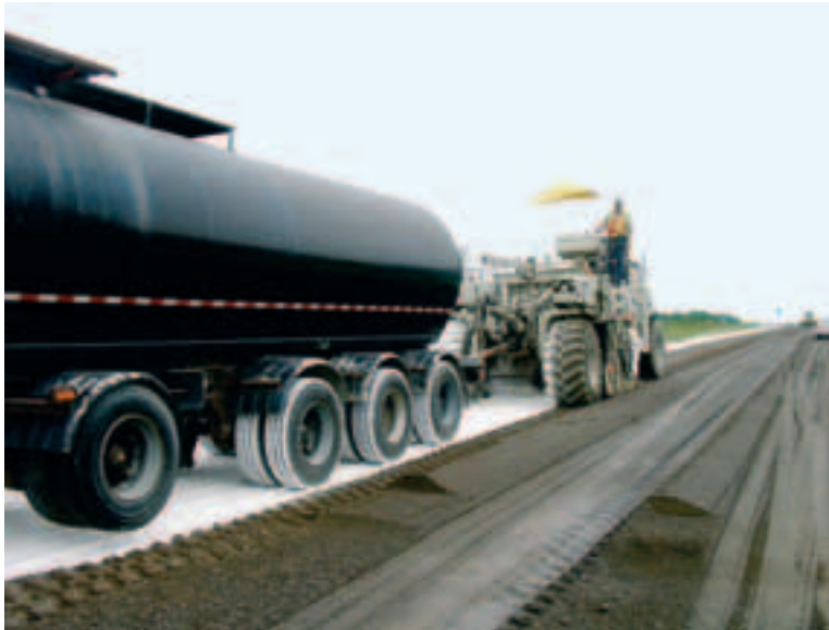
Photo 4 Retraitement en place à l'émulsion de bitume et à la chaux hydratée
