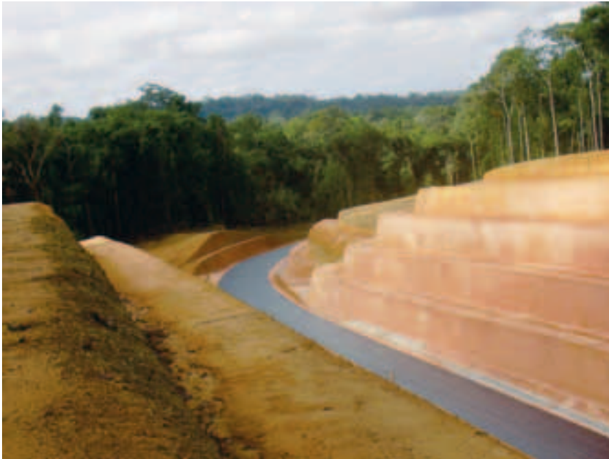
Photo 5 Déblai D4 Earth cut D4
