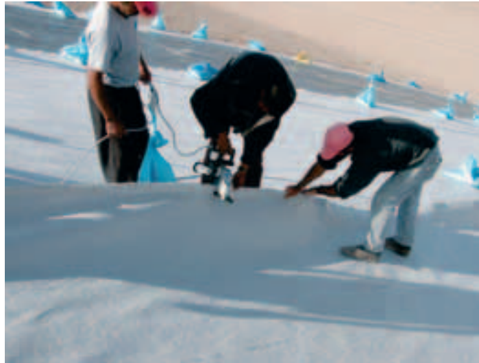
Photo 10 Couture géotextile Geotextile seaming
