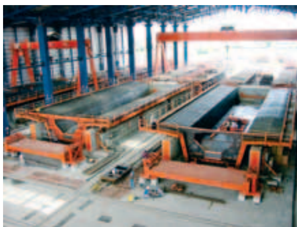
Photo 1 Coffrage avec installation de précontrainte intégrée pour la production de poutres caissons préfabriqués Shuttering with integrated pre-stressing facility for the production of prefabricated box girders
