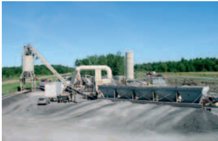
Photo 2 Installation de l'usine mobile d'enrobés sur le terre-plein central de l'autoroute
