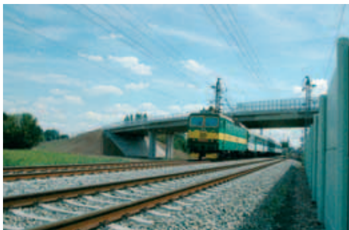
Passage supérieur de Prelouc (section Zabori nad Labem - Prelouc)
