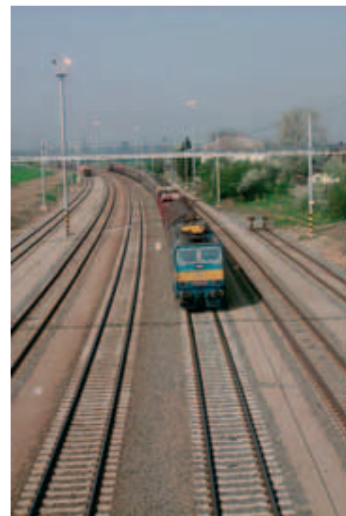
Gare de Hrusky (2 e couloir ferroviaire)
