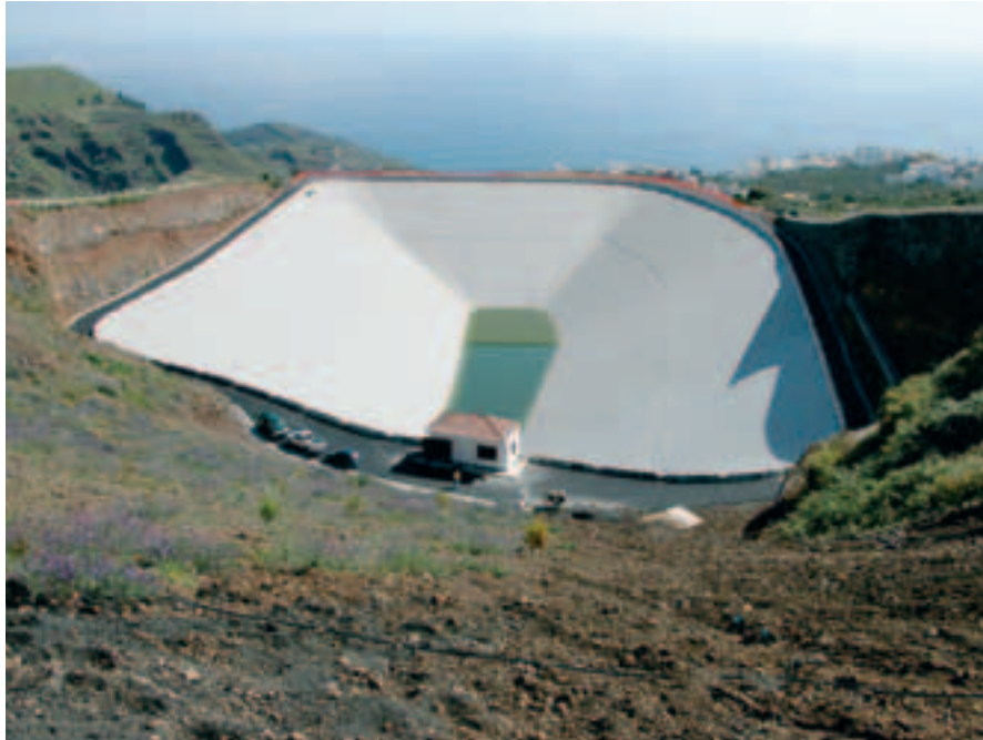
Bassin de Bedestia vu de la crête de la digue de Adeyhamen. La route en pied de talus correspond au sommet du massif de pied de renforcement du talus aval de la digue de Adeyhamen. On observe, à droite, le renforcement de talus par un mur en blocs cyclopéens
