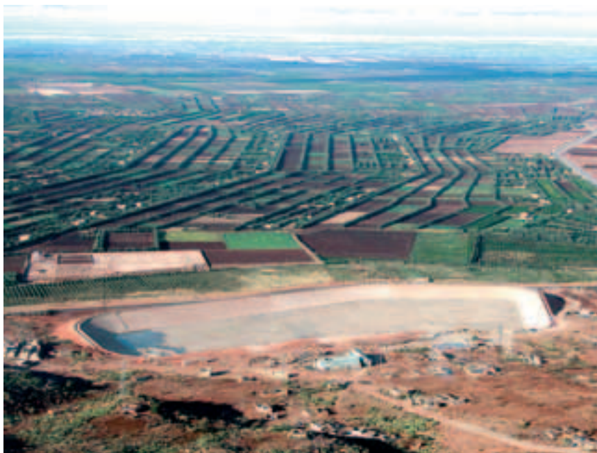
Photo 2 Vue d'ensemble du bassin inférieur
