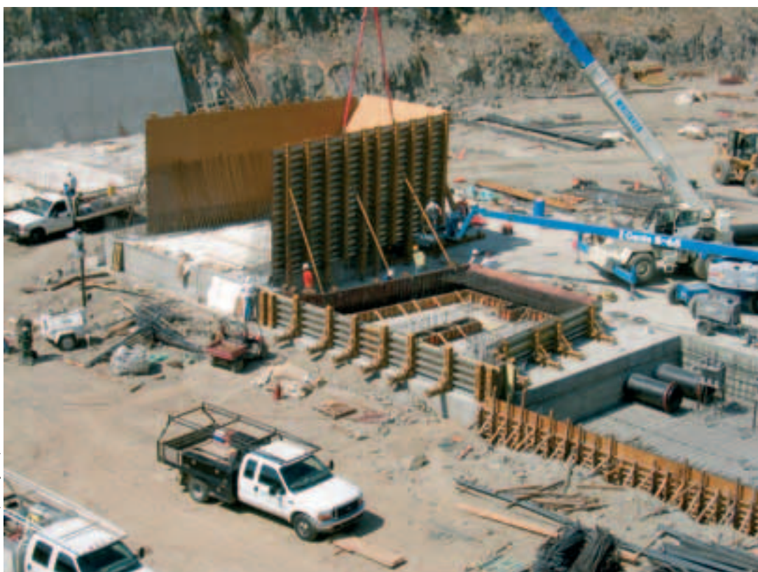
Photo 5 Coffrage des hausses Fuse gate shuttering
