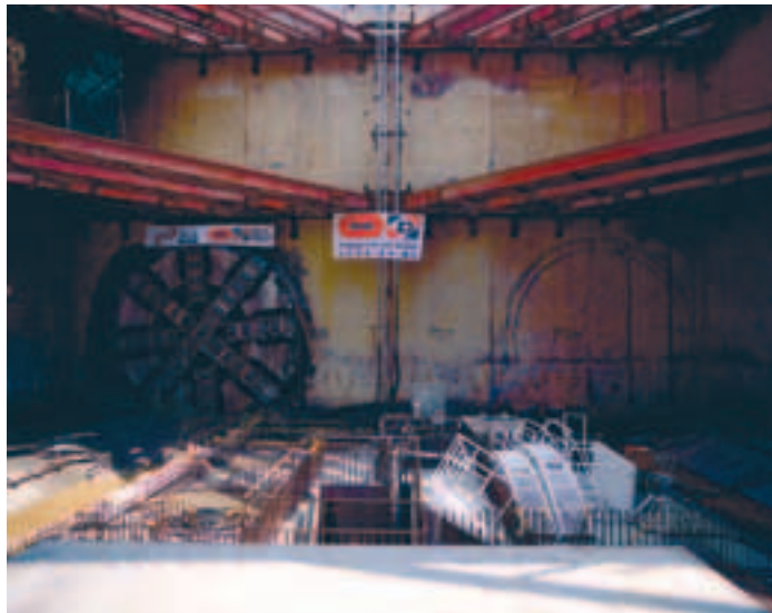
Photo 4 Break-in du tunnelier dans la station
