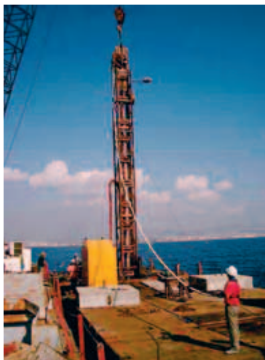
Photo 2 Atelier nautique - Opération de fonçage Nautical workshop - Pile driving operation
