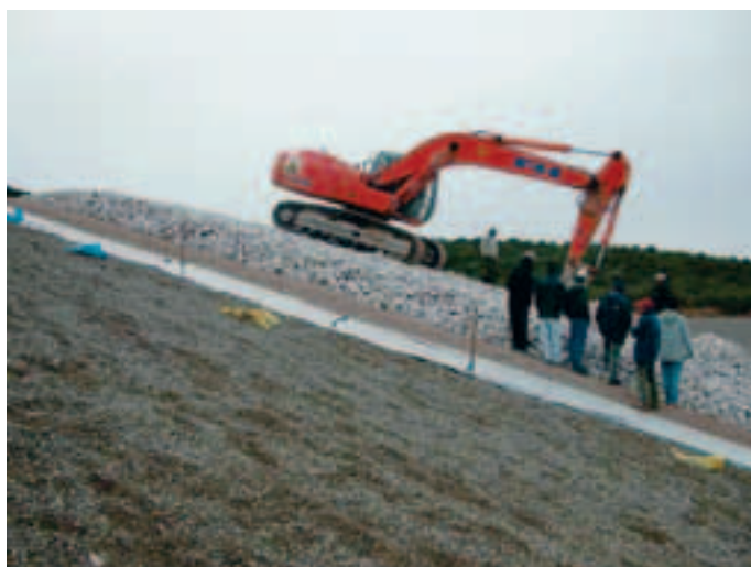
Photo 6 Planche d'essais sur talus à 3/1 bassin inférieur
