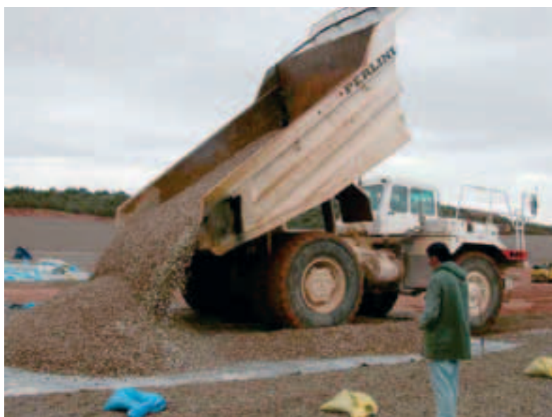
Photo 6 Planche d'essais sur talus à 3/1 bassin inférieur
