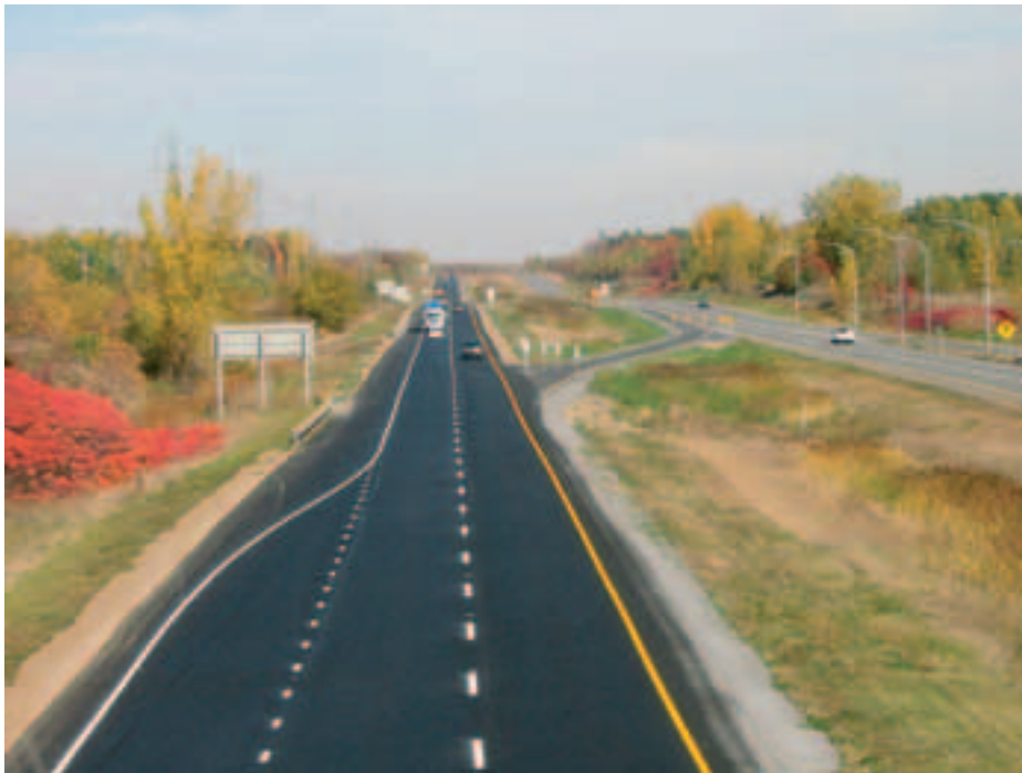
Photo 7 Aspect final du chantier en septembre 2004
