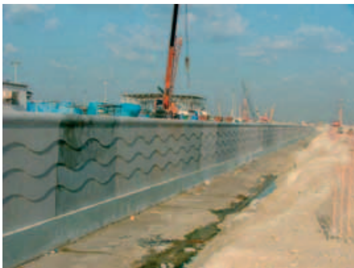
Photo 5 L'habillage des parois autostables du canal
