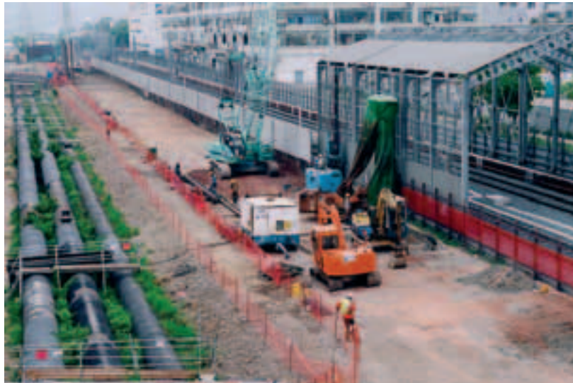
Photo 7 Vérinage palplanches avec portail de protection Jacking of sheet piling with protective gate
