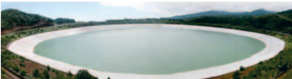
Le bassin de Barlovento en 2004, 13 ans. Géomembrane PVC, 250 000 m 2 , 600 m de diamètre
