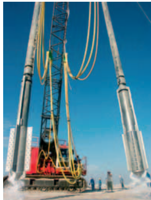
Photo 2 Tandem de vibreurs V48 V48 vibrator tandem
