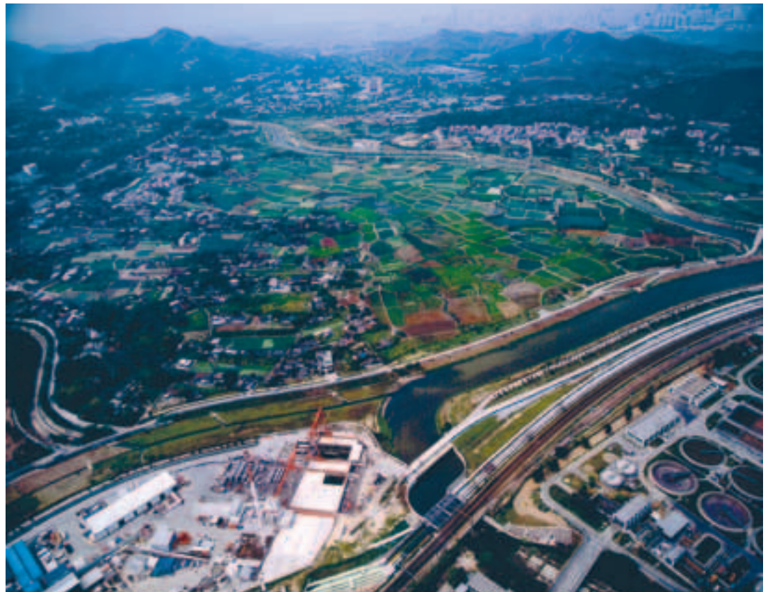
Photo 1 Photo aérienne depuis le puits de départ Aerial photo from the starting shaft
