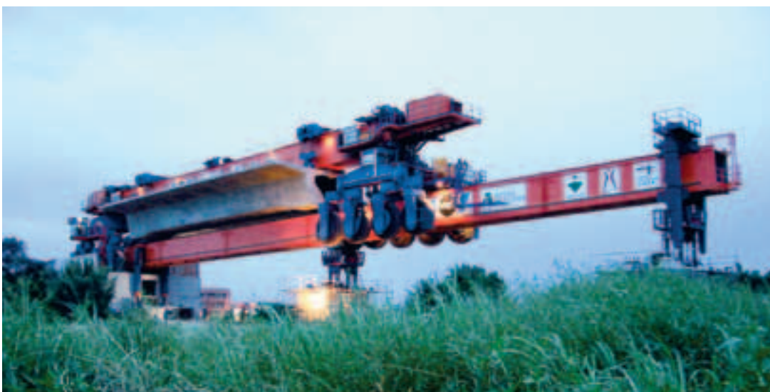
Photo 3 Structure de lancement se déplaçant avec une poutre caisson préfabriquée suspendue le long de la poutre support
