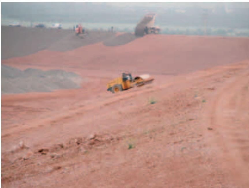
Photo 9 Compactage sur talus à 3/1, bassin inférieur et mise en place de la couche drainante
