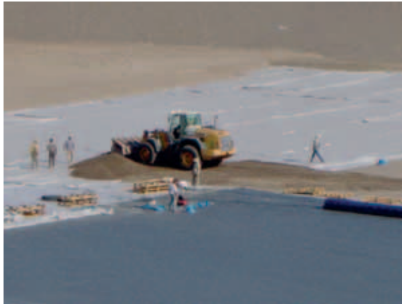
Photo 11 Régalage des matériaux de protection sur le fond
