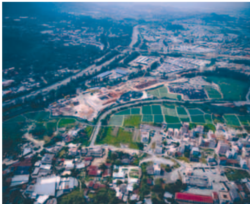
Photo 8 Photo des travaux à l'ouest Photo of works to the west
