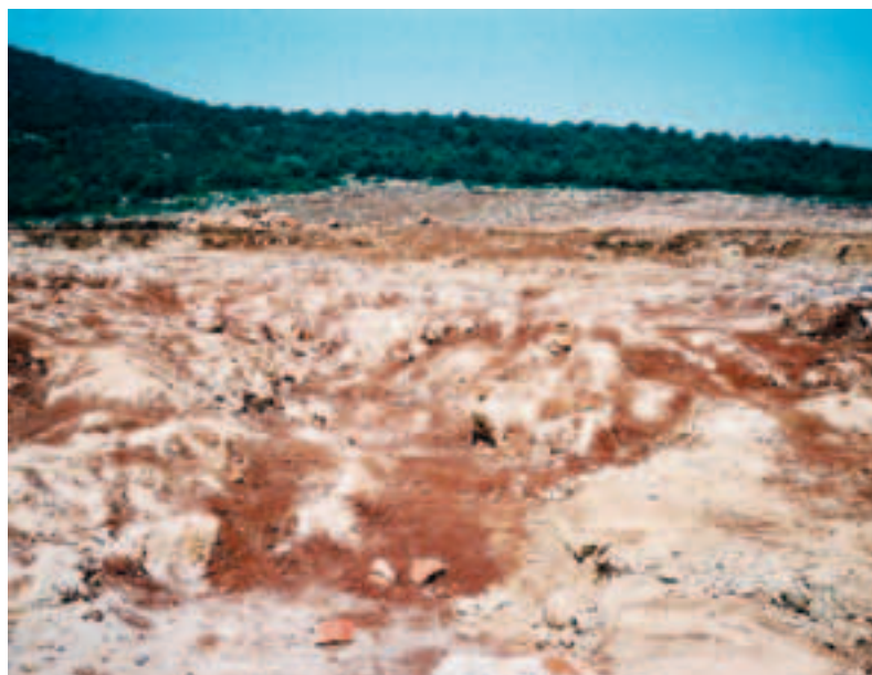
Photo 8 Préparation du support bassin supérieur. Dégagement du toit calcaire et recherche des karsts
