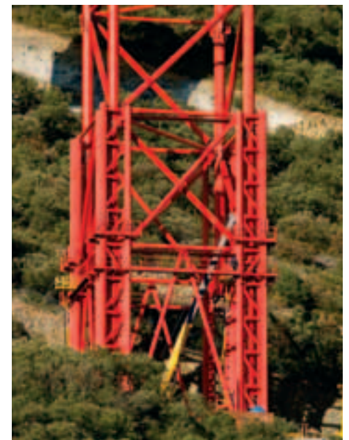
Photos 1 et 2 Vue rapprochée de l'un des quatre coins de la cage de télescopage, avec les "crémaillères" et le système hydraulique Enerpac intégré comprenant vérin, pompe et automate pour le contrôle du levage de la palée provisoire
