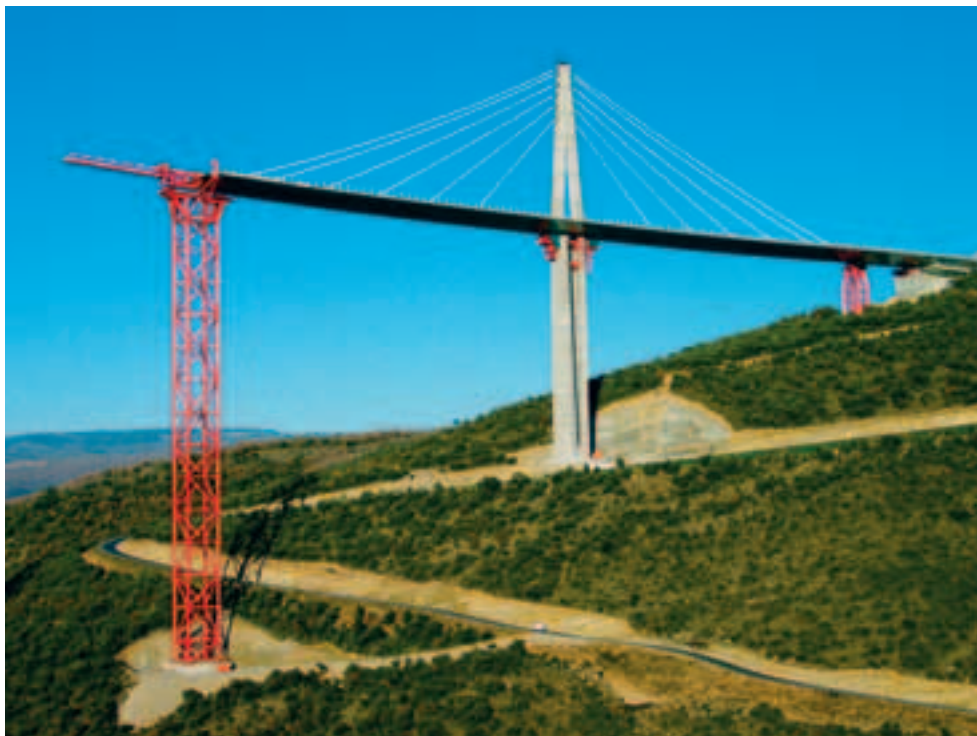
Photo 8 Accostage du tablier nord sur la palée provisoire \pi 2 Docking the northern deck on temporary bent \pi 2
