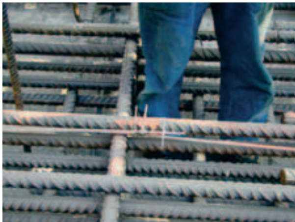
Installation de capteurs extensométriques à fibre optique, noyés dans la semelle de P2
