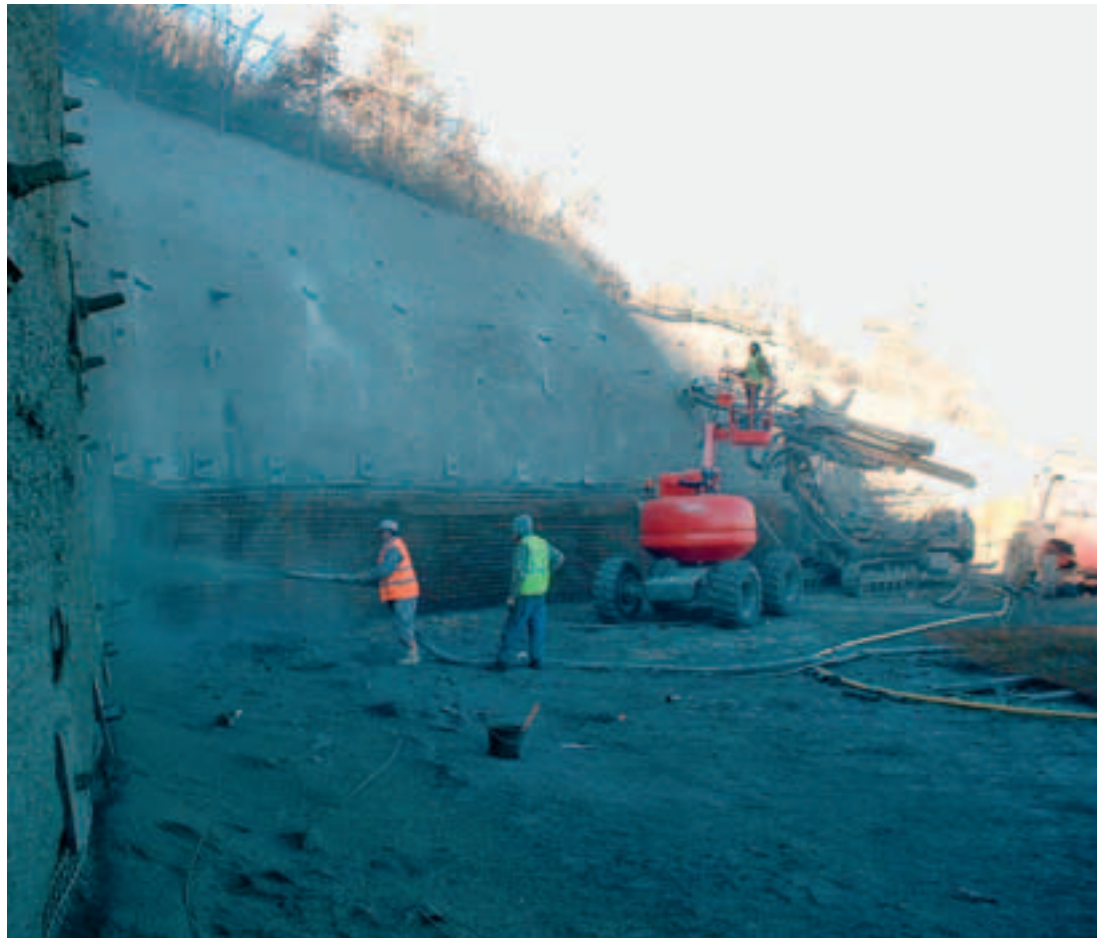
Photo 1 Paroi soutènement P7 Supporting wall P7
