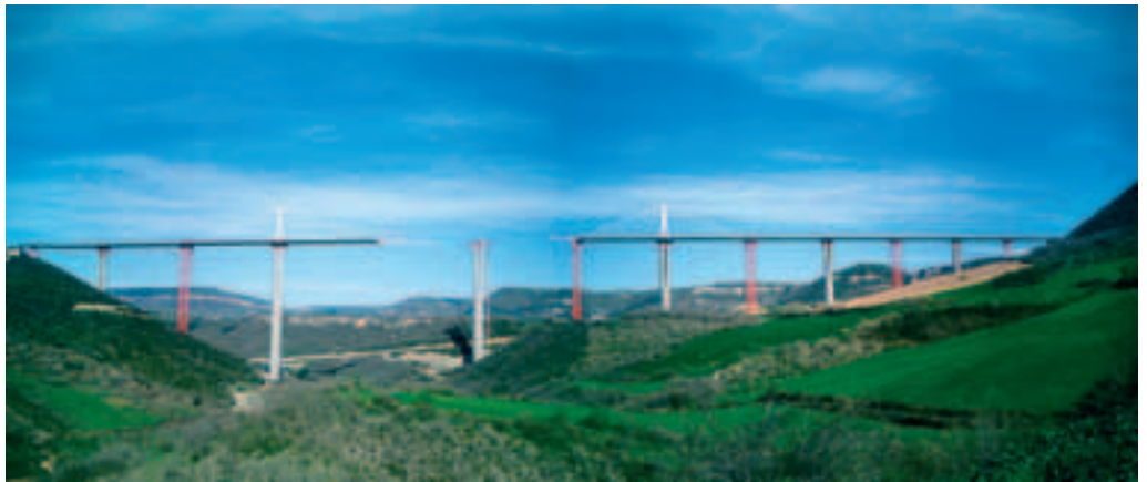
Photo 15 Position du tablier après les lancements L6 nord et L10 sud
