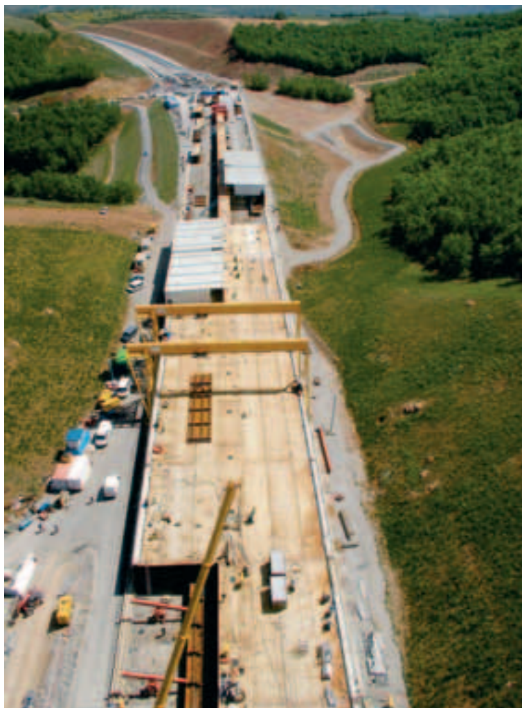
Photo 11 Aire d'assemblage du tablier côté sud Southern end deck assembly area
