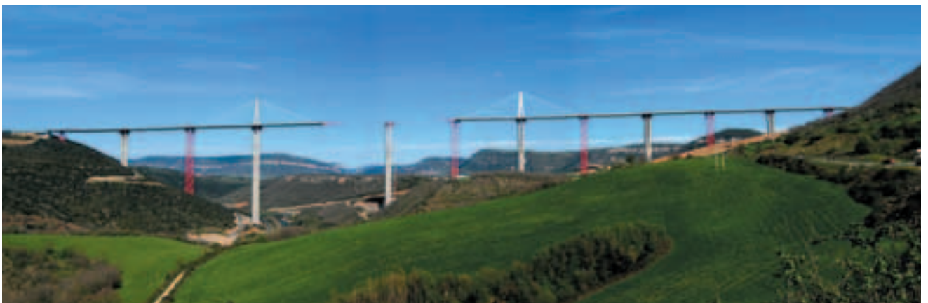
Photo 2 Le viaduc de Millau après le lancement L6 Millau viaduct after launch L6 north
