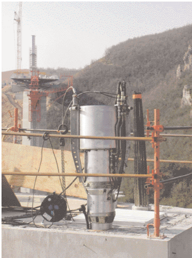
Photo 2 Vérin de mise en tension 400 tonnes sur chevêtre de pile
