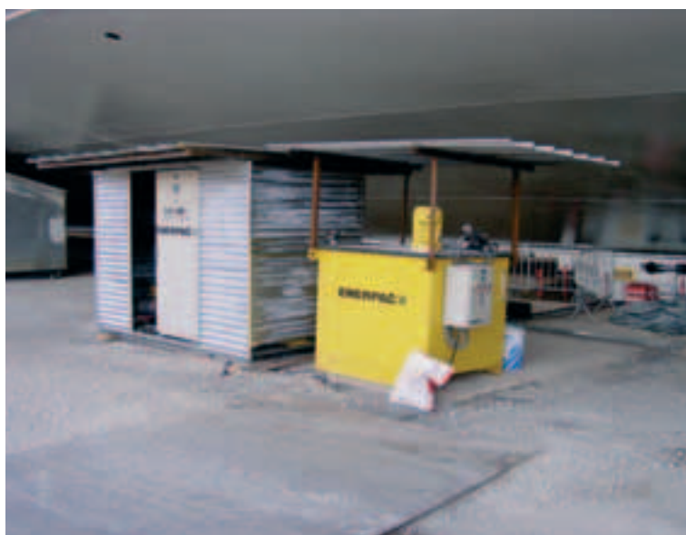
Photo 7 Centrale de commande hydraulique sur culée Hydraulic control unit on abutment
