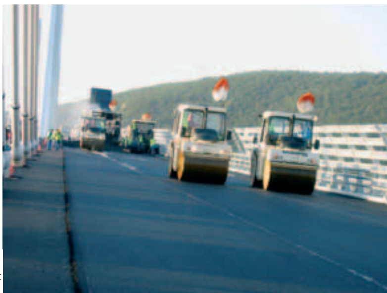
Photo 6 Compactage des enrobés Compacting bituminous mixes
