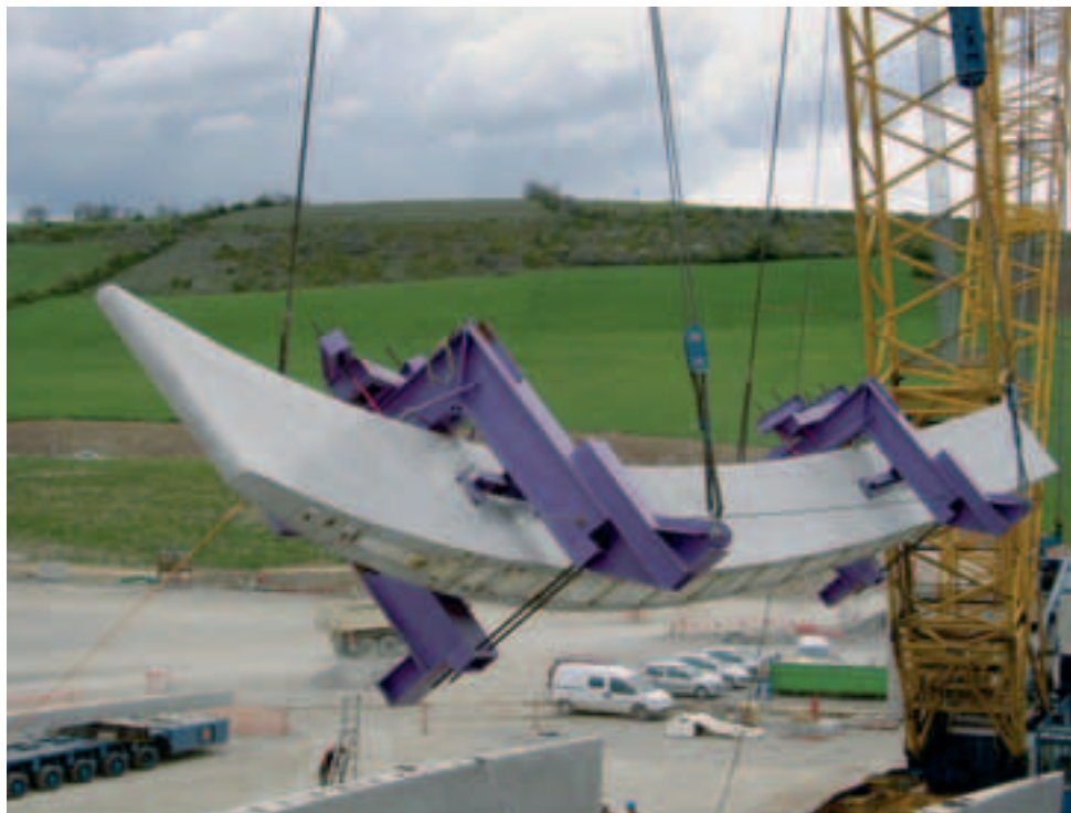
Photo 3 Levage et retournement d'un voussoir Lifting and overturning a segment
