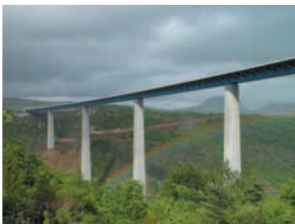
Figure 6 Le viaduc de Verrière (Aveyron). Conception : Setra. Architecte : André Mascarelli. Maître d'œuvre : AIOA. Construction : Spie Batignolles, Dodin, Razel et Buyck
