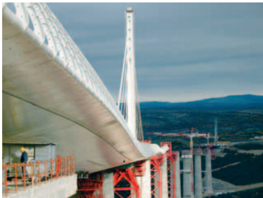
Photo 14 Déformation du tablier au cours d'un lancement côté sud
