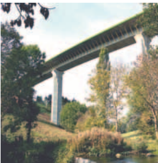
Figures 3 et 4 Les viaducs du Piou et du Rioulong (Lozère). Conception : bureaux d'études Secoa, Sofresid et SEE. Architecte : Philippe Fraleu. Maître d'œuvre : AIOA. Construction : Quillery
