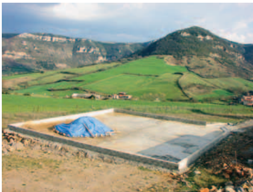
Photo 5 Zone de traitement biologique des matériaux souillés du chantier Area for biological treatment of contaminated site materials
