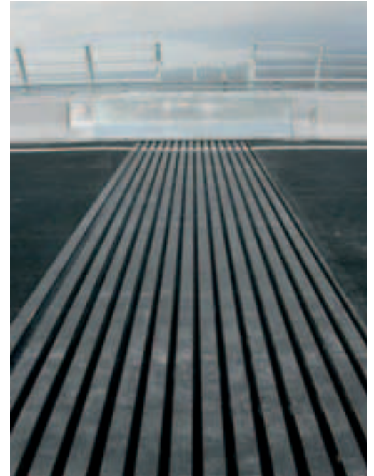
Photo 5 Joint de chaussée : vue de dessus du joint DS 1200
