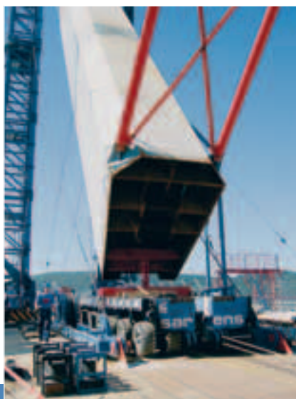
Levage des pylônes Lifting
