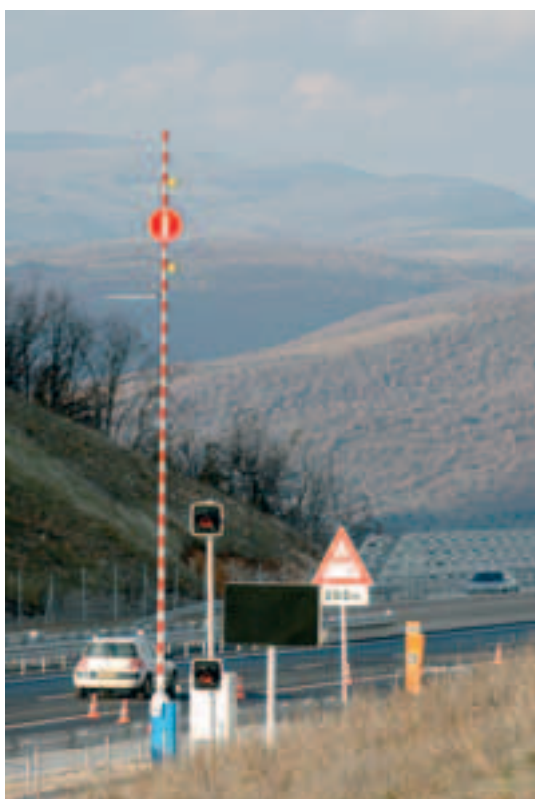
Photo 4 Signalisation dynamique et poste d'appel d'urgence Dynamic signing and emergency call station
