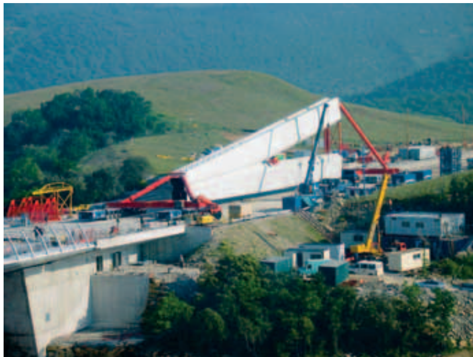
Photo 17 Transport du pylône P1 côté nord
