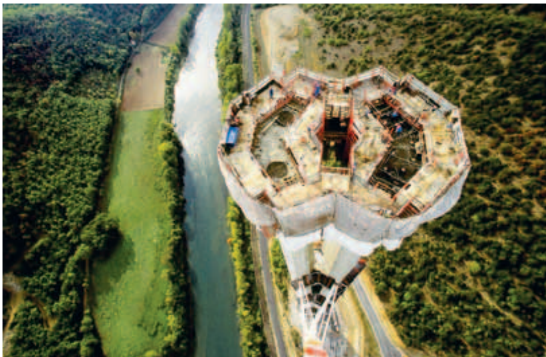
Photo 6 Réalisation des fûts dédoublés de la pile P2
