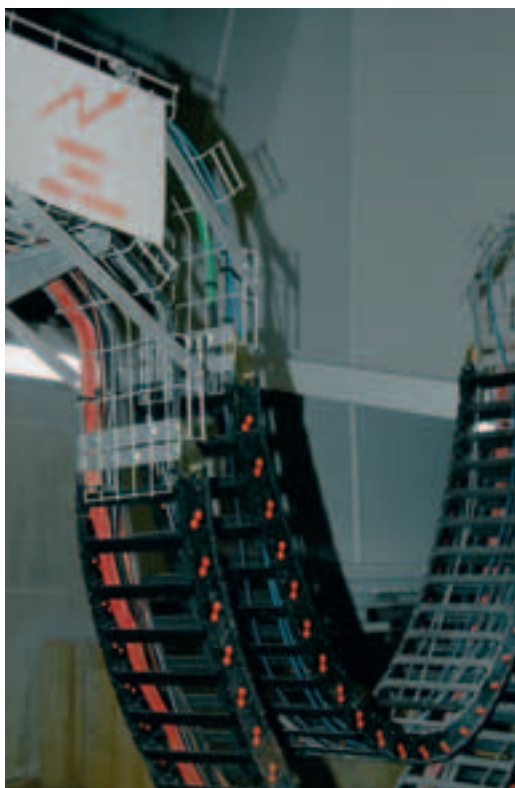
Photo 3 Joint de dilatation par chaîne à câbles
