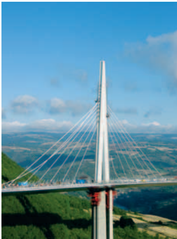
Photo 20 Installation des haubans sur un pylône
