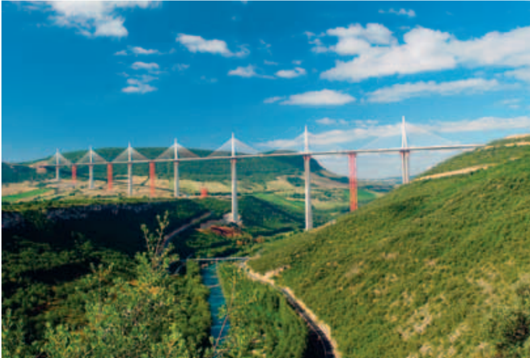
Photo 1 Vue générale du viaduc General view of the viaduct
