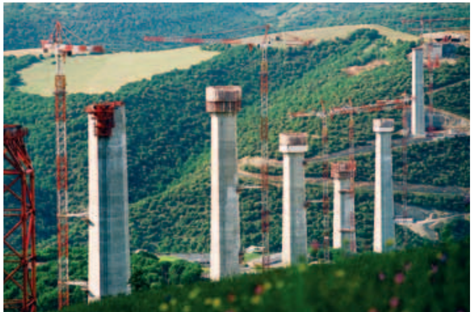
Photo 5 Construction des piles
