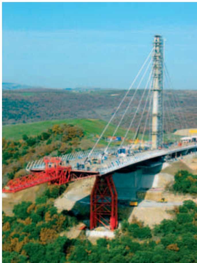
Photo 13 Avant-bec et pylône de lancement côté sud
