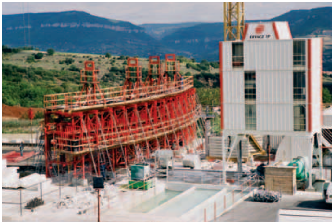
Photo 2 Cellule de préfabrication Prefabrication unit
