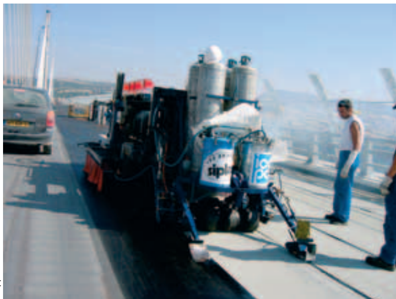
Photo 4 Soudage de l'étanchéité Welding the sealing coat
