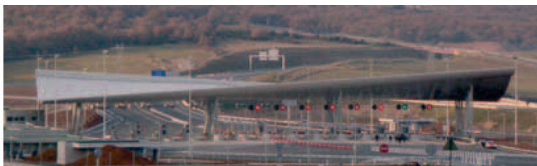
Photo 1 Vue d'ensemble de l'ouvrage Overall view of the structure
