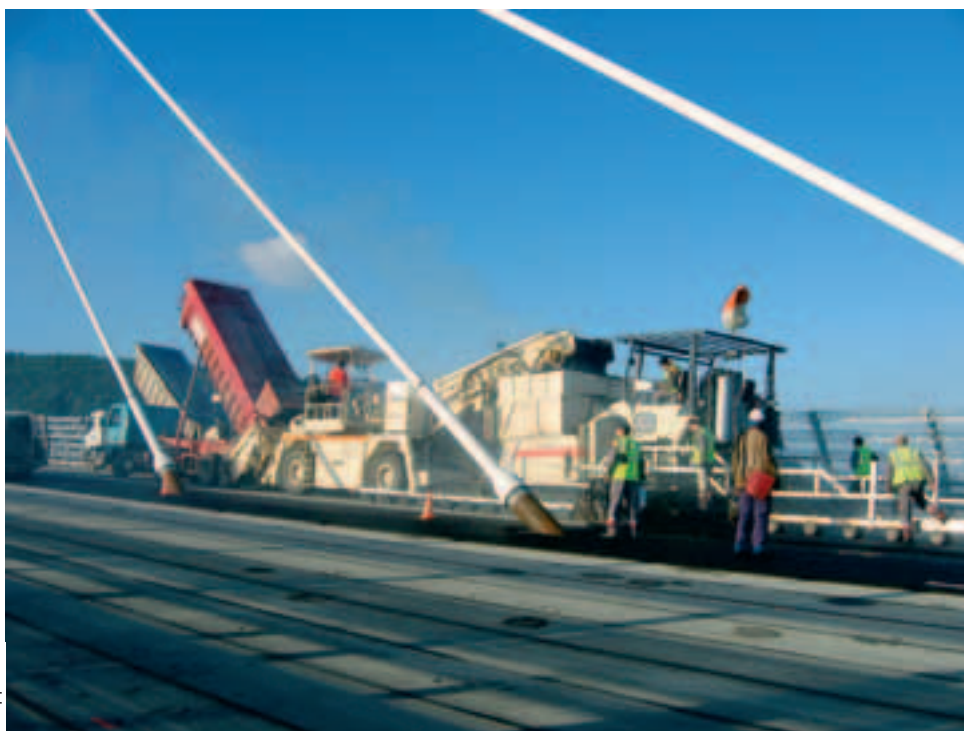
Photo 5 Atelier de mise en œuvre Laying equipment
