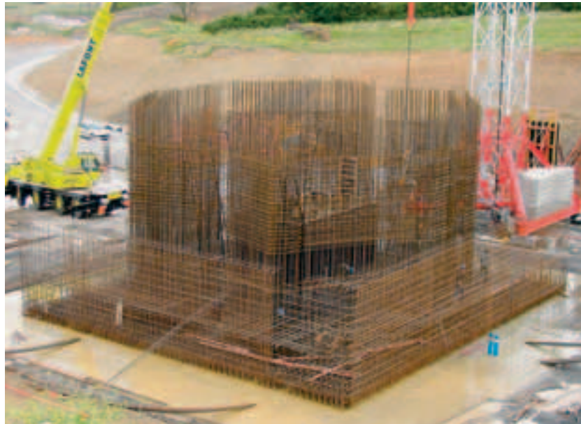
Ferrailage semelle et fût
