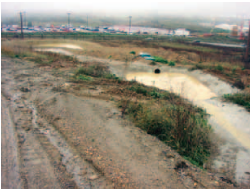
Photo 3 Bassin de décantation des centrales à béton Concrete mixing plant settling pond
