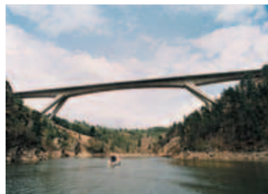
Figure 2 Le viaduc sur la Truyère (Cantal), près du pont de chemin de fer de Garabit. Conception : Europe Etudes Gecti (EEG) et le Centre d'études technique de l'Équipement (CETE) Rhône Alpes. Architecte : Alain Spielmann. Maître d'œuvre : AIOA. Construction : Grands Travaux de Marseille (GTM) et Dumez
