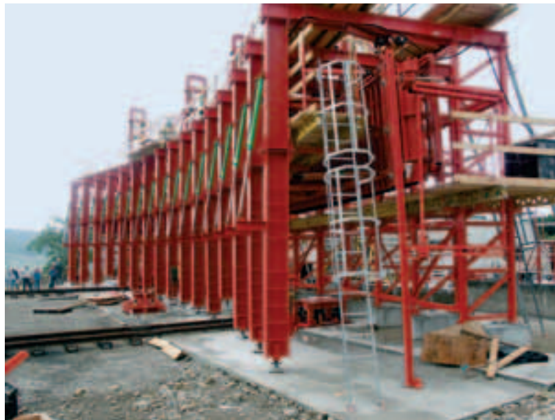
Outil de préfabrication de la toiture de la barrière de péage
