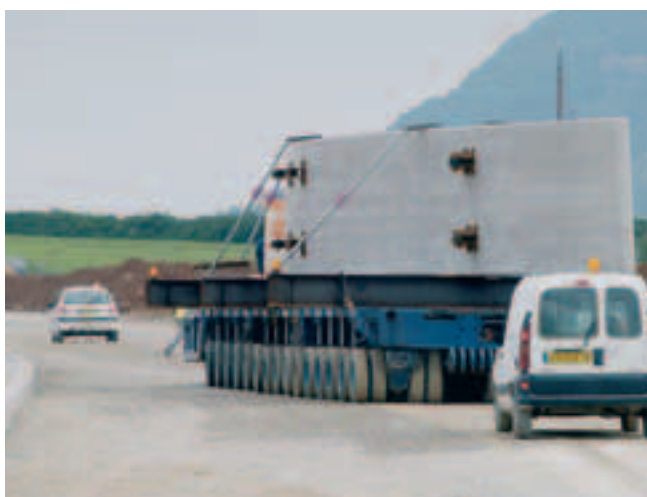
Transport des voussoirs Transporting segments
