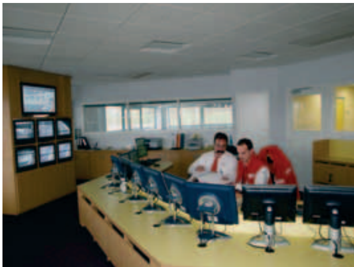
Photo 6 Salle de supervision de la barrière de péage Toll gate supervision room
