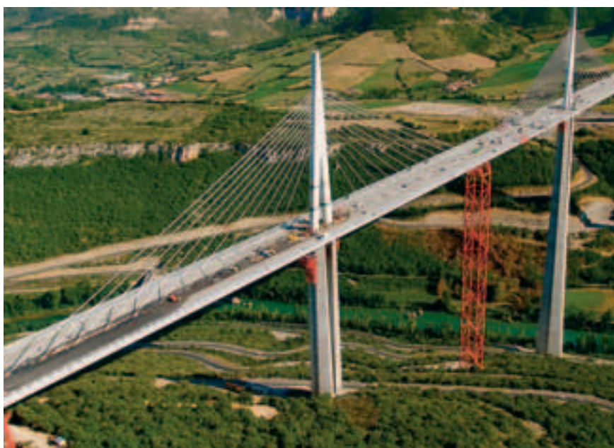
Photo 21 Mise en œuvre des enrobés sur le tablier
