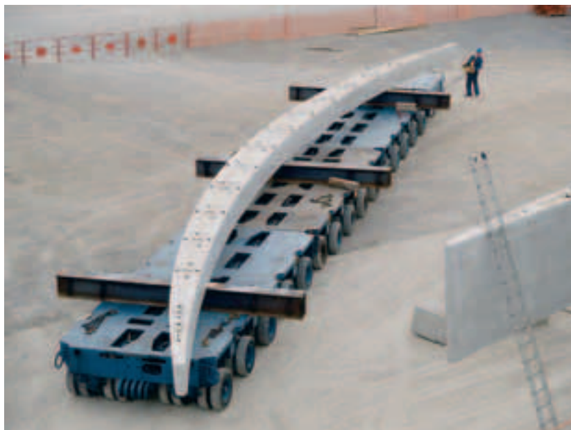
Transport des voussoirs Transporting segments
