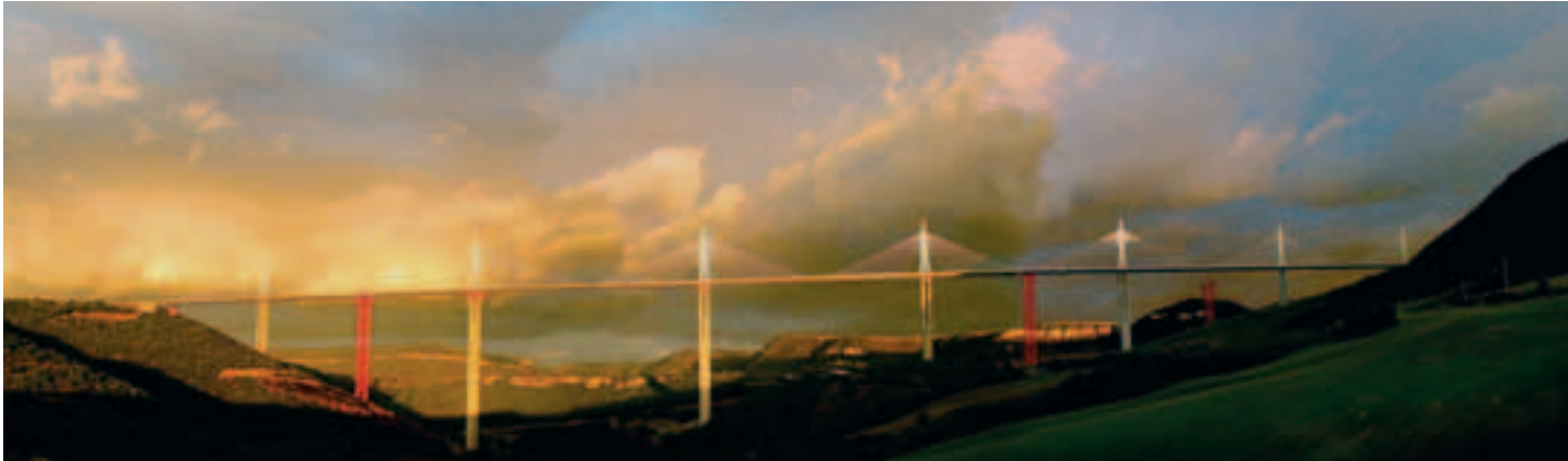
Démontage des palées provisoires Dismantling the temporary bents
