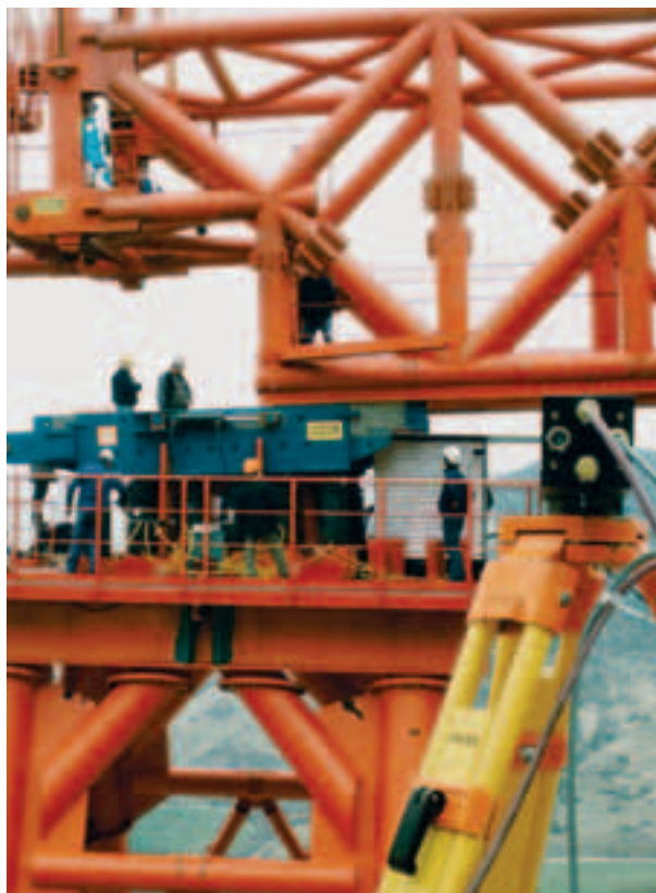
Télémètre laser pour surveillance continue des mouvements transversaux et longitudinaux de la palée pendant lançages Laser telemeter for continuous monitoring of transverse and longitudinal movements of the bent during launching
