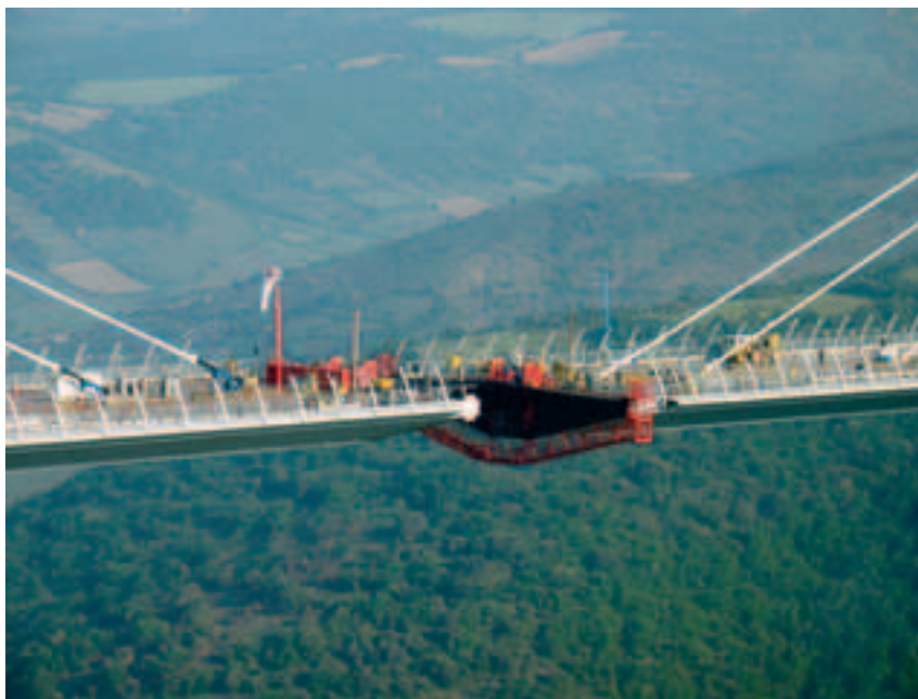
Photo 16 Clavage au-dessus du Tarn
