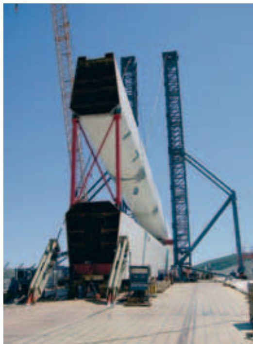
Préparation au levage Preparation for lifting
