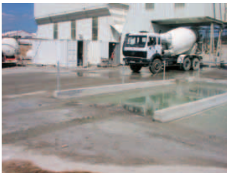
Photo 3 Bassin de décantation des centrales à béton Concrete mixing plant settling pond
