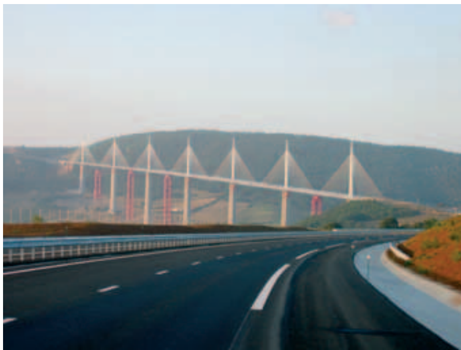
Photo 1 Vue générale du viaduc General view of the viaduct
