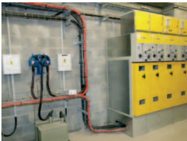
Photo 3 Joint de dilatation par chaîne à câbles
