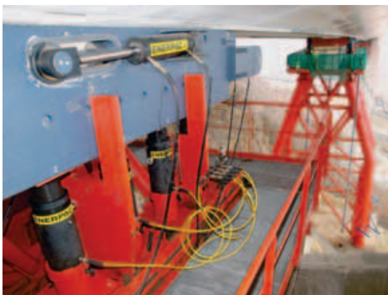
Photo 5 Translateur équipé de son matériel hydraulique Side shifter with its hydraulic equipment
