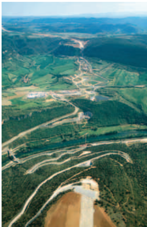
Photo 1 Vue aérienne du chantier Aerial view of the site
