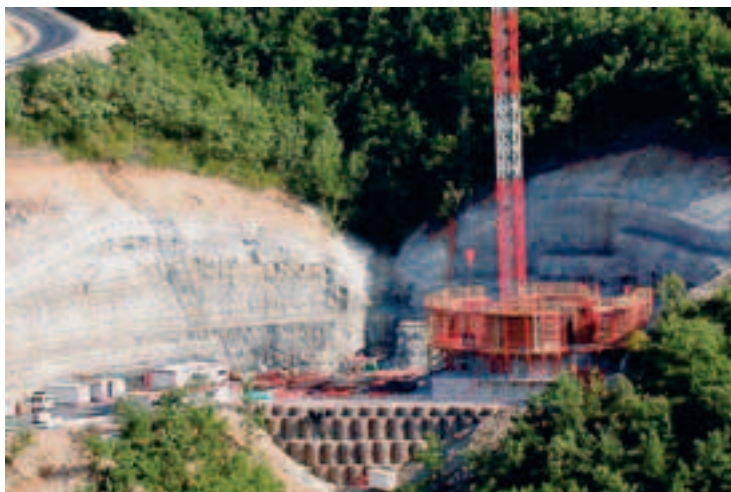
Terrassement P3 avec Tervoile P3 earthworks with Tervoile
