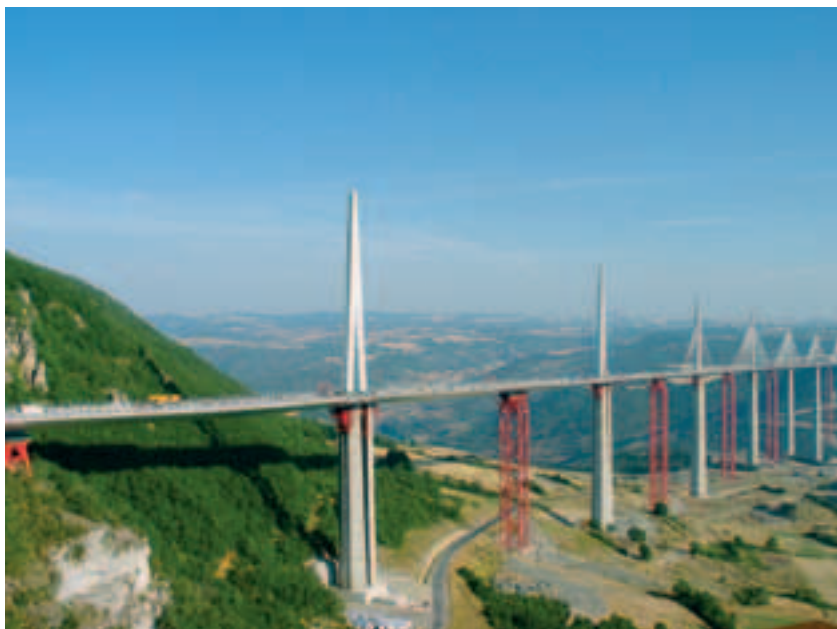
Photo 20 Installation des haubans sur un pylône
