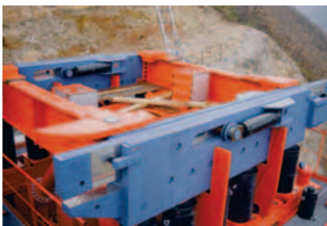
Photo 4 Balancelle : installation de deux balancelles en tête de palée provisoire
