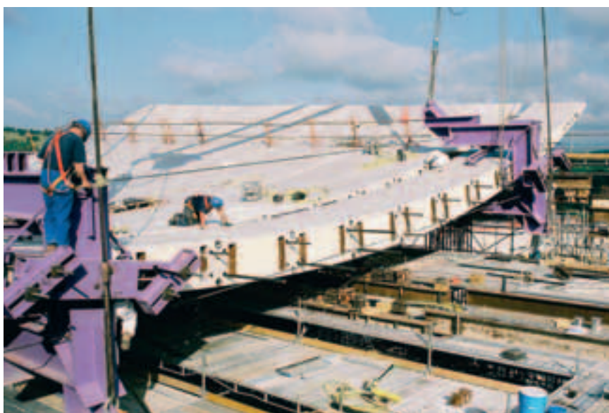
Photo 4 Mise en place d'un voussoir sur le cintre Placing a segment on the centring
