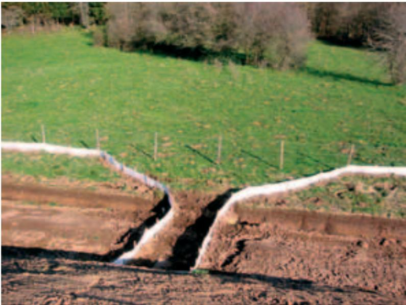
**Pour guider les amphibiens vers les batracoducs un système provisoire associant barrière textile et piquets de géomètre a été mis en place en phase travaux**
