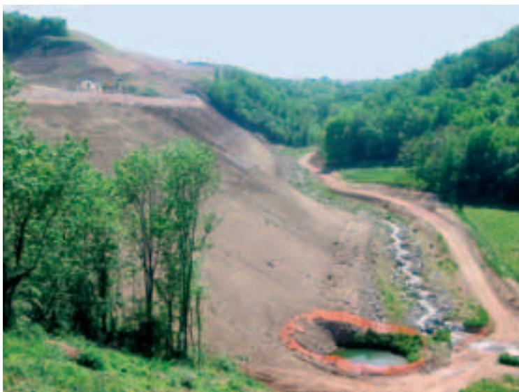
► système provisoire de drainage et d'assainissement destiné à contenir les eaux ruisselant sur l'emprise et donc chargées d'argiles fines. Dans ces vastes bassins, les eaux sont d'abord décan-tées de leurs matières en suspension (MES) puis
