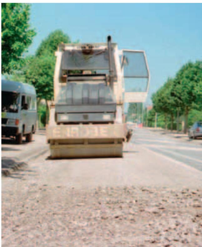
Ensuite, vient l'atelier de compactage, généralement constitué d'un cylindre V3 (photo 6) suivi d'un compacteur de 21 t.
