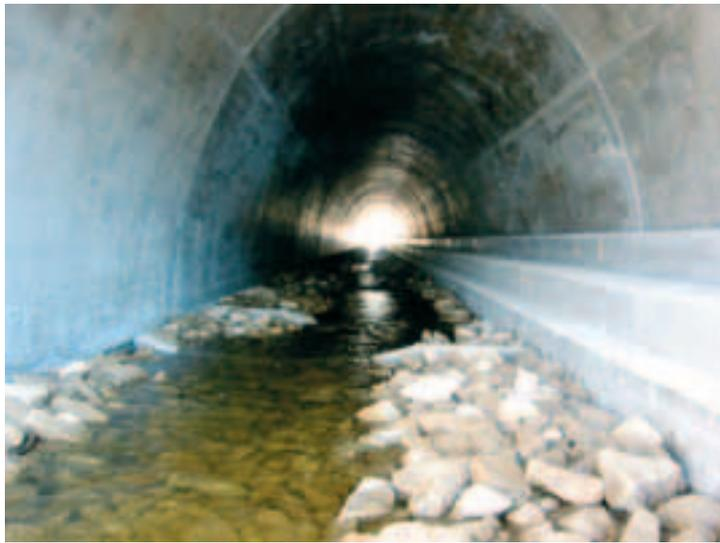
Pour permettre aux loutres de remonter le ruisseau de l'Ambène le passage inférieur du cours d'eau est équipé de marches sur un côté
