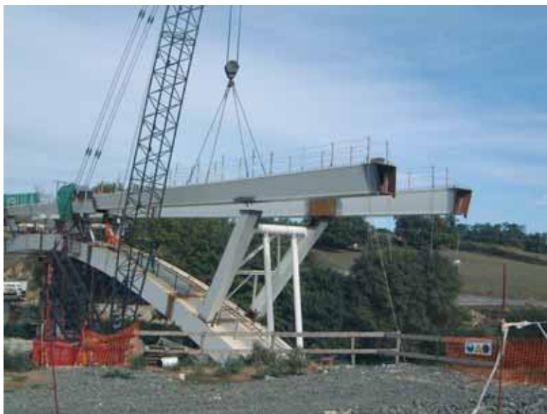
Photo 4 Montage du caisson T4 Erection of box section T4
