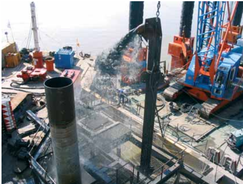
Forage d'un pieu au trépan émulseur Drilling a pile with an emulsion drilling bit
