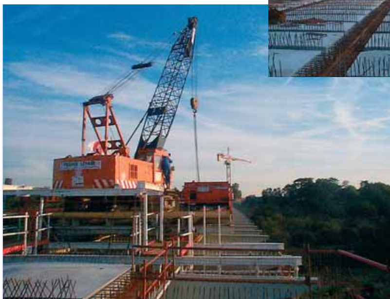
Photos 14 et 15 Mise en place des éléments de dalle préfabriqués
