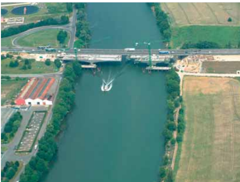
Photo 2 Vue aérienne Aerial view
