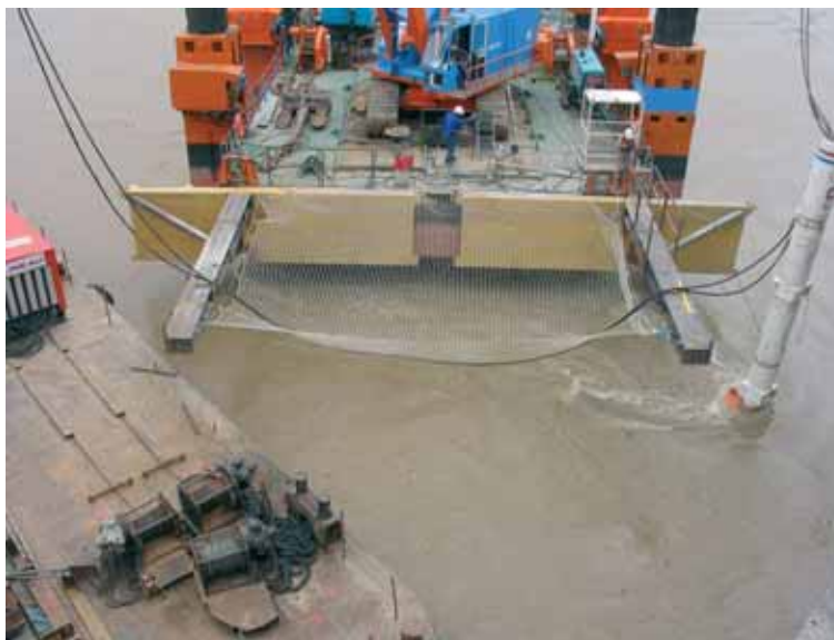
Battage d'un pieu au mouton hydraulique IHC S70
