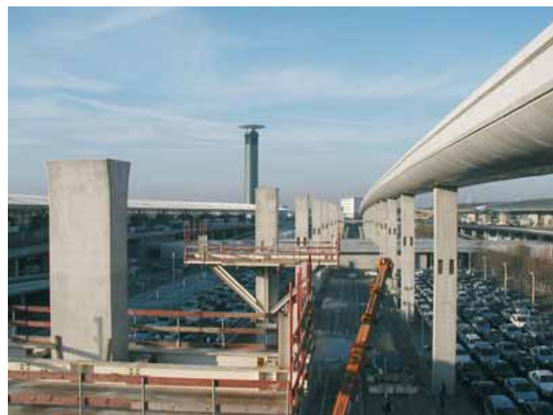
Photo 2 Le viaduc nord terminé, le viaduc sud en cours de réalisation
