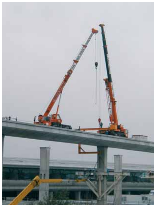
Photo 7 Dépose des mêmes consoles Removal of the same cantilevered beams
