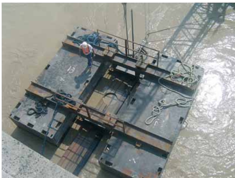
Mise en place de la poutre. Aperçu de l'extrémité de la poutre maintenue en semi-immersion par les flotteurs catamarans
