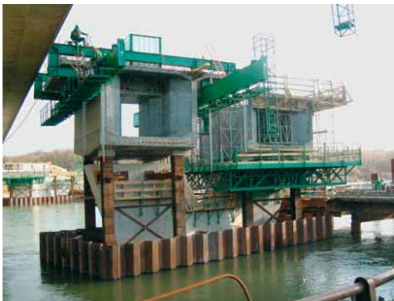
Photo 3 Voussoir sur pile - Equipage mobile
