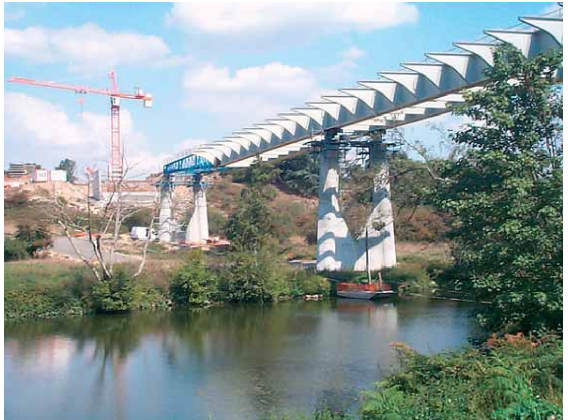
Photo 11 L'ouvrage en cours de lancement The structure during launching
