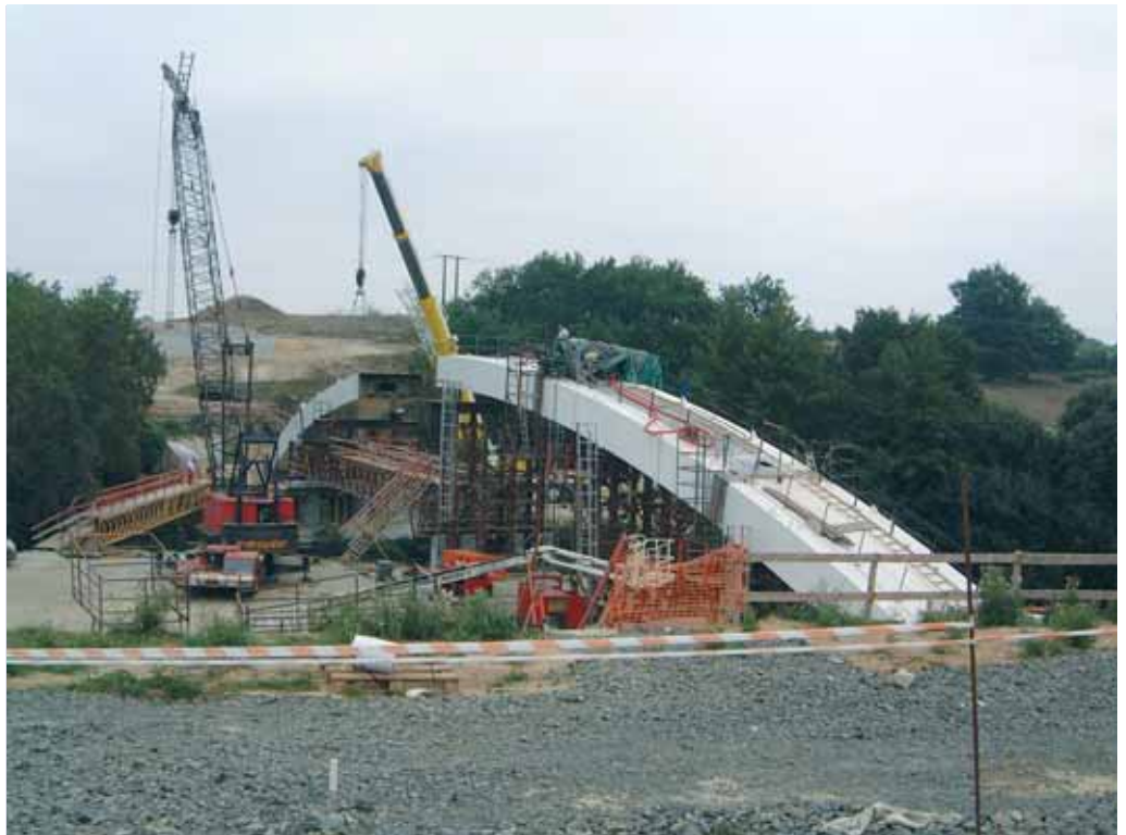
Photo 2 Montage de l'arc A2 Erection of arc A2
