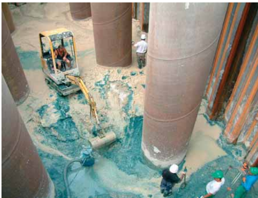
Photo 1 Terrassements dans batardeau Earthworks in cofferdam
