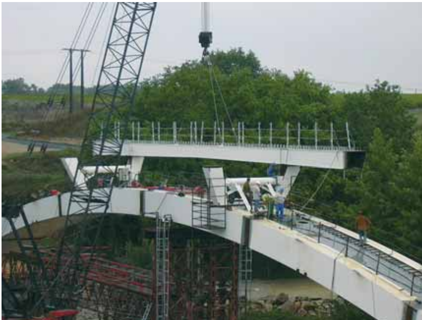
Photo 3 Montage du caisson T3 Erection of box section T3
