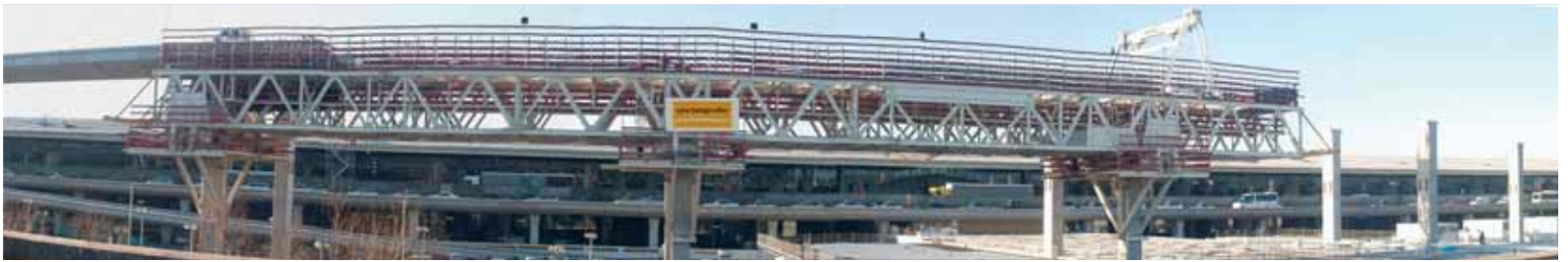
Photo 3 Le cintre une fois calé The centre after wedging
