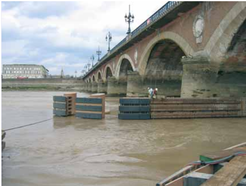
Vue d'ensemble de la poutre posée
