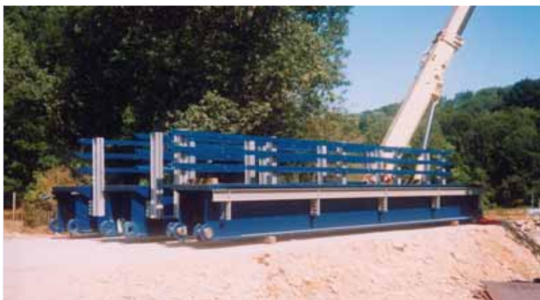
Photo 1 Vue générale des caissons. Appui et barre Dywidag en partie haute. Axe-rotule en partie basse (femelle d'un côté - mâle de l'autre)
