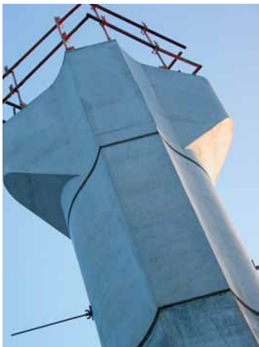
Photo 3 Vue de la tête de pile View of the pier head
