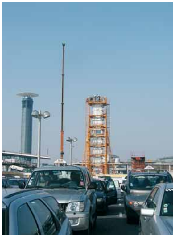
Photo 1 Coffrage de pile au milieu du parking taxis
