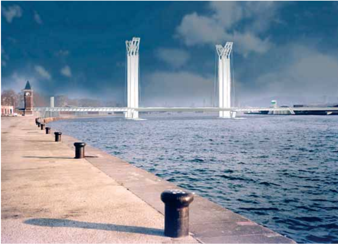
Figure 1 Vue d'ensemble General view
