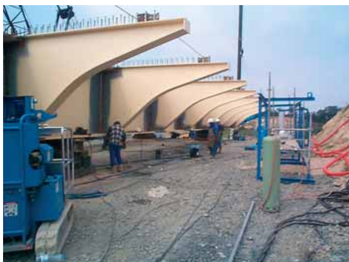
Photo 8 Consoles en cours d'assemblage au chantier Cantilevered beams in course of assembly on the construction site
