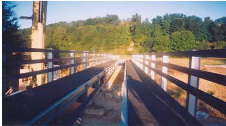
Photo 4 Pose des poutres sur appuis par grutage Laying girders on supports by craning
