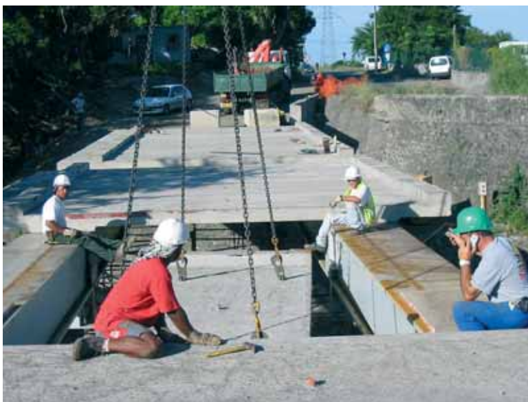
Photo 6 Pose de dalles préfabriquées Laying prefabricated slabs
