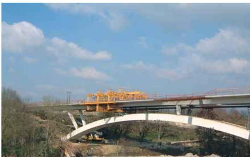
Photo 5 Bétonnage du hourdis Deck section concreting
