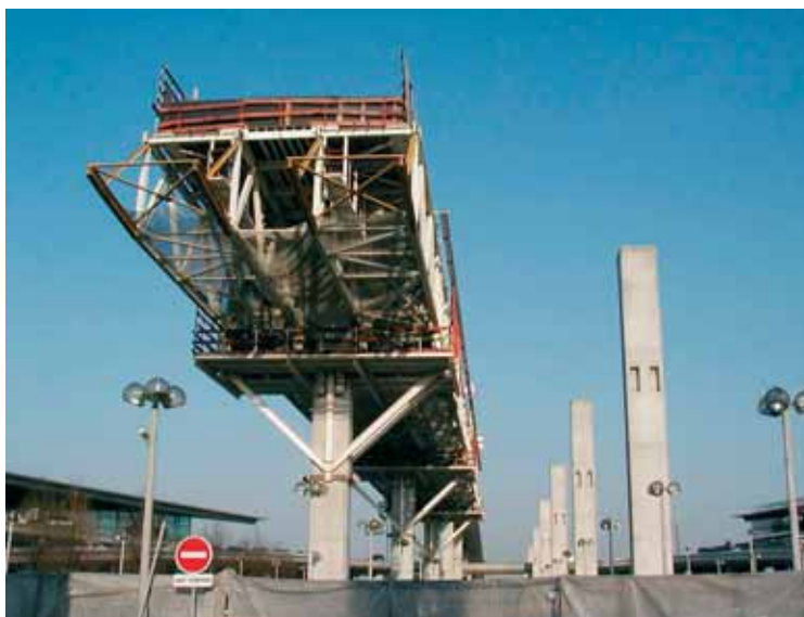
Photo 5 Travaux en cours Work in progress
