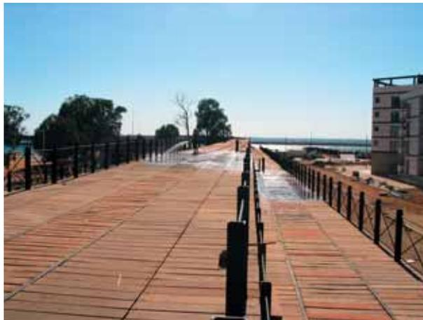
Les dalles du plancher mesurent 0,20 m de large et 1,10 m de long, pour une épaisseur variant de 40 mm à 70 mm en fonction de leur emplacement
