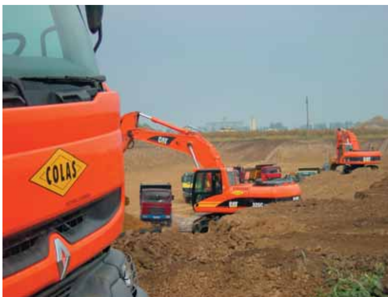
Photo 3 Terrassement dans un emprunt de loëss Earthworks in loess borrow material
