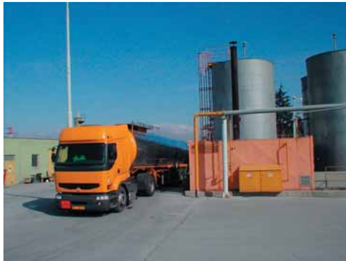
Soutirage des émulsions
