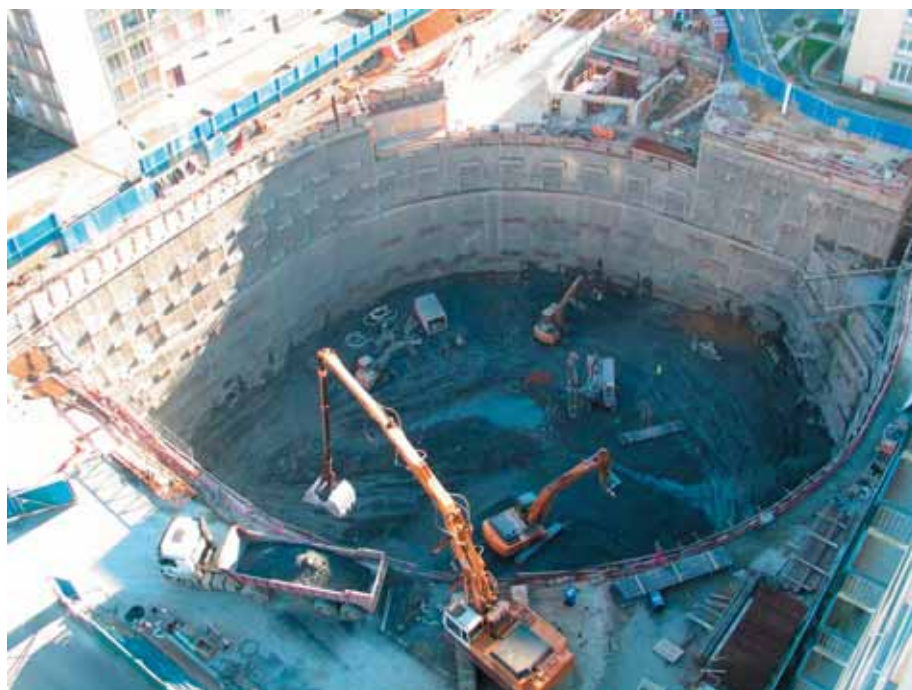
Photo 8 Terrassements en grande masse. Les terres sont chargées et évacuées depuis le haut de la plateforme ce qui limite fortement les salissures de voiries
