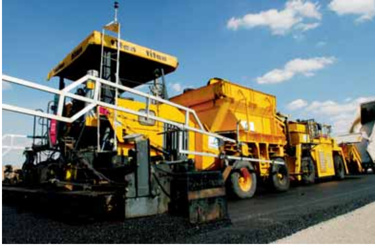
Photo 7 Système de guidage DPS : mât récepteur équipé d'un prisme monté sur le finisseur
