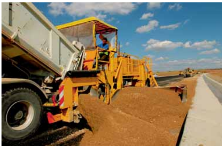
Photo 2 Mise en œuvre de matériaux en accotement : emploi de l'épandeur latéral Dupire Laying materials on the road shoulder : use of the Dupire side spreader
