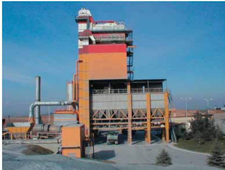
Une centrale d'enrobage mobile + une stationnaire
