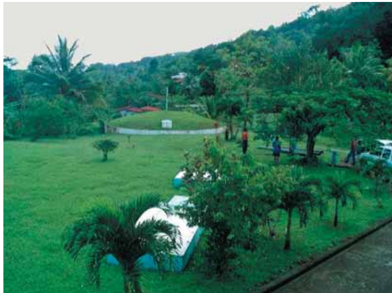
Photo 2 Le réservoir Durand correspond au type de réservoir le plus répandu. C'est un ouvrage en béton armé, circulaire, à coupole, de 1 000 m 3
