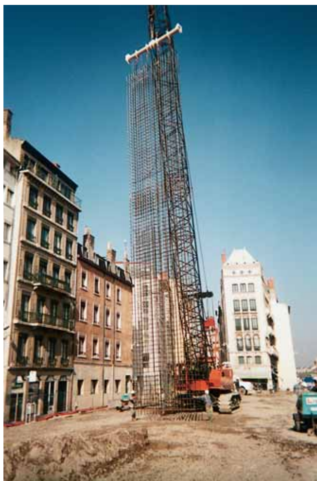
Photo 2 Equipement des panneaux de paroi moulée avec des armatures de 25 m de hauteur
