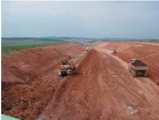
Déblais - Profondeur 18 m près du secteur de Letkov Earth cuts - Depth of 18 metres near the Letkov sector
