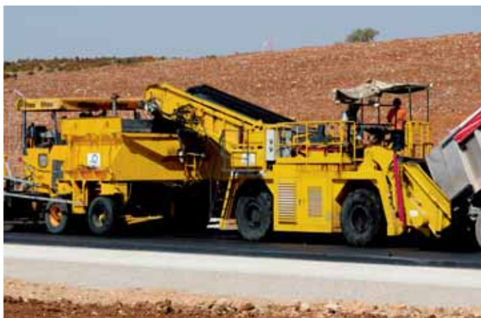
Photos 5 et 6 Vues d'ensemble de l'atelier de mise en œuvre (finisseur ABG et alimentateur Franex) sur section courante
