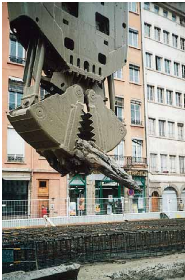
Photo 3 Remontée de la base d'un pieu en bois
