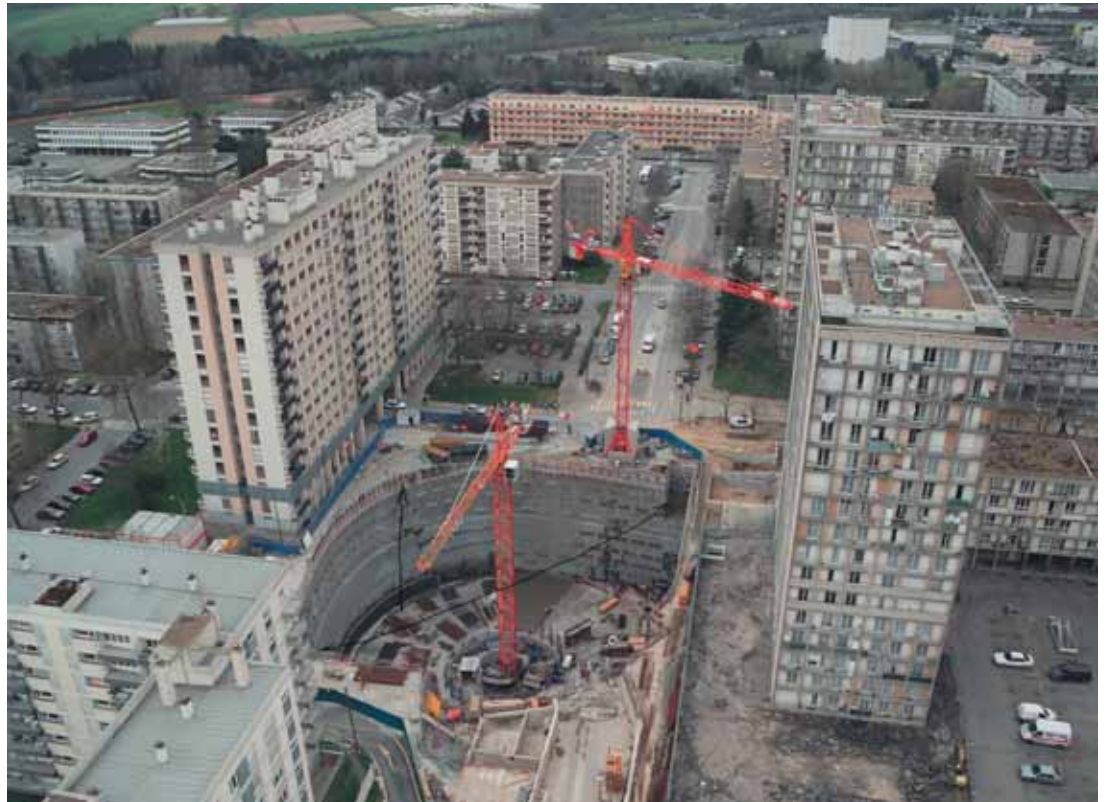
Photo 1 Une fouille de 50 m de diamètre pour 25 m de profondeur aux pieds d'immeubles R + 7 à R + 15 An excavation 50 metres in diameter and 25 metres deep at the base of eight- and sixteen-storey buildings
