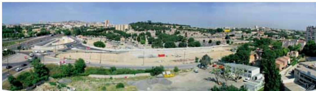
Démarrage des travaux de l'échangeur Florian Start of work on the Florian interchange
