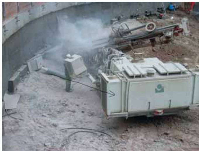
Photo 3 Isolation phonique des machines de forage grâce à des caissons
