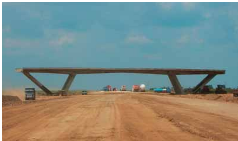
Photo 2 Passage supérieur Overpass
