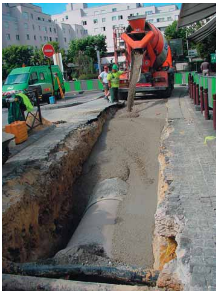
Photo 1 Mise en œuvre du remblai auto-compactant Laying the self-compacting backfill
