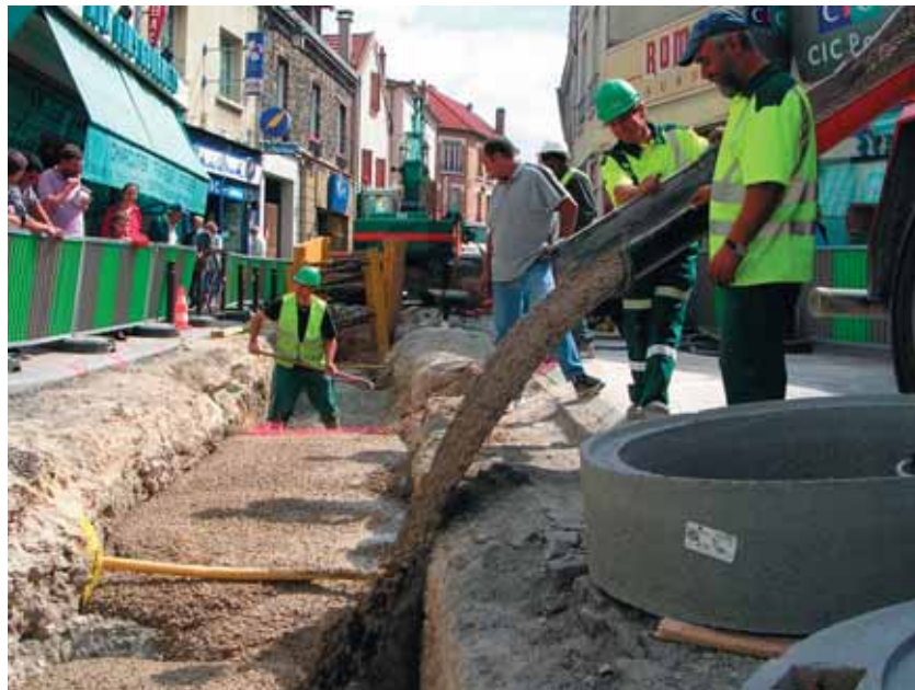
Photo 2 Un chantier à proximité des commerces A construction site close to shops
