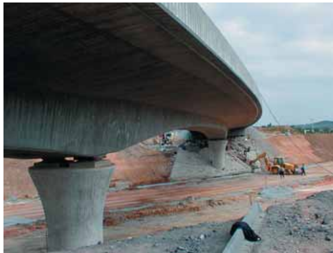
Ouvrage d'art n° 209 - Passage supérieur
