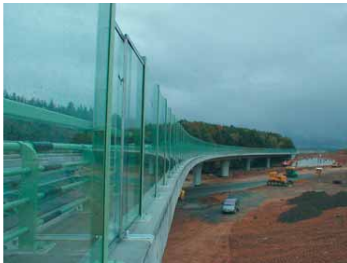
Ouvrage d'art n° 206 - Intersection Cernice Nord
