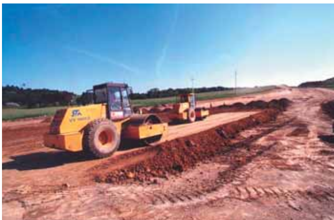
Compactage - Secteur de la rivière d'Uslava Compaction - Uslava River sector
