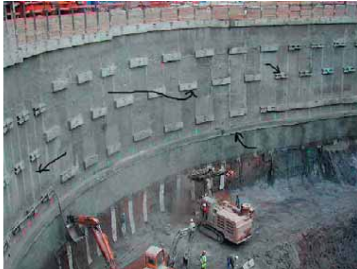
Photo 2 La structure de la paroi microberlinoise
