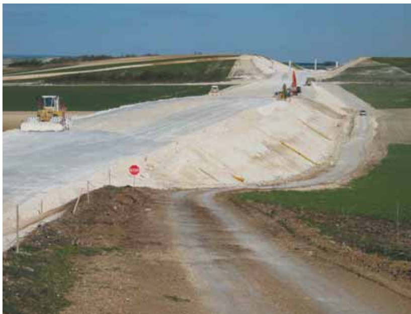
Photo 3 Déblai n° 24526, extraction des sables gris vert Earth cut No. 24526, extraction of grey-green sands
