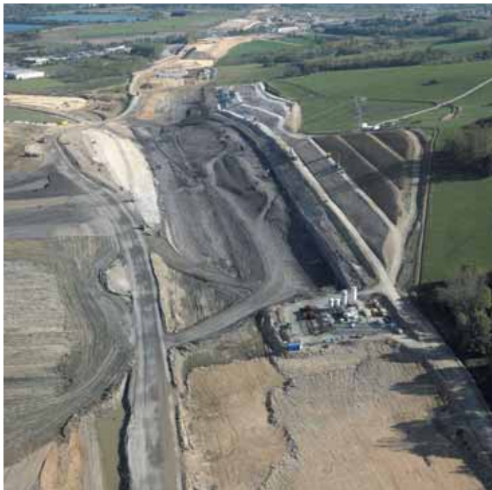
Photo 8 Remblaiement de la purge en cours Backfilling of the drainage system in progress
