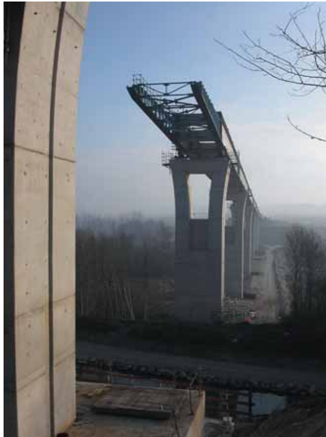
Vue depuis le canal de l'Ourcq - Lancement du tablier en cours
