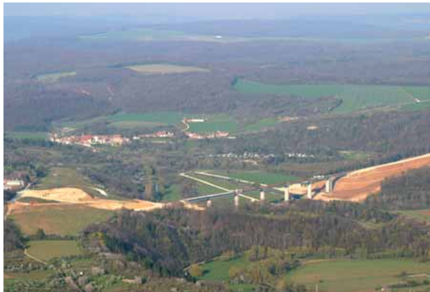
Photo 7 Viaduc de Jaulny Jaulny viaduct
