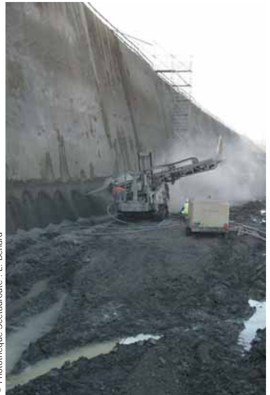
Photo 7 Réalisation du mur cloué Construction of the soil-nailed wall
