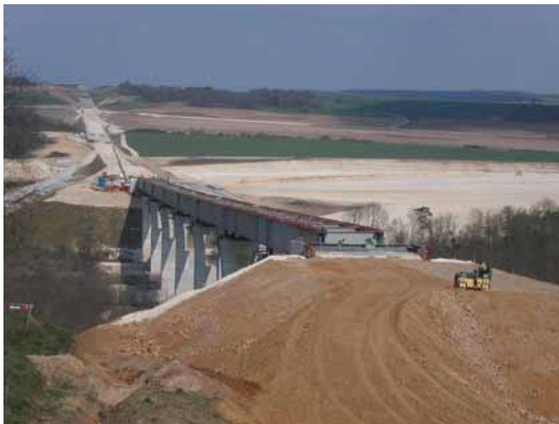
Vue depuis la culée ouest - Tablier lancé
