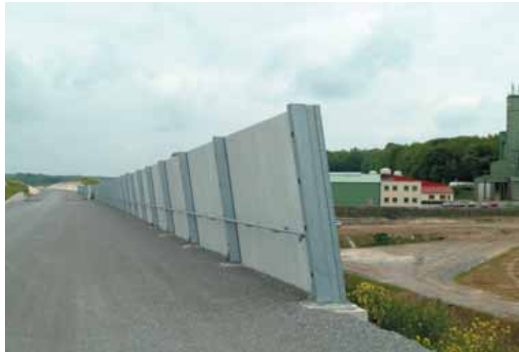
Photo 6 Mur antibruit au niveau de la ferme de la Cense (77)
