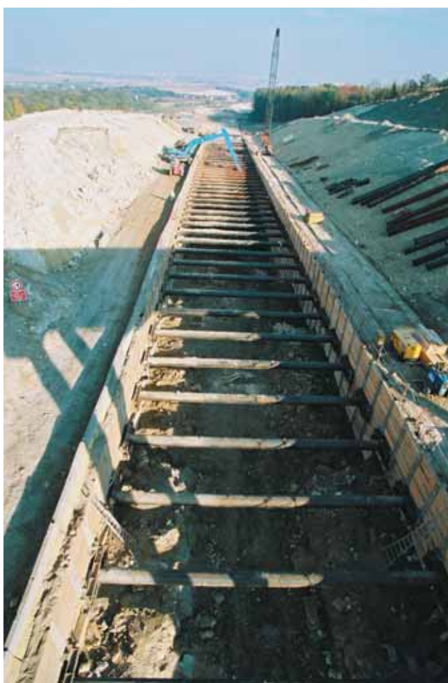
Photo 2 Terrassements de la tranchée ouverte Open cutting earthworks
