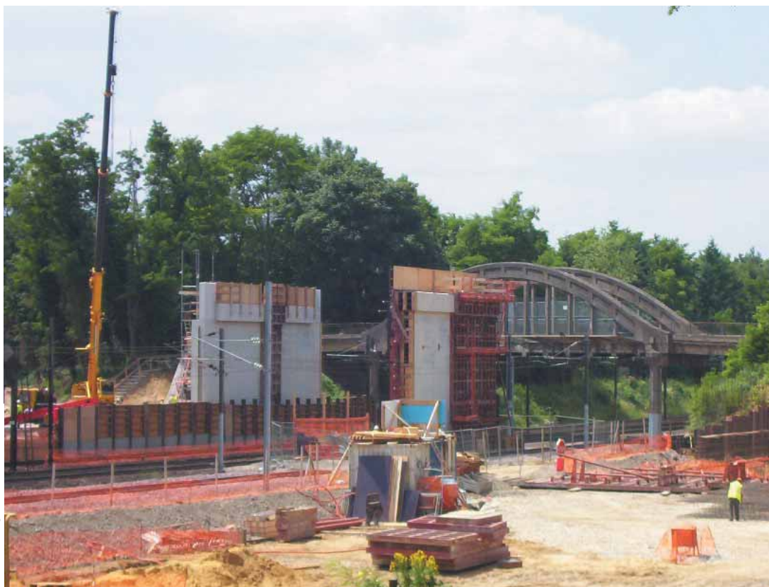
Photo 8 Construction des appuis du nouveau pont-route devant l'ancien ouvrage
