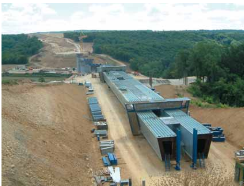
Photo 1 Déblai ouest et installation d'assemblage et de poussage
