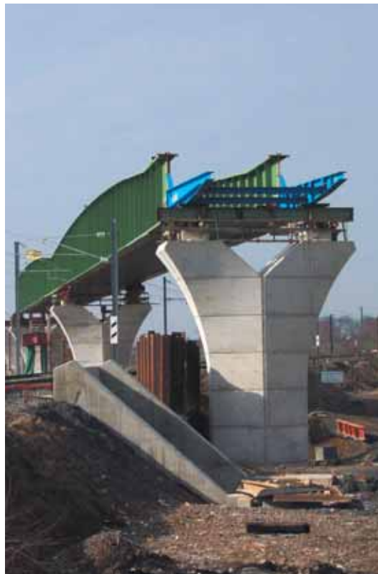
Photo 2 Le viaduc de Baudrecourt
