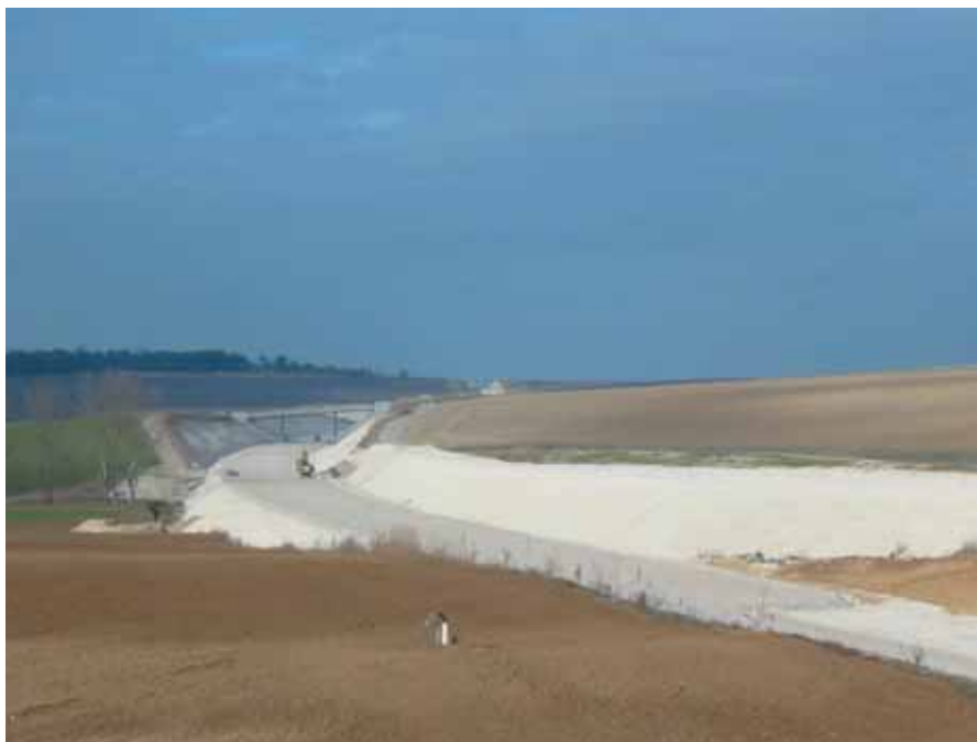
Photo 3 Terrassement en cours
