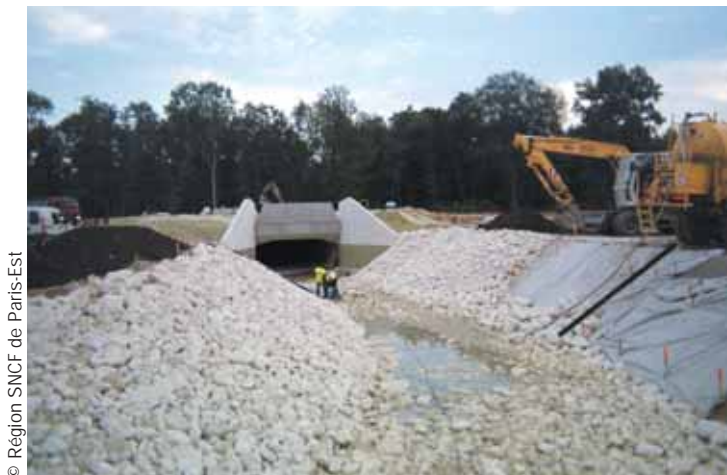
Photo 5 Le revêtement de la dérivation définitive du nouveau ru du Gué de l'Aulnay (enrochement de 10 à 100 kg), avec une section hydraulique
