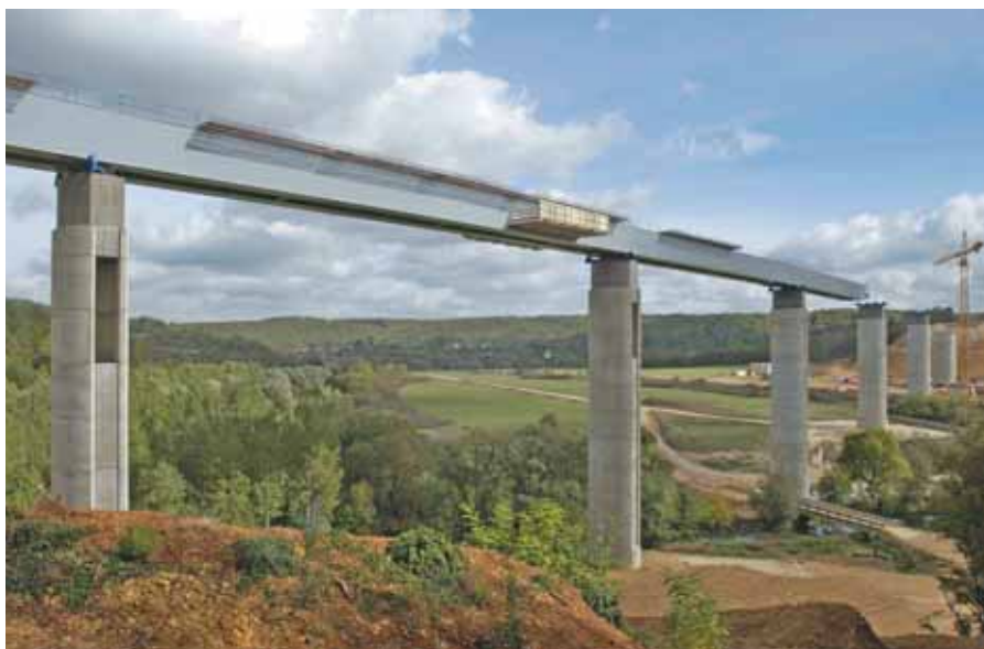
Photo 6 Vue d'ensemble et équipement mobile sur CO Overall view and mobile rig on CO
