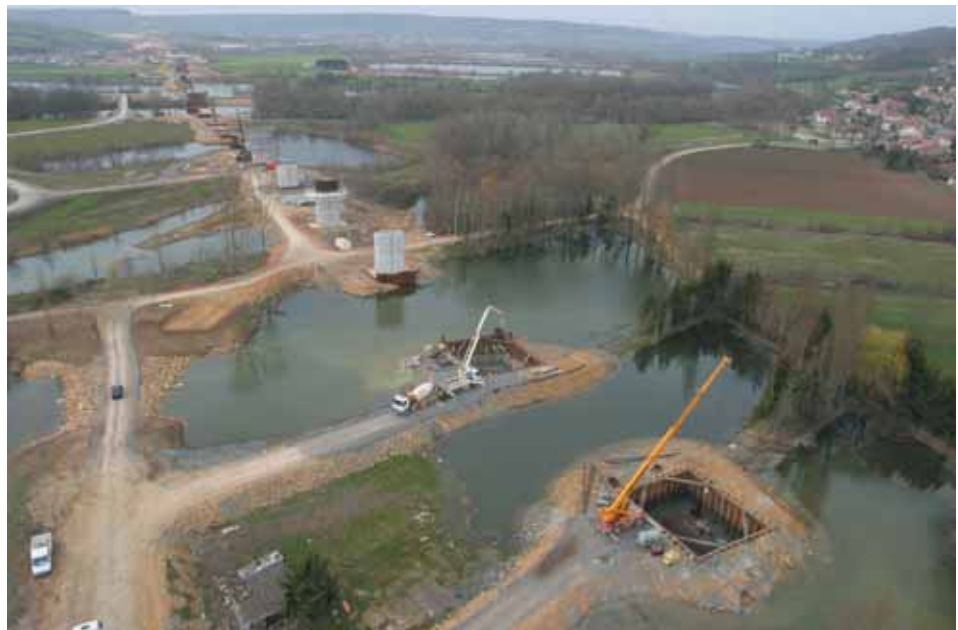
Photo 1 Réalisation des appuis du viaduc de la Moselle Construction of the supports for the Moselle viaduct
