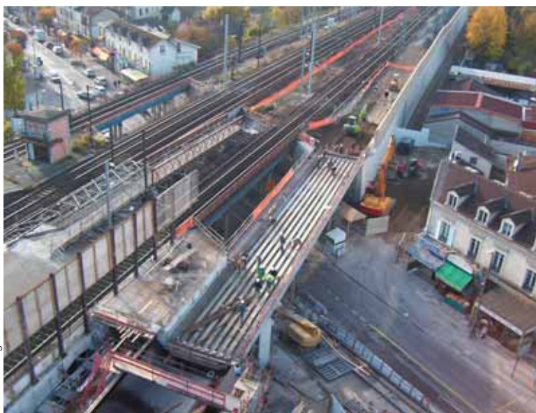
Photo 4 Chelles : le nouveau pont-rail construit dans le prolongement du mur de soutènement
