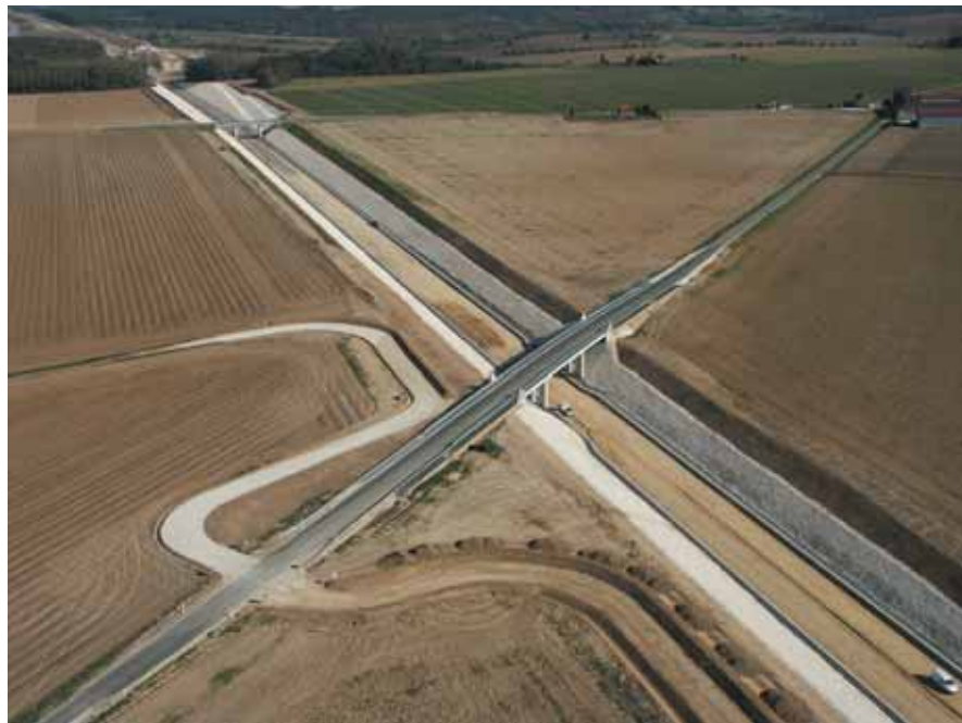
Franchissement de la RD 320 aux environs de Château-Thierry
