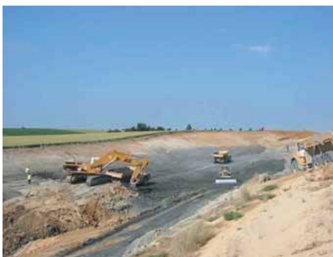
Photo 3 Déblai n° 24526, extraction des sables gris vert Earth cut No. 24526, extraction of grey-green sands
