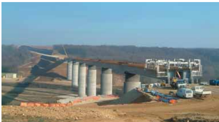
Photo 5 Dispositif de protection au-dessus de la voie ferrée en service
