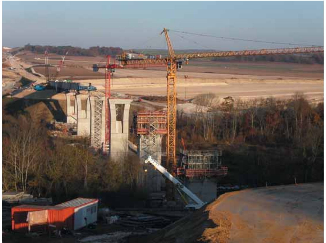
Vue depuis la culée ouest - Construction des piles et début du lancement
