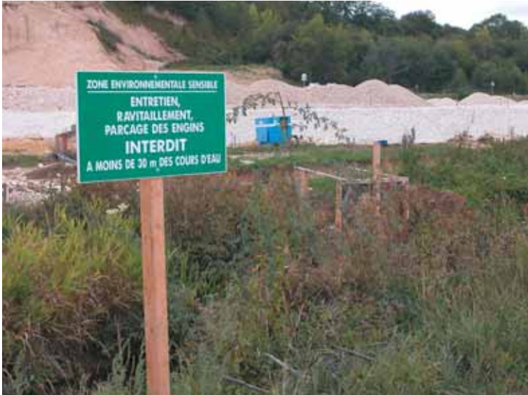
Photo 16 Identification sur le chantier des zones sensibles Identification of sensitive areas on the site
