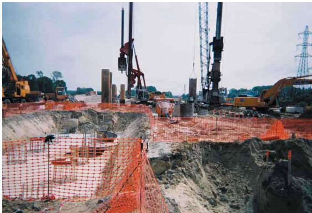
Photo 8 Vue des ateliers de forage mobilisés sur l'emprise du saut-de-mouton 10.120 avec les tubages provisoires pour la réalisation des 237 pieux sans utilisation de la boue bentonique
