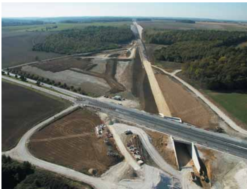
Franchissement de la RD1 à Château-Thierry
