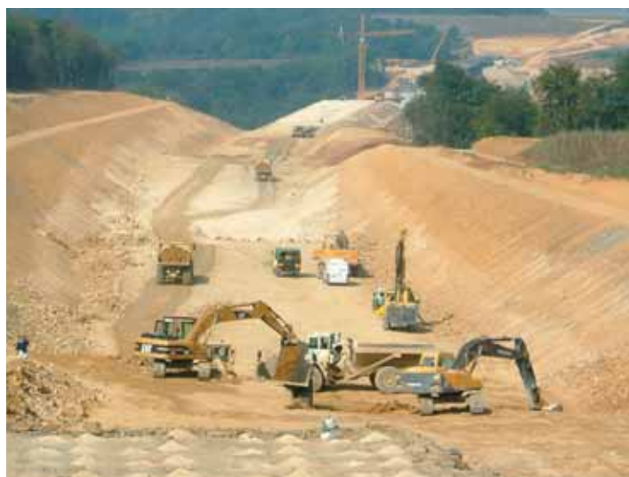
Photo 3 Déblai. Remblai Est Earth cut. Eastern backfill
