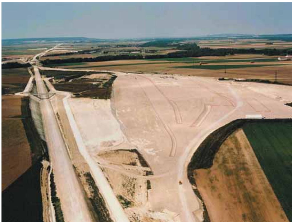
Photo 1 Vue aérienne de la base travaux d'équipements ferroviaires
