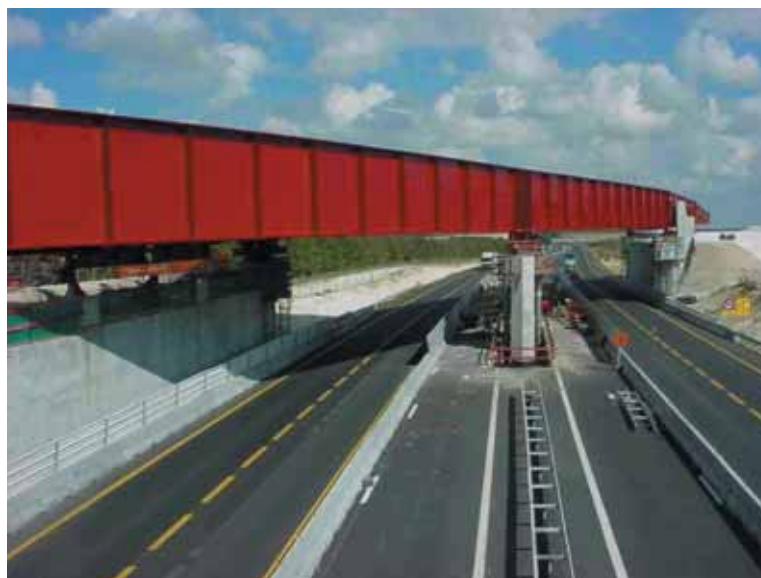
Photo 8 Viaduc sur l'A4 à Bussy-le-Château en fin de lancement
