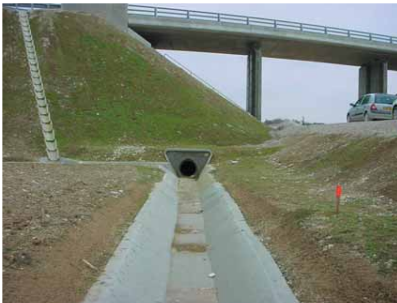
Photo 5 Ouvrages d'assainissement Drainage structures
