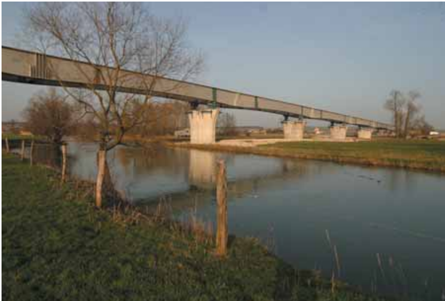
Photo 4 Viaduc de franchissement de la Meuse
