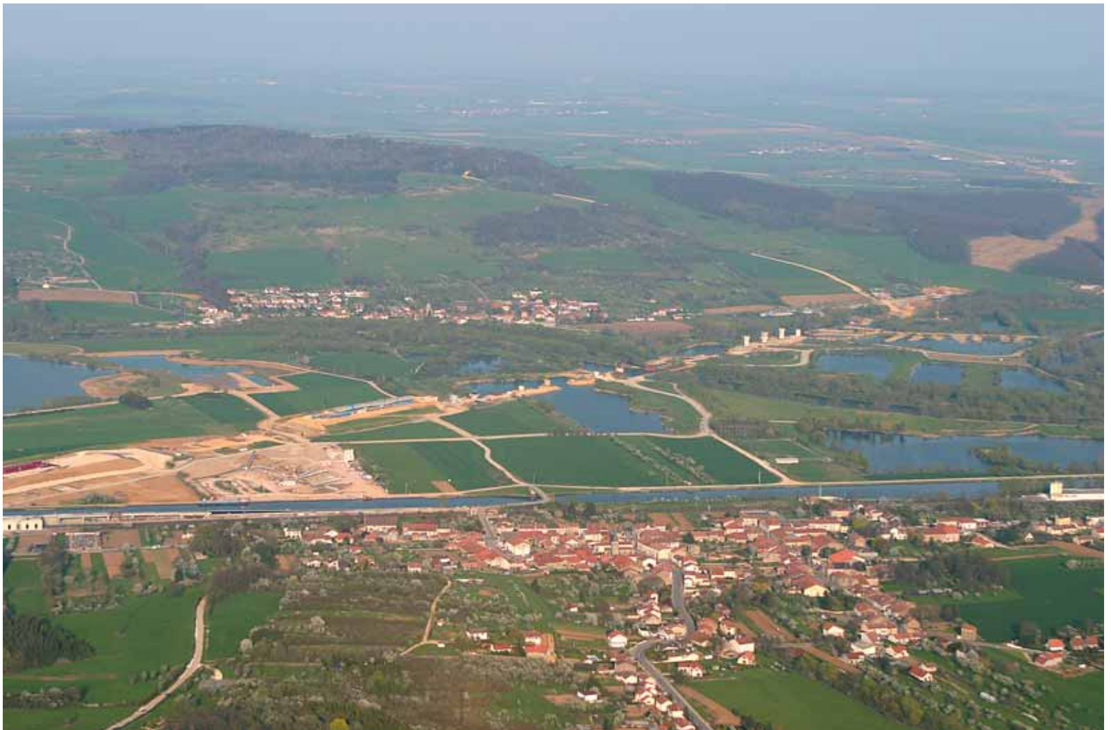
Franchissement de la vallée de la Moselle (57) Passage through Moselle Valley
