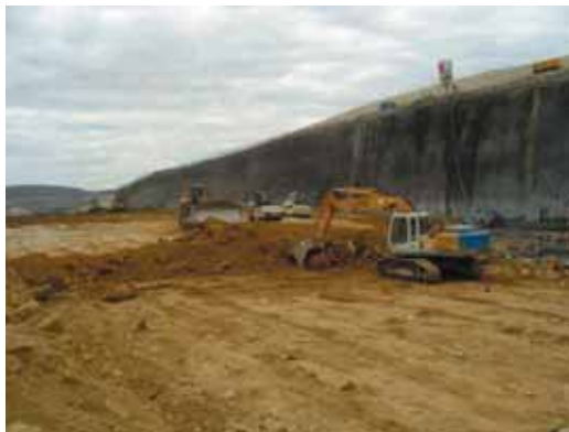
Photo 8 Remblaiement de la purge en cours Backfilling of the drainage system in progress
