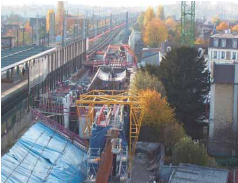
Photo 5 Coffrage de la nouvelle structure porteuse du bâtiment voyageurs de Chelles
