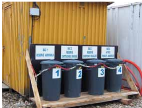
Photo 11 Tri sélectif des déchets de chantier Selective sorting of site wastes
