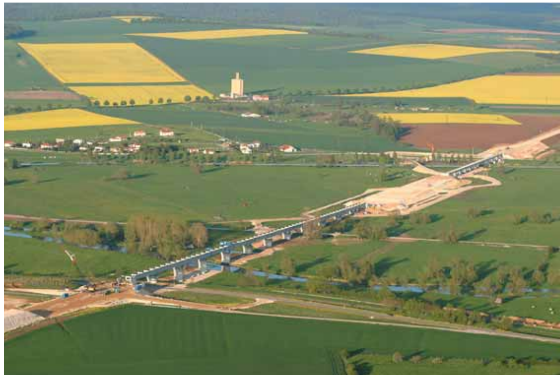
Photo 1 Vue générale du viaduc de la Meuse General view of the Meuse viaduct
