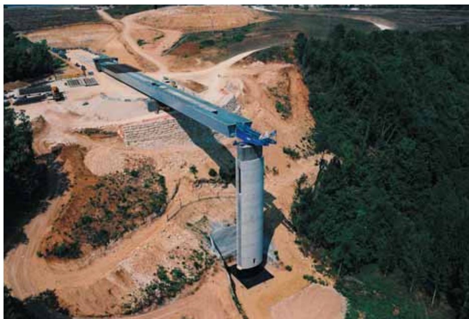
Photo 2 Mur de soutènement en enrochements. Talus ouest. Pile P1 avec paroi clouée. Premier lancement en cours
