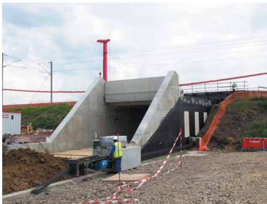
Photo 3 L'ouvrage foncé sous la voie ferrée existante
