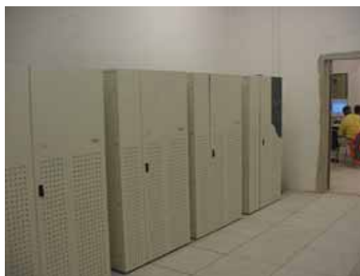
Photo 1 Alimentation de secours par onduleur de 120 kVA avec une autonomie de fonctionnement d'une heure
