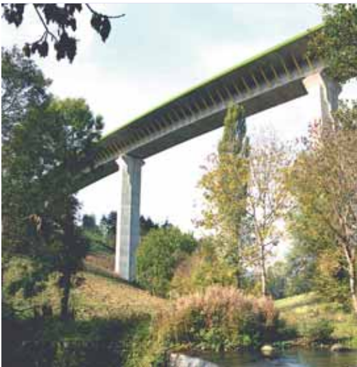
Figures 3 et 4 Les viaducs du Piou et du Rioulong (Lozère). Conception : bureaux d'études Secoa, Sofresid et SEE. Architecte : Philippe Fraleu. Maître d'œuvre : AIOA. Construction : Quillery
