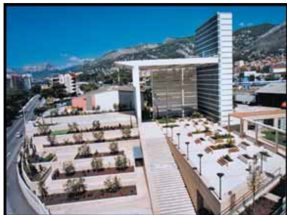
Photo 3 Ensemble de l'unité de ventilation Entire ventilation unit
