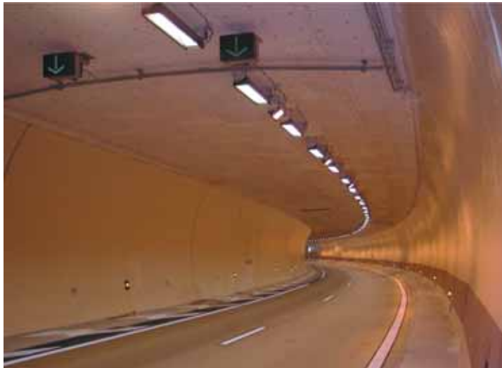
Ouvrage terminé avec les protections en plafond Completed structure with protection on the ceiling
