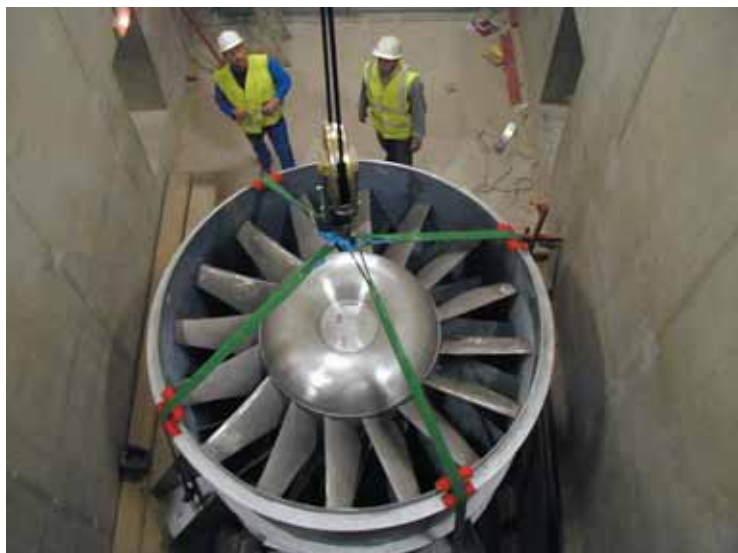
Manutention pour la mise en œuvre d'un ventilateur d'air frais (ventilation principale)
