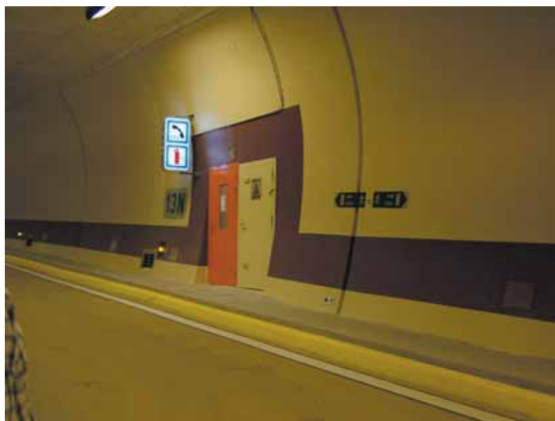
Traitement architectural des niches de sécurité
