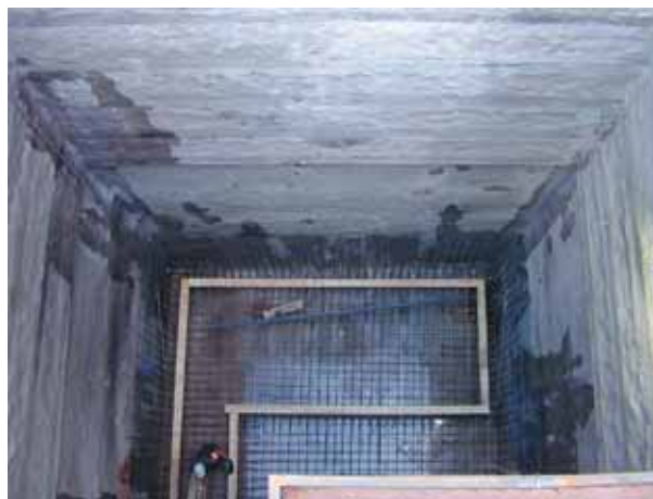
Photo 3 Réalisation d'un escalier de secours supplémentaire
