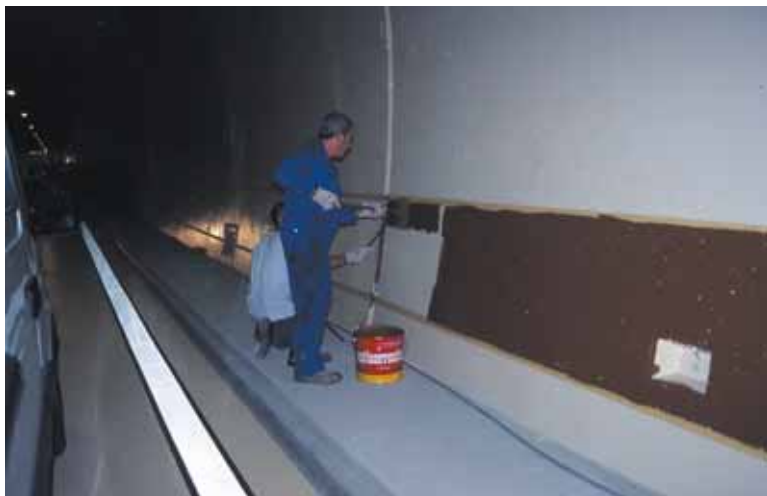
Photo 2 Mise en œuvre manuelle de l'animation colorée Manual application of the coloured animation
