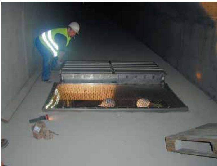
Pose des trappes de désenfumage Installation of smoke hatches
