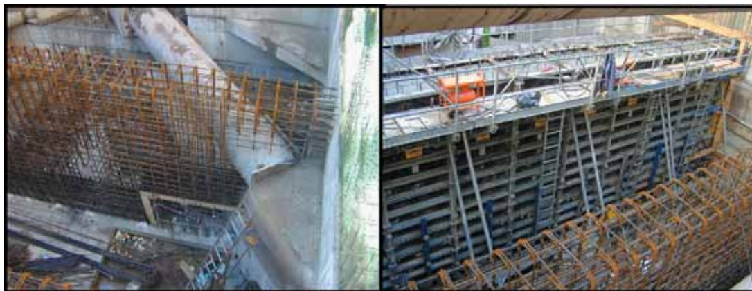
Photo 2 Réalisation des poutres du niveau - 4,01 Construction of girders at level - 4.01 m
