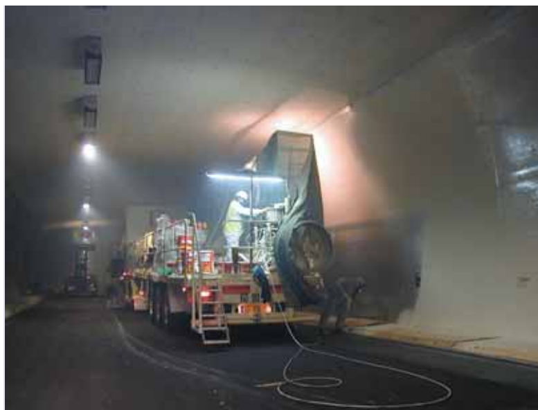
Photo 1 Atelier mobile de mise en peinture des piédroits
