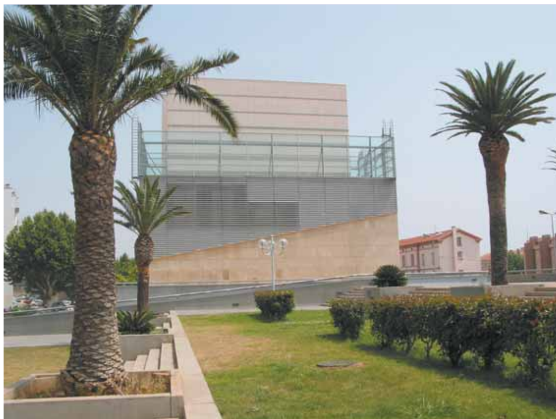
L'unité de ventilation Castigneanu terminée The completed Castigneanu ventilation unit
