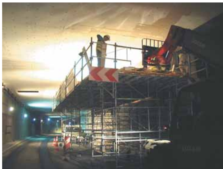
Pose du revêtement de protection incendie
