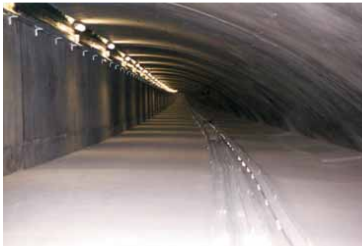
Intérieur de la gaine d'air frais Interior of the fresh air duct
