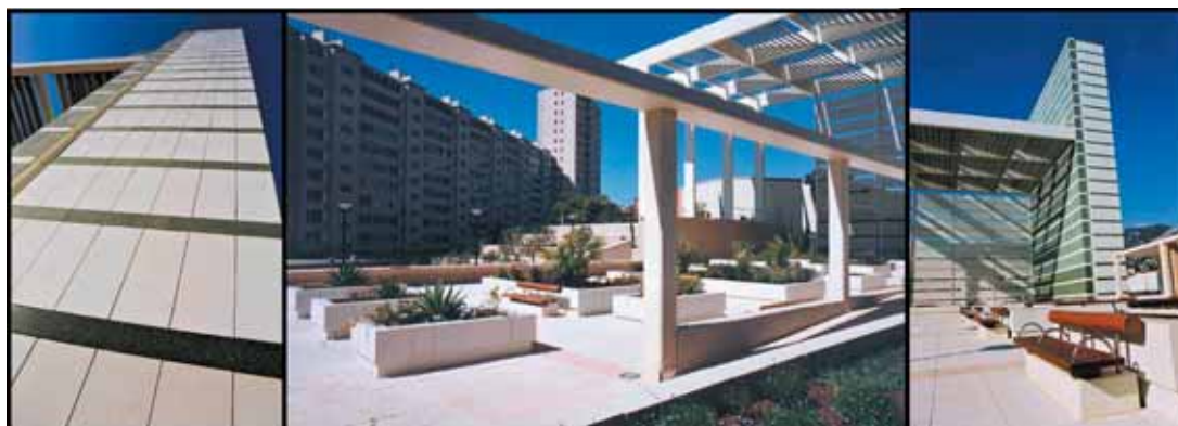
Photo 4 Détails de l'unité de ventilation Ventilation unit details
