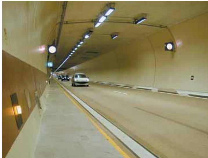
Le tunnel sous circulation
