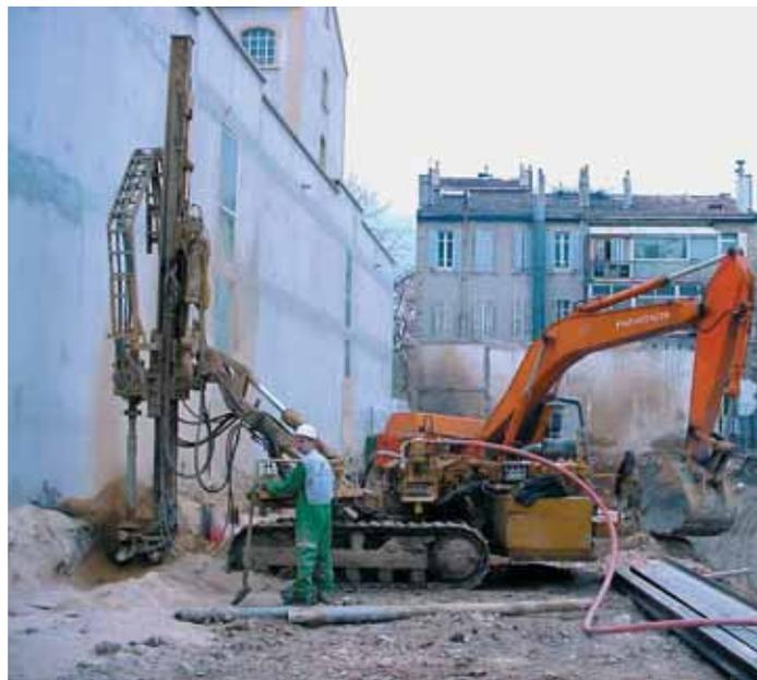
Les profilés HEB de 8 m constituant la paroi de 212 ml, sont scellés dans le terrain et espacés de 1,50 m sur la périphérie du parking. Une excavation de 6 m de profondeur par rapport au terrain naturel, est exécutée en suivant par passes de 2 m de hauteur, au droit des profilés HEB. Confronté à un terrain dur (marno-calcaire), à très dur, le terrassement (exécuté par l'entreprise Fi-
