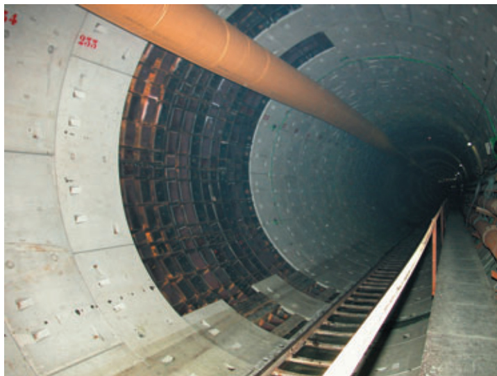
Photo 7 Segments métalliques utilisés pour la réalisation des rameaux Steel segments used for the construction of the cross-passages
