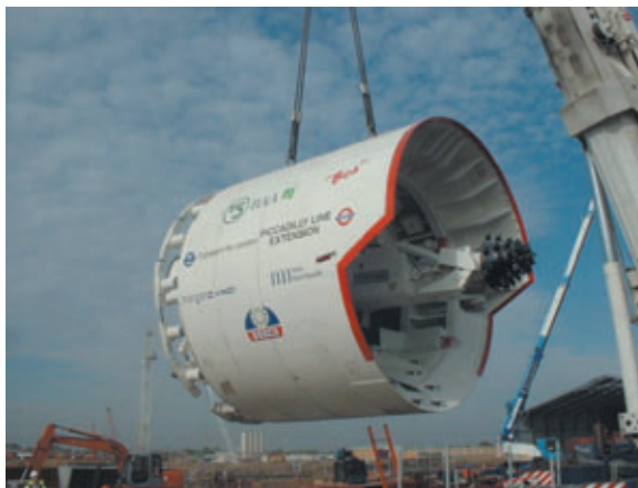
Photo 11 Tunnelier PiccEx pendant son installation dans le puits de démarrage
