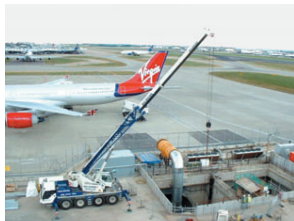
Photo 6 Chambre de démarrage du tunnelier directement au-dessous d'un stand d'avion TBM starting chamber directly below an aircraft stand
