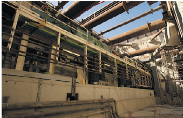
Station Canal du Midi. Au premier plan, la remorque du tunnelier. A droite, le bâti du faux tunnel qui sert de point d'appui à la machine sur les premiers mètres de creusement
