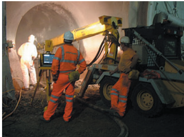
Photo 14 "Beamer" utilisé à la face pour contrôler la projection de béton Beamer used at the face to control concrete spraying
