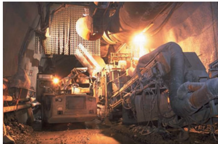
Photo 3 Concasseur mobile Mobile crusher
