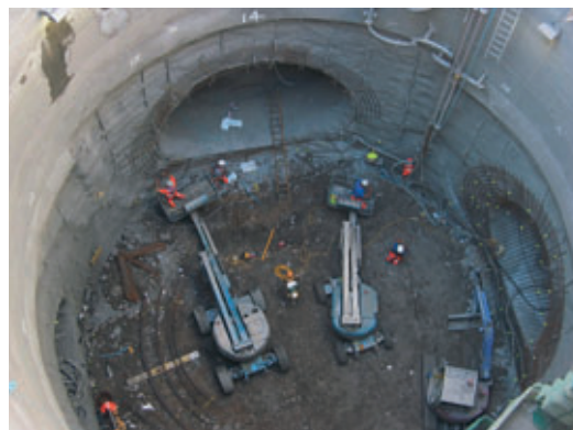
Photo 16 Amorces de galeries démarrant depuis un puits Beginning of galleries starting from a shaft
