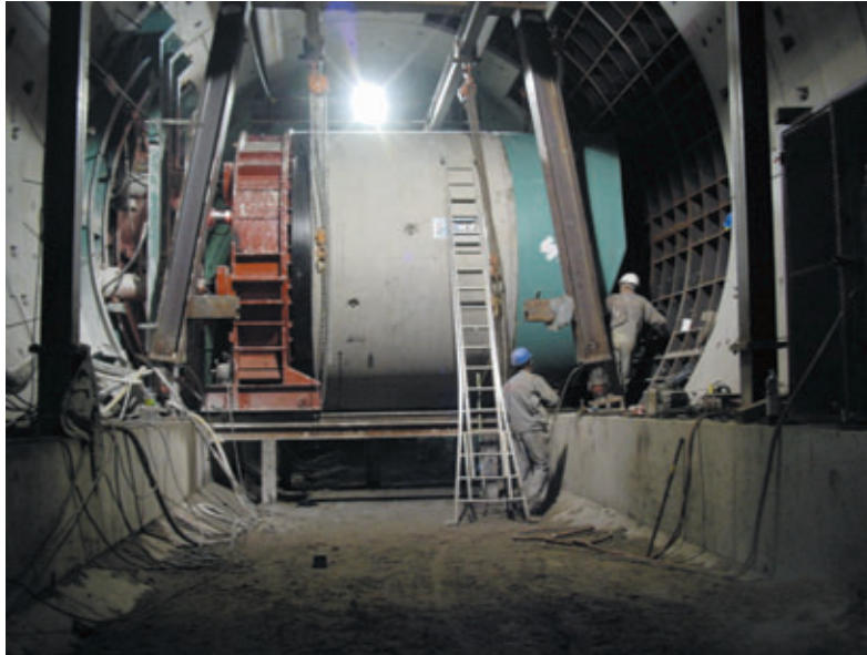
Photo 6 Installation de poussage de tubes utilisée pour la réalisation des rameaux Jacking installation used for the cross-passages
