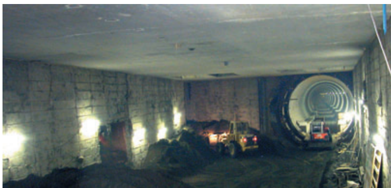
Photo 5 Arrivée du tunnelier du second tube sous la station Astrid (8 septembre 2003) Breakthrough of the TBM of the 2nd tube under metrostation Astrid (08/09/03)
