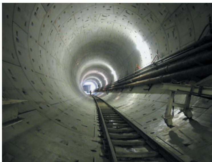
Photo 2 Vue des voussoirs constituant le revêtement du tunnel
