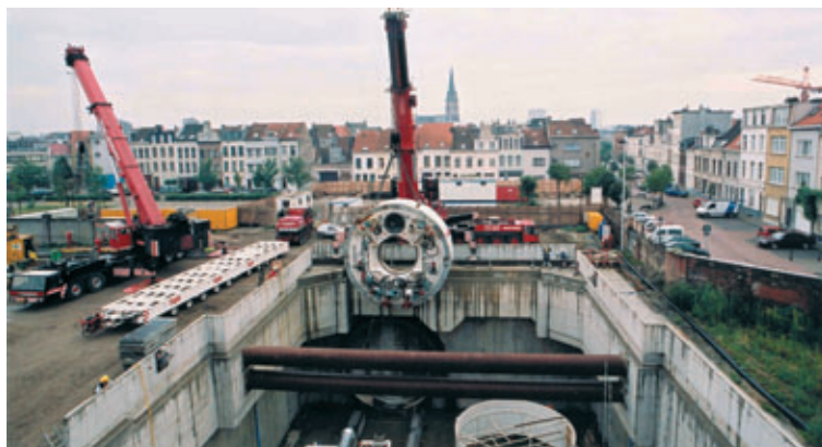
Photo 3 Montage du tunnelier dans le puits de départ Assembly of the TBM in the start shaft
