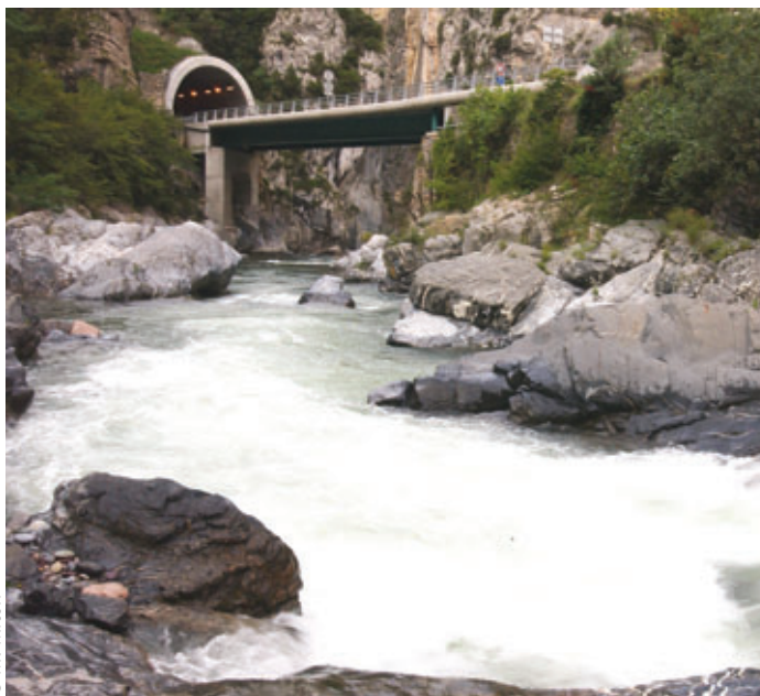
La Roya au pied du pont amont
