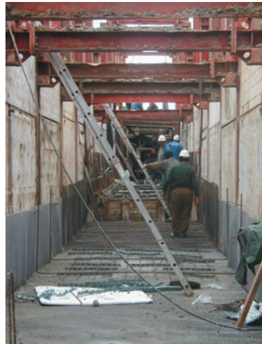
Photo 3 Galerie en construction - Vue sur l'Alvéodrain F et les armatures
