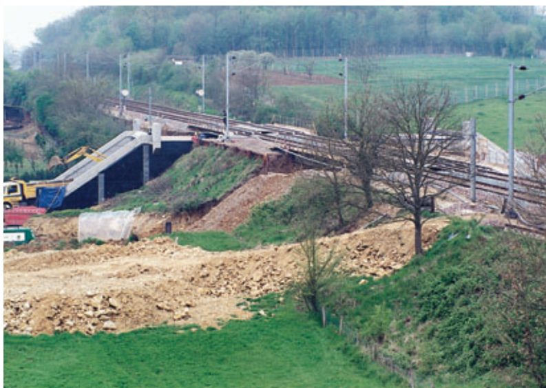
AUTOFONÇAGE ® . SNCF Nantes. Déviation de Virolet, un demi-ouvrage d'art de chaque côté des voies
