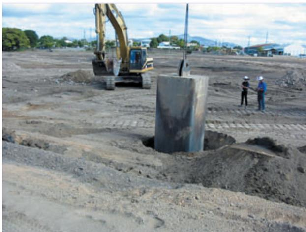
**Les sols ont été consolidés par compactage dynamique ou par plots ballastés pour obtenir un résultat homogène conforme aux caractéristiques requises pour les fondations**
