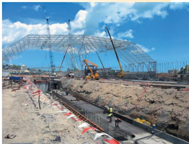
Les semelles de fondation et les dalles de planchers sont précontraintes à 90 %. Le mur d'enceinte a reçu en outre, une précontrainte verticale composée de câbles à cinq torons mis en place tous les 0,8 m
