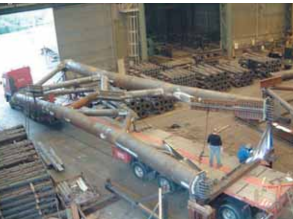
Figure 16 Arrivée sur site de deux demi-arcs peints Arrival on site of two painted half-arches
