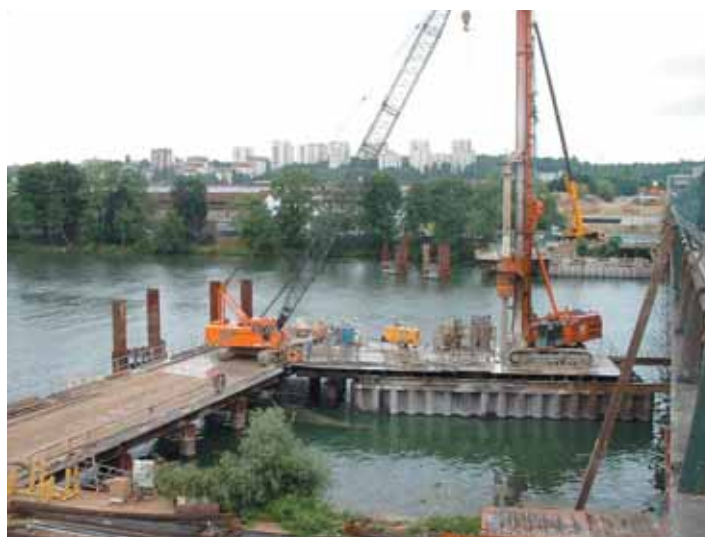
Photo 2 Réalisation des pieux depuis la plate-forme sur le batardeau
