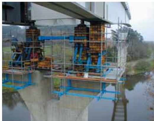
Photo 13 Calage charpente sur P3 Structure bracing on P3
