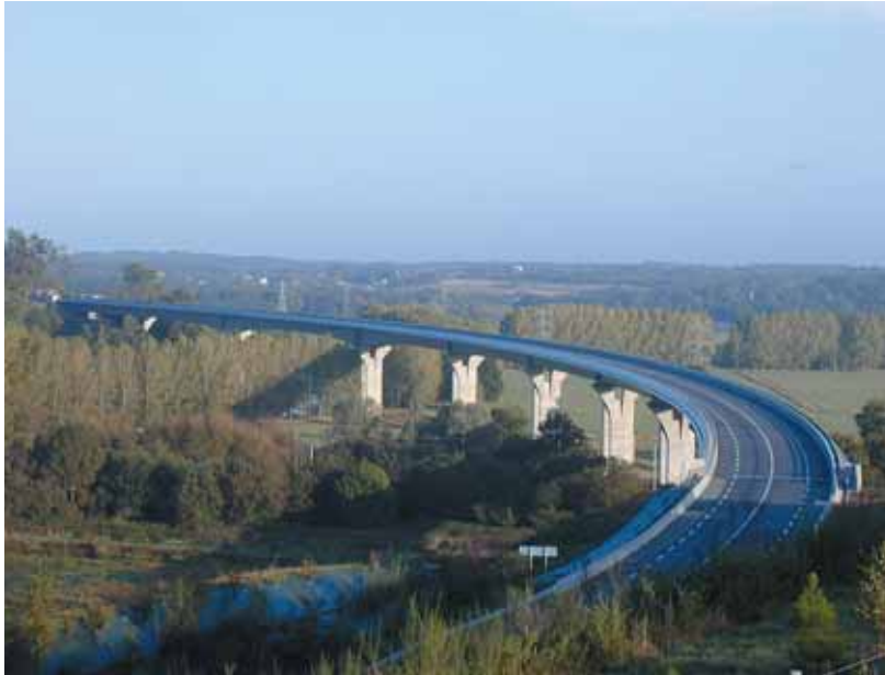
Photo 22 Vue d'ensemble Overall view
