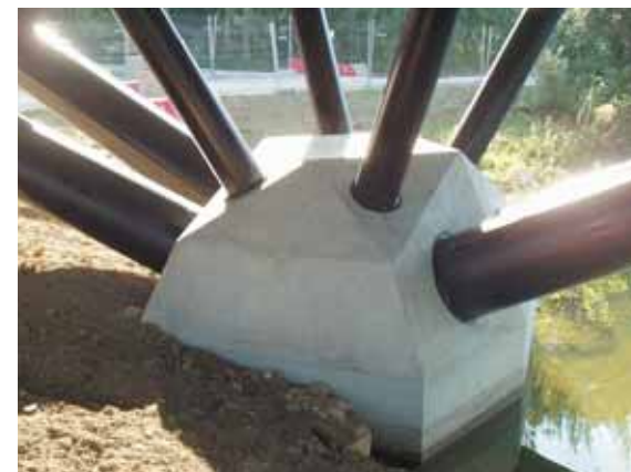
Figure 29 Pile terminée, avec arcs encastrés Completed pier, with fixed arches
