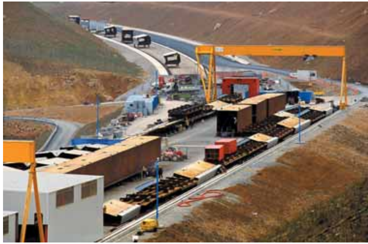
Photo 8 Aire d'assemblage du tablier côté sud Deck assembly area on the south side
