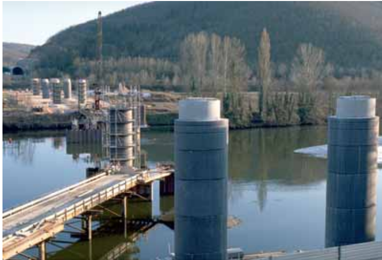
Photo 1 Les piles du viaduc en premier plan avec les estacades et la tranchée couverte en arrière plan
