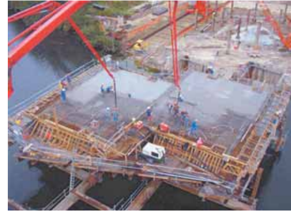
Figure 18 Bétonnage du 1 er plot nervuré (clé de l'arc)
