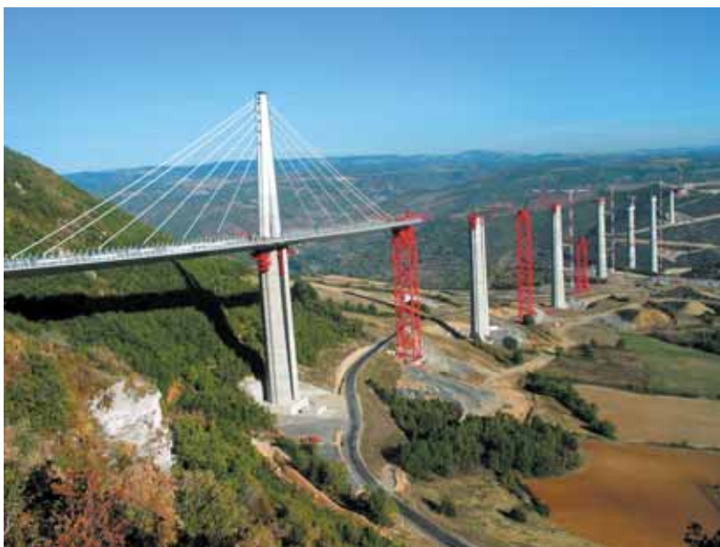
Photo 1 Vue générale de l'ouvrage General view of the structure
