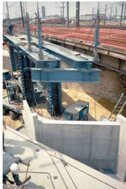
Photo 12 Mise en place d'un sommier Installing a springer
