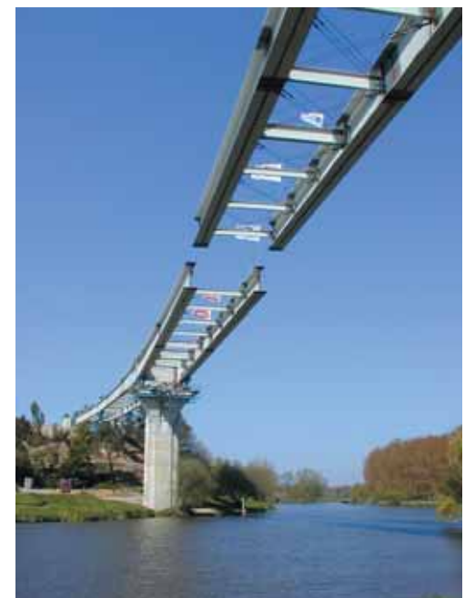
Photo 14 Accostage charpente le 8 avril 2002 Structure berthing on 8 April 2002
