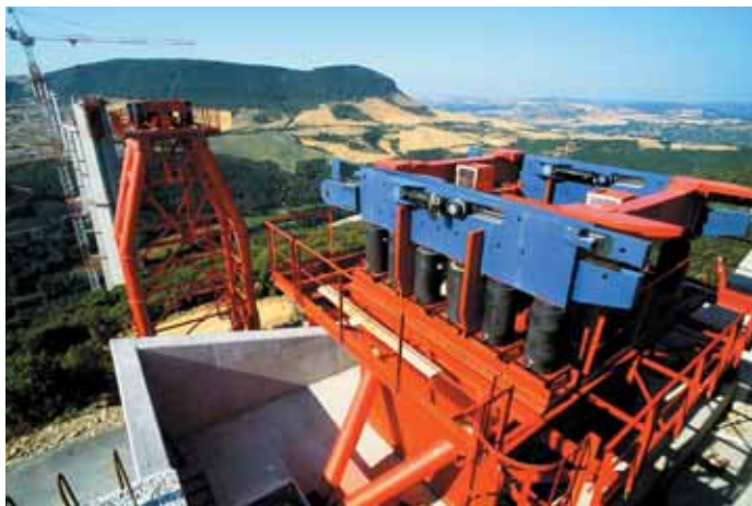
Photo 10 Translateur sur culée nord Side shifter on north abutment
