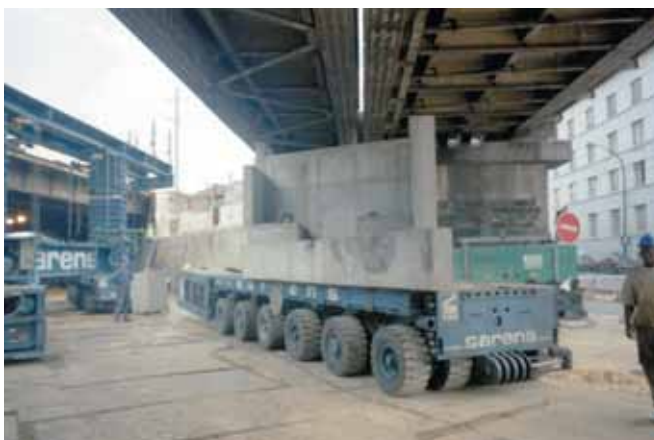
Photo 11 Amenée d'un sommier par Kamag Bringing in a springer by Kamag carrier
