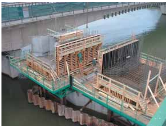
Photo 6 Réalisation des voussoirs sur pile (VSP) Execution of segments on piers
