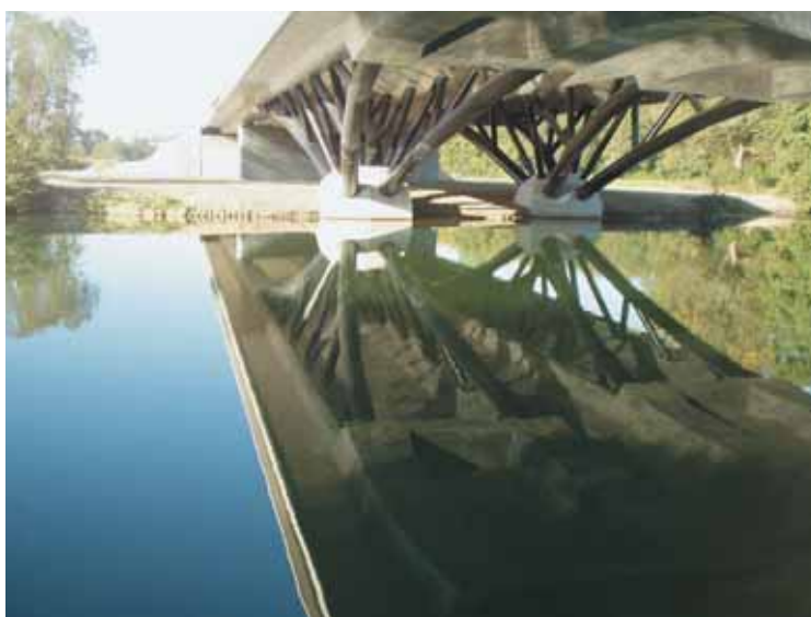
Figure 31 Ouvrage terminé - Détail Completed structure - Detail
