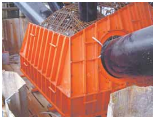
Figure 28 Coffrage de la seconde partie de pile Shuttering the second part of the pier
