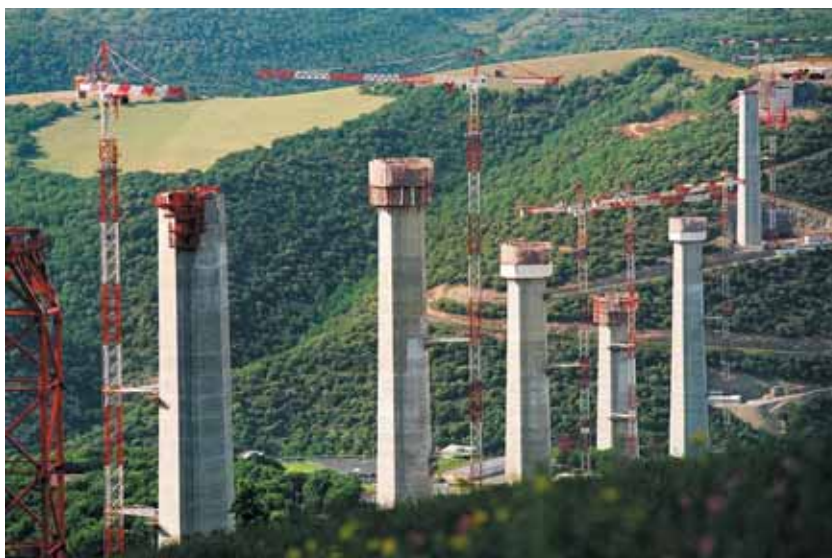
Photo 3 Construction des piles
