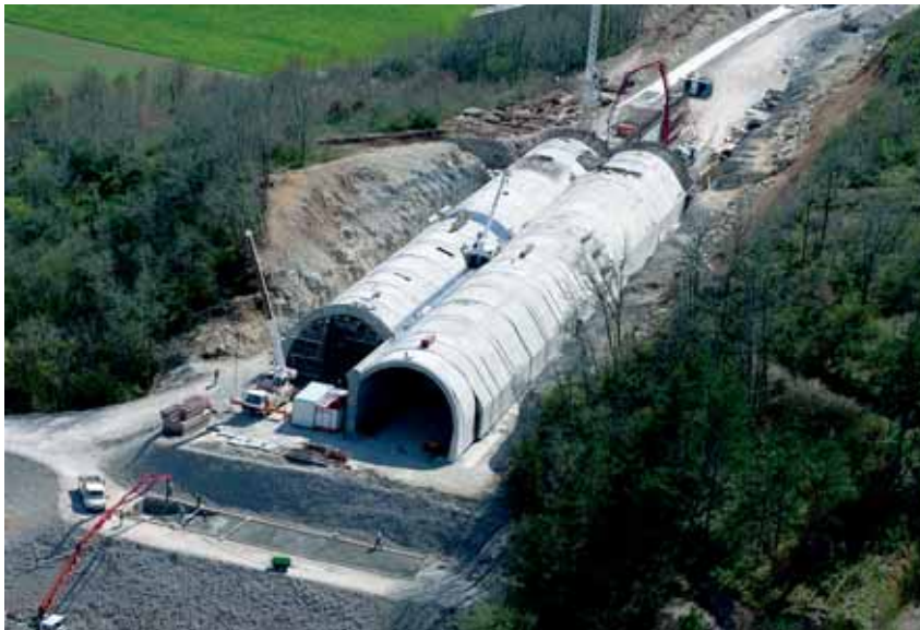
Photo 7 Tranchée couverte avant recouvrement avec culée sud du viaduc en premier plan
