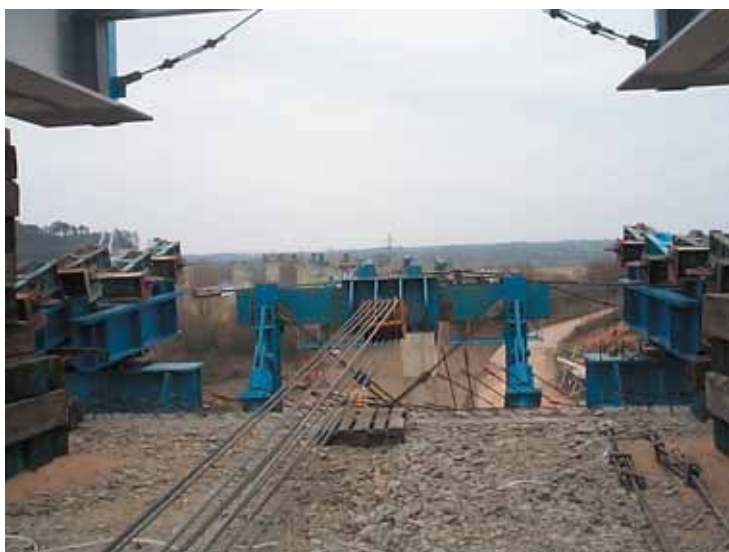
Photo 8 Dispositif de retenue. Le tronçon P2 en position de lancement sur la plate-forme
