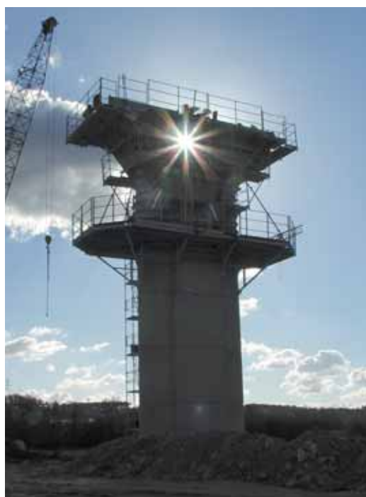
Photo 5 Coffrage chevêtre Joist shuttering
