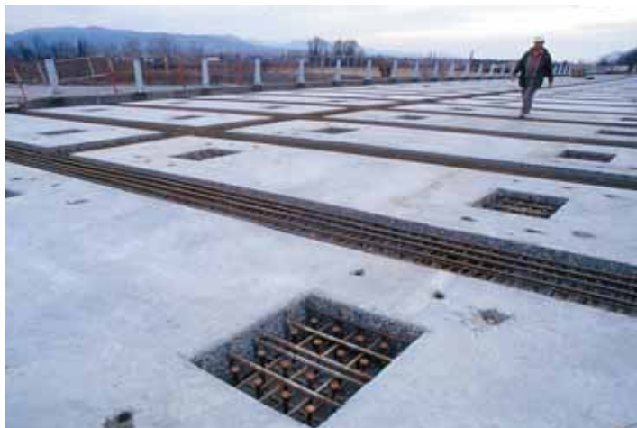
Vue du tablier en dalles préfabriquées avant clavage
