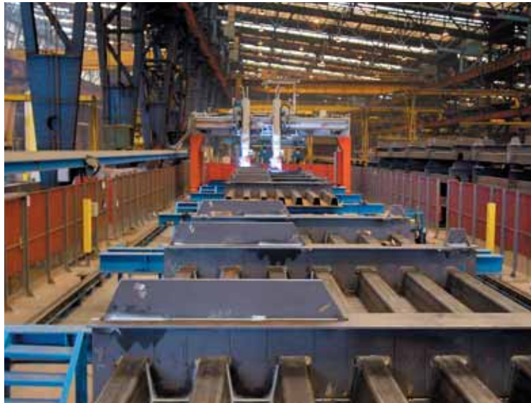
Photo 6 Fabrication des platelages du tablier dans l'usine de Lauterbourg
