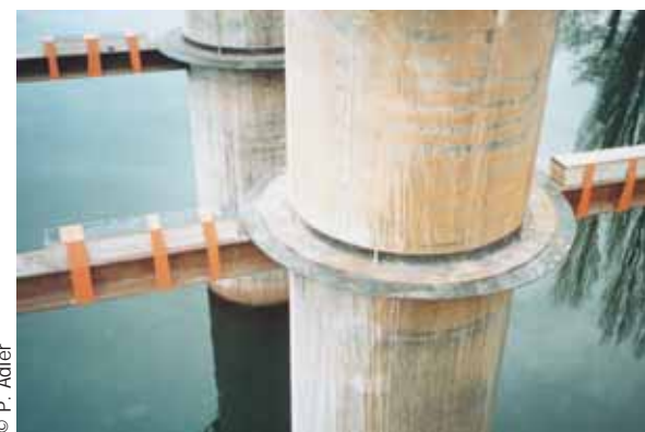
Photo 4 Couronne d'étanchéité Sealing ring
