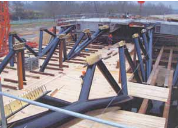
Figure 23 Montage du plancher de travail Erection of the work floor
