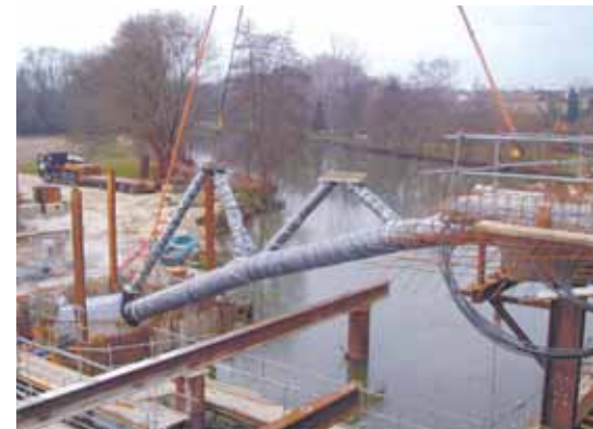
Figure 19 Mise en place d'un demi-arc Installing a half-arch
