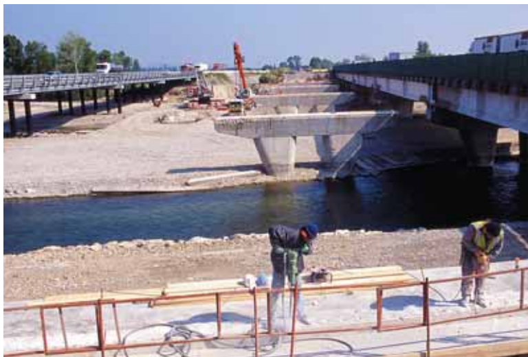
Reprise des chevêtres Reworking the joists
