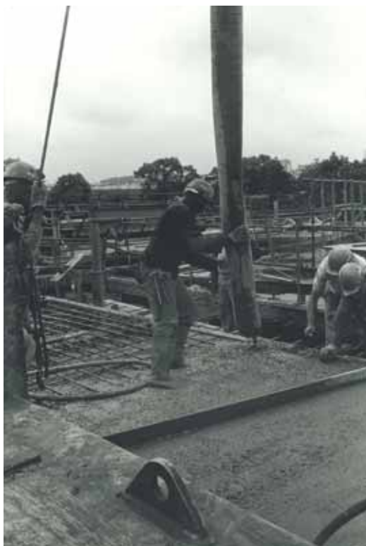
Photo 8 Bétonnage de voussoir Segment concreting
