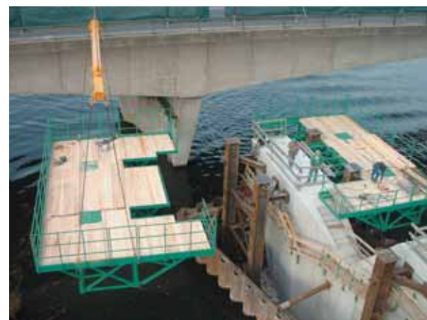
Photo 5 Palées provisoires et mise en place des platelages de travail
