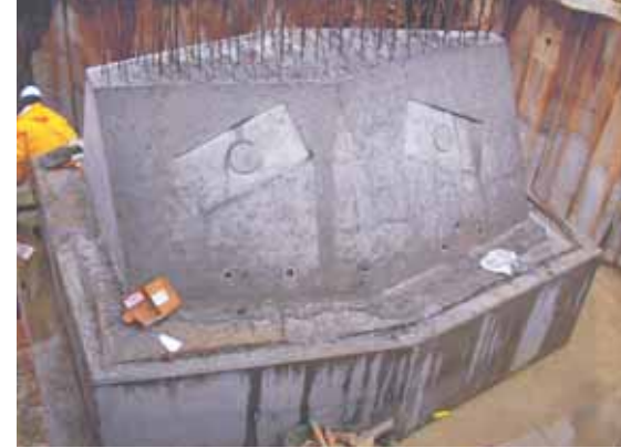
Figure 27 Première partie de pile pour appui provisoire des arcs Initial part of pier for temporary support of arches
