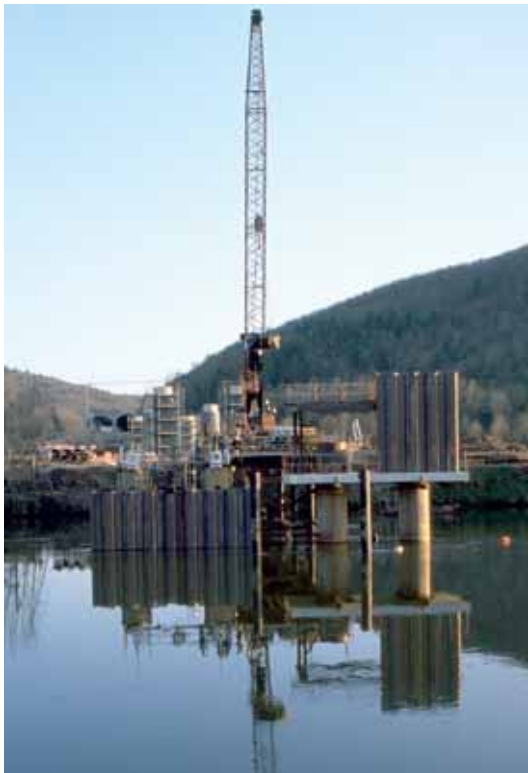
Photo 2 Batardeau P8 en cours de réalisation et batardeau amont en cours de descente
