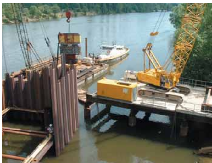
Photo 1 Fonçage des palplanches des batardeaux et estacade en Seine
