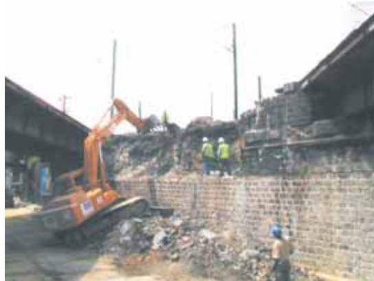
Photo 10 Démolition de la culée Demolition of the abutment
