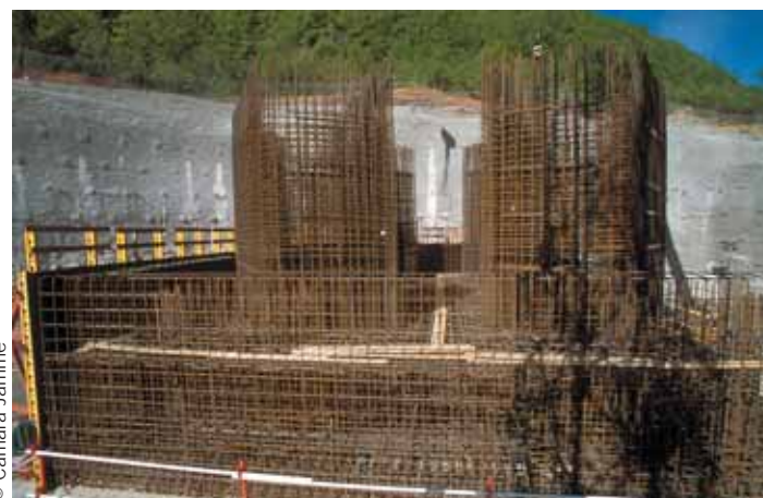
Photo 2 Ferrailage de la semelle de P7
