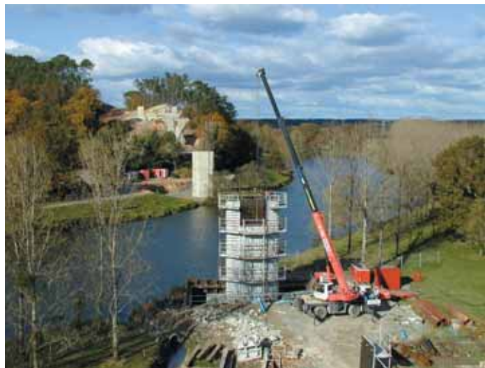
Photo 5 Coffrage chevêtre Joist shuttering
