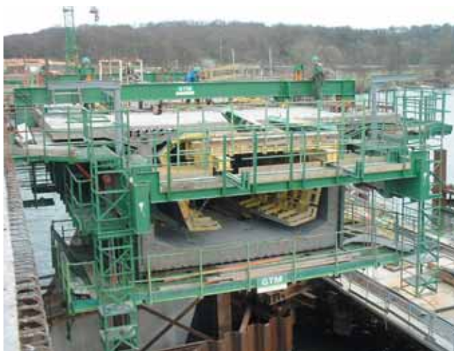
Photo 8 Bétonnage de voussoir Segment concreting
