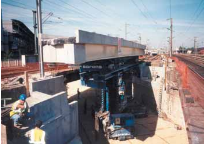
Photo 13 Mise en place d'un tablier neuf Laying a new deck
