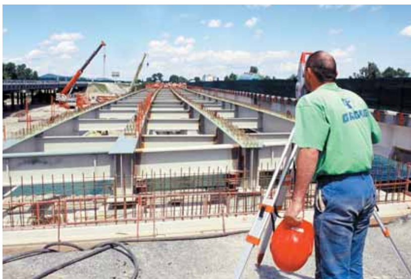
Vue de la structure métallique avant la pose des dalles View of the steel structure prior to laying the slabs
