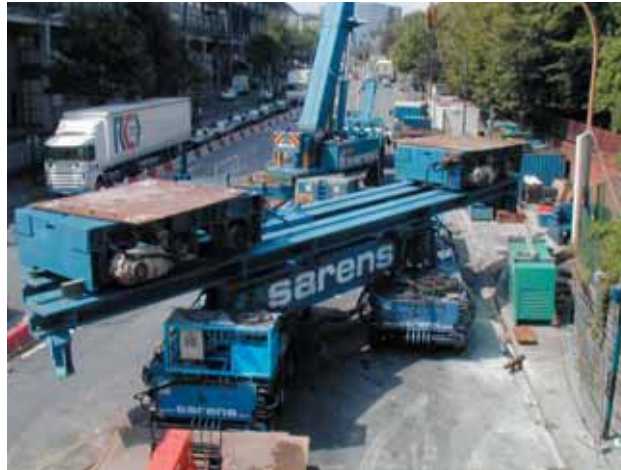
Photo 7 Dépose d'un ancien tablier Removing an old deck
