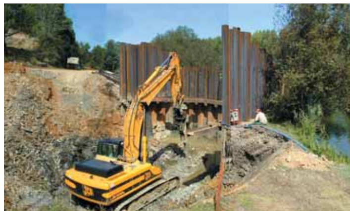
Photo 3 Réalisation semelle pile P2 Construction of the footing of pier P2
