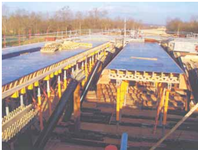
Figure 24 Mise en place des tables coffrantes Installation of the casting tables
