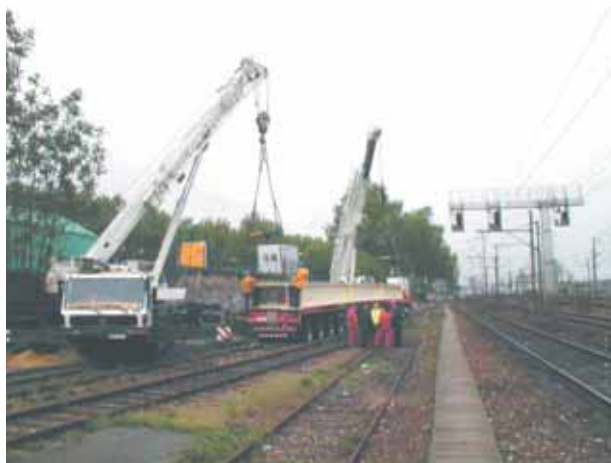
Photo 3 Mise en place de l'ossature métallique sur zone de stockage
