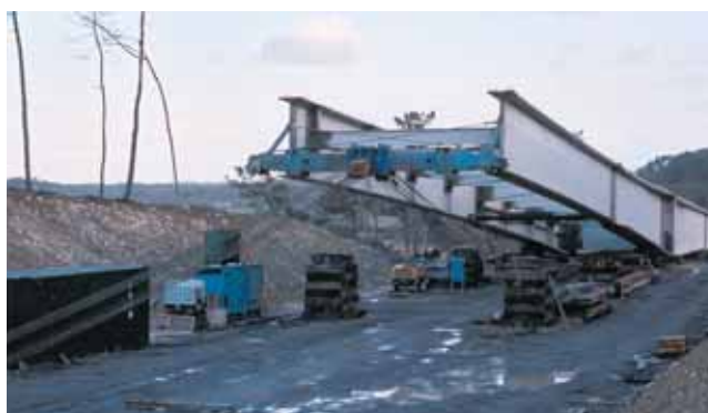
Photo 8 Dispositif de retenue. Le tronçon P2 en position de lancement sur la plate-forme
