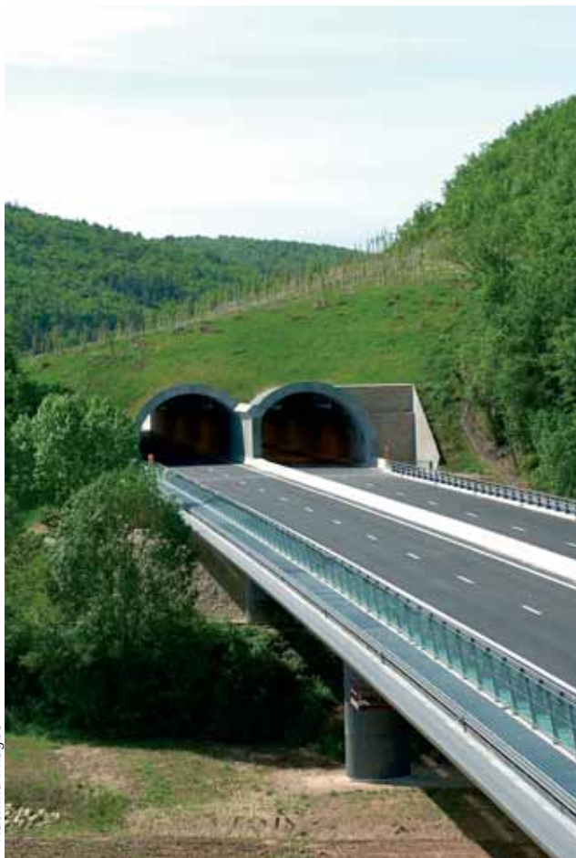
Photo 8 Viaduc et tête nord de la tranchée couverte (travaux achevés)
