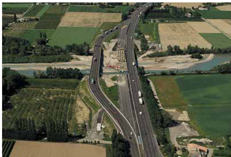
Vue aérienne du chantier et de la déviation Aerial view of the project and the diversion
