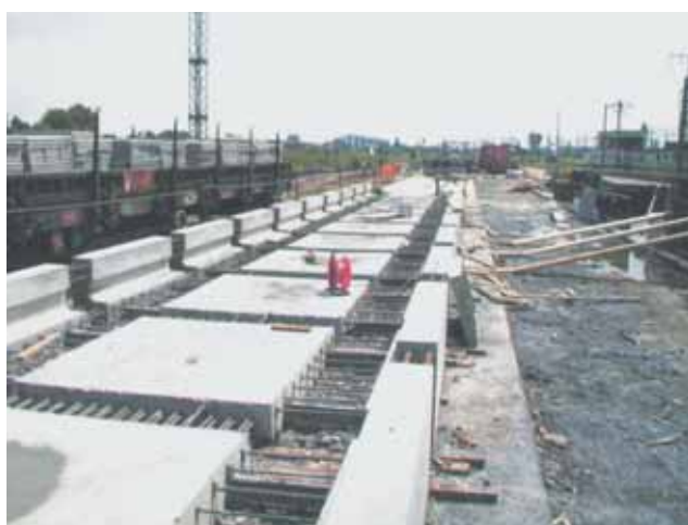
Photo 4 Aire de préfabrication des dalles
